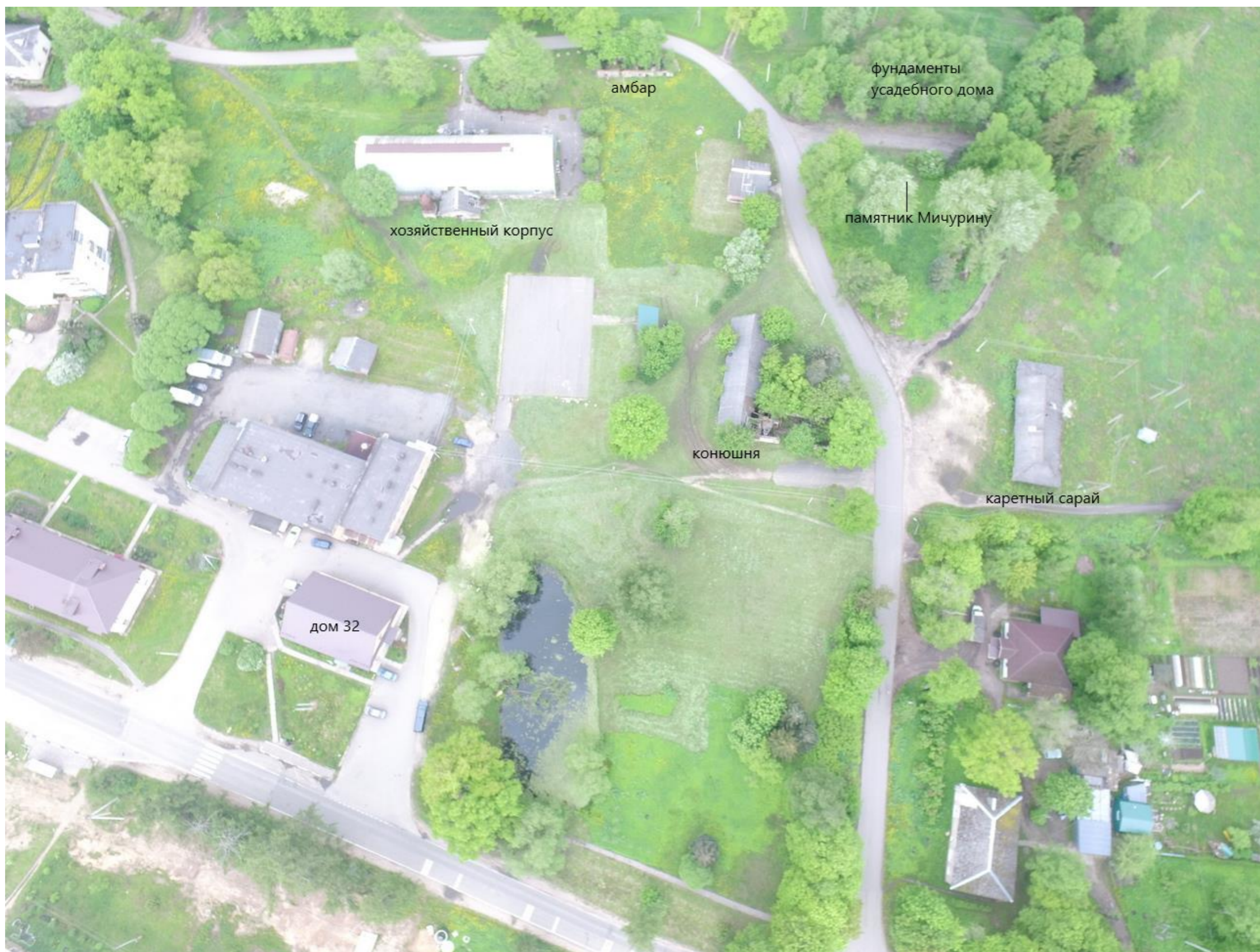
2 Вид с востока на участок проектируемого благоустройства. Участок ограничен: с запада автодорогой, с юга домом 32, с востока хозяйственным корпусом, с севера дорогой к усадебному дому. Между конюшней и хозяйственным корпусом видны существующая асфальтированная площадка и навес сцены. Между домом 32 и асфальтовой площадкой – объект диссонирующей застройки с плоской кровлей. Здание находится вне границ ансамбля, однако просматривается на большинстве путей обзора.
