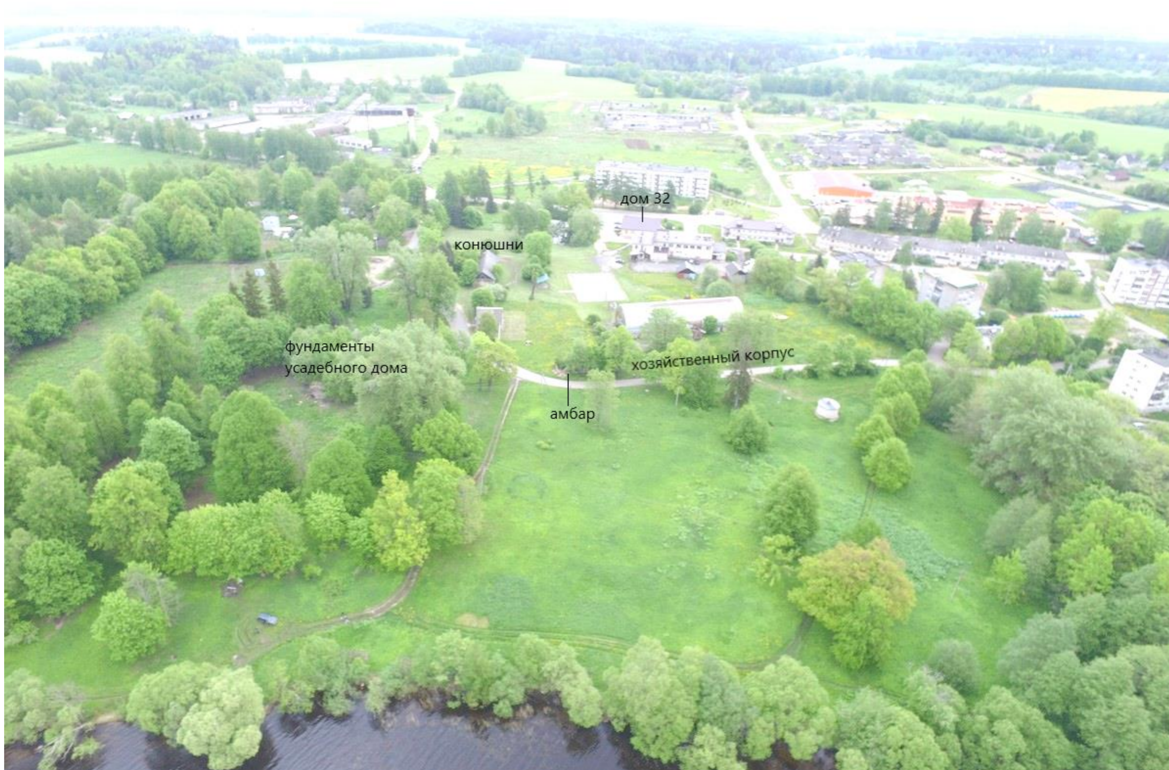
10 Вид на центральную часть ансамбля с запада, со стороны озера.
