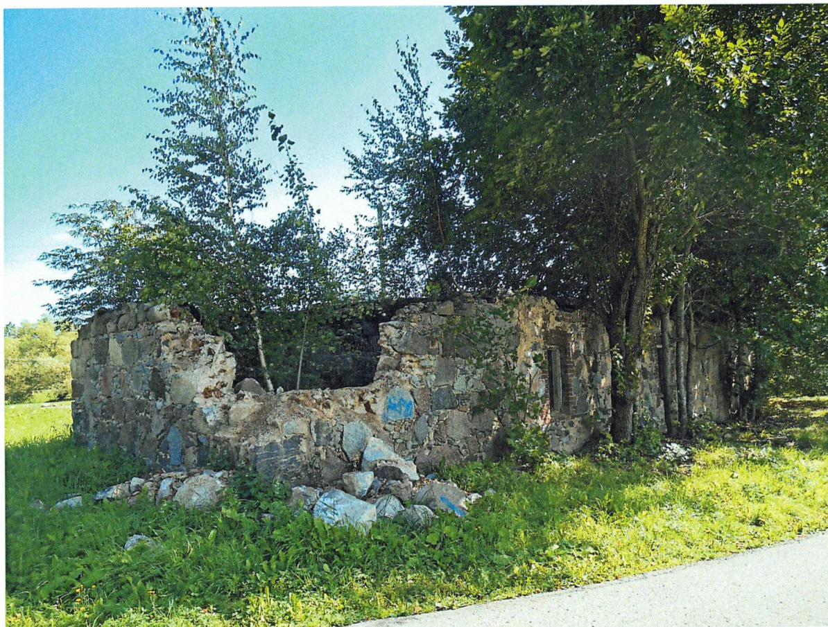
16. Амбар, северо-западный фасад и фрагмент юго-западного фасада, вид с запада.
