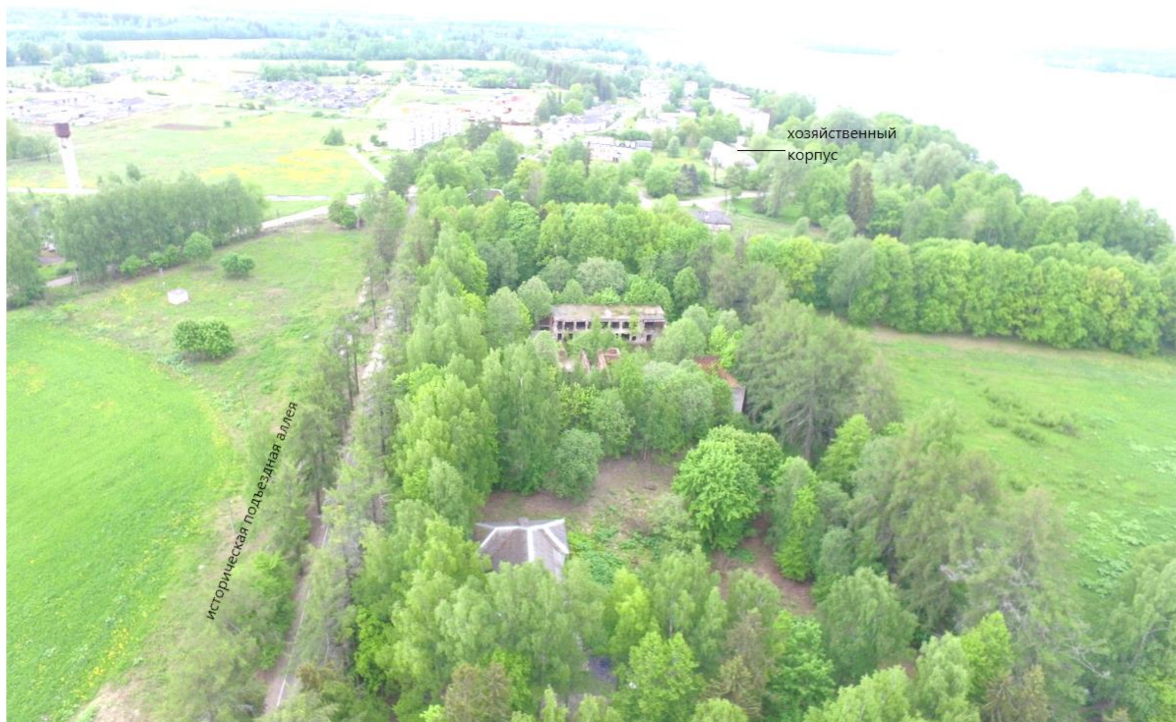
8 Вид на северную часть ансамбля с севера. В центральной части кадра – руинированные постройки в границах ансамбля.
