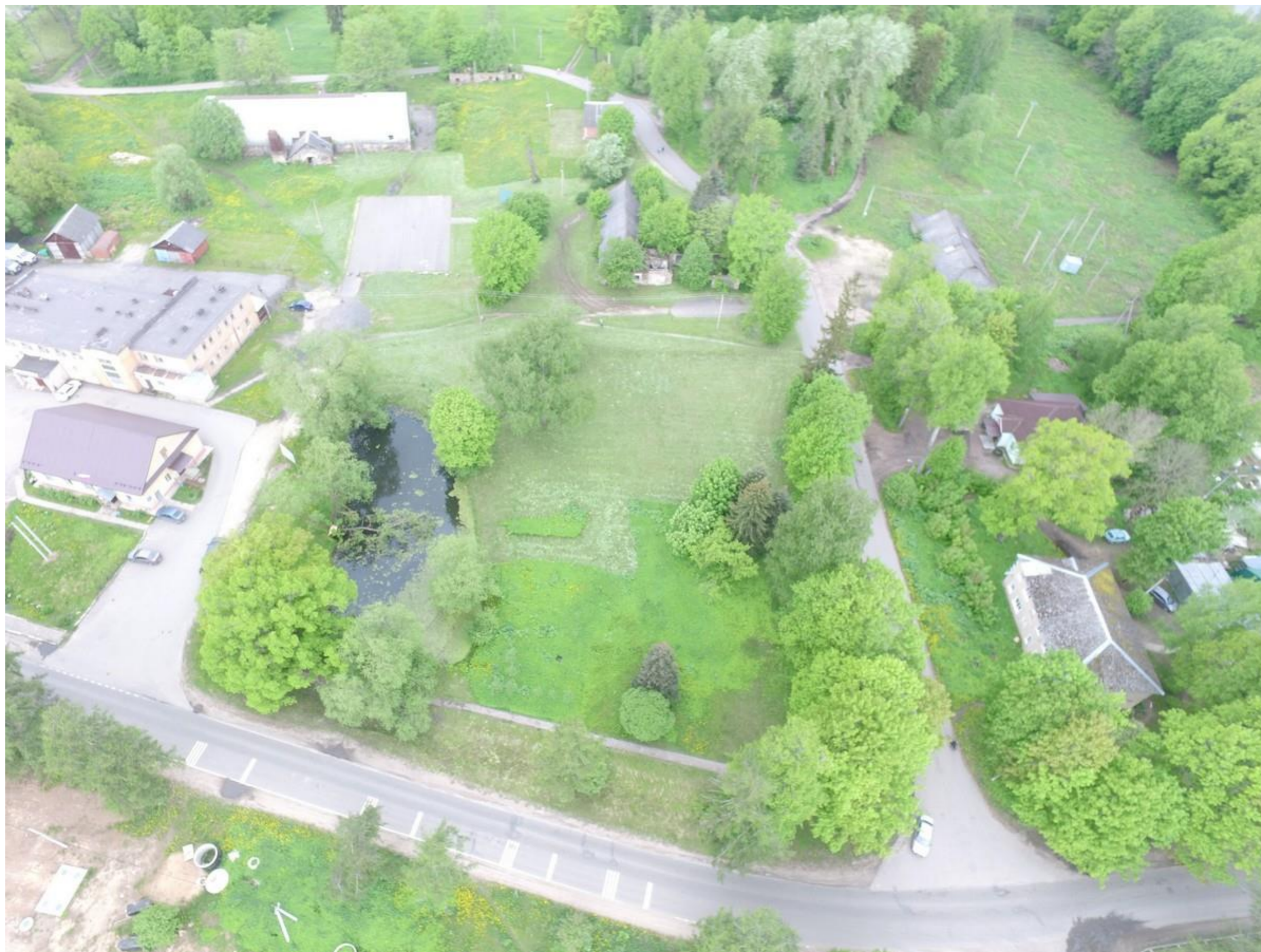
4 Территория проектируемого благоустройства, вид с востока.
