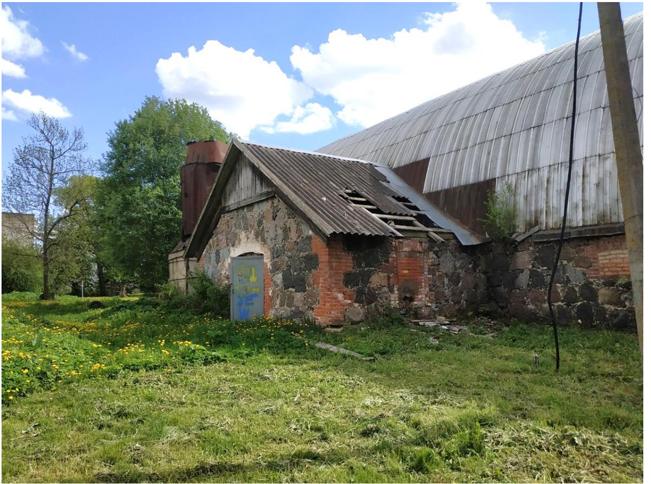
16 Хозяйственный корпус, восточный фасад.
