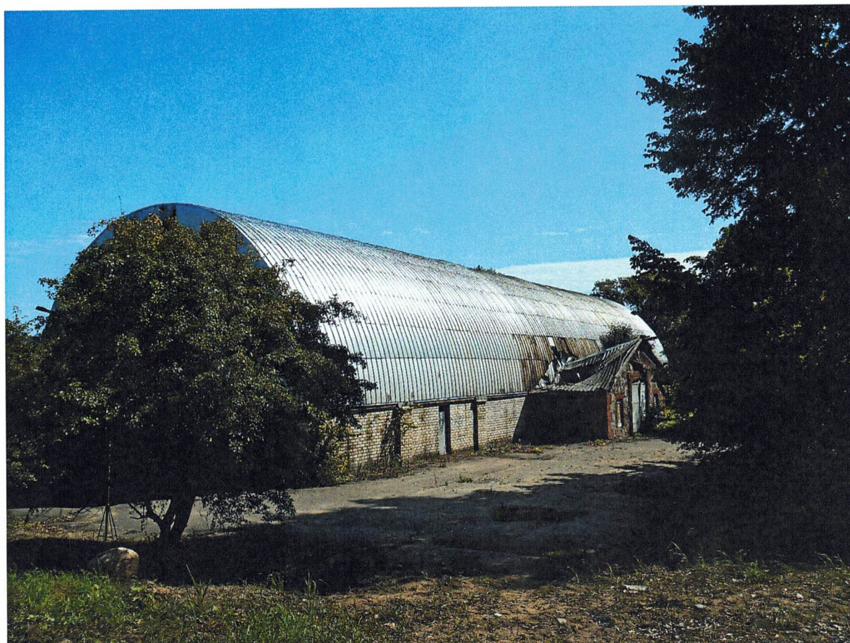
14. Хозяйственный корпус, фрагмент северо-западного и юго-западного фасадов, вид с запада.
