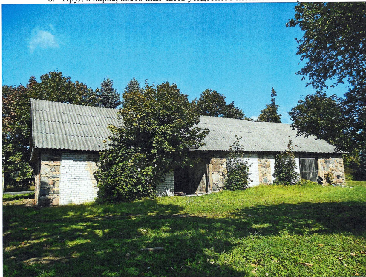
9. Конюшня, ю-западный фасад, вид с юго-запада.
