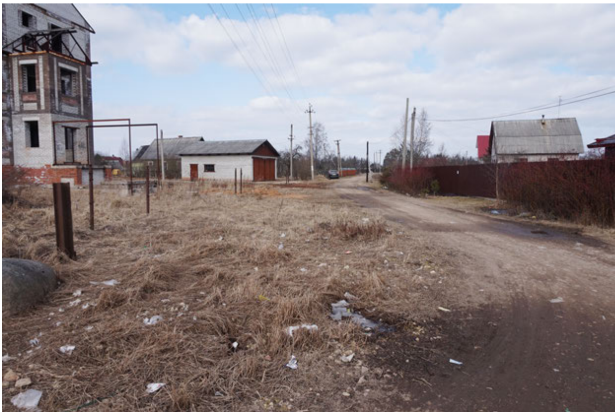
Рис. 51. Ленинградская область, Гатчинский район, д. Покровка. Прохождение газопровода по Полевой улице. Вид с Ю
