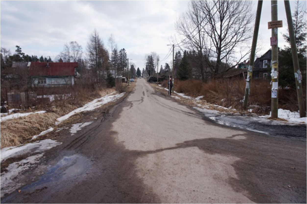
Рис. 38. Ленинградская область, Гатчинский район, п. Прибыtkовo. Прохождение газопровода по ул. Пушкинской. Вид с 3
