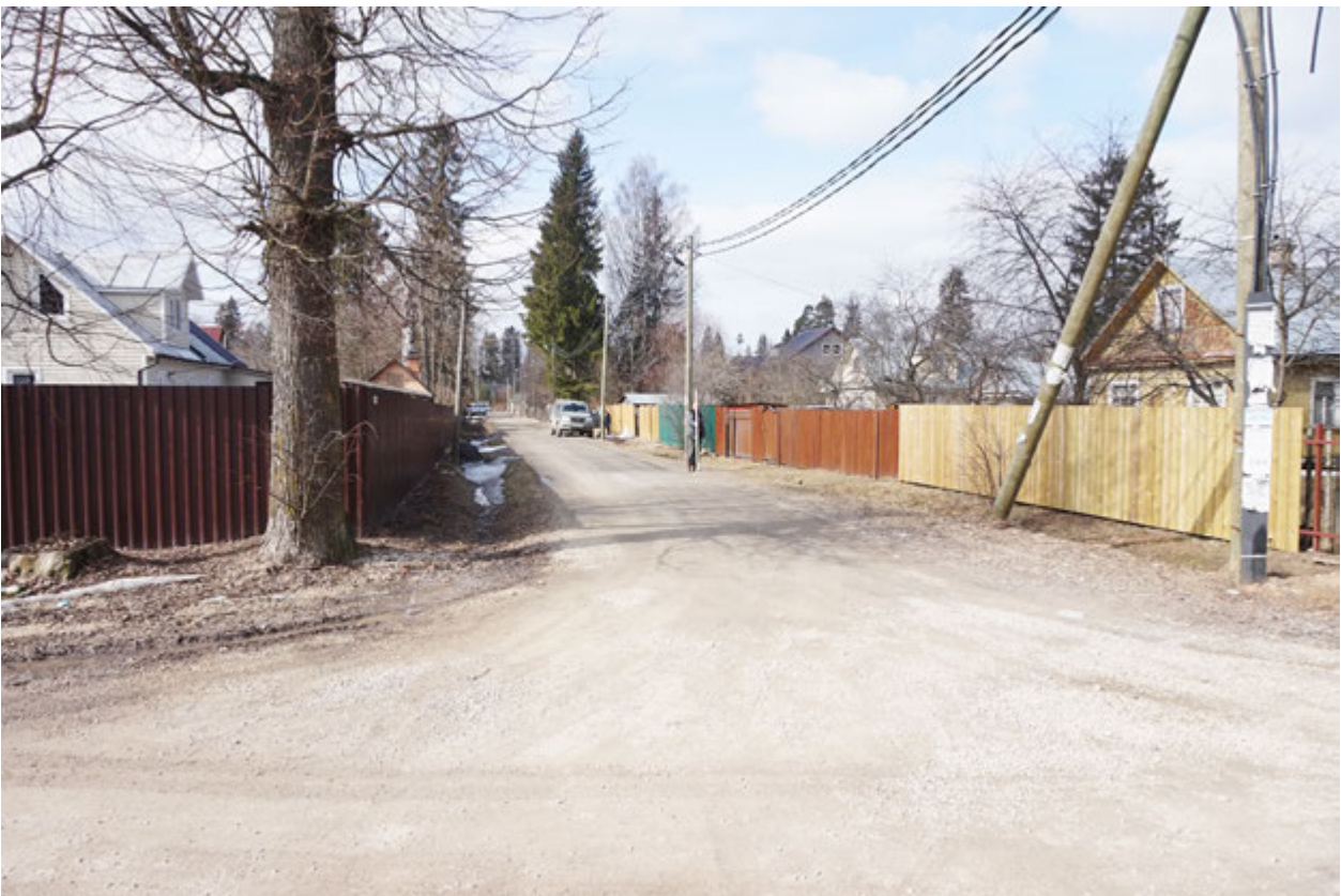
Рис. 29. Ленинградская область, Гатчинский район, п. Прибыtkовo. Прохождение газопровода по ул. 1-й Поперечной. Вид с В
