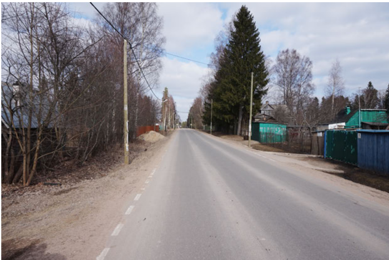
Рис. 43. Ленинградская область, Гатчинский район, п. Прибыtkовo. Прохождение газопровода по Среднему проспекту. Вид с Ю
