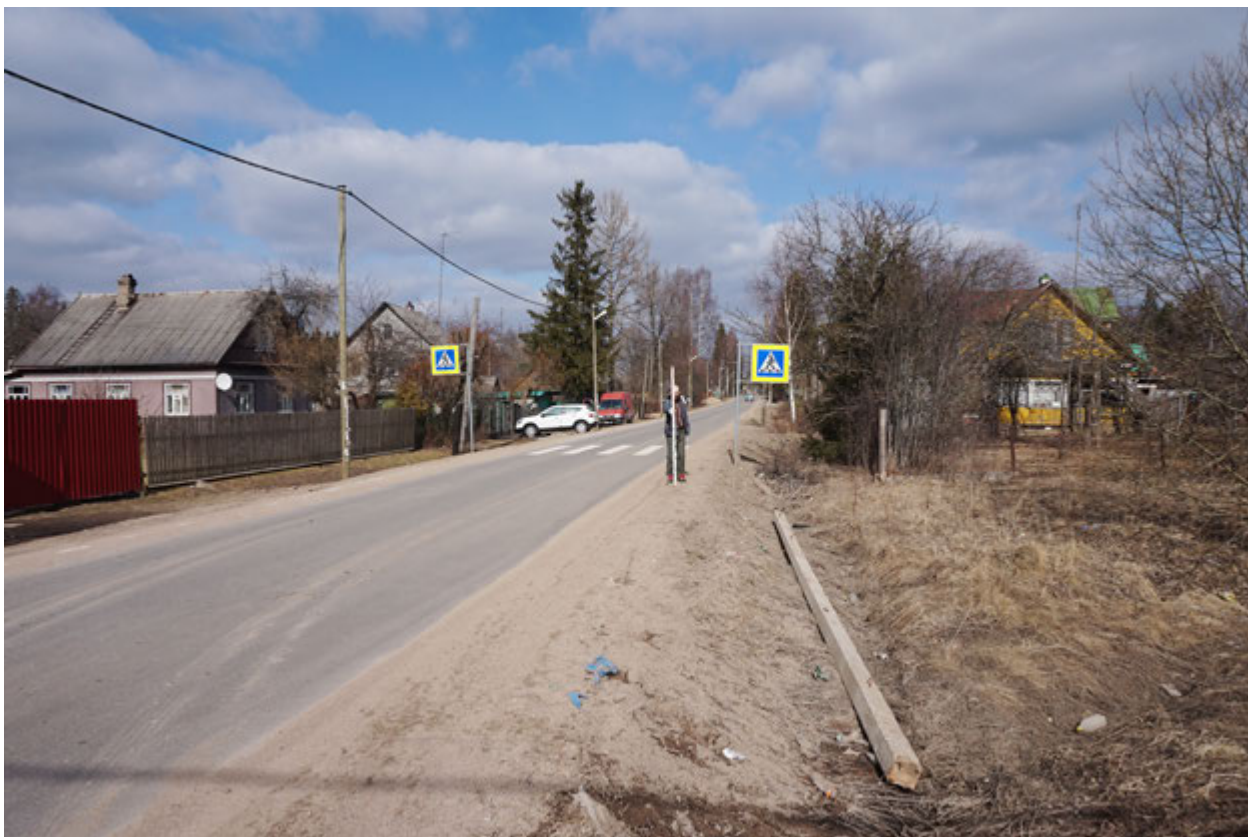
Рис. 42. Ленинградская область, Гатчинский район, п. Прибыtkовo. Прохождение газопровода по Среднему проспекту. Вид с Ю
