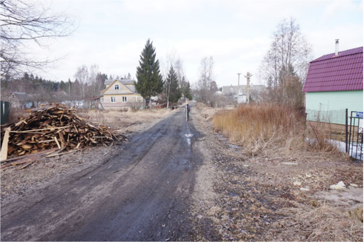
Рис. 26. Ленинградская область, Гатчинский район, п. Прибыtkовo. Прохождение газопровода по Школьному переулку. Вид с ЮВ
