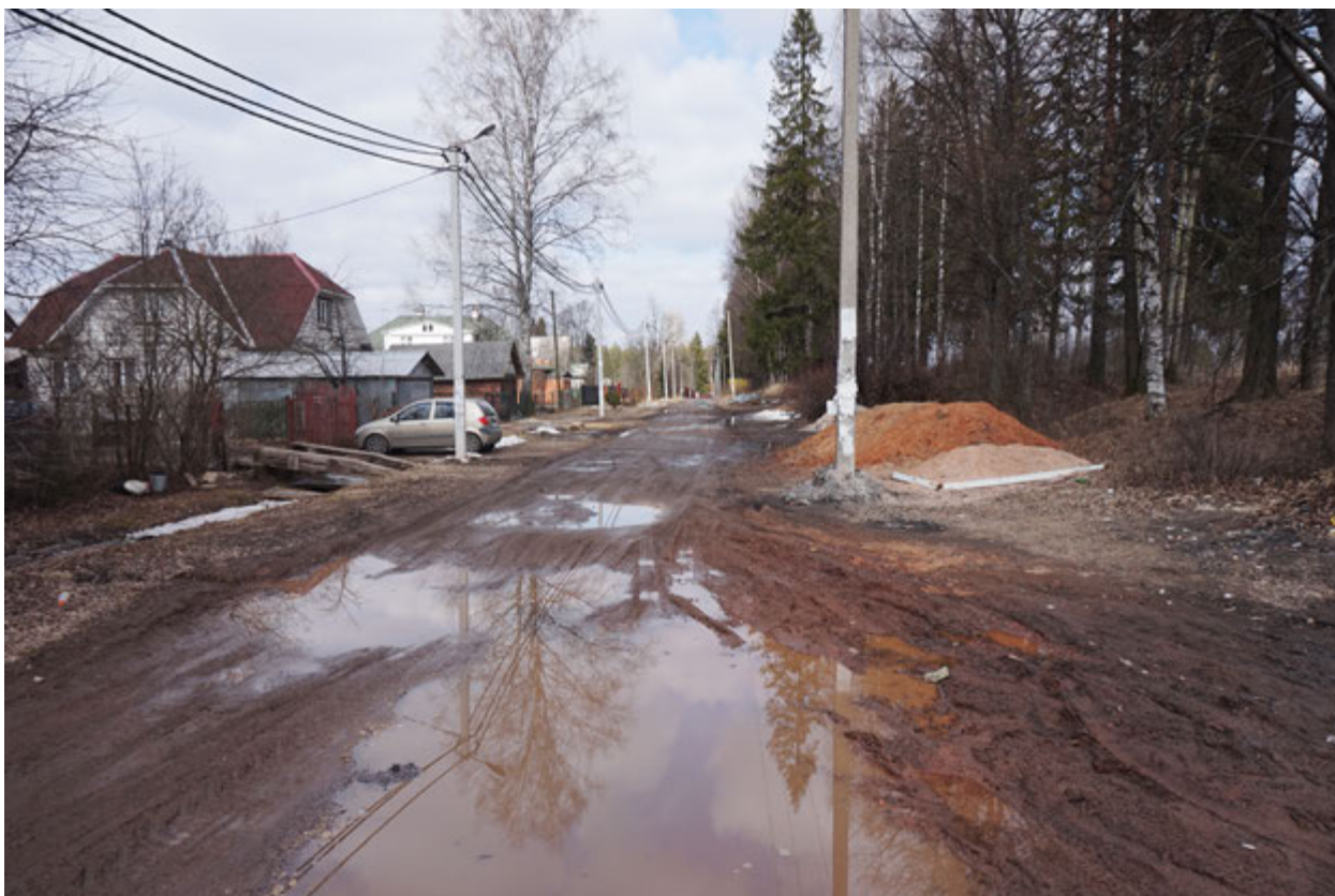
Рис. 44. Ленинградская область, Гатчинский район, п. Прибыtkовo. Прохождение газопровода по Большому проспекту. Вид с Ю
