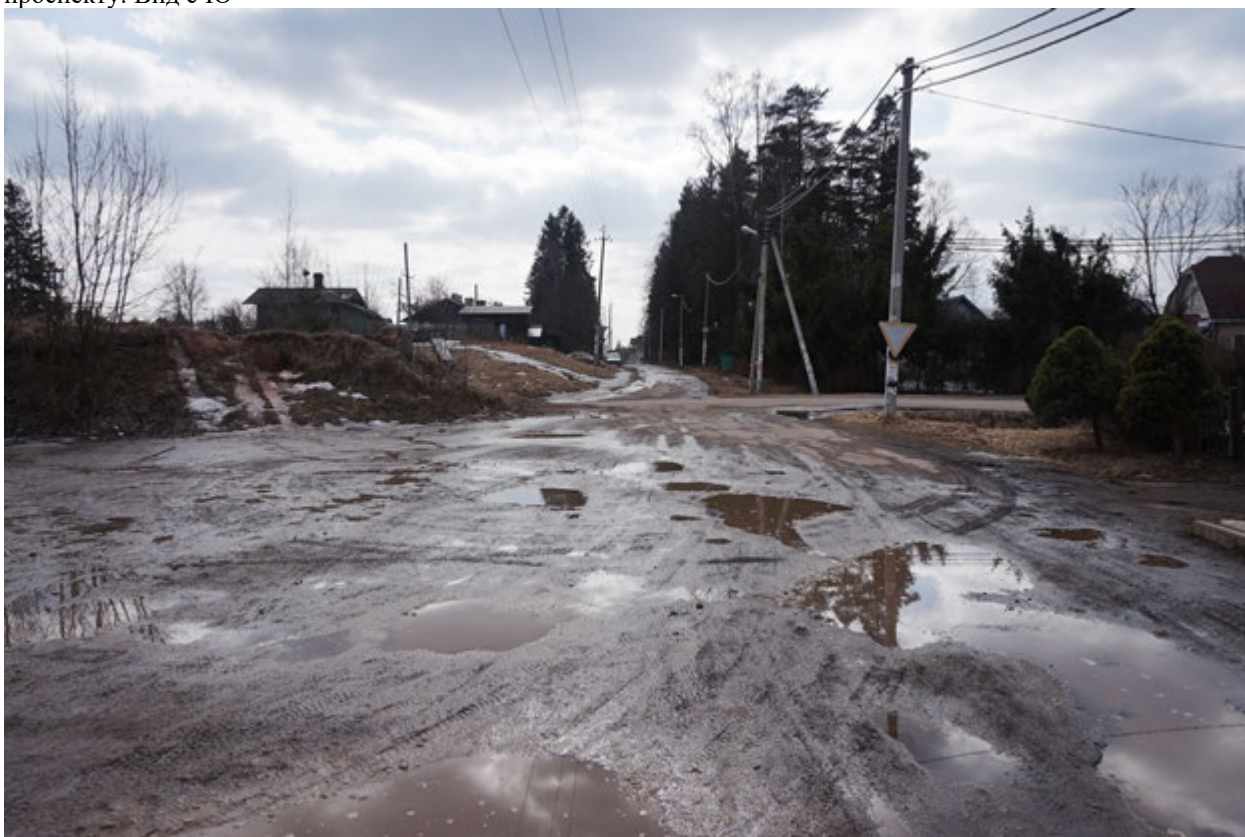
Рис. 45. Ленинградская область, Гатчинский район, п. Прибыtkовo. Прохождение газопровода по Большому проспекту. Вид с С
