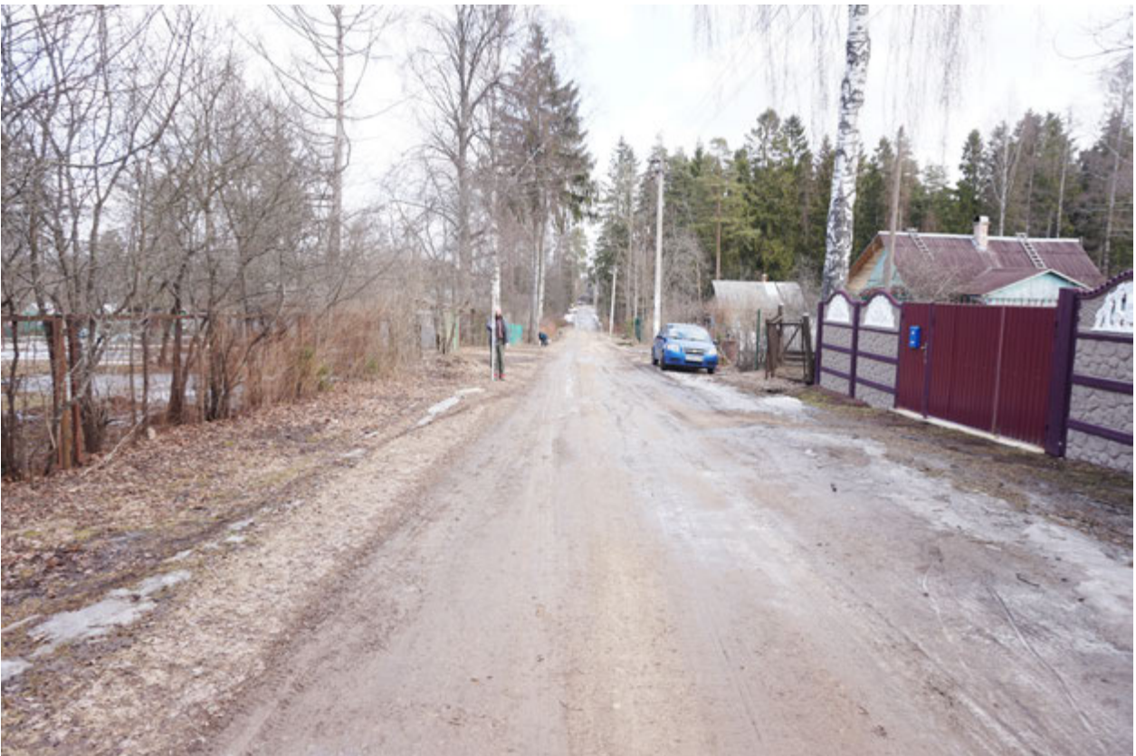
Рис. 19. Ленинградская область, Гатчинский район, п. Прибыtkовo. Прохождение газопровода по ул. Репина. Вид с ЮЗ
