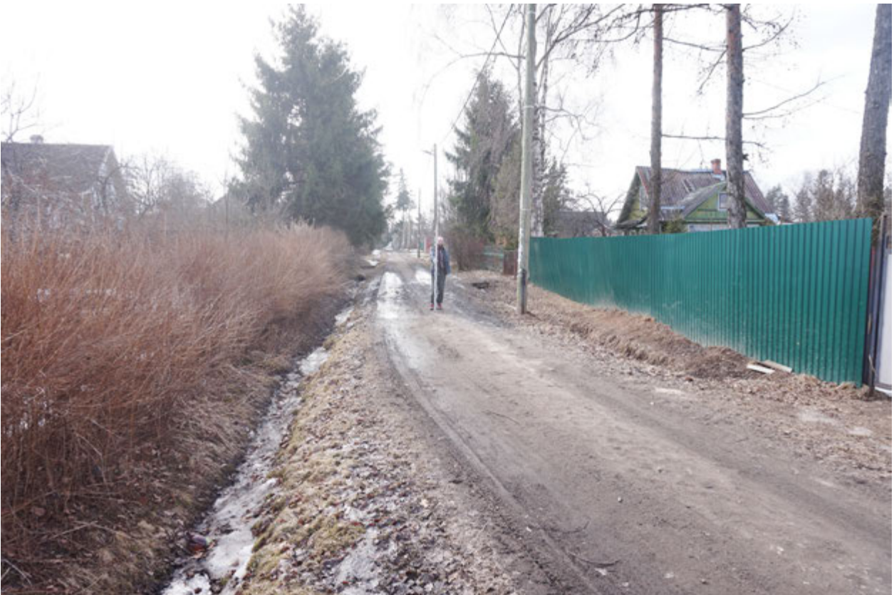
Рис. 27. Ленинградская область, Гатчинский район, п. Прибыtkовo. Прохождение газопровода по ул. Школьной. Вид с С
