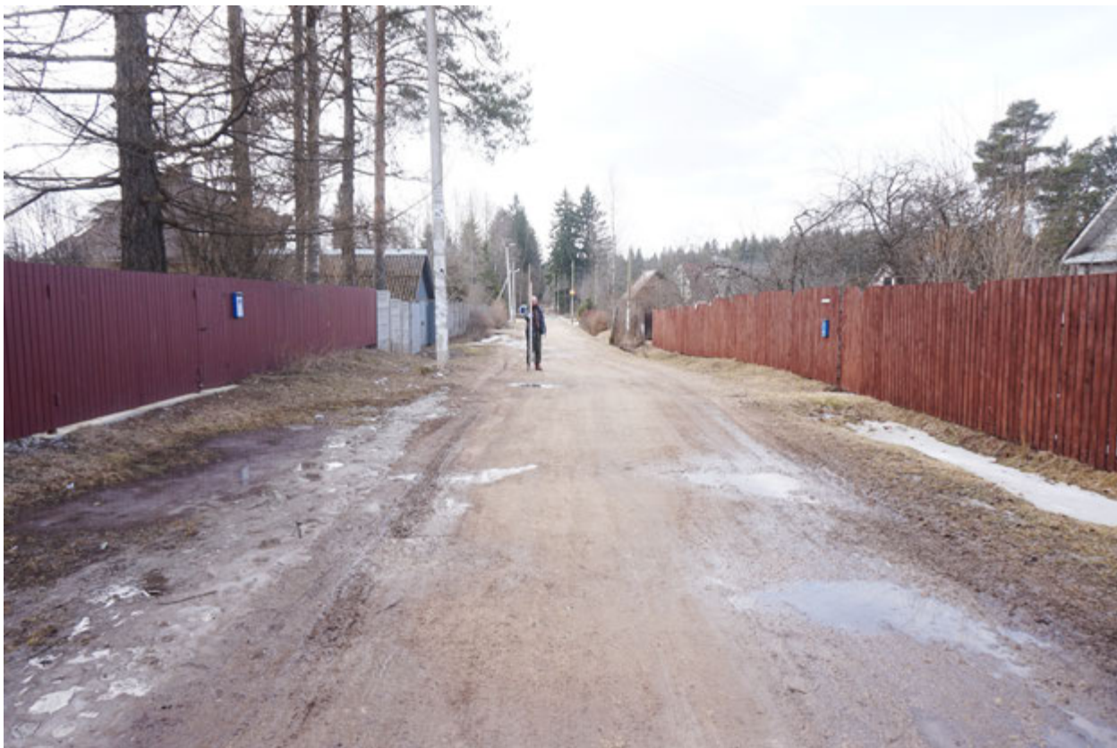
Рис. 20. Ленинградская область, Гатчинский район, п. Прибыtkовo. Прохождение газопровода по ул. Репина. Вид с СВ
