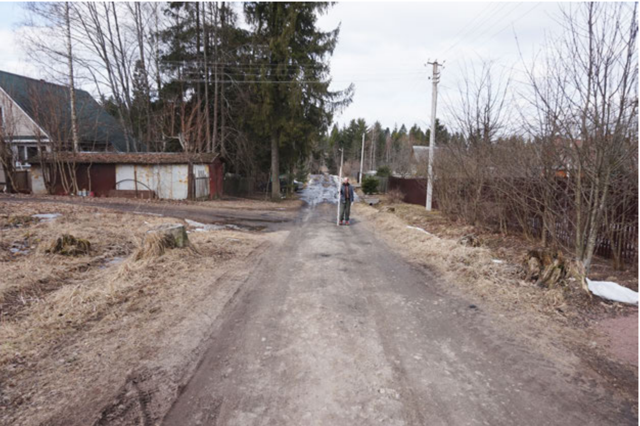
Рис. 13. Ленинградская область, Гатчинский район, п. Прибыtkовo. Прохождение газопровода по ул. Речной на перекрестке с ул. Средней. Вид с ЮВ
