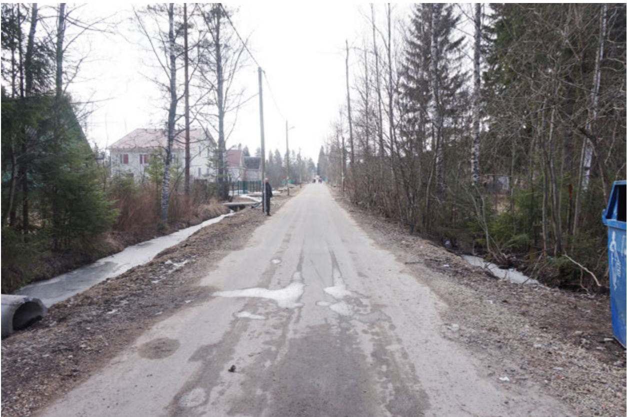
Рис. 25. Ленинградская область, Гатчинский район, п. Прибытково. Прохождение газопровода по ул. Пионеров. Вид с С
