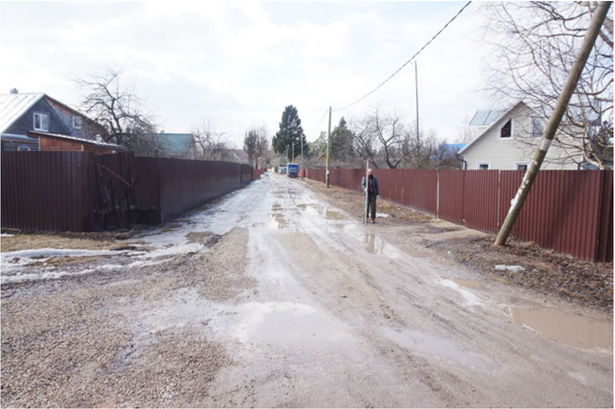
Рис. 30. Ленинградская область, Гатчинский район, п. Прибыtkовo. Прохождение газопровода по ул. Железнодорожников. Вид с СВ
