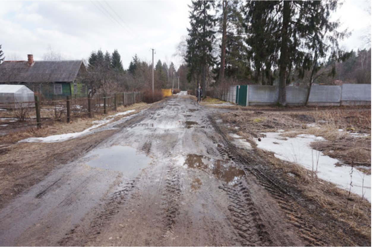
Рис. 12. Ленинградская область, Гатчинский район, п. Прибыtkовo. Прохождение газопровода по ул. Речной . Вид с СЗ
