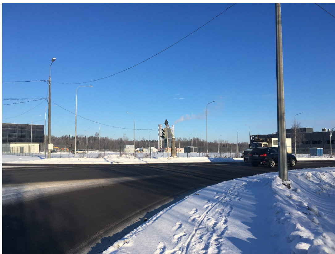
2. Объект культурного наследия «Столбы верстовые» (Ленинградская область, Гатчинский район, г. Гатчина, Пушкинское шоссе, верстовой столб № 1, 43 километр). Вид с юга. Дата фотофиксации: 08.02.2021
