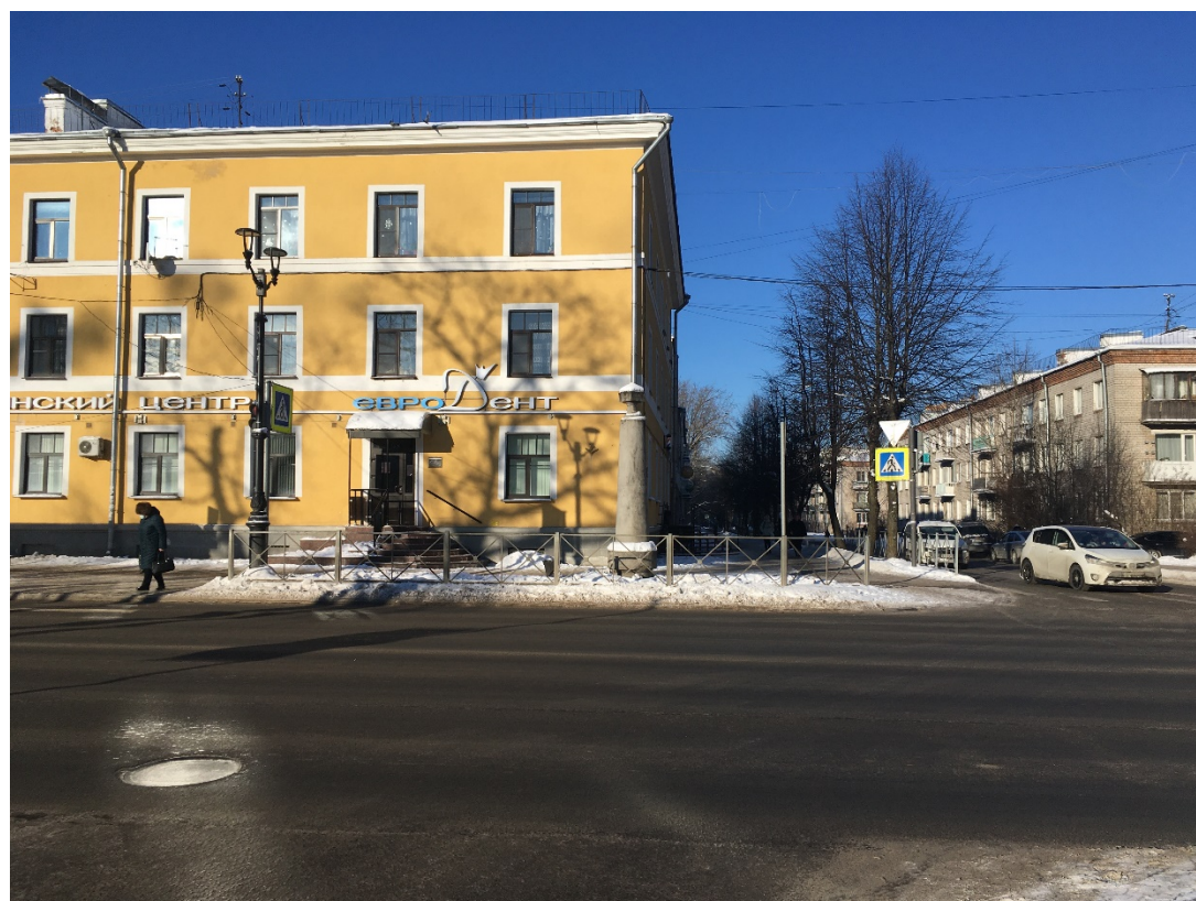
7. Объект культурного наследия «Столбы верстовые» (Ленинградская область, Гатчинский район, г. Гатчина, Пушкинское шоссе, верстовой столб № 2, 44 километр). Вид с юго-востока. Дата фотофиксации: 08.02.2021
