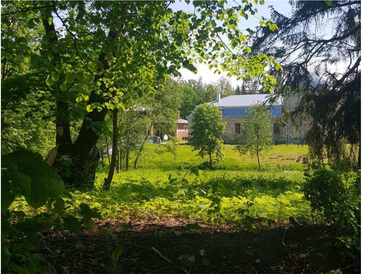
1. Вид здания каменного телятника в ансамбле фермы. Съемка в направлении С-Ю.
