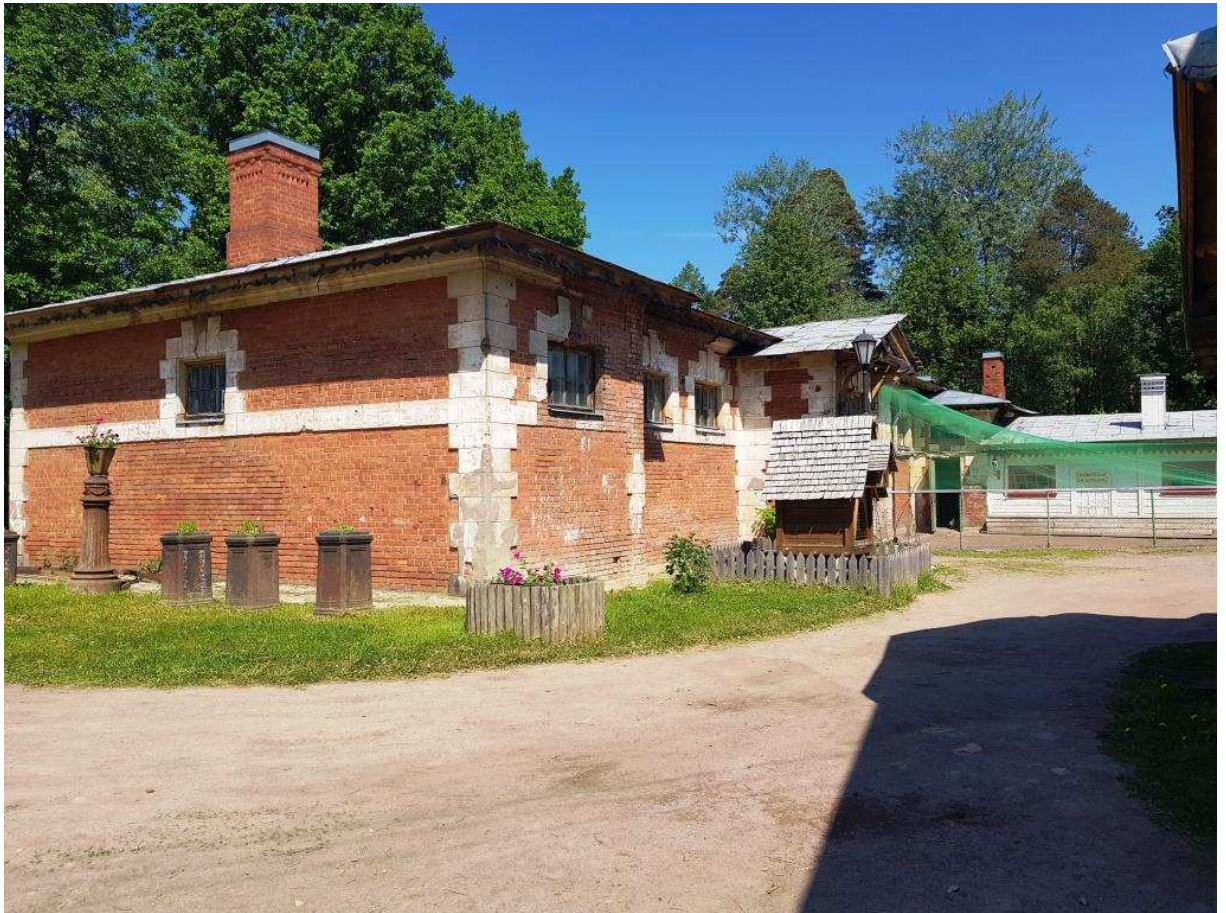
6. Здание телятника. Вид западного и южного фасадов.
