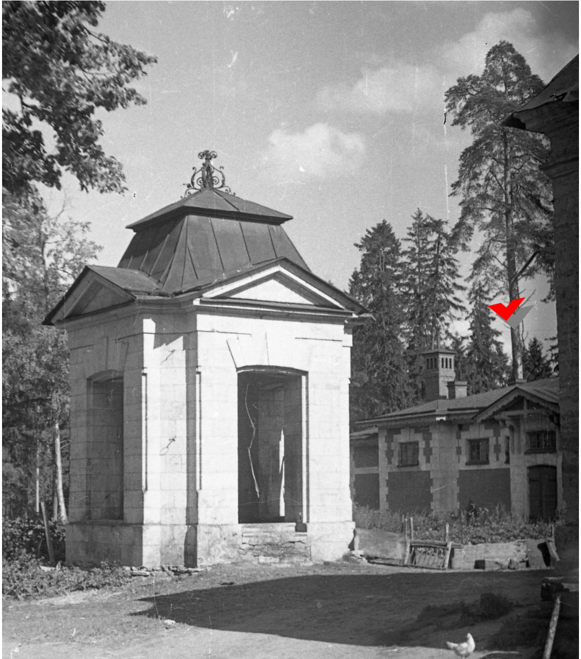
Илл. 10. Павильон над колодцем. На заднем плане справа – каменное здание телятника. Фото 1949 г. ГМЗ «Гатчина». А-221.
