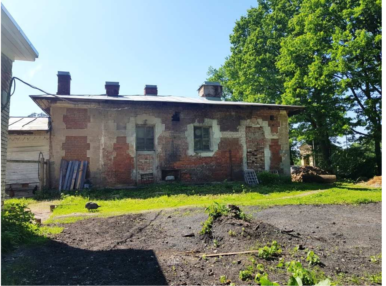
9. Восточный фасад телятника. Общий вид.
