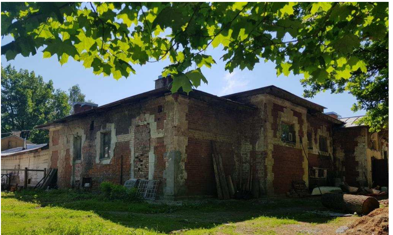
10. Восточный и северны фасады телятника.
