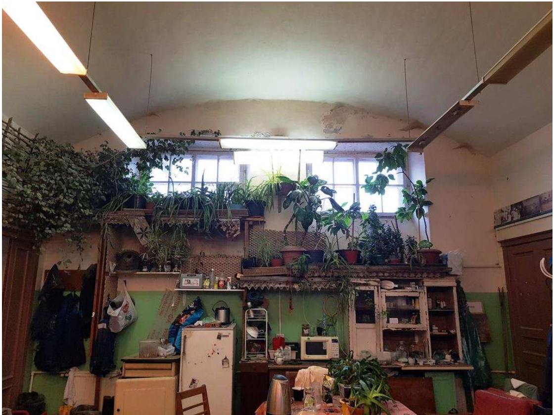
12. Цилиндрический свод в пом. 10, 1-й эт.
