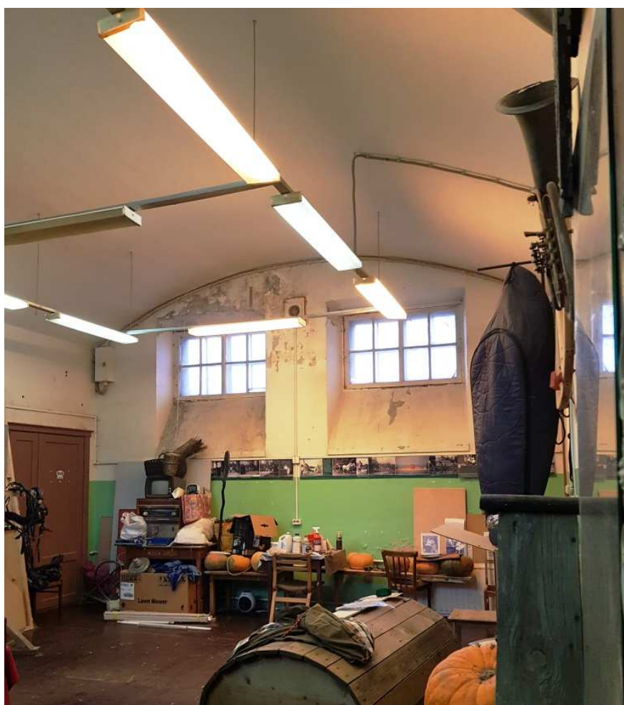
11. Цилиндрический свод в пом. 4, 1-й эт.
