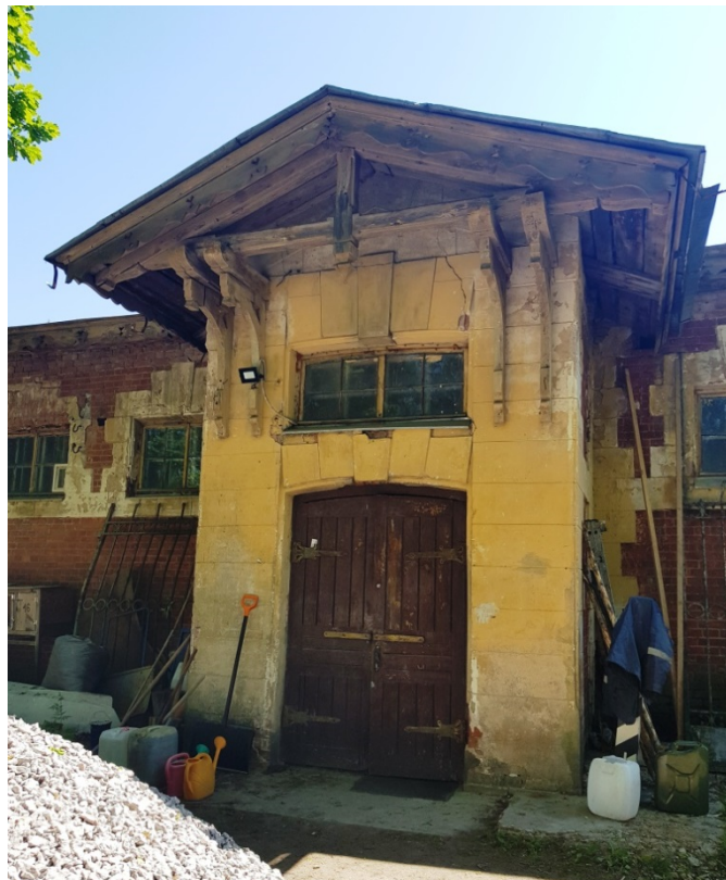
4. Фрагмент северного фасада. Ризалит входа.
