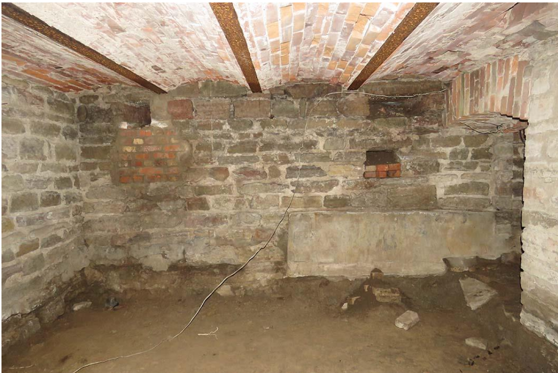
Фото 20. Подвал. Пом. 0.13. Общий вид помещения с юга.
