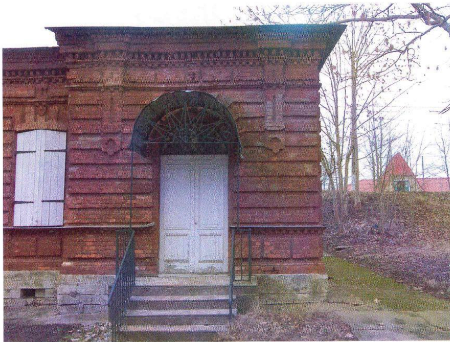
5. Здание б.таможни ("Красный дом"). Г.Ивангород, Кингисеппское ш.д.1. Южный фасад. Фрагмент.
