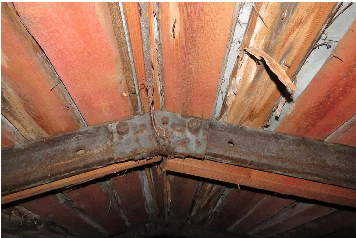
Фото 40. Чердак. Фрагмент соединения стропил.
