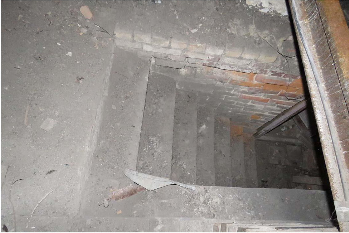
Фото 37. Чердак. Лестница на чердак из пом. 1.6.
