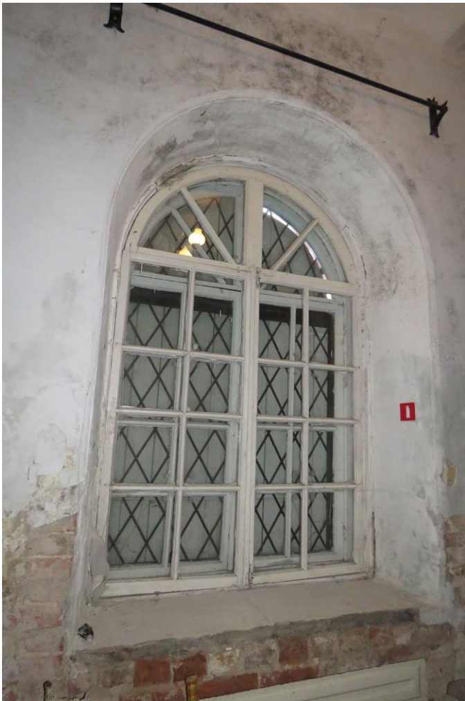
Фото 29. 1-ый этаж. Пом. 1.8. Оконный проем на месте первоначального дверного проема.
