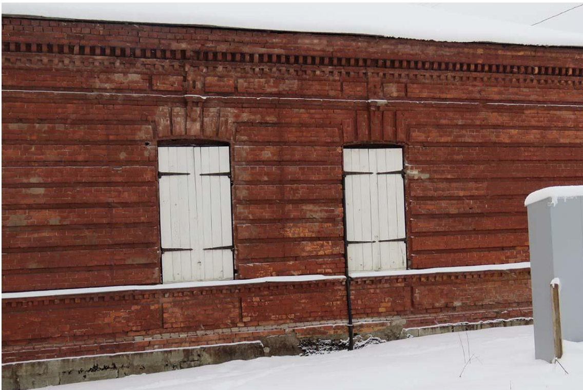
Фото 10. Фрагмент центральной части восточного фасада.
