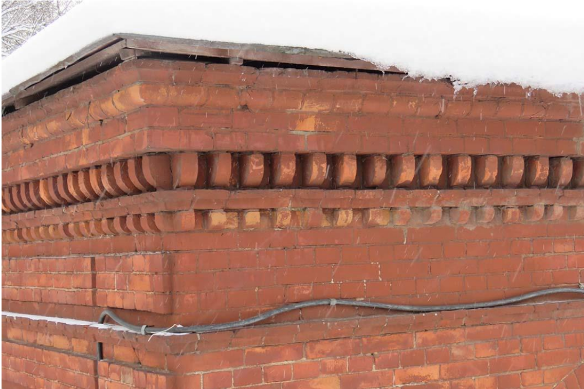
Фото 11. Северо-восточный угол здания. Венчающий карниз.
