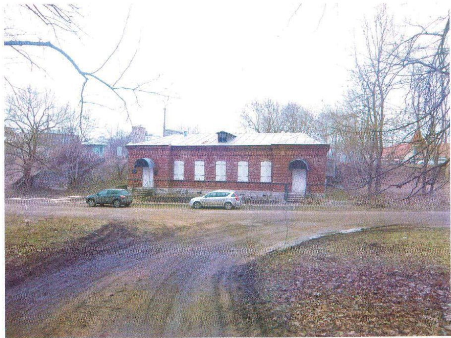
2. Здание б.таможни (“Красный дом”). Г.Ивангород, Кингисеппское ш.д.1. Южный фасад. Общий вид.
