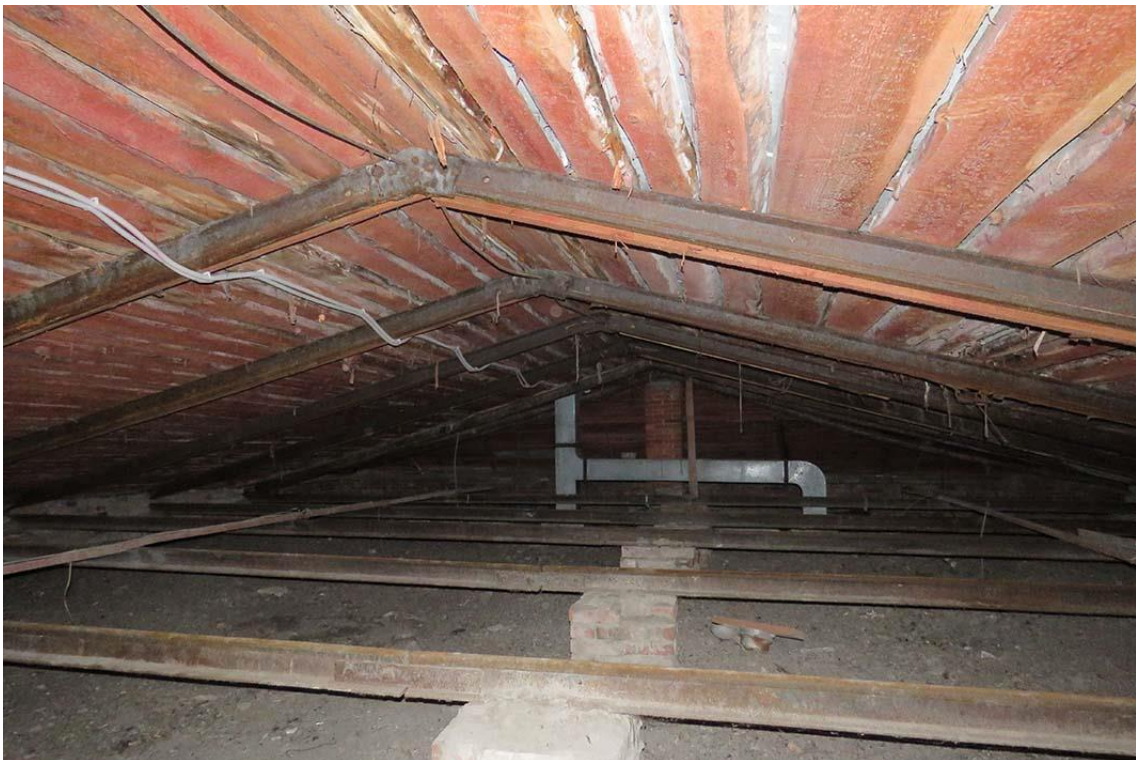
Фото 38. Чердак. Общий вид помещения с востока.
