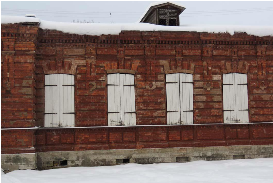
Фото 9. Фрагмент центральной части южного фасада.
