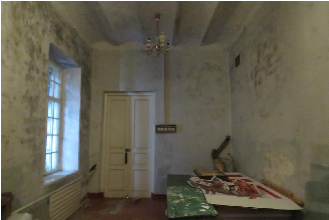
Фото 28. 1-ый этаж. Пом. 1.8. Общий вид помещения с севера.
