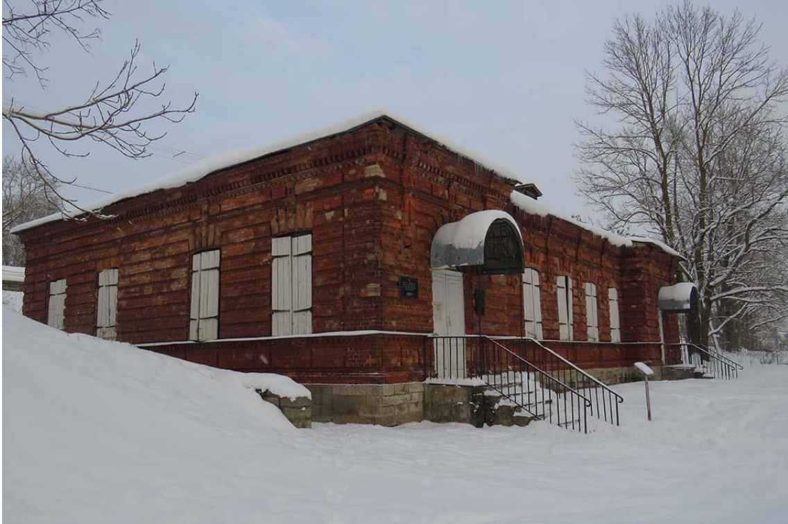
Фото 1. Общий вид здания с юго-запада.
