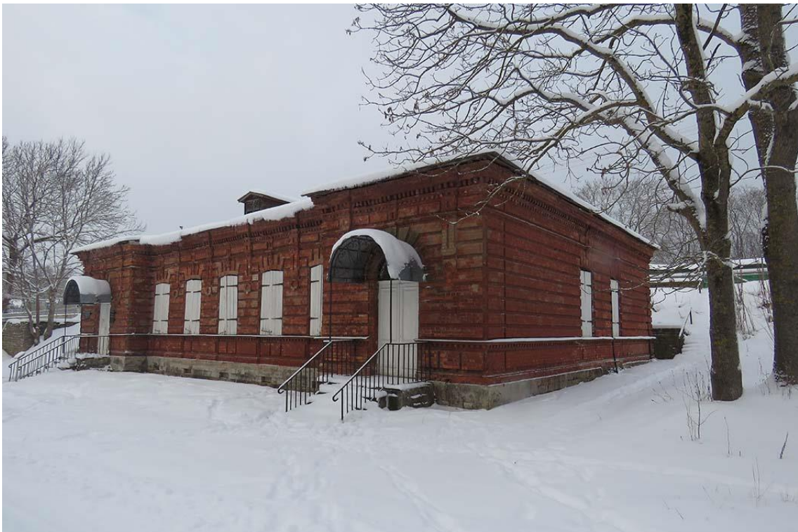
Фото 2. Общий вид здания с юго-востока.
