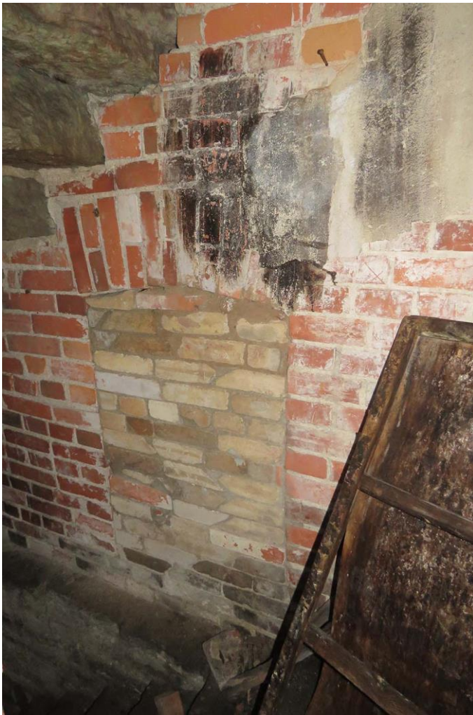
Фото 15. Подвал. Пом. 0.1. Заложённый проем.
