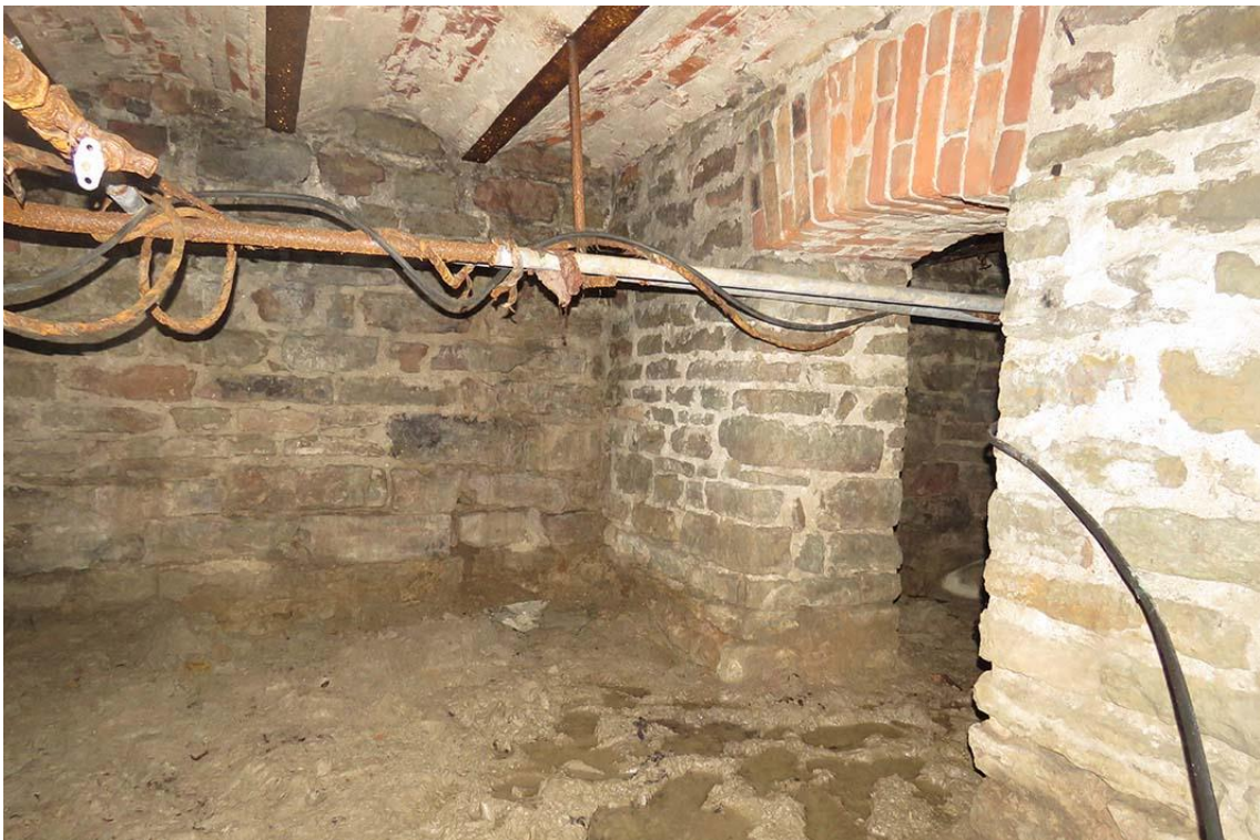
Фото 16. Подвал. Пом. 0.3. Вид на помещение с северо-запада.
