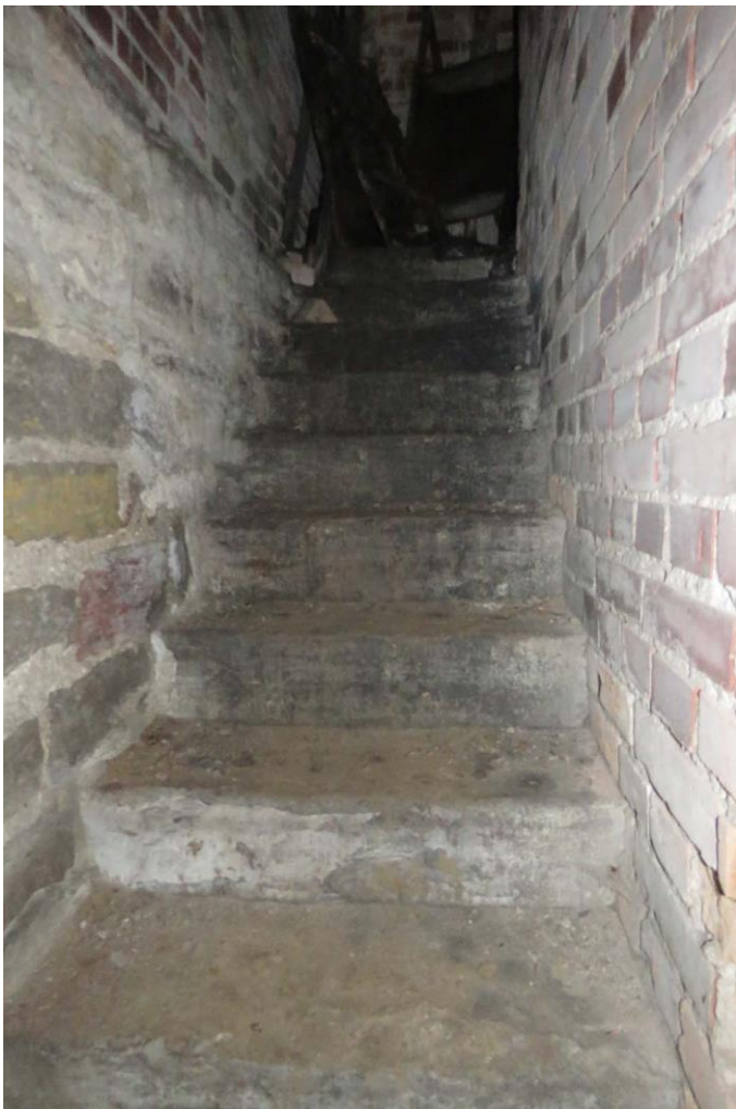
Фото 14. Подвал. Пом. 0.1. Известняковая лестница.
