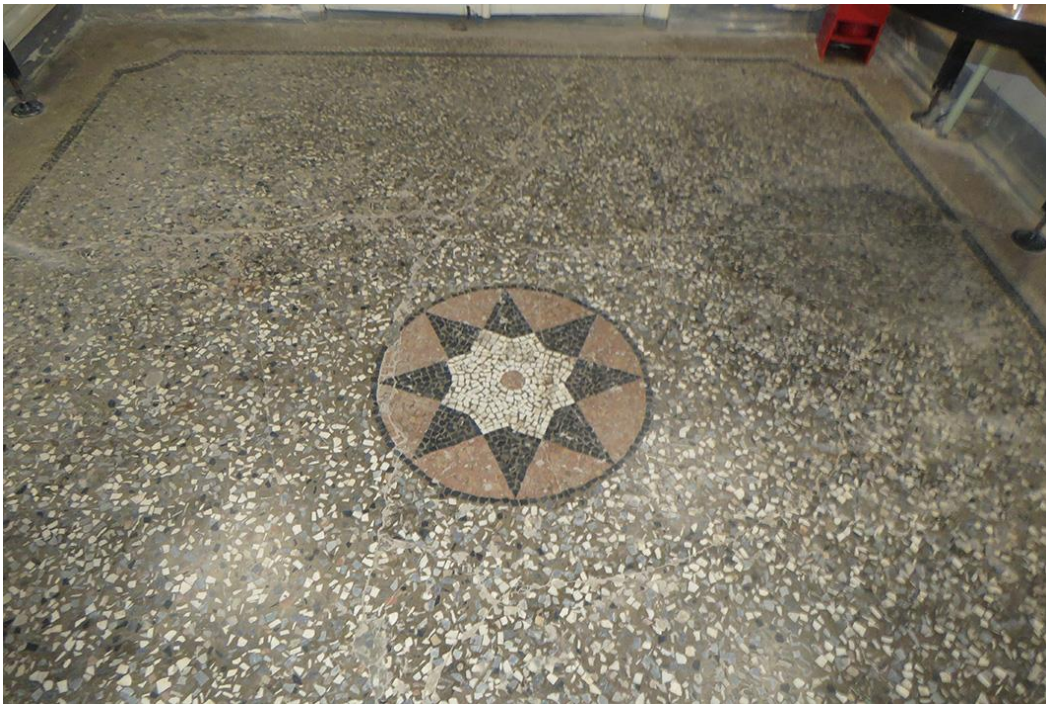
Фото 32. 1-ый этаж. Пом. 1.9. Фрагмент мозаичного декоративного пола в южной части помещения.
