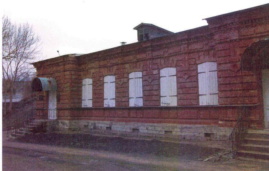
3. Здание б.таможни (“Красный дом”). Г.Ивангород, Кингисеппское ш.д.1. Южный фасад. Фрагмент.
