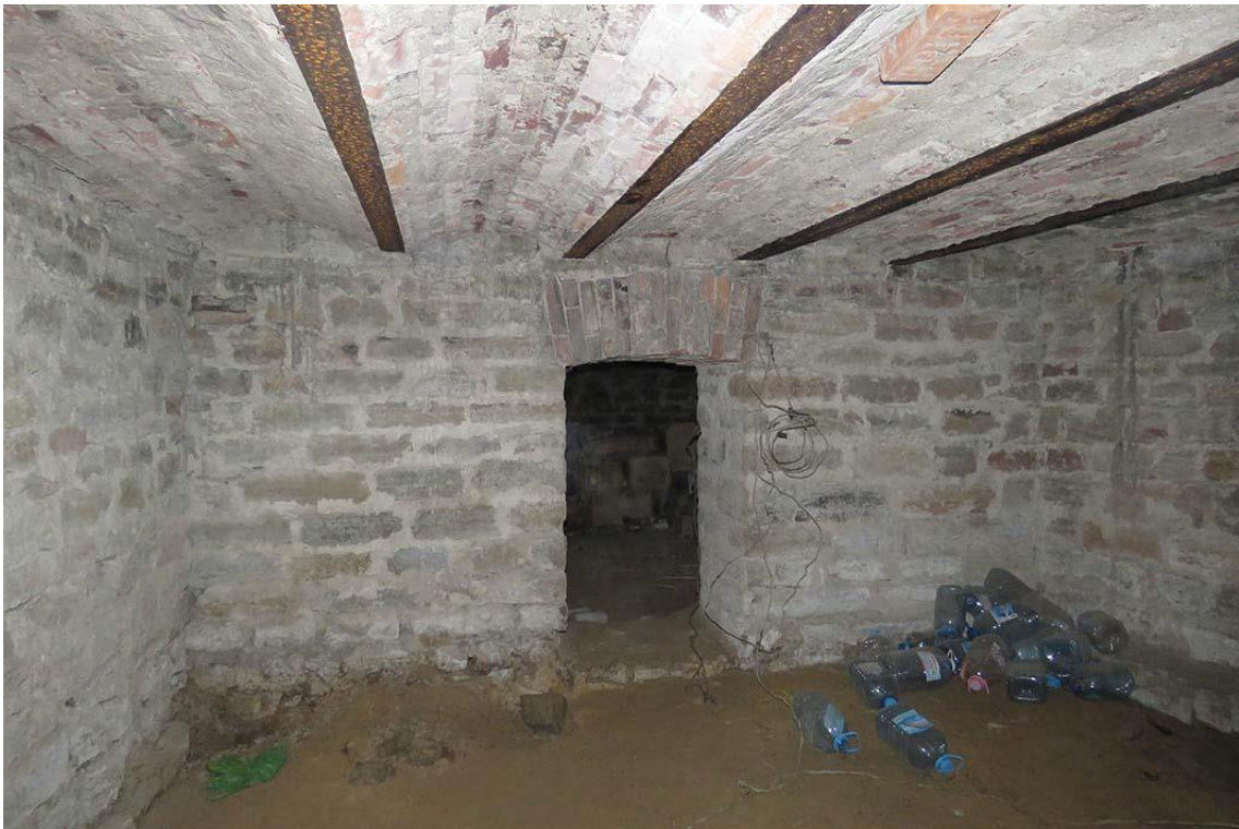
Фото 19. Подвал. Пом. 0.12. Общий вид помещения с запада.
