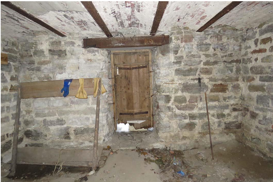
Фото 18. Подвал. Пом. 0.10. Вид на западную стену с востока.
