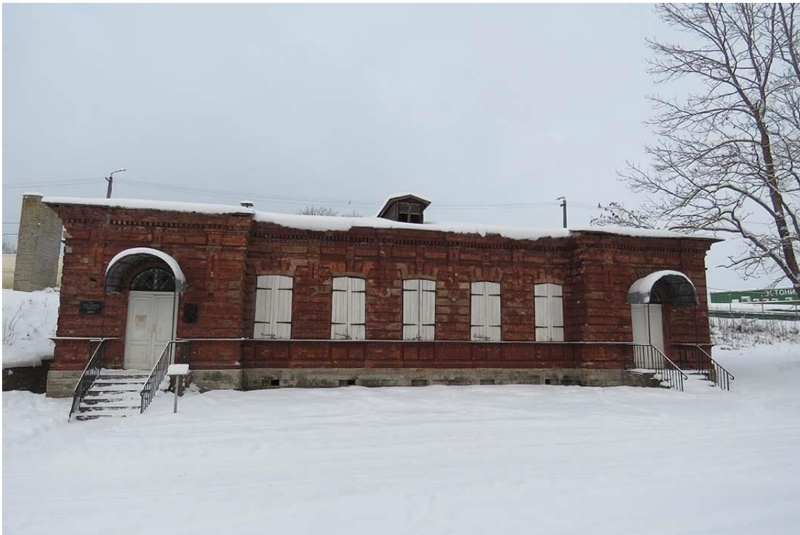
Фото 3. Общий вид южного фасада.
