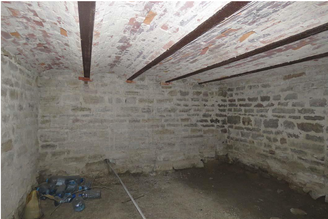
Фото 17. Подвал. Пом. 0.7. Общий вид помещения с юга.
