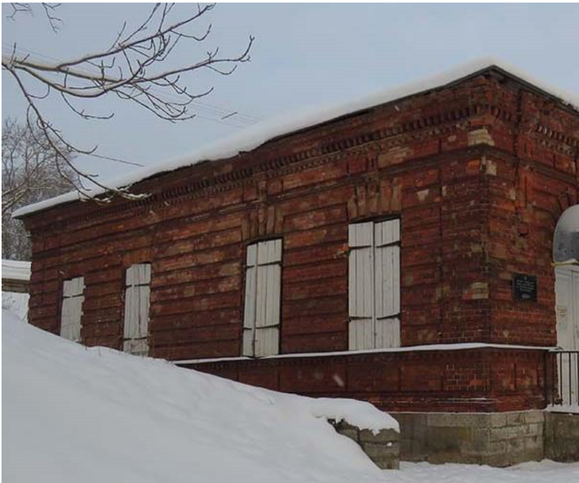
Фото 4. Общий вид западного фасада с юго-запада.
