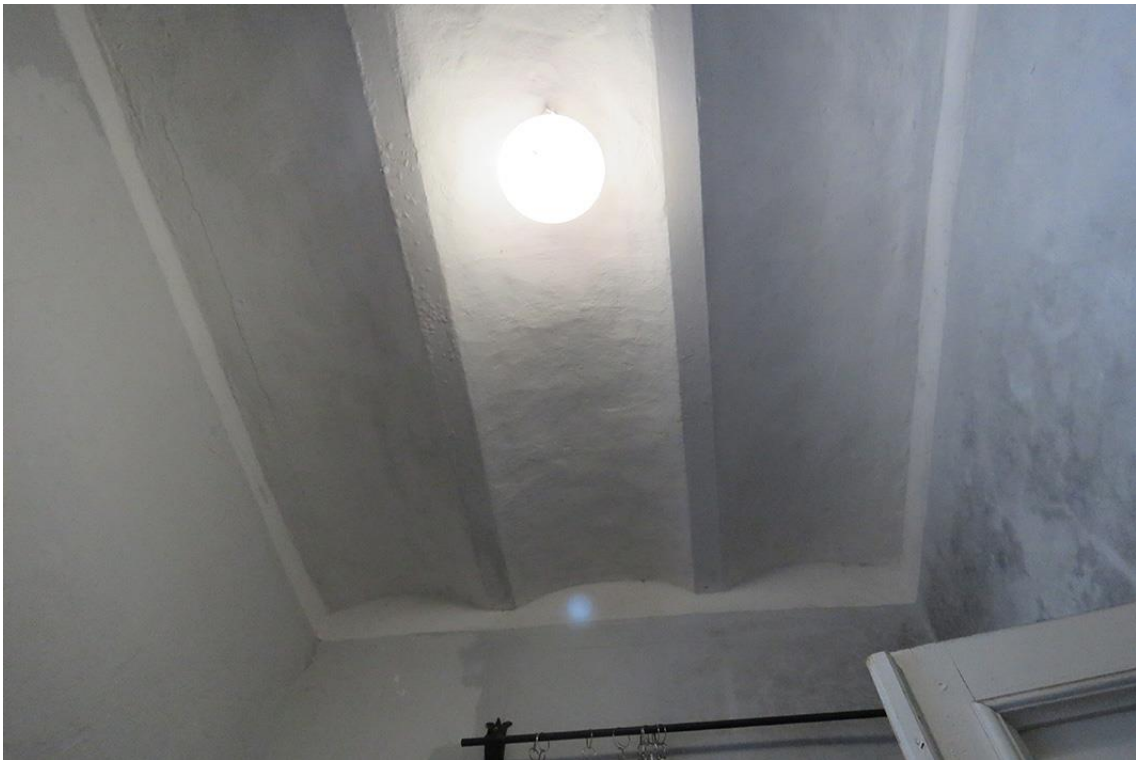
Фото 27. 1-ый этаж. Пом. 1.6. Фрагмент перекрытия.
