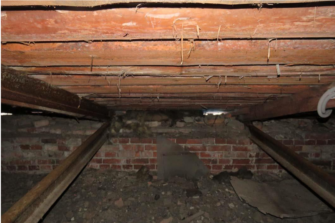
Фото 39. Чердак. Северный скат. Поздние металлические балки стропильной системы.
