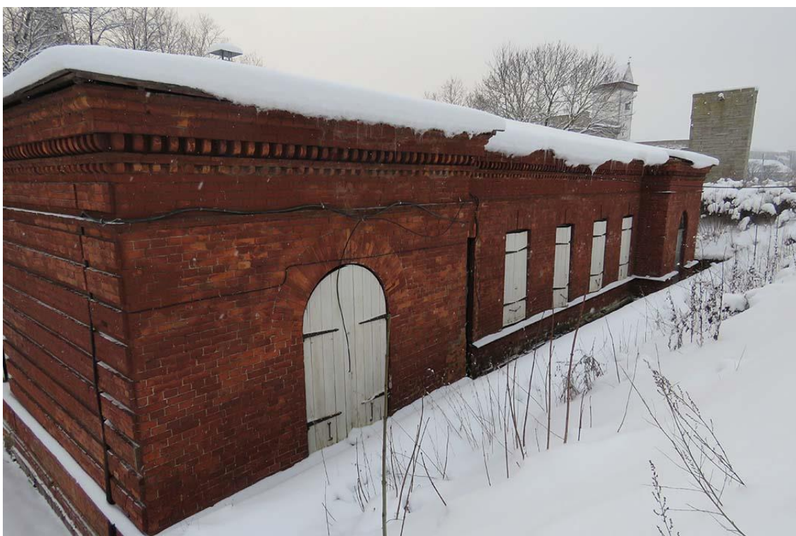
Фото 6. Общий вид северного фасада с северо-востока.
