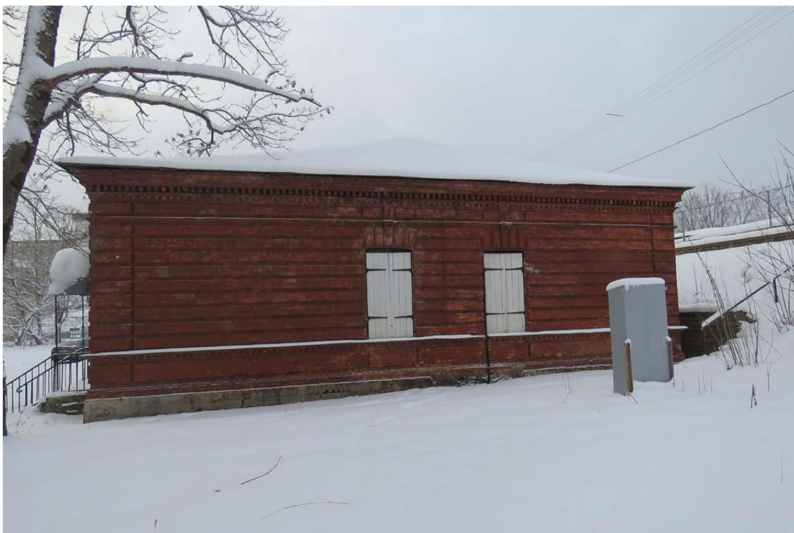
Фото 5. Общий вид восточного фасада.
