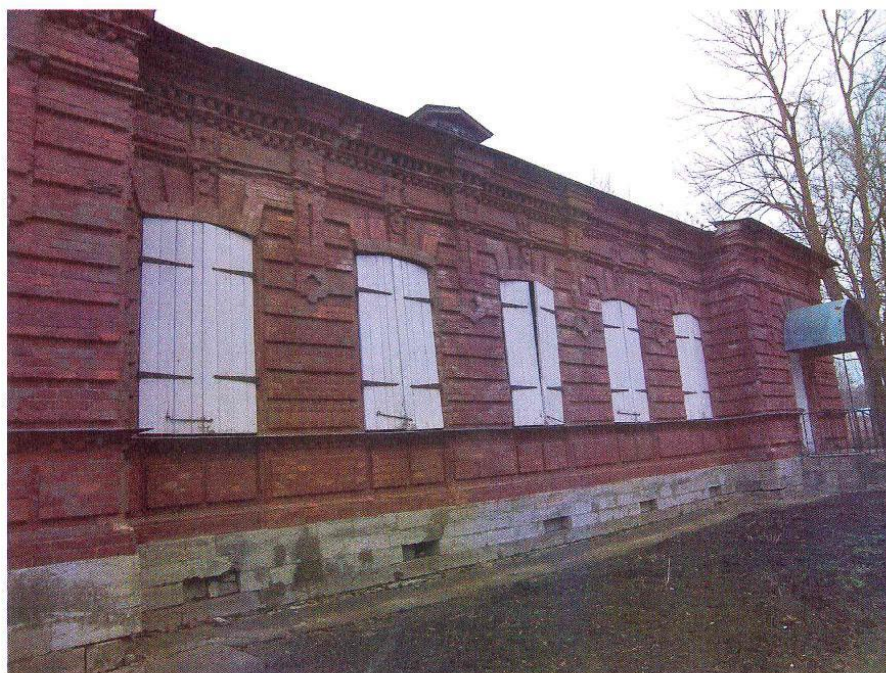
4. Здание б.таможни (“Красный дом”). Г.Ивангород, Кингисеппское ш.д.1. Южный фасад. Фрагмент.
