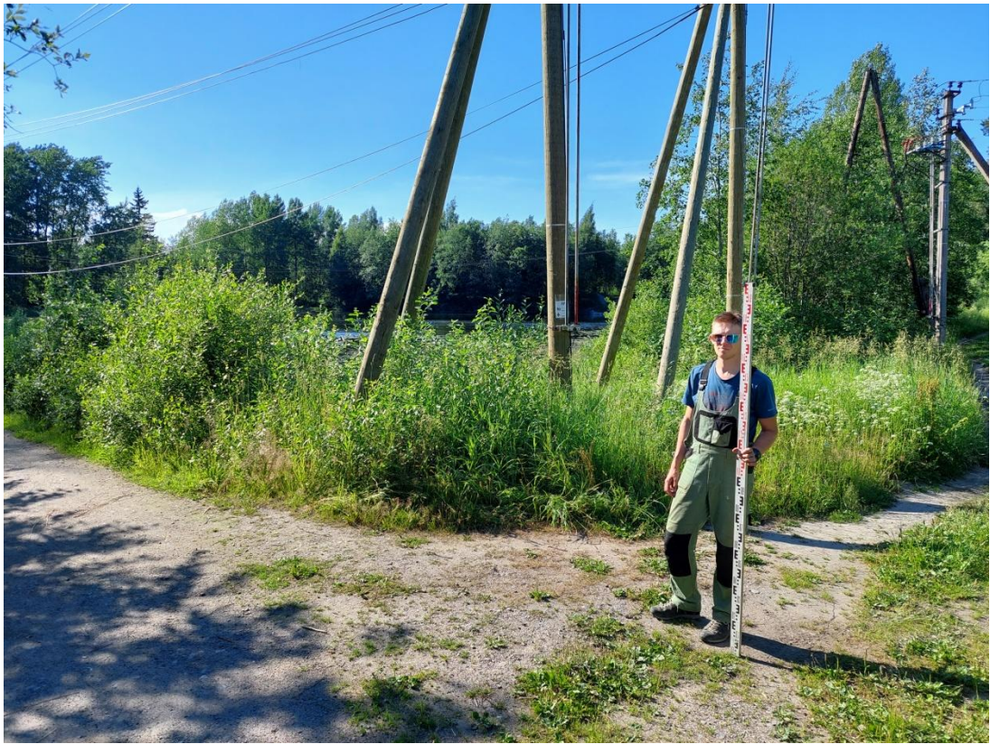
Рис. 15. Ленинградская область, Приозерский район, Кузнечинское городское поселение, пос. Кузнечное – 2021 г. Точка фотофиксации №2. Вид с ЮВ.
