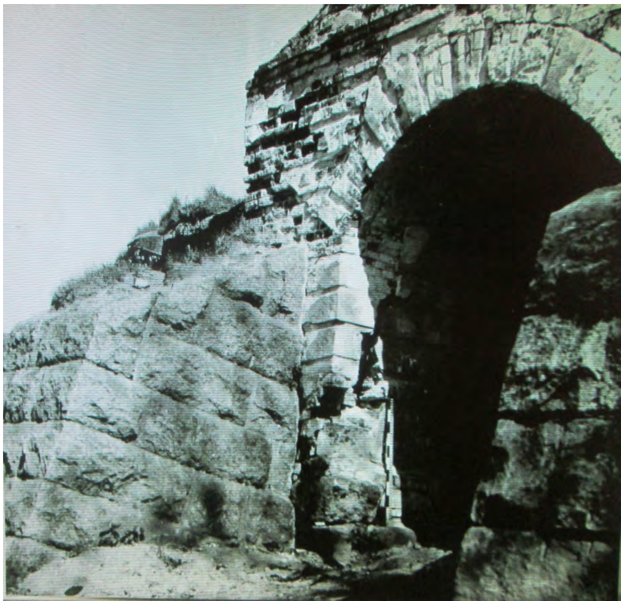
106. Круглая башня. Контрфорсы, пристроенные к portalу во время реставрации 1908г. Министерство Культуры РСФСР. Трест «Росреставрация». Ленинградская Областная СНРПИМ. Материалы исследований. Фотофиксация. Крепость Корела. Круглая башня в г. Приозерск. Т.Ш. Ленинград. 1977г.
