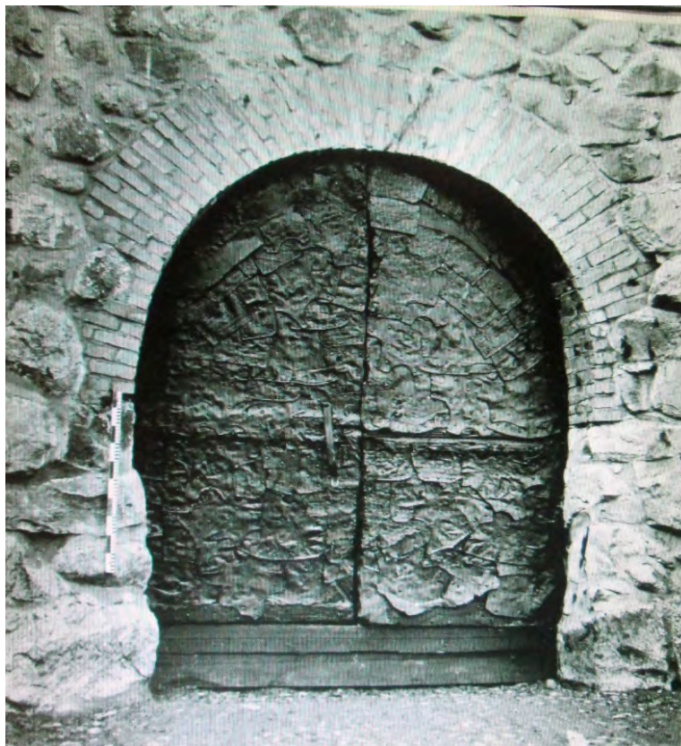
94. Круглая башня. Заполнение воротного проема западного фасада древними воротами, перенесенными из Новой крепости. Вид из башни. Министерство Культуры РСФСР. Трест «Росреставрация». Ленинградская Областная СНРПМ. Материалы исследований. Фотофиксация. Крепость Корела. Круглая башня в г. Приозерск. Т.Ш. Ленинград. 1977г.
