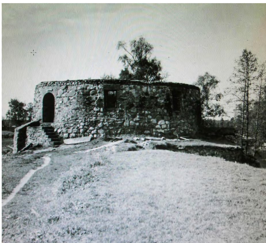
91. Круглая башня. Северный фасад. Министерство Культуры РСФСР. Трест «Росреставрация». Ленинградская Областная СНРПМ. Материалы исследований. Фотофиксация. Крепость Корела. Круглая башня в г. Приозерск. Т.Ш. Ленинград. 1977г.
