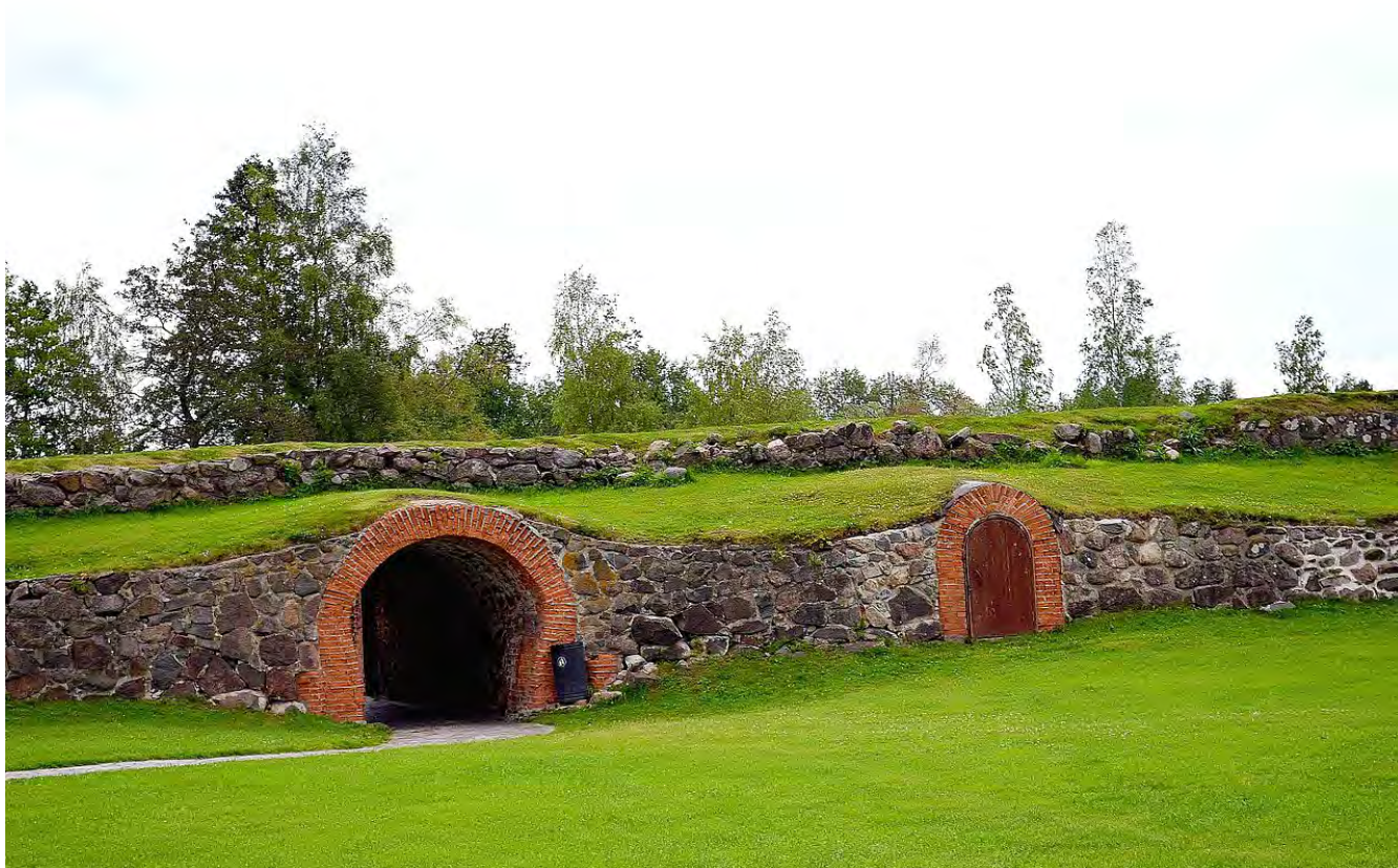
Фото 3.2. Объект культурного наследия федерального значения Крепость "Корела", XIV-XVIII вв., входящий в состав объект культурного наследия федерального значения "Комплекс крепостных сооружений" XIV-XVIII вв.
