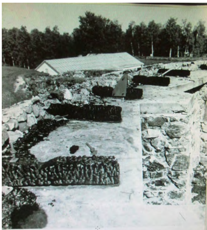
101. Круглая башня. Остатки конструкций шатра. Министерство Культуры РСФСР. Трест «Росреставрация». Ленинградская Областная СНРПМ. Материалы исследований. Фотофиксация. Крепость Корела. Круглая башня в г. Приозерск. Т.Ш. Ленинград. 1977г.
