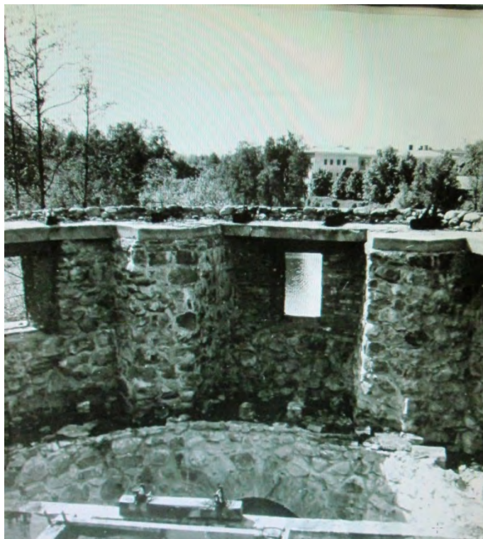
98. Круглая башня. Жел-бет. пояс реставрационных работ 1963г. Вид с востока. Министерство Культуры РСФСР. Трест «Росреставрация». Ленинградская Областная СНРПМ. Материалы исследований. Фотофиксация. Крепость Корела. Круглая башня в г. Приозерск. Т.Ш. Ленинград. 1977г.
