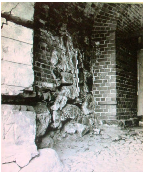
103. Круглая башня. Портал. Состояние северной стены. Министерство Культуры РСФСР. Трест «Росреставрация». Ленинградская Областная СНРПМ. Материалы исследований. Фотофиксация. Крепость Корела. Круглая башня в г. Приозерск. Т.Ш. Ленинград, 1977г.
