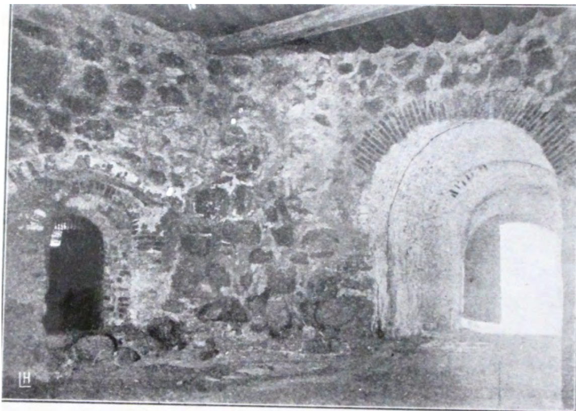
Kuv. 3. Porttihilvi pyöreän tornin sisältä ennen korjaamista.
