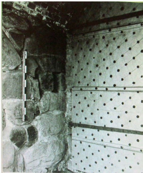
93. Круглая башня. Ниша для запорного бруса ворот. Восточный фасад, правая сторона. Министерство Культуры РСФСР. Трест «Росреставрация». Ленинградская Областная СНРПИМ. Материалы исследований. Фотофиксация. Крепость Корела. Круглая башня в г. Приозерск. Т.Ш. Ленинград. 1977г.
