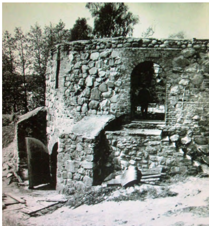
97. Круглая башня. Входной проем верхнего боя. Вид с севера. Министерство Культуры РСФСР. Трест «Росреставрация». Ленинградская Областная СНРПМ. Материалы исследований. Фотофиксация. Крепость Корела. Круглая башня в г. Приозерск. Т.Ш. Ленинград. 1977г.
