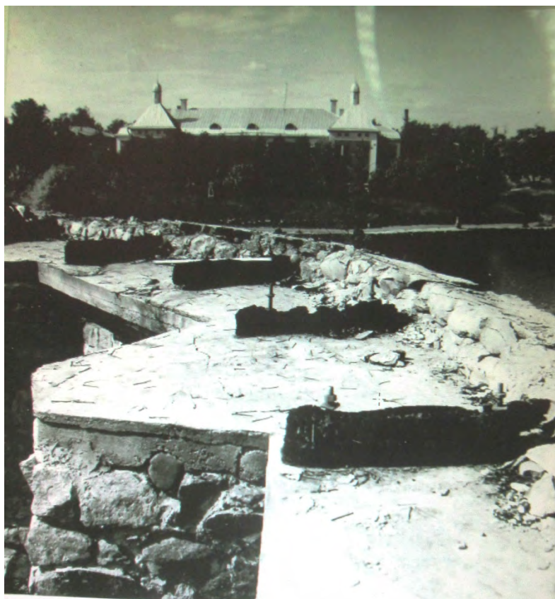
100. Круглая башня. Остатки конструкций шатра. Министерство Культуры РСФСР. Трест «Росреставрация». Ленинградская Областная СНРПМ. Материалы исследований. Фотофиксация. Крепость Корела. Круглая башня в г. Приозерск. Т.Ш. Ленинград. 1977г.
