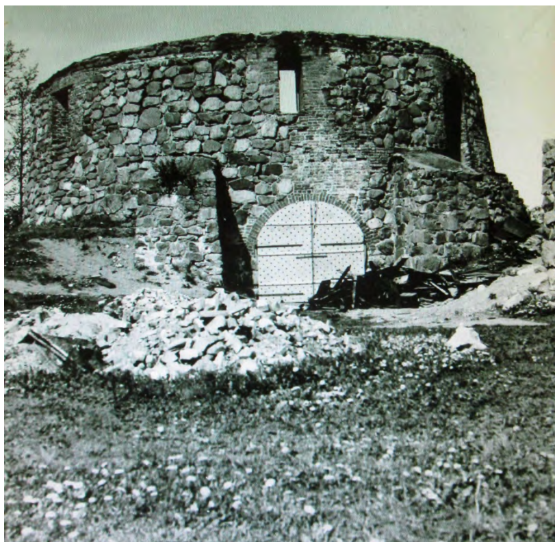
90. Круглая башня. Восточный фасад. Министерство Культуры РСФСР. Трест «Росреставрация». Ленинградская Областная СНРПМ. Материалы исследований. Фотофиксация. Крепость Корела. Круглая башня в г. Приозерск. Т.Ш. Ленинград. 1977г.
