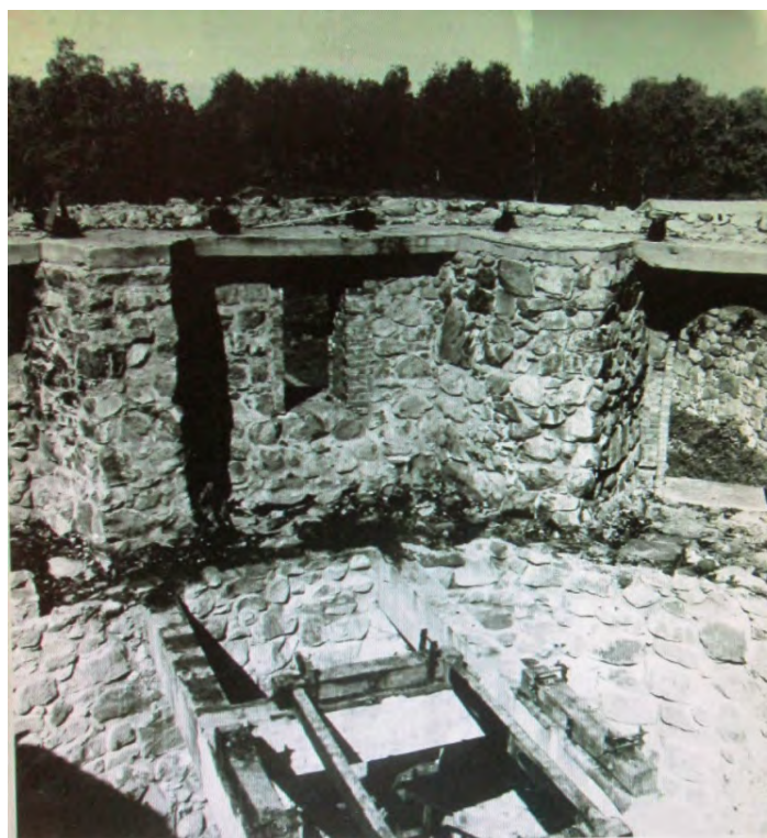
99. Круглая башня. Жел-бет. пояс реставрационных работ 1963г. Вид с юга. Министерство Культуры РСФСР. Трест «Росреставрация». Ленинградская Областная СНРПМ. Материалы исследований. Фотофиксация. Крепость Корела. Круглая башня в г. Приозерск. Т.Ш. Ленинград. 1977г.
