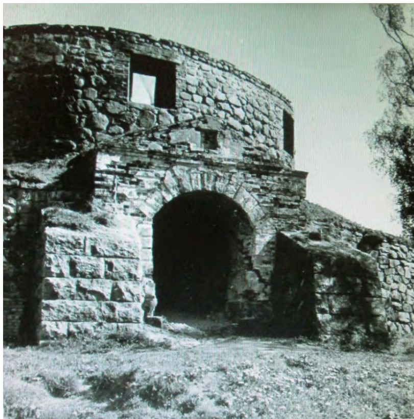
102. Круглая башня. Портал. Вид с запада. Министерство Культуры РСФСР. Трест «Росреставрация». Ленинградская Областная СНРПМ. Материалы исследований. Фотофиксация. Крепость Корела. Круглая башня в г. Приозерск. Т.Ш. Ленинград, 1977г.
