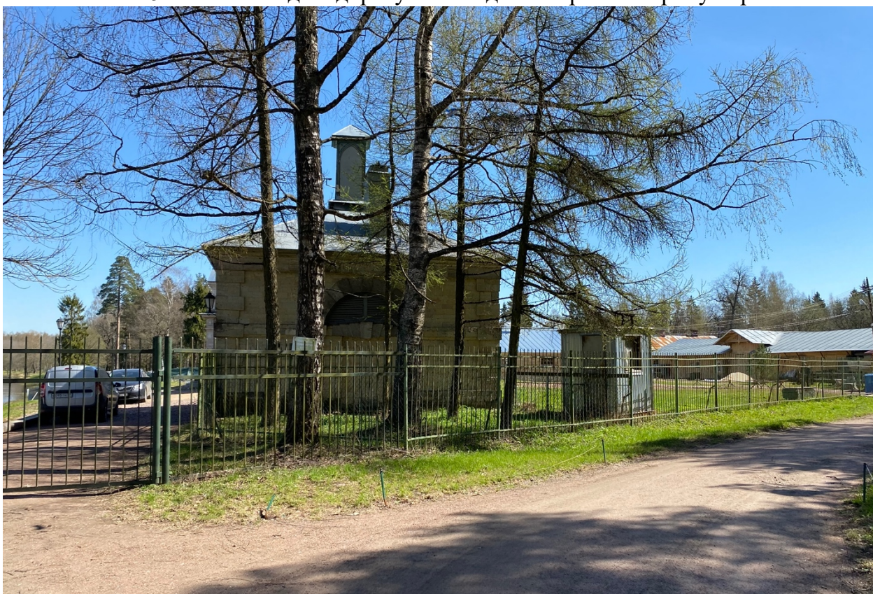
Рис 16. Фото 5. Вид на территорию объекта культурного наследия «Ферма». Место поворота парковой дороги вправо.
