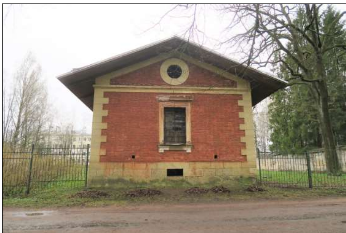
8.Главный фасад караулки. Вид с северо-востока. Фото Н.М.Петуховой.01.05.2021г.
