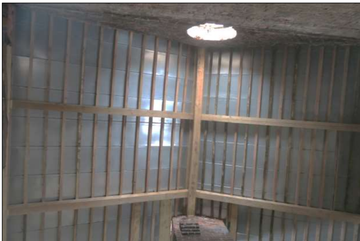
18. Конструкции воссозданной крыши основного объема. Фото Н.М.Петуховой.01.05.2021г.
