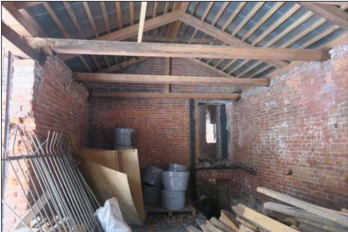
20. Интерьер хозяйственной пристройки. Вид с юго-запада на стену основного объема. Фото Н.М.Петуховой.01.05.2021г.
