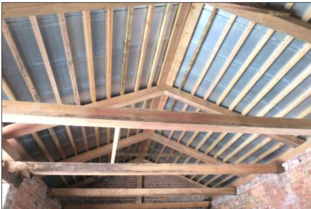
21. Интерьер хозяйственной пристройки. Восстановленные конструкции крыши. Фото Н.М.Петуховой.01.05.2021г.
