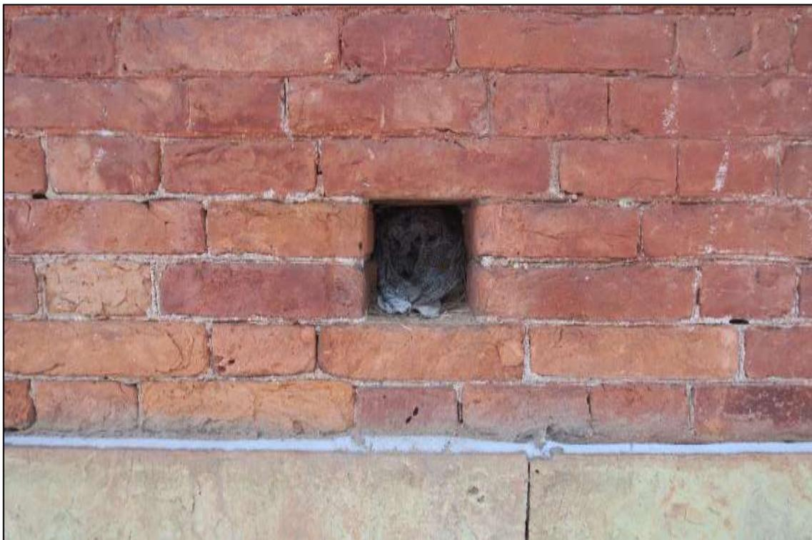
25. Приточное отверстие вентиляционного внутристенного канала на боковом фасаде
