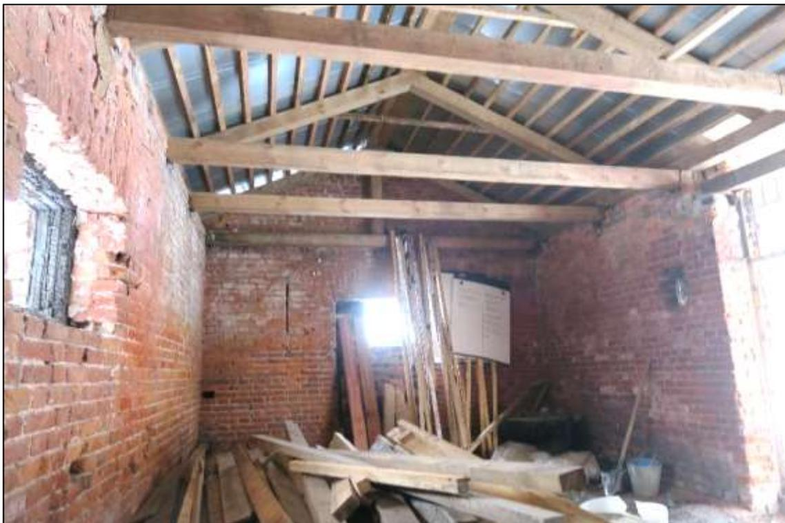
48.Общий вид интерьера пристройки с востока. Видны конструкции воссозданной стропильной системы и несущие балки перекрытия.
