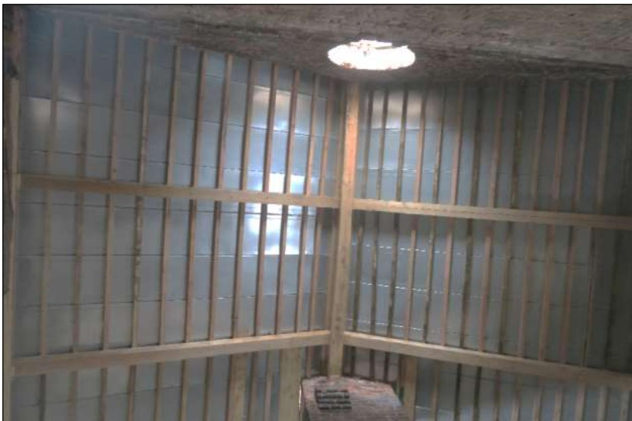
37. Воссозданная конструкция стропильной системы, обрешетка и кровля.
