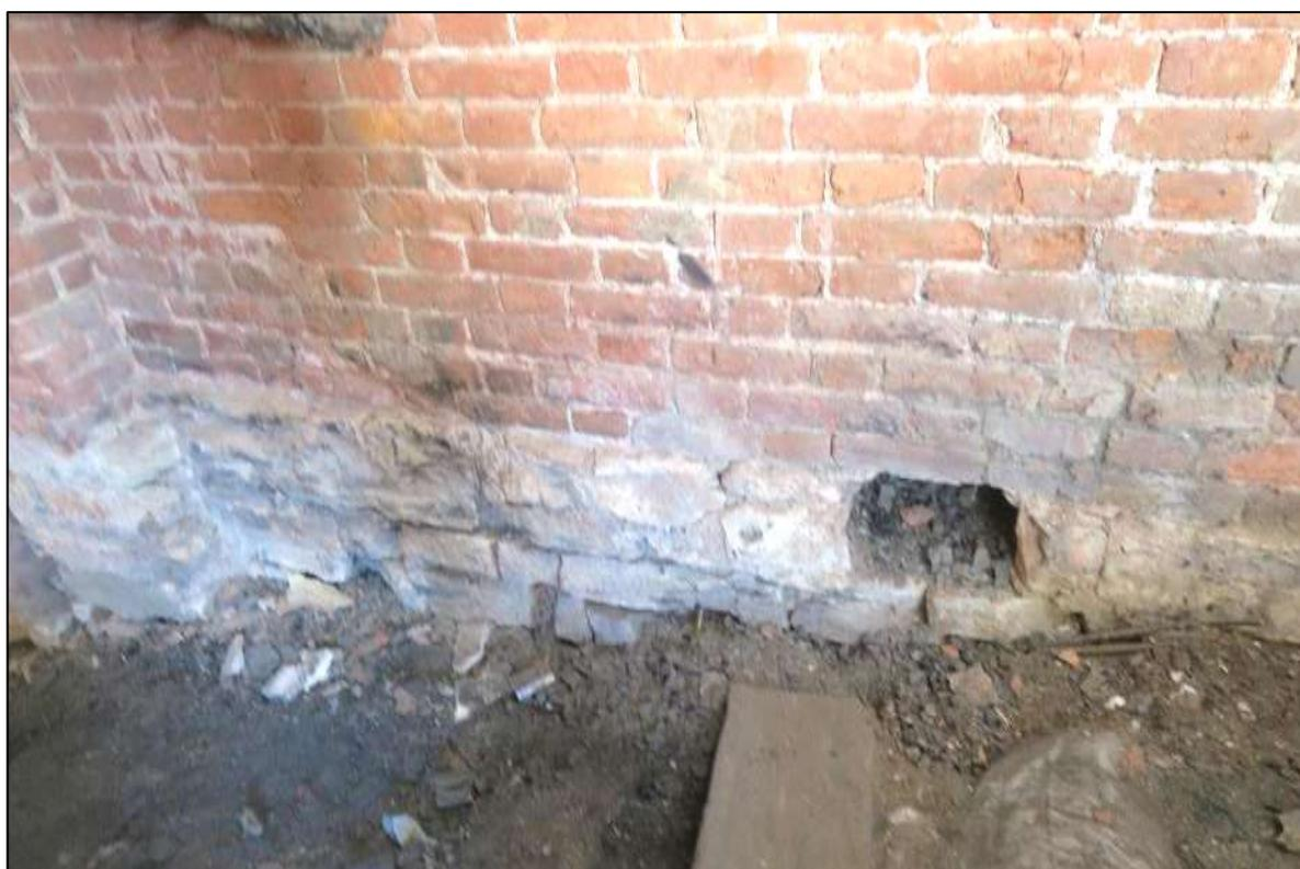
54. Бутовый фундамент юго-восточной стены пристройки в зоне лестницы входа в подвал основного объема.
