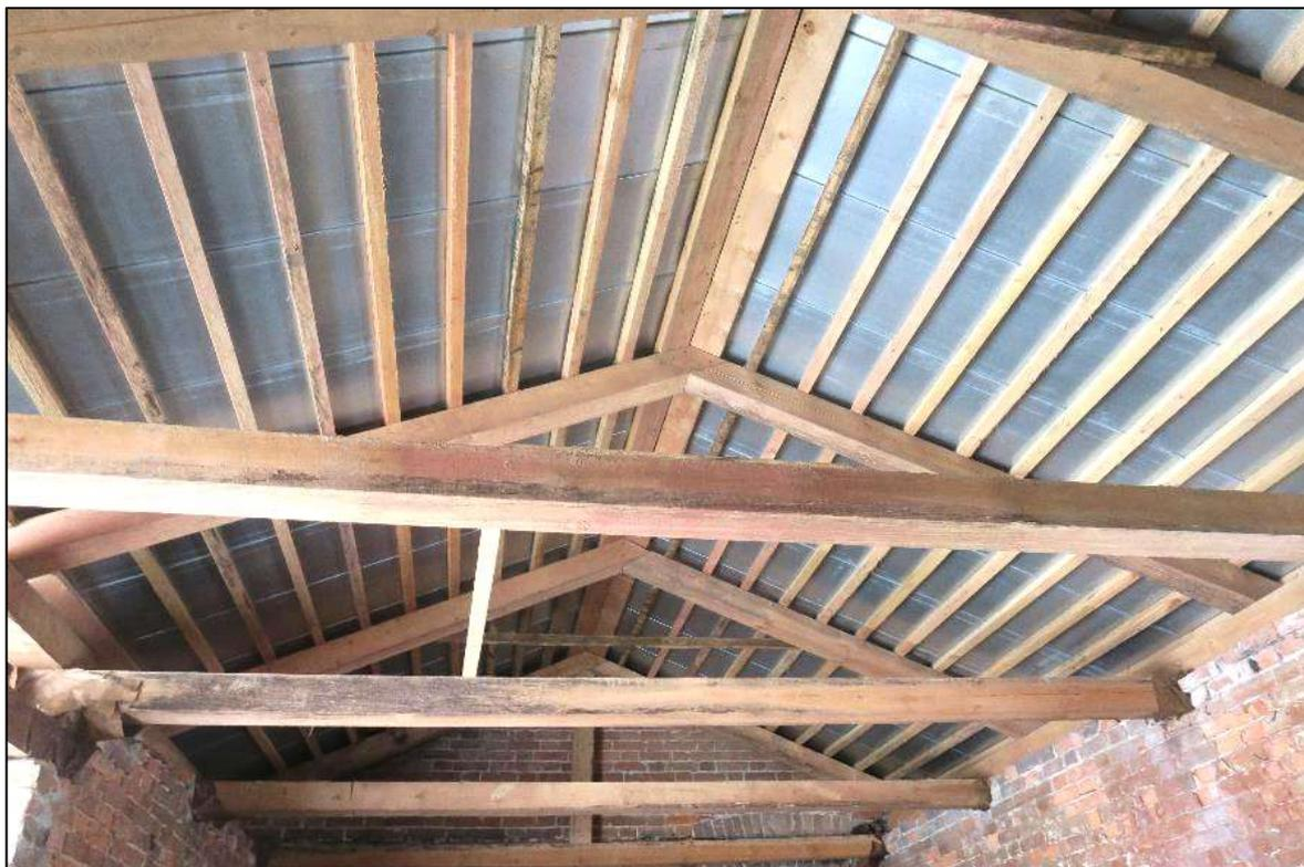
53. Конструкции крыши и несущие балки перекрытия, воссозданные в 2012г.
