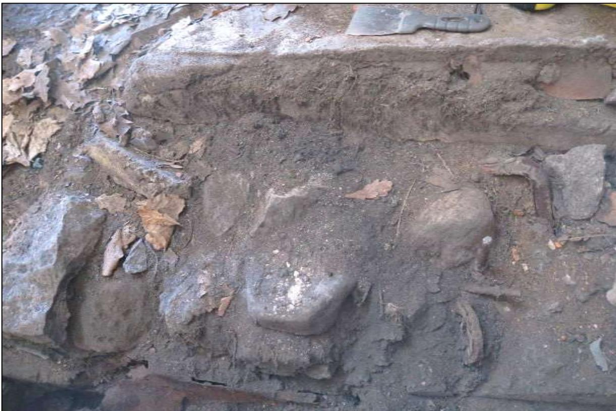
57. Валунная забутовка приемка входа в подвал.
