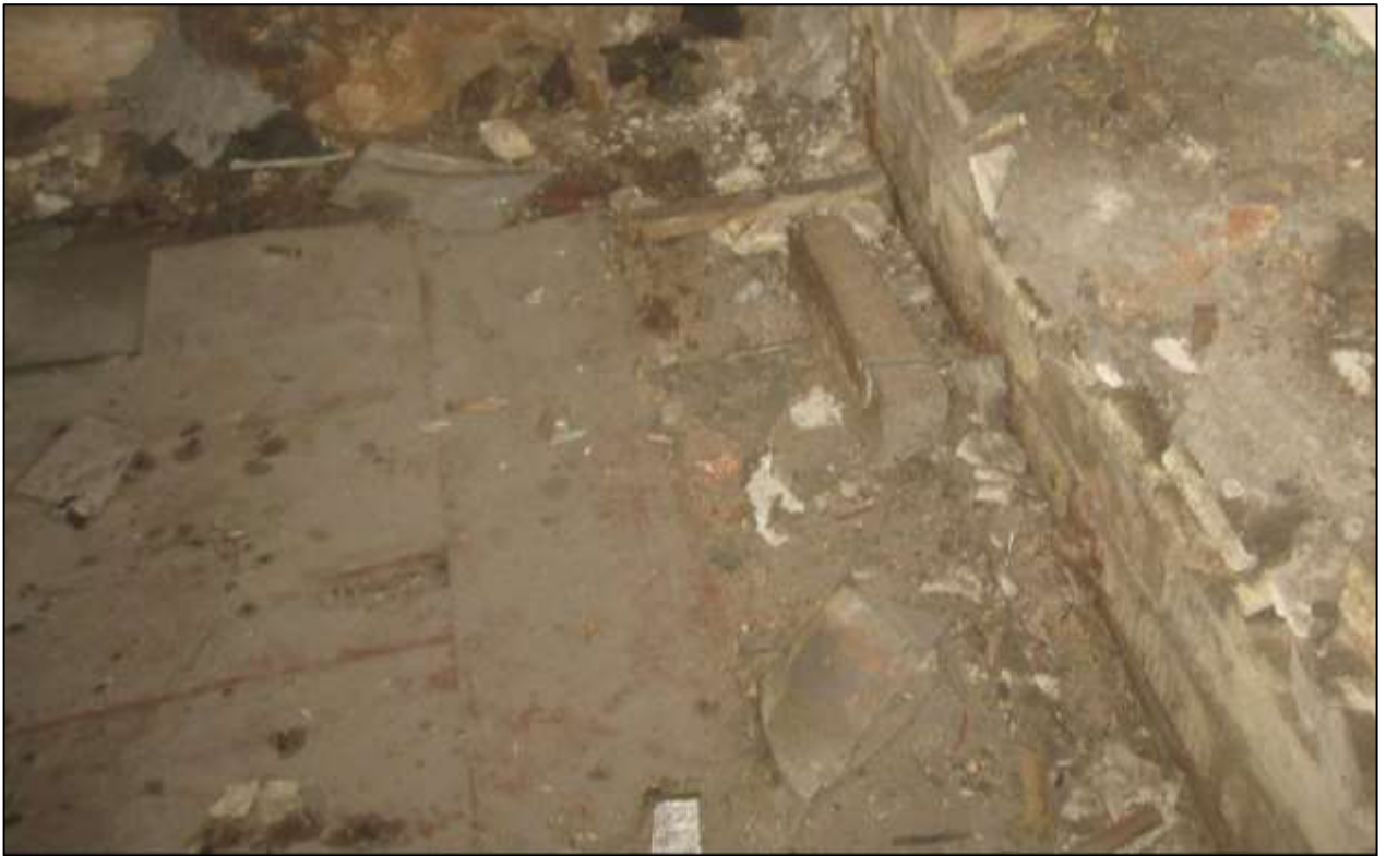
34. Дощатый пол «во фриз». Здание бывшей земской станции. Архангельская обл., г.Вельск, ул.Нечаевского, д.1.
