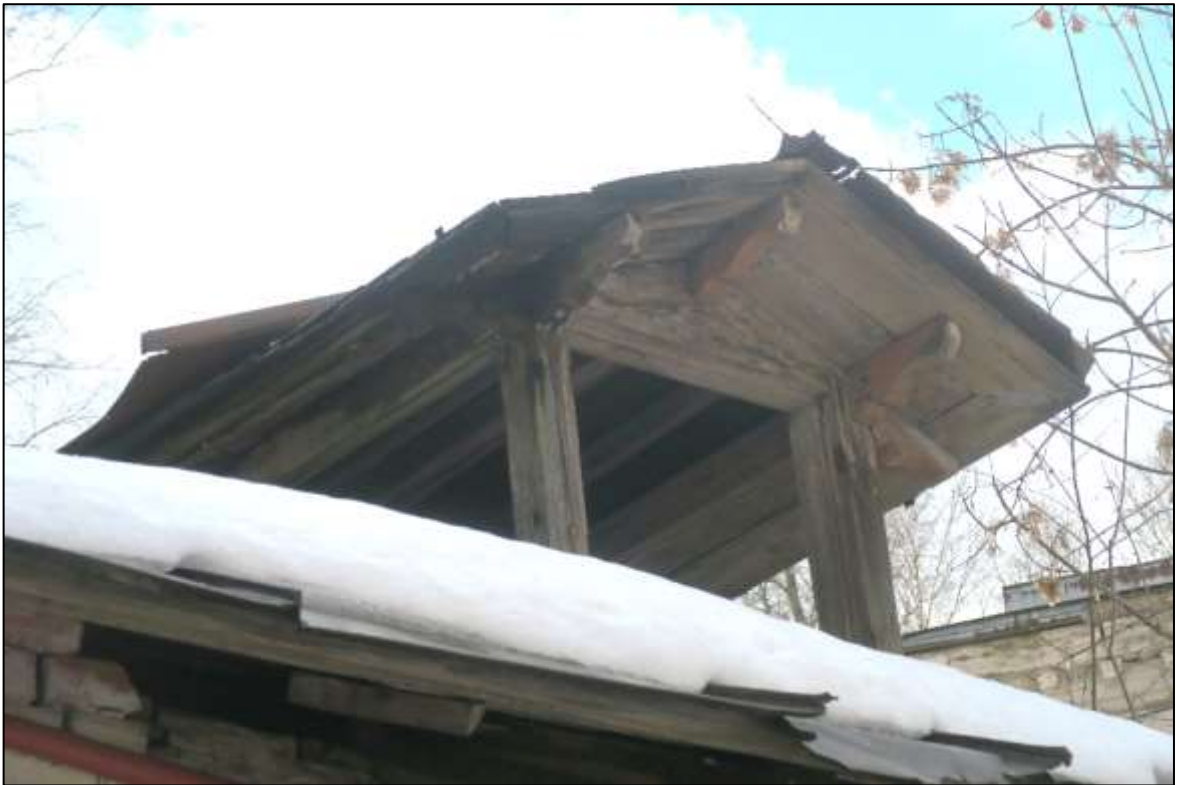
24. Караулка у Березовых ворот. Слуховое окно на кровле хозяйственной пристройки. Декоративная обработка кобылок свесов кровли.
