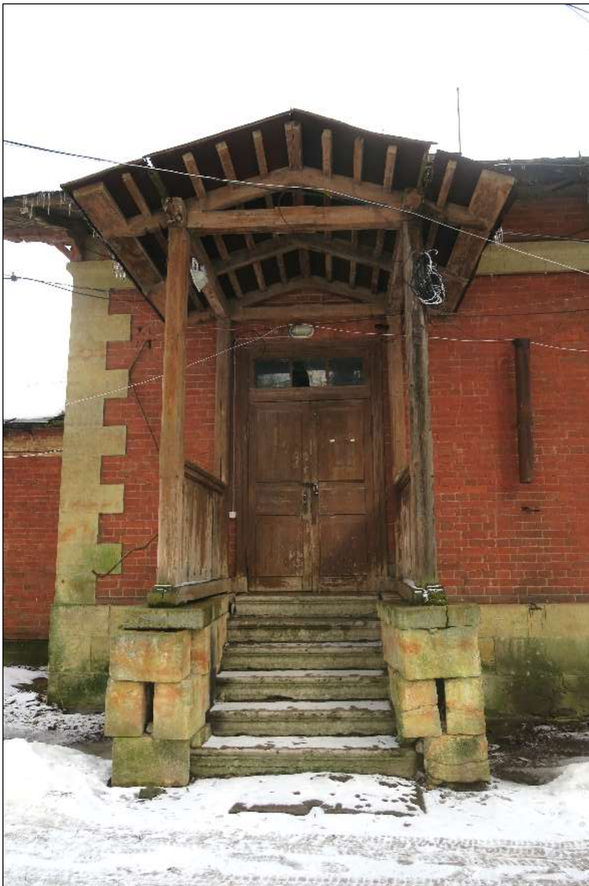
8. Караулка у Березовых ворот. Крыльцо и навес. Фронтальный вид. Характер обработки деталей, цветовое решение. Сохранилось дверное заполнение входного проема с остекленной фрамугой.
