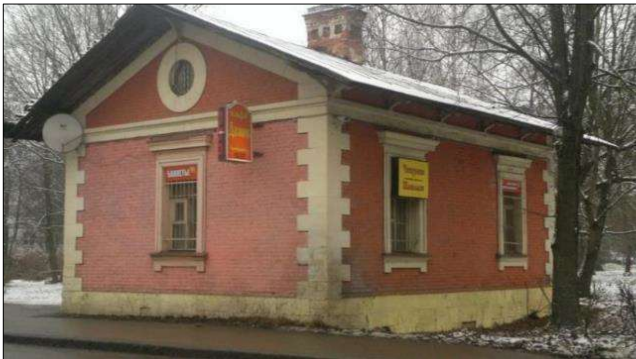
26. Караулка на ул. Хохлова, д. 1. Сохранилась дымовая труба.
