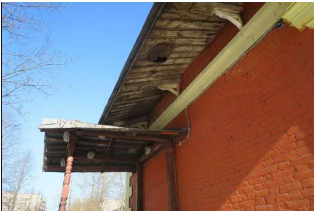
18. Караулка на ул.Хохлова, д.1. Свес кровли на боковом фасаде. Ритм кобылок и кронштейнов. Видна воронка водосточной трубы.
