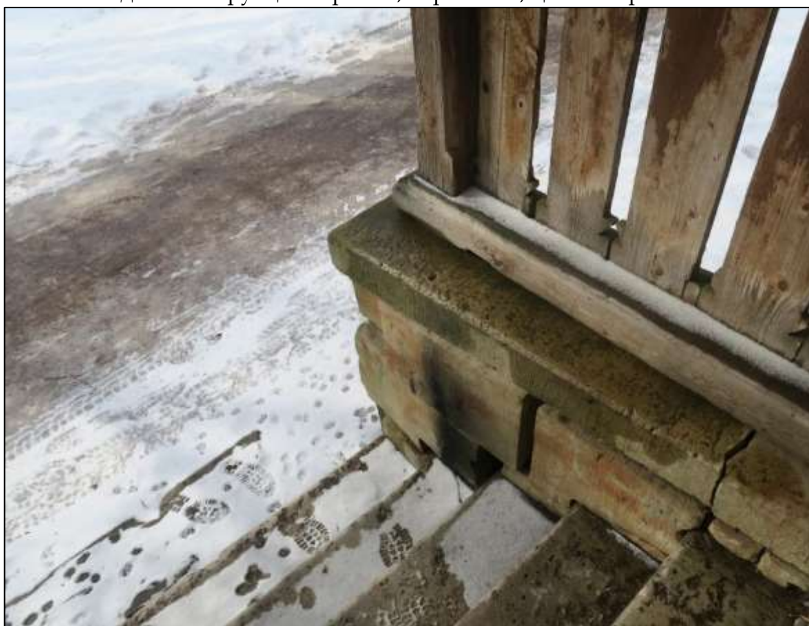
12. Караулка у Березовых ворот. Крыльцо. Нижняя обвязка и доски ограждения.
