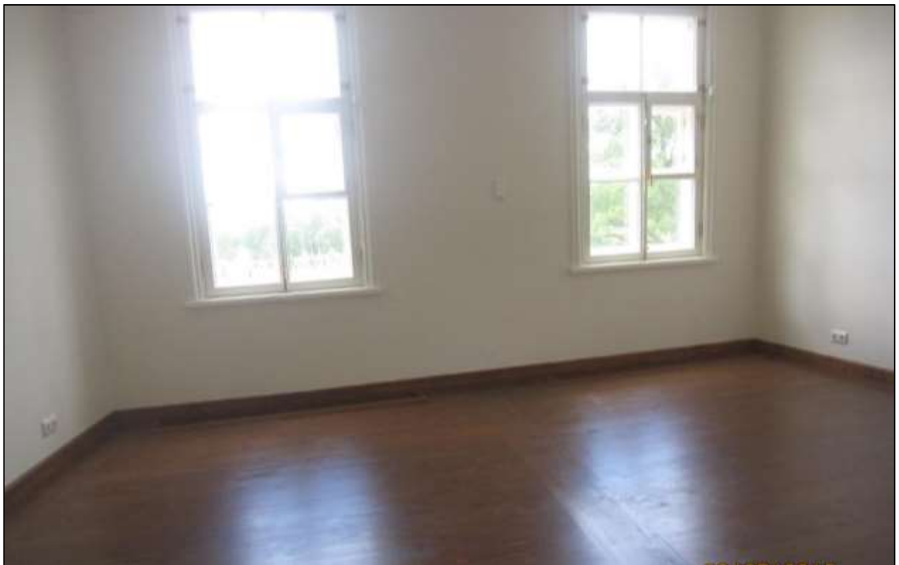
35. Дощатые полы «во фриз» в западном полуциркуле Большого Меншиковского дворца в Ораниенбауме. Воссозданы в 2013г.
