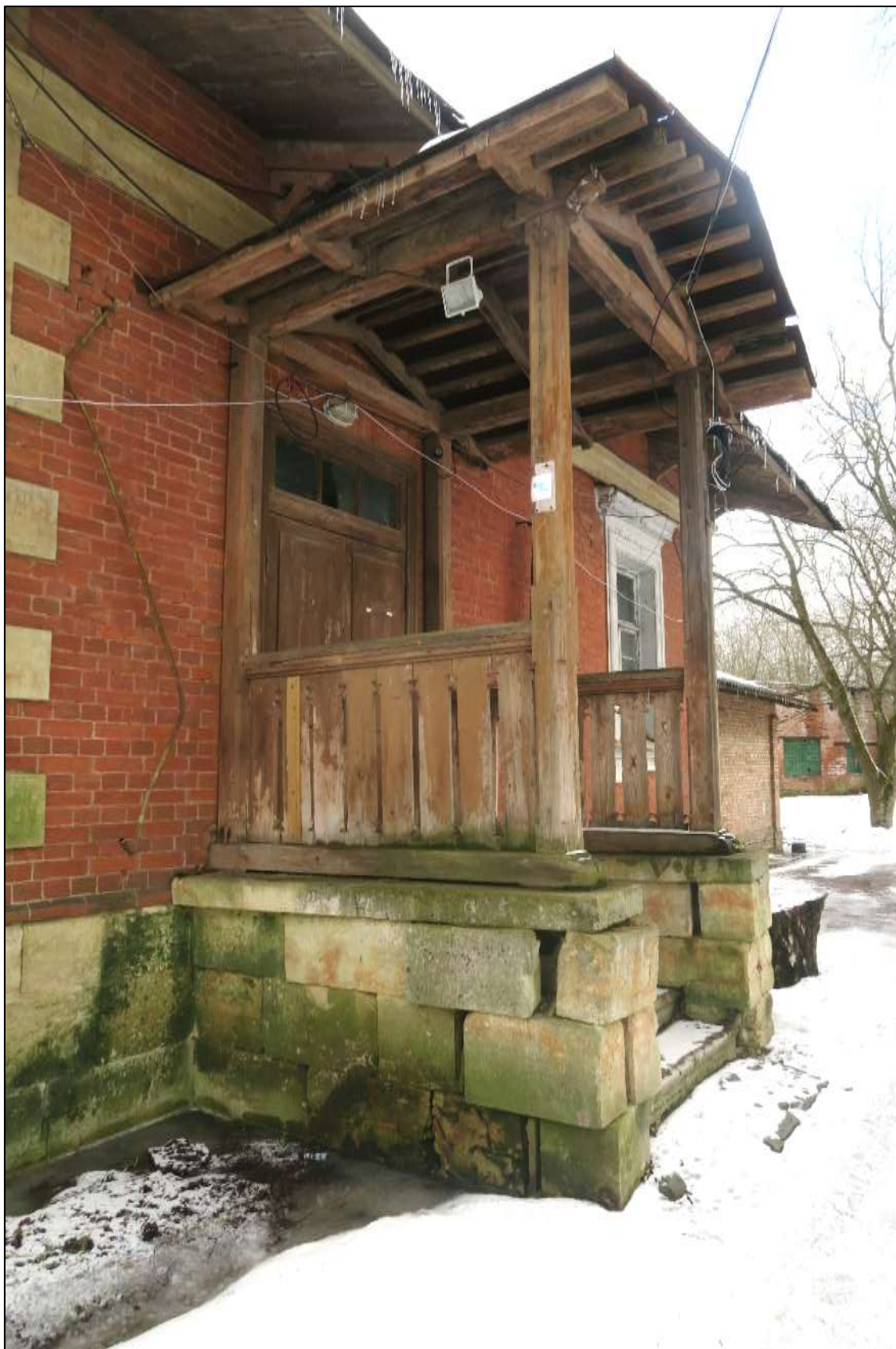
7. Караулка у Березовых ворот. Крыльцо. Общий вид. Виден деревянные навес и ограждение, объемно-пространственное решение, характер обработки деталей, цветовое решение. Сохранились накрывные известняковые плиты парапетов.
