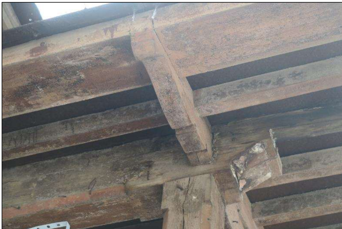
10. Караулка у Березовых ворот. Навес над крыльцом. Обработка кобылок и брусьев каркаса, обрешетка кровли.
