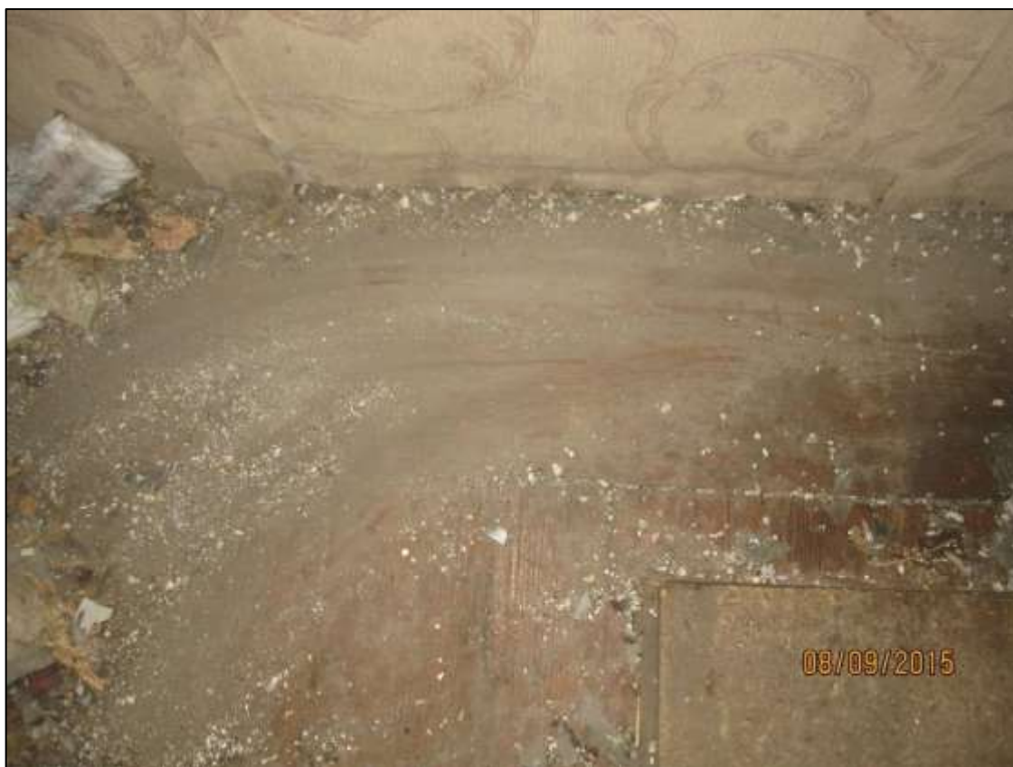
33. Дощатый пол «во фриз». Здание бывшей земской станции. Архангельская обл., г.Вельск, ул.Нечаевского, д.1.
