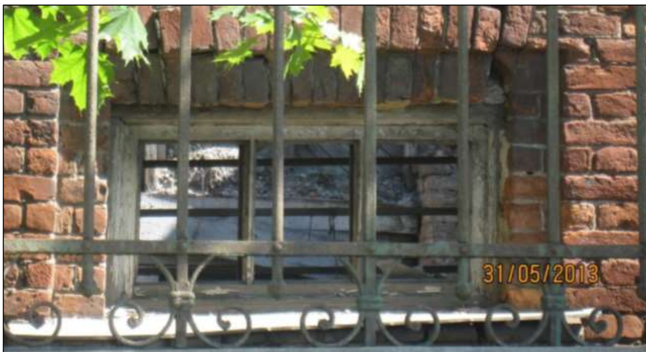
29. Караулка у Черных ворот. Сохранившееся заполнение оконного проема хозяйственной пристройки.
