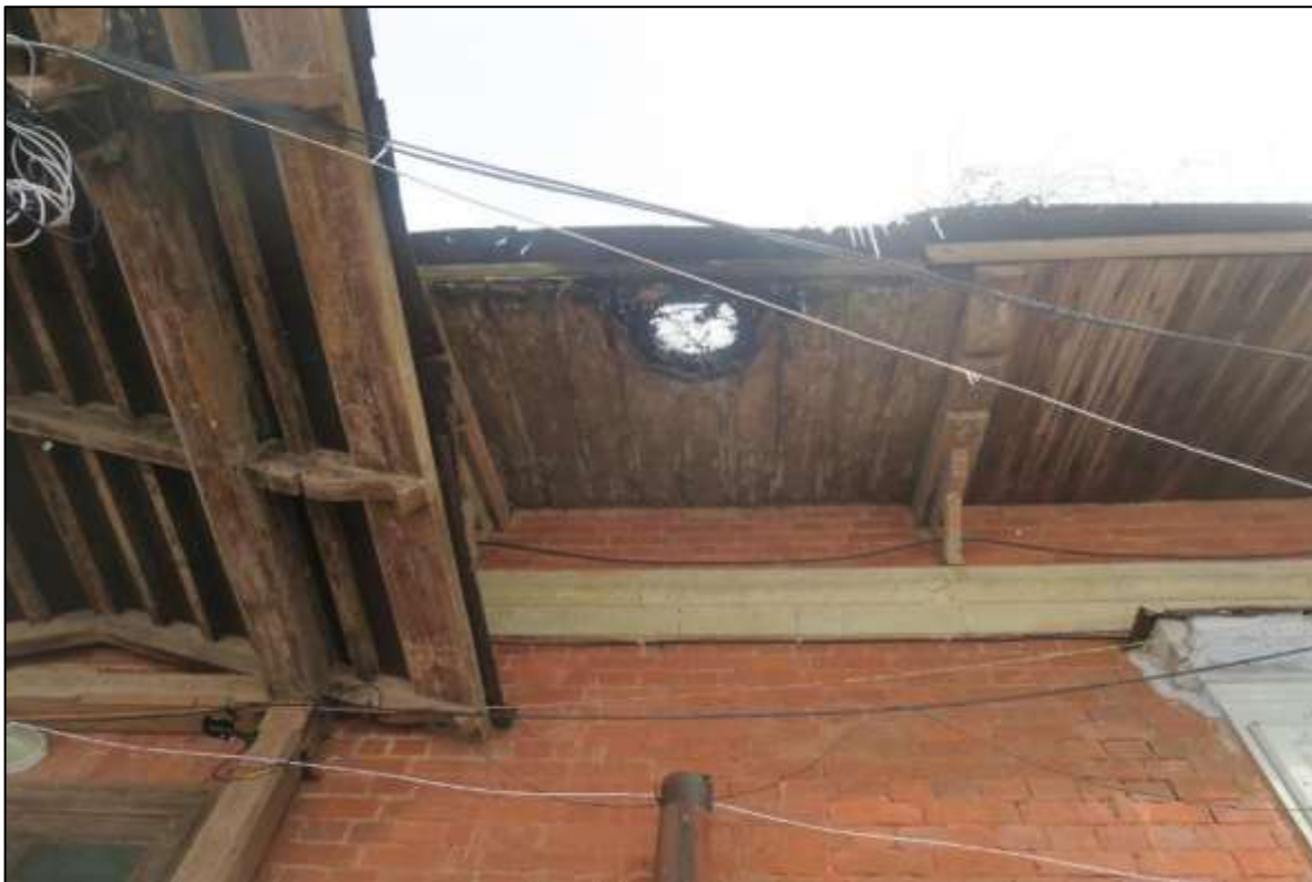
14. Караулка у Березовых ворот. Свес кровли бокового фасада. Видны резные кобылки, кронштейны под ними и место водосточной трубы. Примыкание крыши навеса к стене здания.
