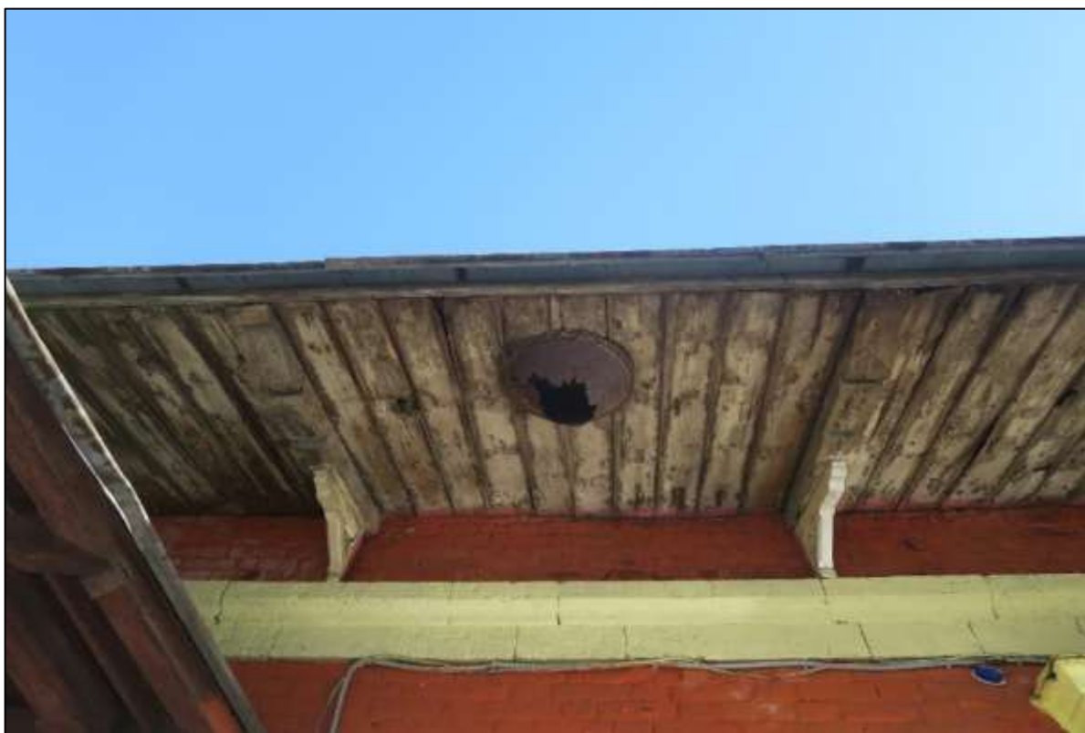
15. Караулка на ул.Хохлова, д.1. Свес кровли бокового фасада. Декоративное оформление – резные кобылки, кронштейны. Сохранилась воронка водосточной трубы.
