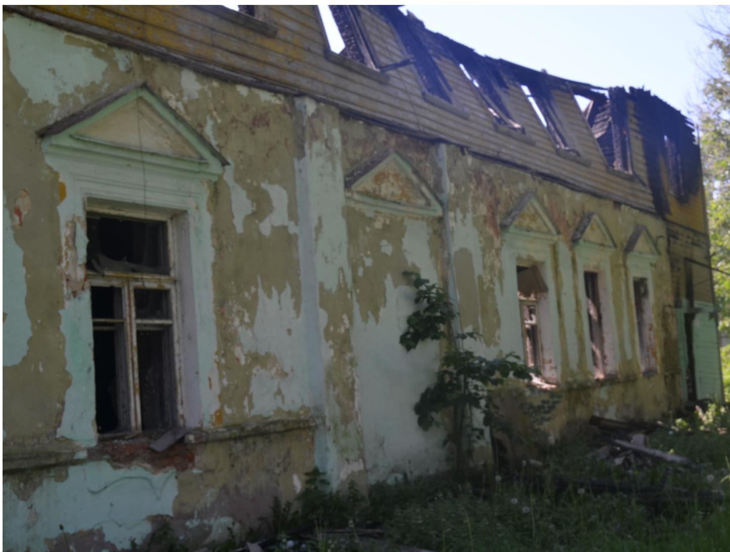
Фото 23. Фрагмент лицевого фасада объекта экспертизы с историческими оконными и заложенным историческим дверным проемом и сохранившимися элементами исторической отделки.
