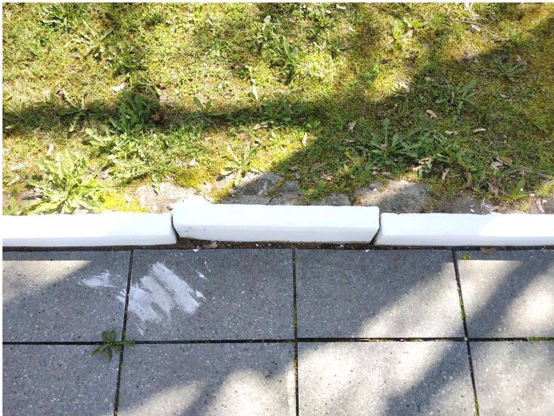
14. Бордюр по периметру верхней площадки.
