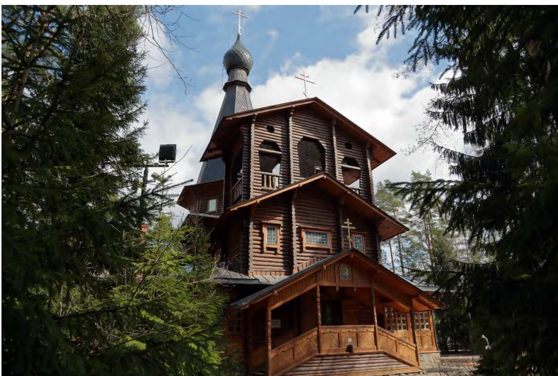
Фото 6. Резное парадное крыльцо. Бревчатые стены, рубленные «с остатком»
