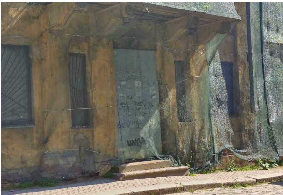
Фото 5. Объект культурного наследия регионального значения «Дом губернского правления», расп. по адресу: Ленинградская обл., г. Выборг, ул. Крепостная, 22. Лицевой фасад основного объема по ул. Крепостной. Фрагмент. Центральная часть в отметке первого этажа. Входной проем, зашитый листовым железом.
