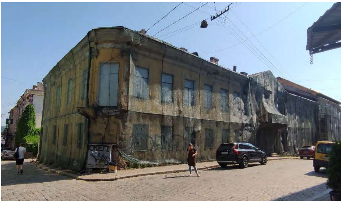
Фото 1. Объект культурного наследия регионального значения «Дом губернского правления», расп. по адресу: Ленинградская обл., г. Выборг, ул. Крепостная, 22. Лицевой фасад основного объема по ул. Крепостной. Общий вид.
