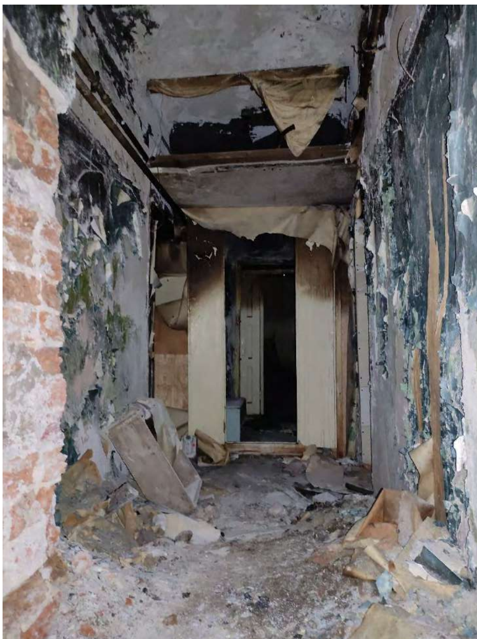
Фото 39. Объект культурного наследия регионального значения «Дом губернского правления», расп. по адресу: Ленинградская обл., г. Выборг, ул. Крепостная, 22. Интерьер пом. № III, 1 этаж.
