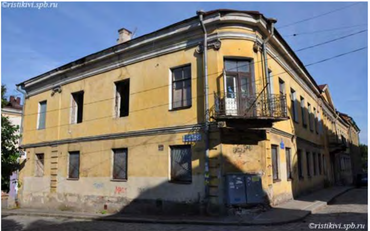
Иллюстрация 35. Жилой дом (Крепостная ул., 22), утраченный угловой балкон. Фото 2013 г. http://ristikivi.spb.ru/albums/viipuri-hs-krepostnaya-n22.html?photo=4
