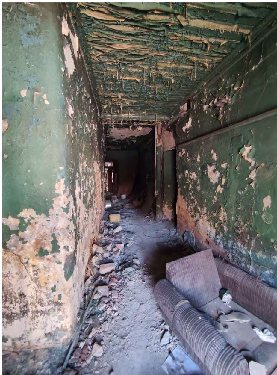
Фото 30. Объект культурного наследия регионального значения «Дом губернского правления», расп. по адресу: Ленинградская обл., г. Выборг, ул. Крепостная, 22. Интерьер пом. № IV, 1 этаж.
