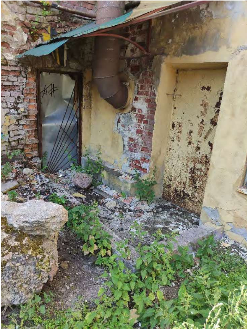
Фото 27. Объект культурного наследия регионального значения «Дом губернского правления», расп. по адресу: Ленинградская обл., г. Выборг, ул. Крепостная, 22. Дворовый северо-восточный фасад основного объема, фрагмент; дворовый юго-восточный фасад основного объема, фрагмент. Заложенный дверной проем.
