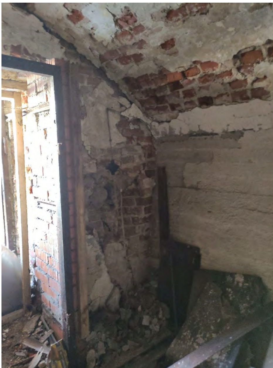
Фото 41. Объект культурного наследия регионального значения «Дом губернского правления», расп. по адресу: Ленинградская обл., г. Выборг, ул. Крепостная, 22. Интерьер пом. № 6/н(1), подвальный этаж. Сводчатые перекрытия цокольного этажа; слева – входной проем со стороны дворового фасада основного объема.
