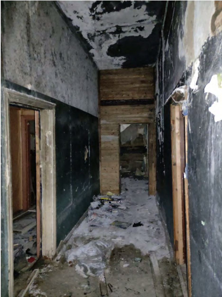
Фото 37. Объект культурного наследия регионального значения «Дом губернского правления», расп. по адресу: Ленинградская обл., г. Выборг, ул. Крепостная, 22. Интерьер пом. № IV, 2 этаж.
