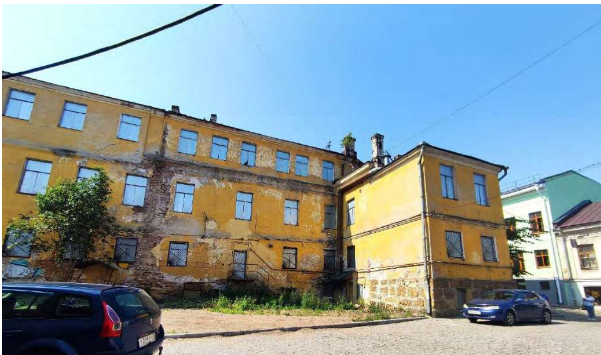
Фото 17. Объект культурного наследия регионального значения «Дом губернского правления», расп. по адресу: Ленинградская обл., г. Выборг, ул. Крепостная, 22. Дворовый северо-восточный фасад основного объема, общий вид; дворовый юго-восточный фасад основного объема, общий вид; дворовый юго-восточный фасад пристройки, общий вид; торцевой фасад пристройки, общий вид.
