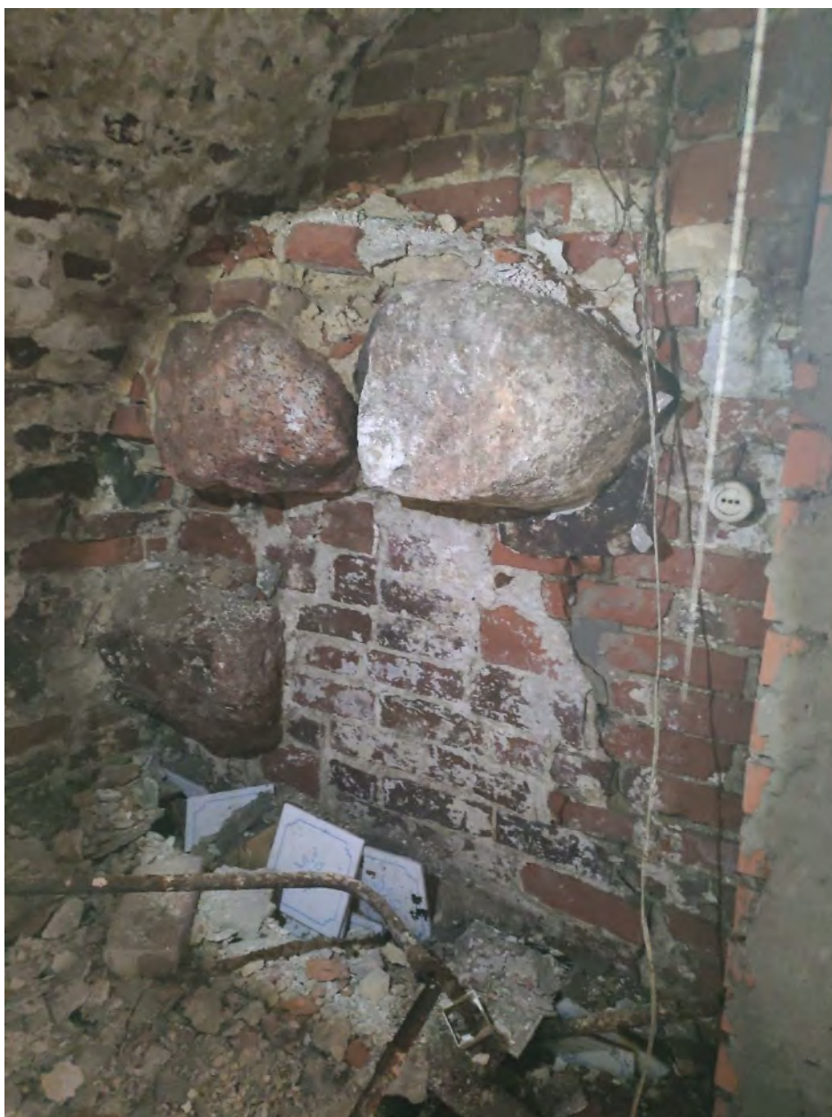
Фото 40. Объект культурного наследия регионального значения «Дом губернского правления», расп. по адресу: Ленинградская обл., г. Выборг, ул. Крепостная, 22. Интерьер пом. № 6/н(1), подвальный этаж. Сохранившиеся элементы исторической валунной кладки фундамента, поздние закладки кирпичом.
