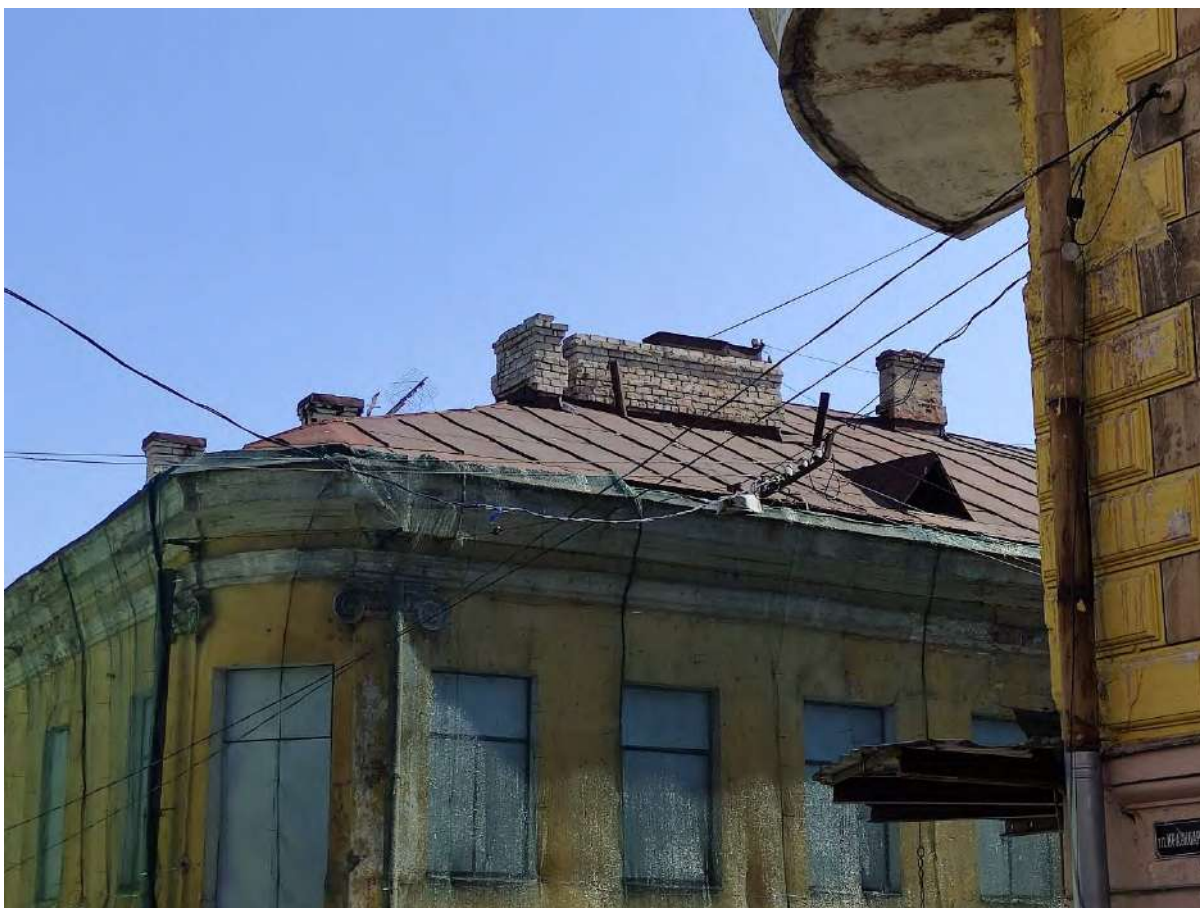
Фото 3. Объект культурного наследия регионального значения «Дом губернского правления», расп. по адресу: Ленинградская обл., г. Выборг, ул. Крепостная, 22. Фрагмент угловой части основного объема на пересечении Крепостной и Красноармейской улиц. Венчающий карниз, поздние дымовые трубы.
