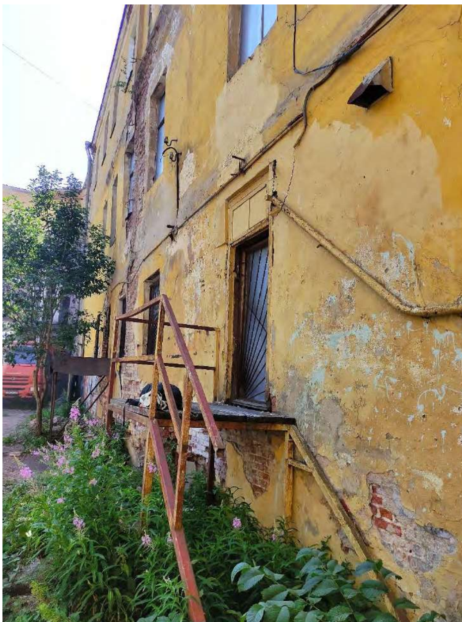
Фото 28. Объект культурного наследия регионального значения «Дом губернского правления», расп. по адресу: Ленинградская обл., г. Выборг, ул. Крепостная, 22. Дворовый северо-восточный фасад основного объема, фрагмент. Поздняя рунированная металлическая лестница, вход в пом. № IV, 1 этаж.
