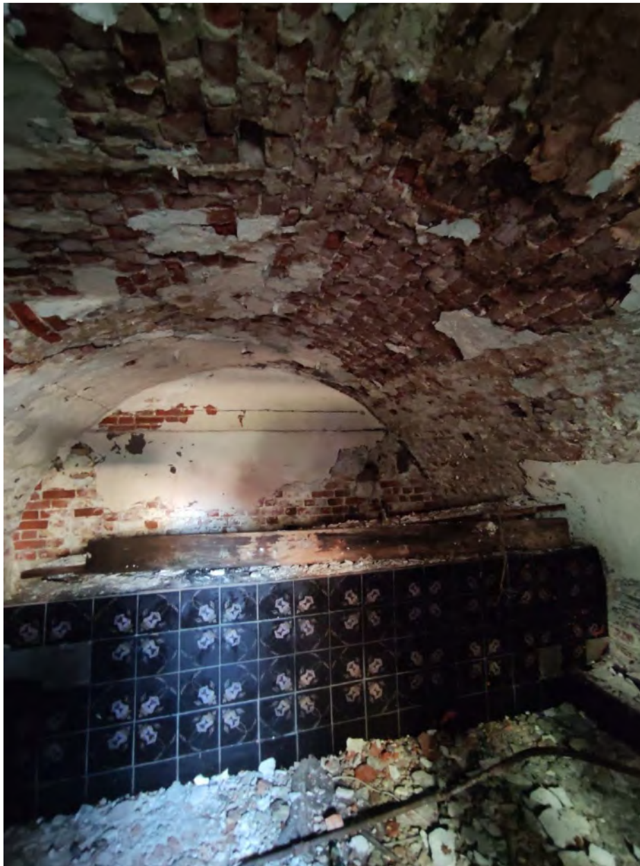
Фото 42. Объект культурного наследия регионального значения «Дом губернского правления», расп. по адресу: Ленинградская обл., г. Выборг, ул. Крепостная, 22. Интерьер пом. № 6/н(1), подвальный этаж. Сводчатые перекрытия цокольного этажа.
