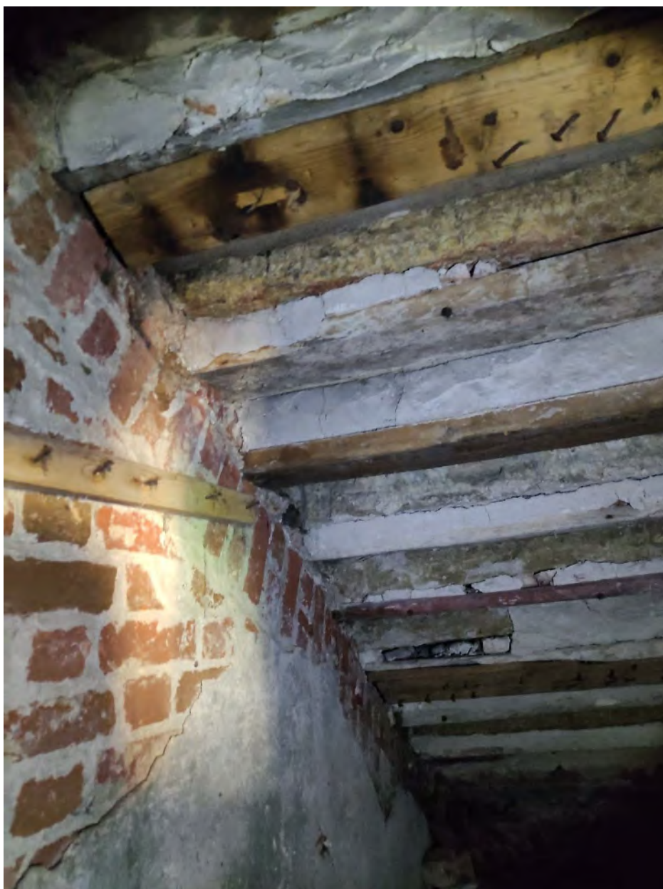
Фото 38. Объект культурного наследия регионального значения «Дом губернского правления», расп. по адресу: Ленинградская обл., г. Выборг, ул. Крепостная, 22. Интерьер пом. № IV, 1 этаж. Лестничный марш лестницы.
