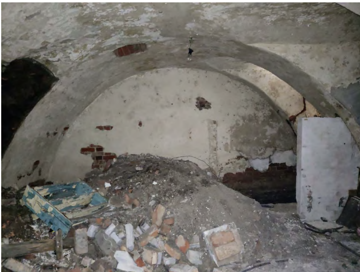
Фото 45. Объект культурного наследия регионального значения «Дом губернского правления», расп. по адресу: Ленинградская обл., г. Выборг, ул. Крепостная, 22. Интерьер пом. № б/н(3), подвальный этаж. Сводчатые перекрытия цокольного этажа.
