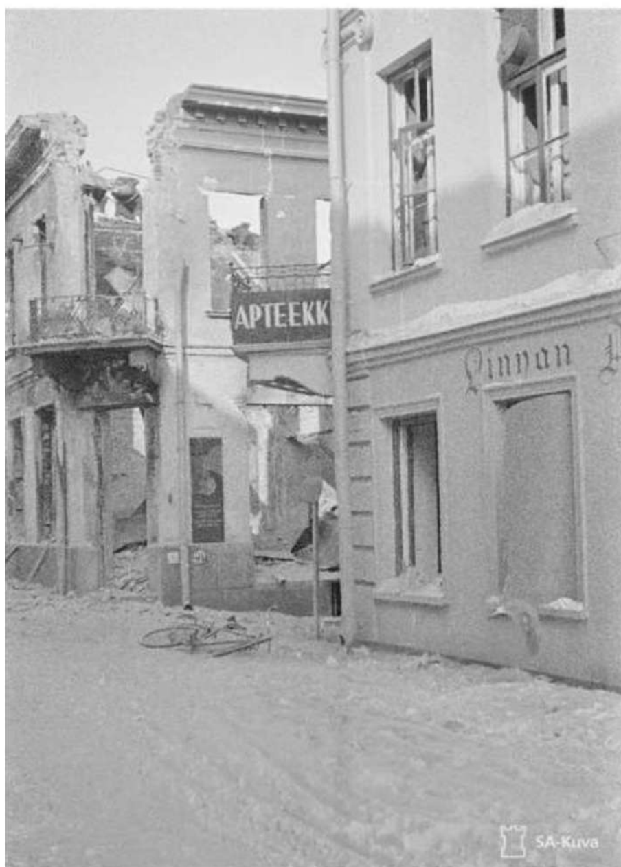
Иллюстрация 30. Разрушенный Выборг. Фото 1940 г. Справа – дом по ул. Крепостной, №22.
