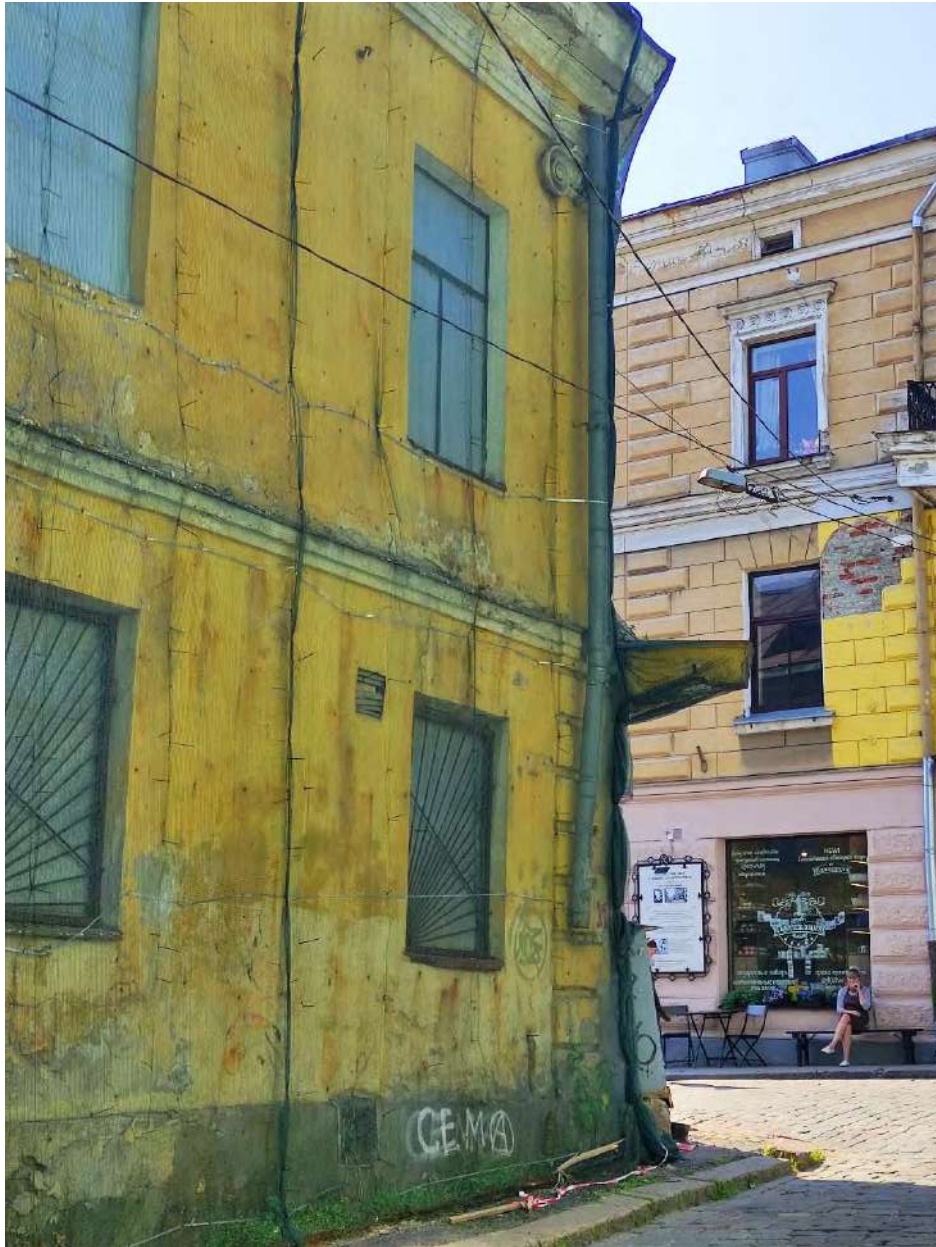
Фото 11. Объект культурного наследия регионального значения «Дом губернского правления», расп. по адресу: Ленинградская обл., г. Выборг, ул. Крепостная, 22. Лицевой фасад основного объема по ул. Красноармейской. Фрагмент. Кронштейн утраченного углового балкона.
