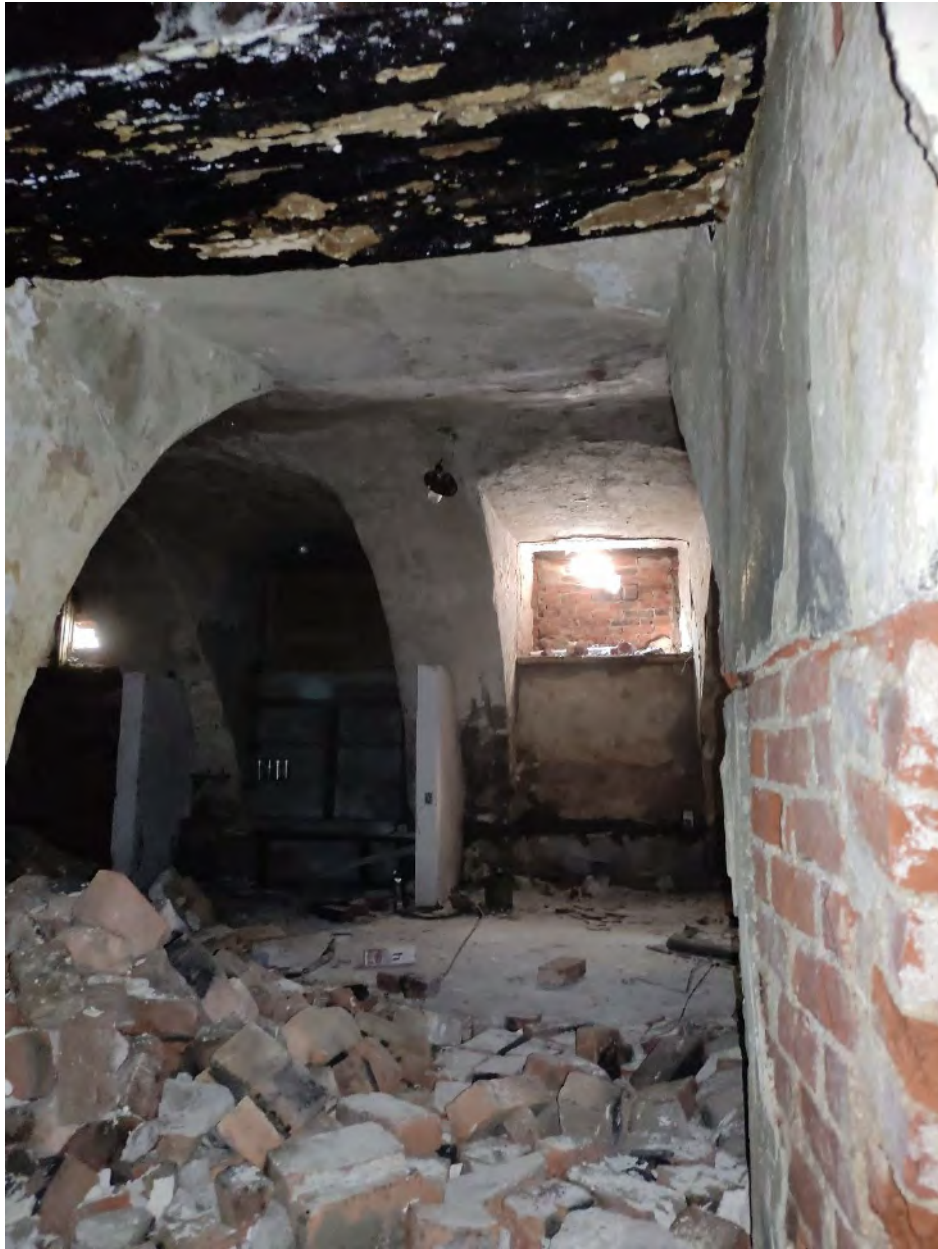
Фото 43. Объект культурного наследия регионального значения «Дом губернского правления», расп. по адресу: Ленинградская обл., г. Выборг, ул. Крепостная, 22. Интерьер пом. № 6/н(3), подвальный этаж. Сводчатые перекрытия цокольного этажа; заложенные оконные проемы в сторону ул. Крепостной.
