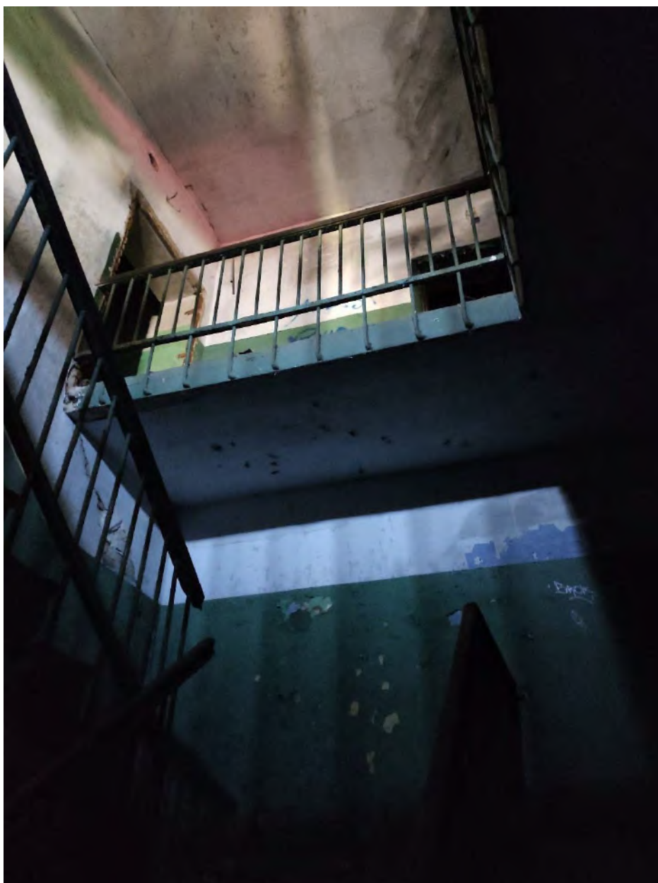
Фото 33. Объект культурного наследия регионального значения «Дом губернского правления», расп. по адресу: Ленинградская обл., г. Выборг, ул. Крепостная, 22. Интерьер пом. № I, лестница.
