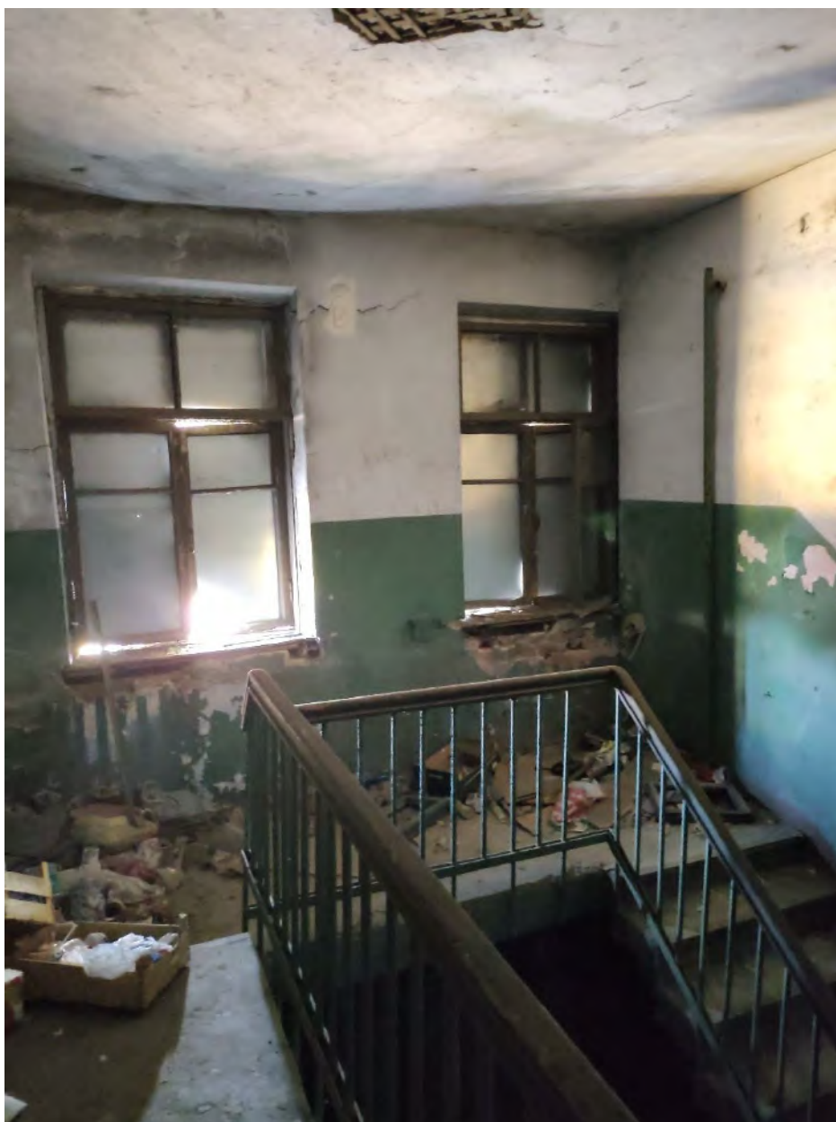
Фото 34. Объект культурного наследия регионального значения «Дом губернского правления», расп. по адресу: Ленинградская обл., г. Выборг, ул. Крепостная, 22. Интерьер пом. № I , лестница.
