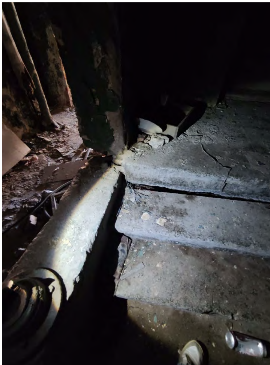
Фото 31. Объект культурного наследия регионального значения «Дом губернского правления», расп. по адресу: Ленинградская обл., г. Выборг, ул. Крепостная, 22. Интерьер пом. пом. № IV, 1 этаж. Лестница, исторические ступени с валиком.
