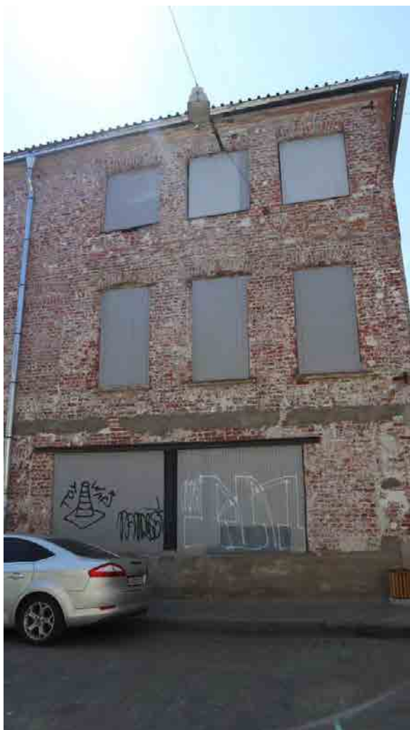
Фото 13. Фрагмент фасада по ул. Крепостная, д. 12. В уровне первого этажа – витринные оконные проемы.
