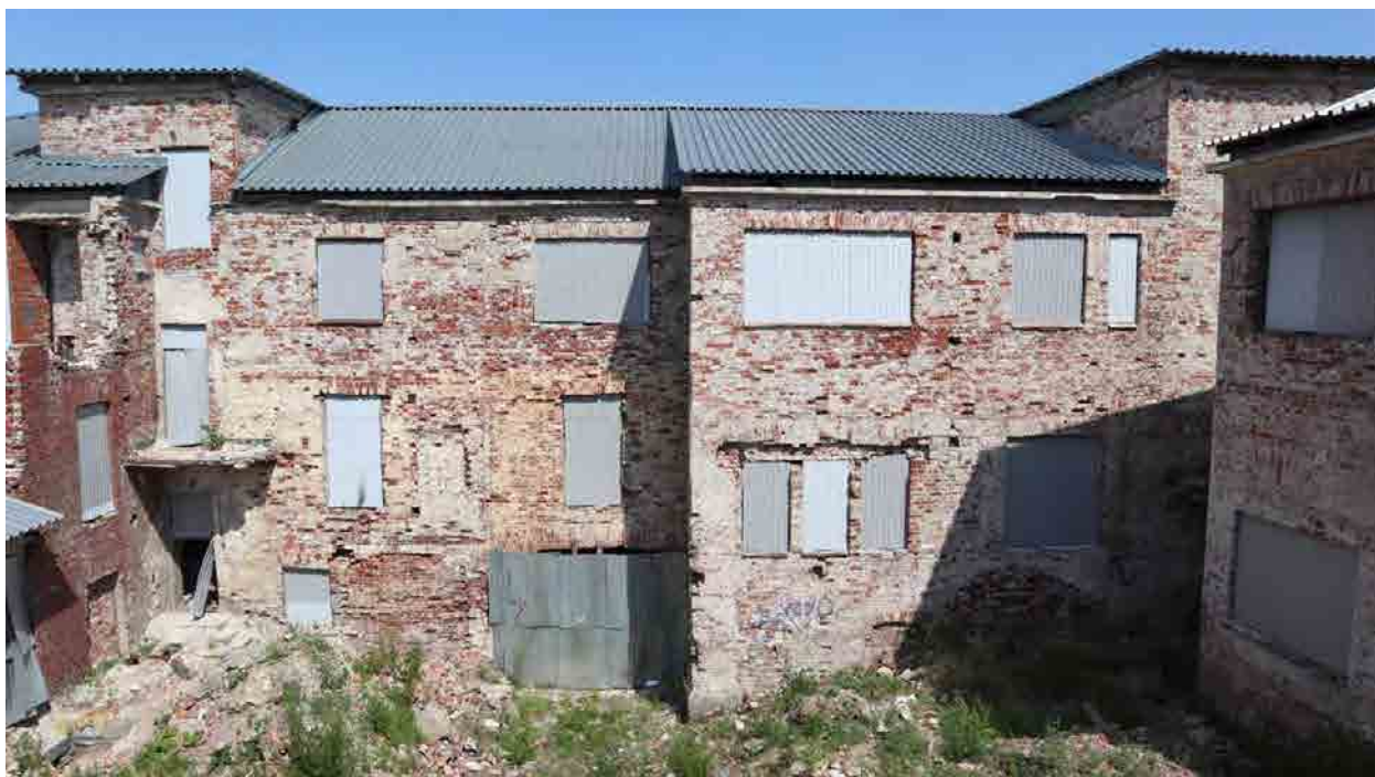
Фото 26. Дворовой фасад здания по ул. Крепостная, д. 15, 15а.
