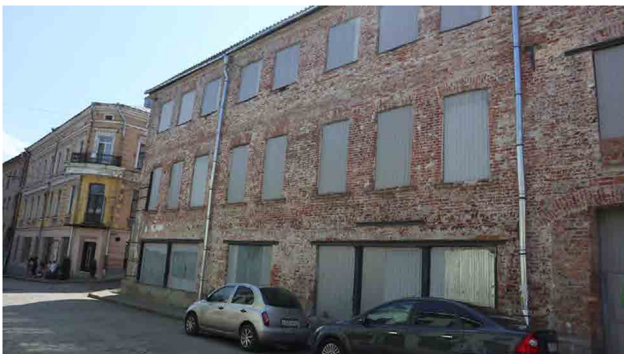
Фото 16. Фрагмент фасада по ул. Крепостная, д. 12: витринные оконные проёмы первого этажа.
