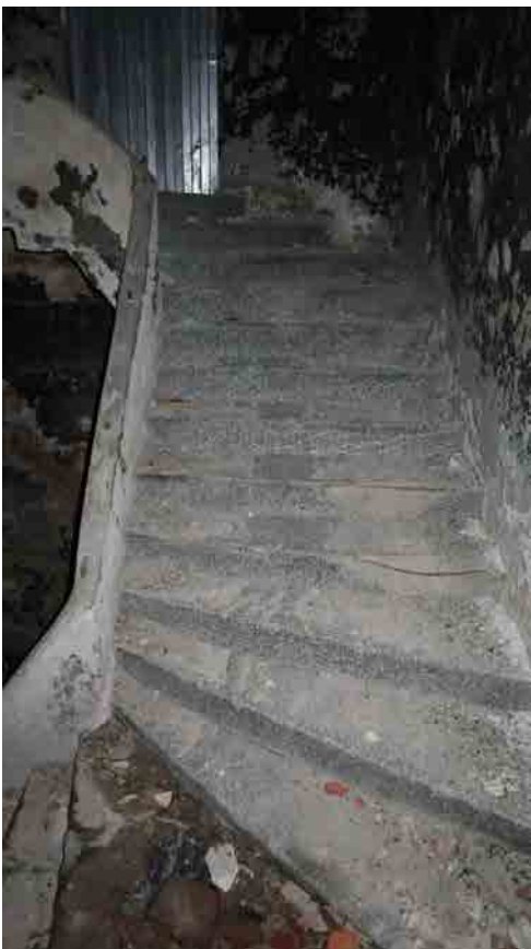
Фото 53. Лестница в южной части здания.
