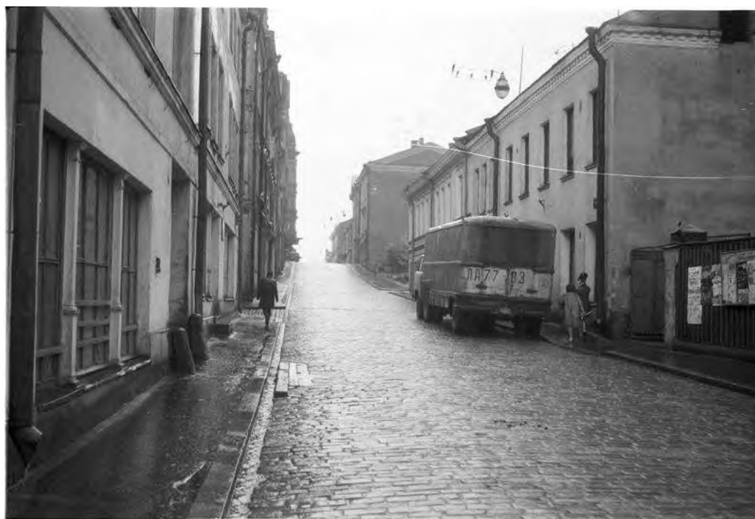
Илл. 72. Крепостная ул., 1964 г. Слева – дом по Крепостной 15.
