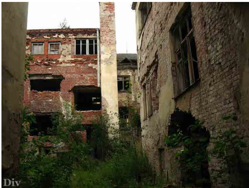
Илл. 116. Дворовые корпуса. Фото 2008 г. http://www.hiddenside.ru/photos/industrial/lo
