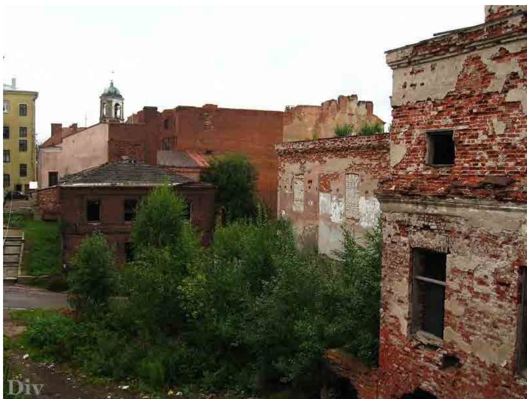
Илл. 141. Дома на бывшем участке №67. Фото 2008 г. http://www.hiddenside.ru/photos/industrial/lo
