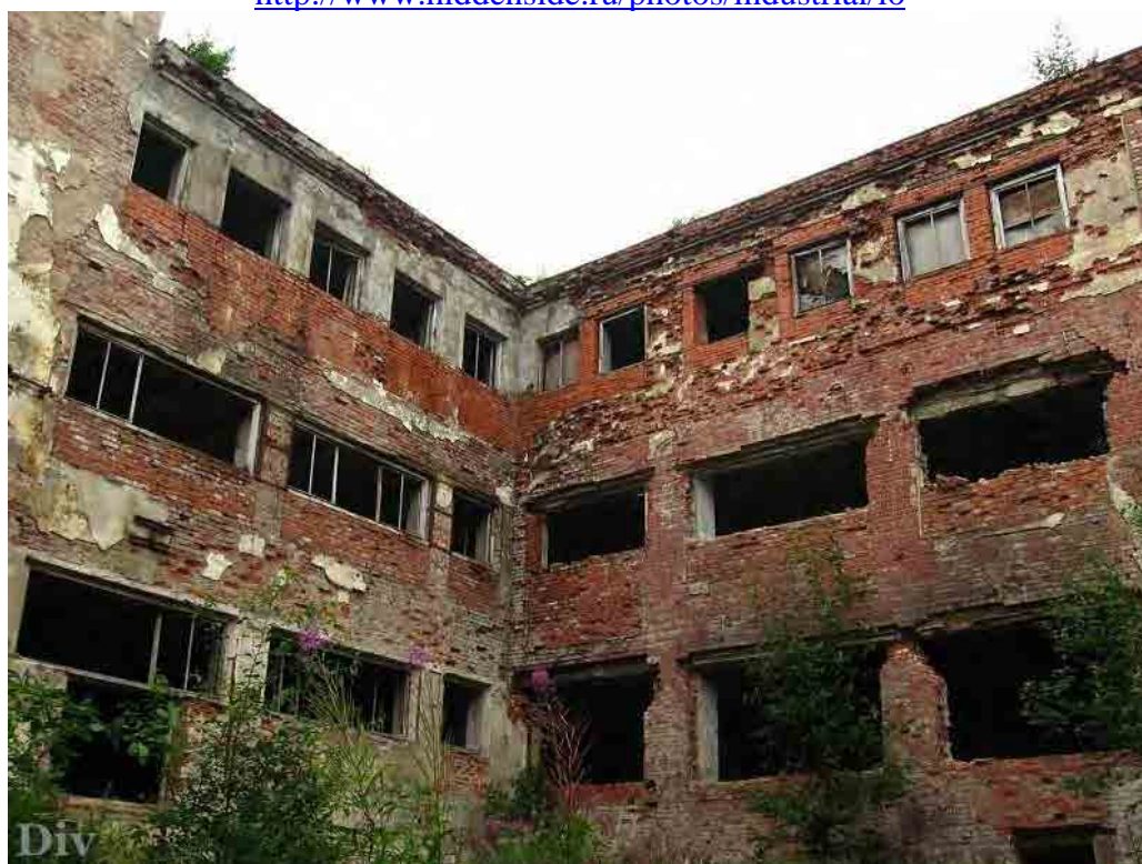
Илл. 115. Дворовые корпуса. Фото 2008 г. http://www.hiddenside.ru/photos/industrial/lo
