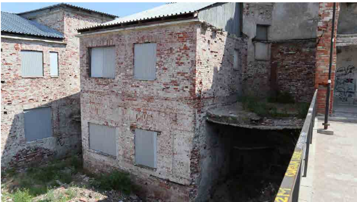
Фото 24. Дворовой фасад здания по ул. Крепостная, д. 15, 15а.
