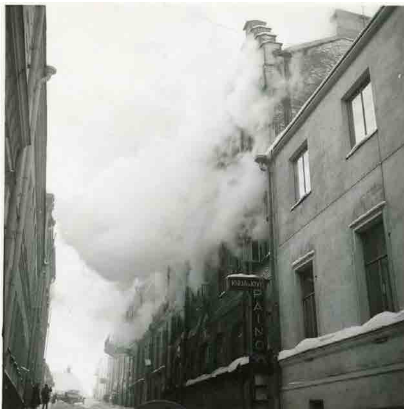
Илл. 97. Здания по Красноармейской ул. Пожар в здании №10. Фото 1940 г. Справа – фрагмент здания по Крепостной 15.
