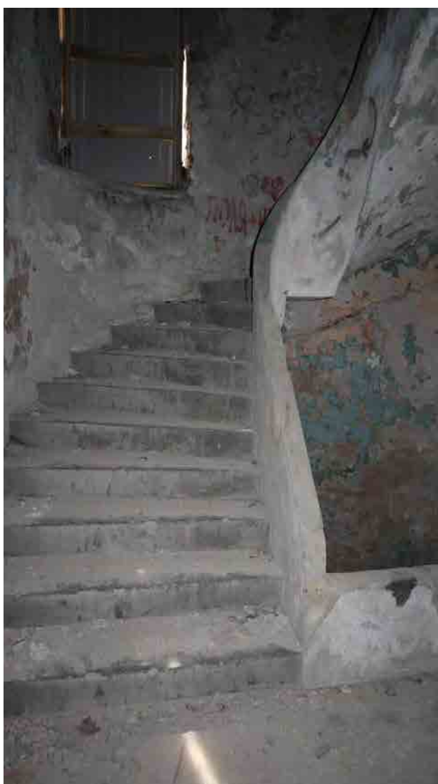
Фото 48. Лестница в северной части здания.
