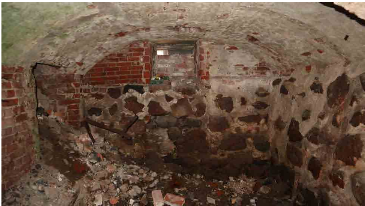
Фото 59. Цокольная часть здания (по ул. Красноармейской)
