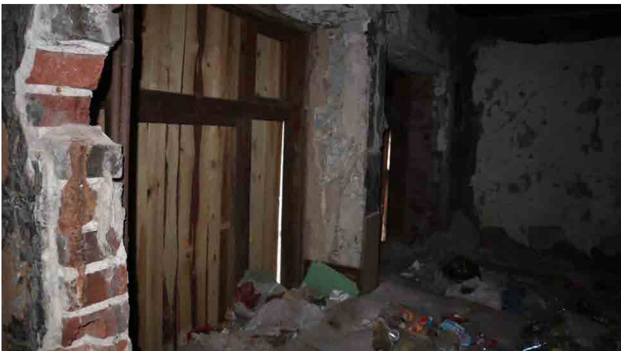
Фото 34. Помещение первого этажа. Оконные проемы, выходящие на ул. Крепостная.
