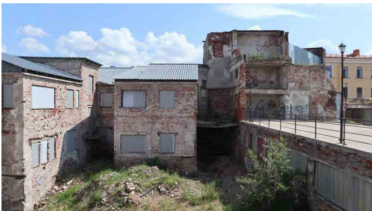
Фото 27. Дворовой фасад здания по ул. Крепостная, д. 15, 15а.
