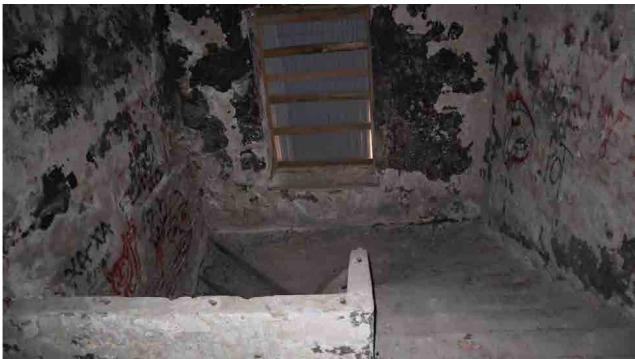
Фото 54. Лестница в центральной части здания.
