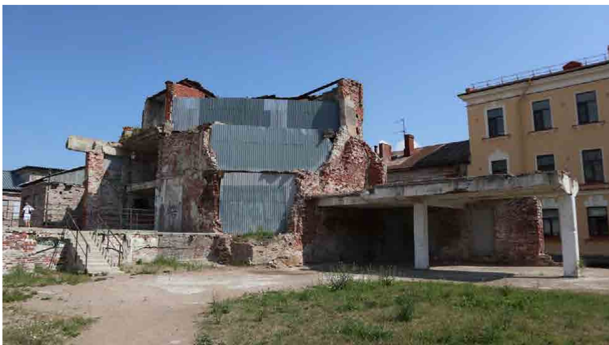
Фото 78. Вид на здание со стороны двора.
