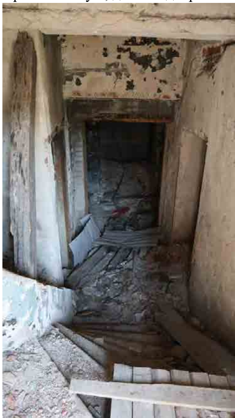
Фото. 33. Лестница в северной части здания.
