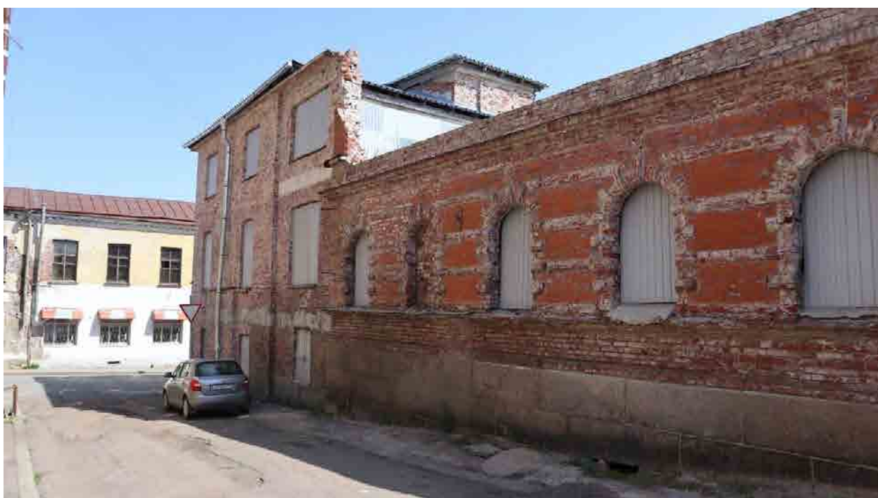
Фото 6. Фрагмент лицевого фасада. Примыкание к зданию по ул. Крепостная, д. 15а.
