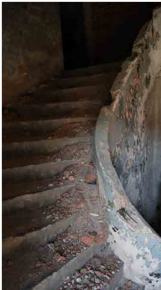
Фото 32. Лестница в северной части здания.
