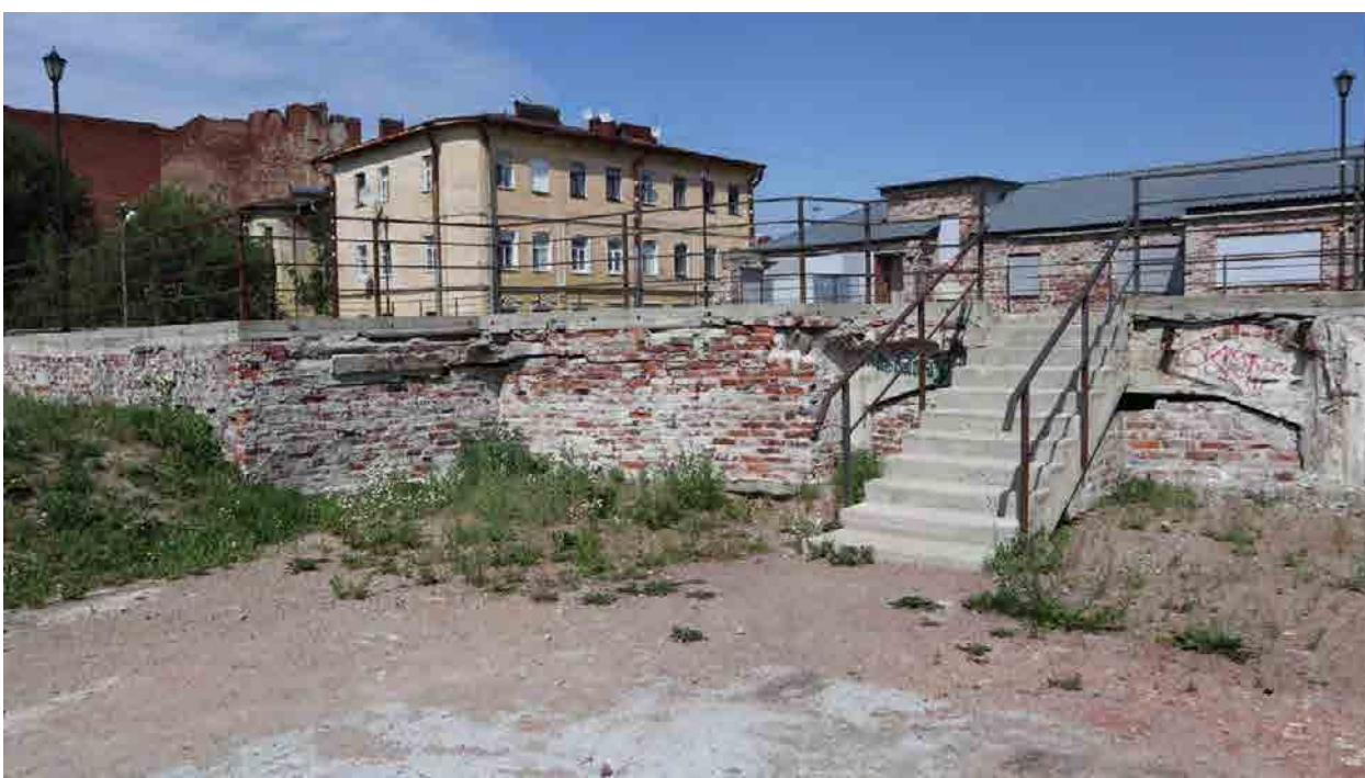
Фото 80. Фрагмент стен внутри дворовых корпусов.
