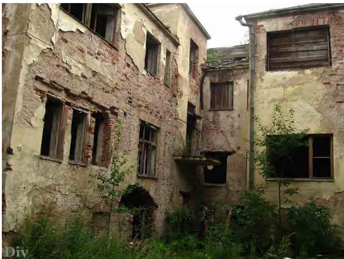
Илл. 86. Дворовый фасад здания Крепостная 15. Фото 2008 год. http://www.hiddenside.ru/photos/industrial/lo
