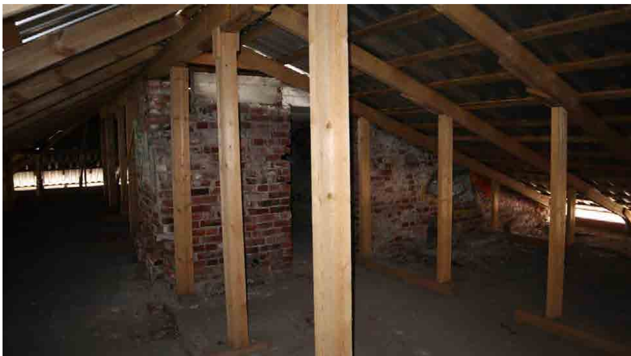
Фото 62. Конструкции временной кровли.
