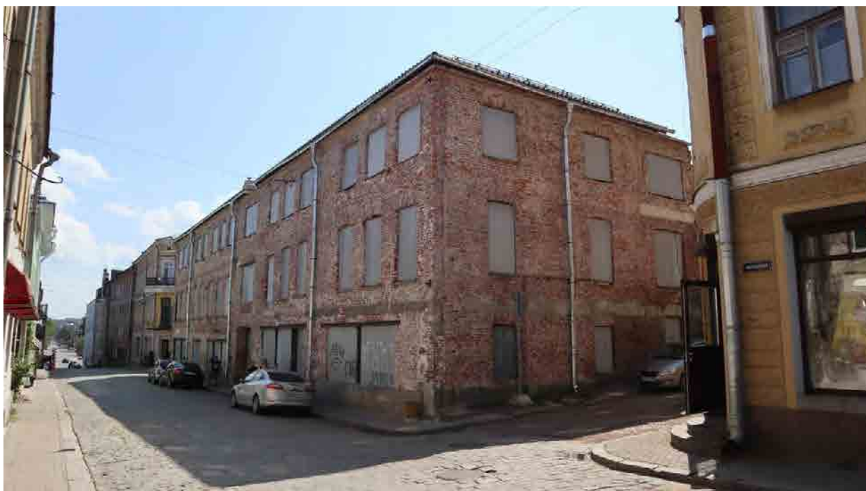
Фото 12. Лицевые фасады здания, ориентированные на ул. Крепостная, ул. Красина.
