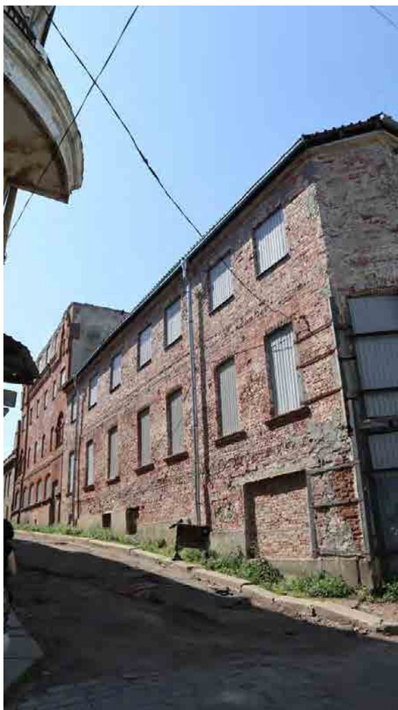
Фото 20. Лицевой фасад по ул. Красноармейская.
