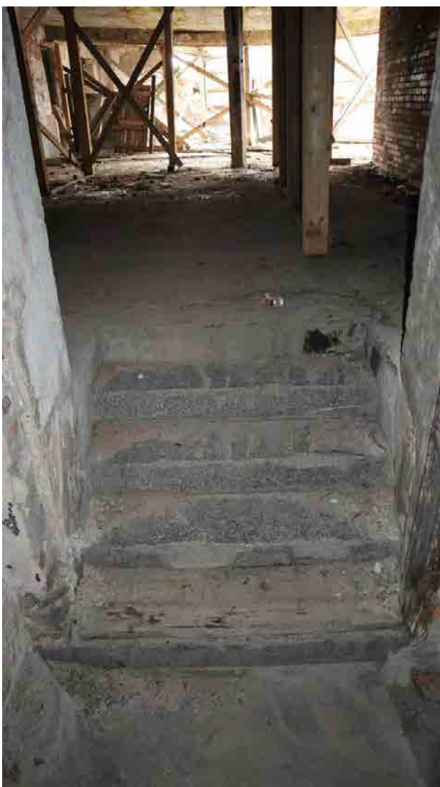
Фото 50. Лестница между зданием по адресу: Крепостная 15 и Красноармейская 10.
