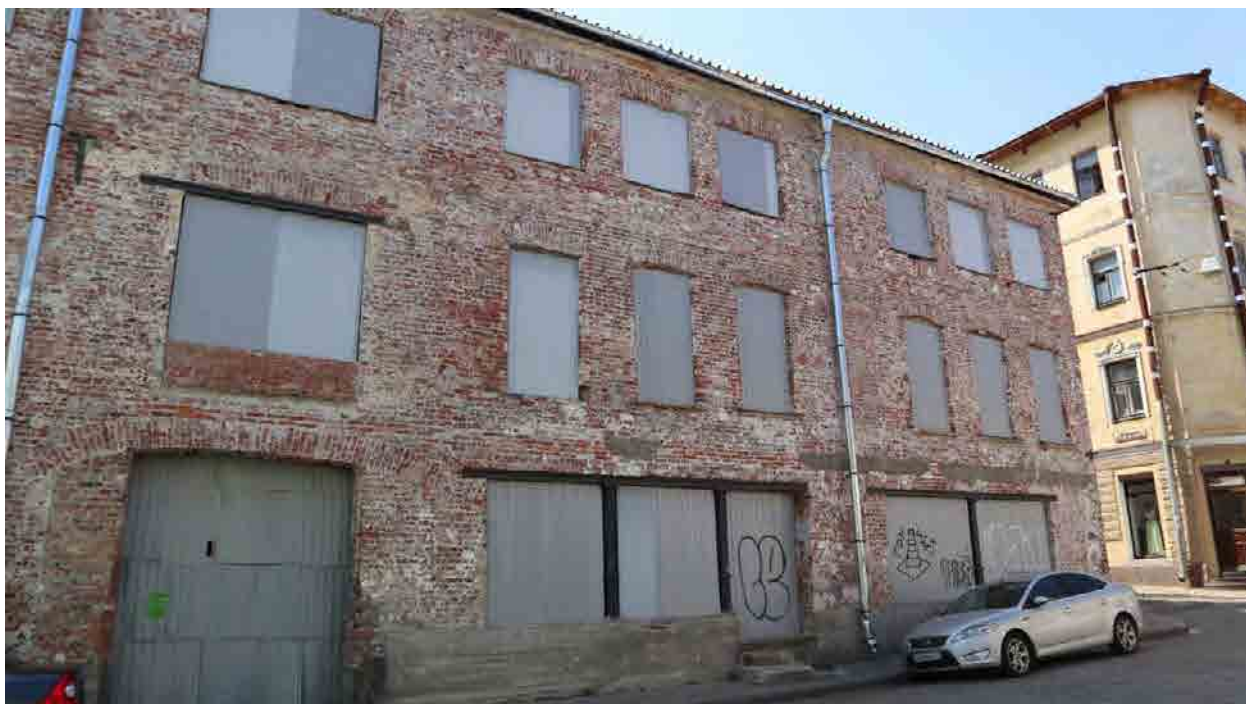
Фото 15. Фрагмент фасада по ул. Крепостная, д. 12. Слева – воротный проём, через который осуществляется въезд во двор.
