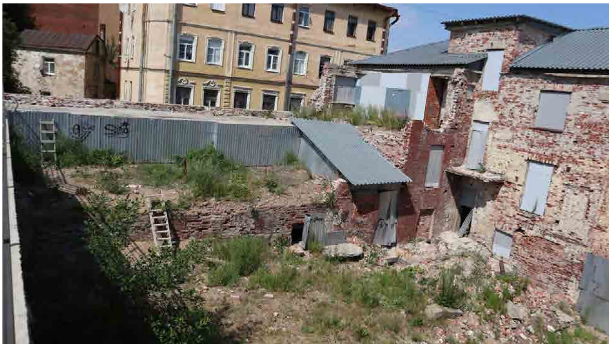
Фото 9. Дворовой фасад здания по ул. Красина, д. 11. Справа – дворовой фасад здания по ул. Крепостная, д. 15а.
