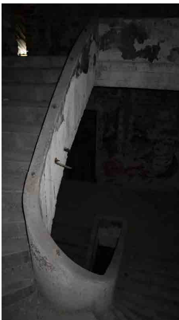
Фото 55. Лестница в центральной части здания.
