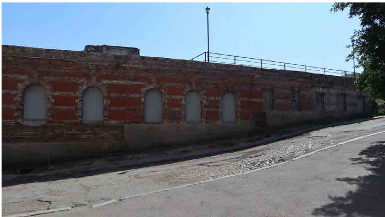
Фото 5. Вид на лицевой фасад здания (центральная часть).
