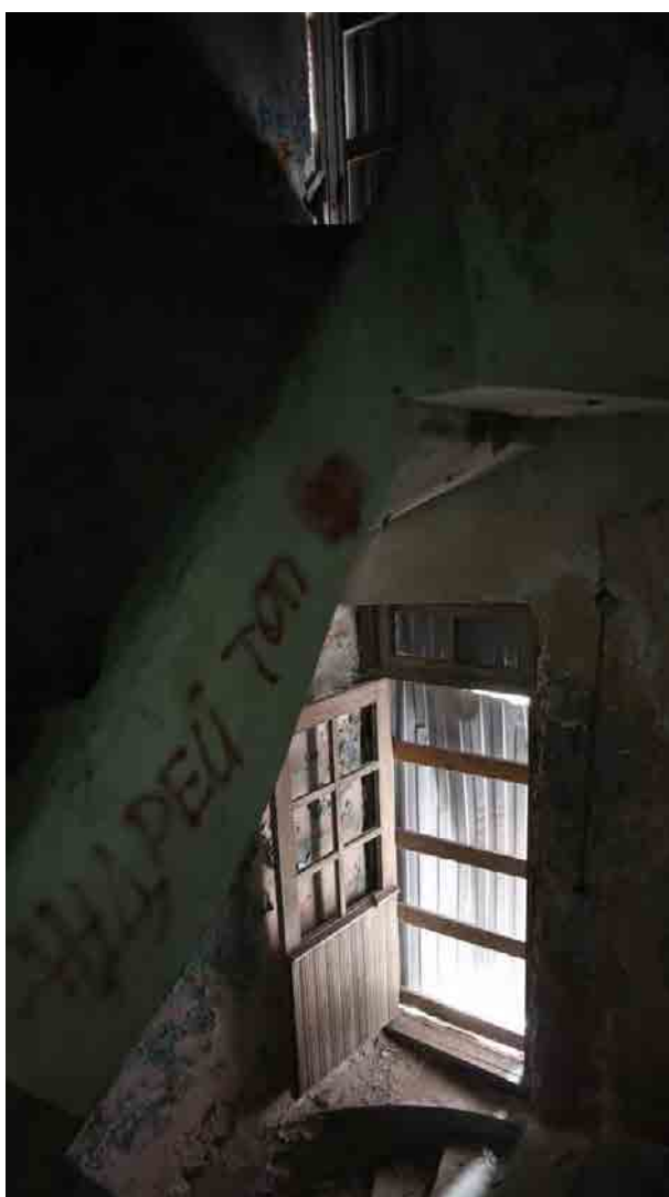
Фото 42. Лестница в северной части здания.
