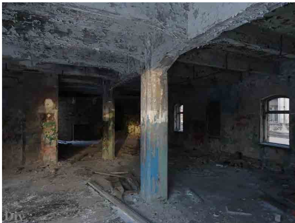
Илл. 112. Здание по Красноармейской 10. Фото 2017 г. Помещения второго этажа. http://www.hiddenside.ru/photos/industrial/10
