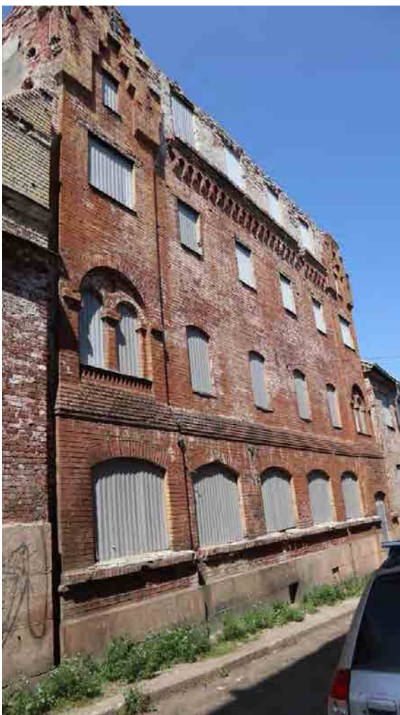
Фото 68. Общий вид на лицевой фасад.
