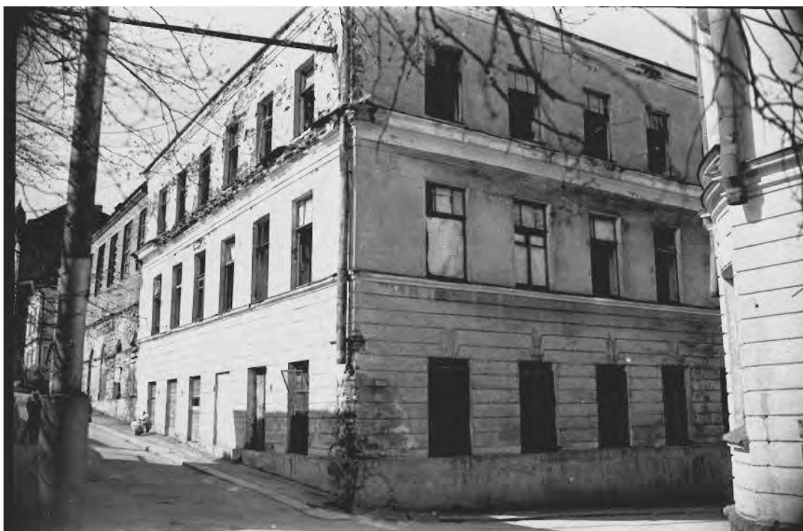
Илл. 139. Лицевой фасад здания по улице Сторожевой башни, д. 16 (на углу с ул. Красноармейской). Фото 1995 г. Из личного архива В.В. Дмитриева
