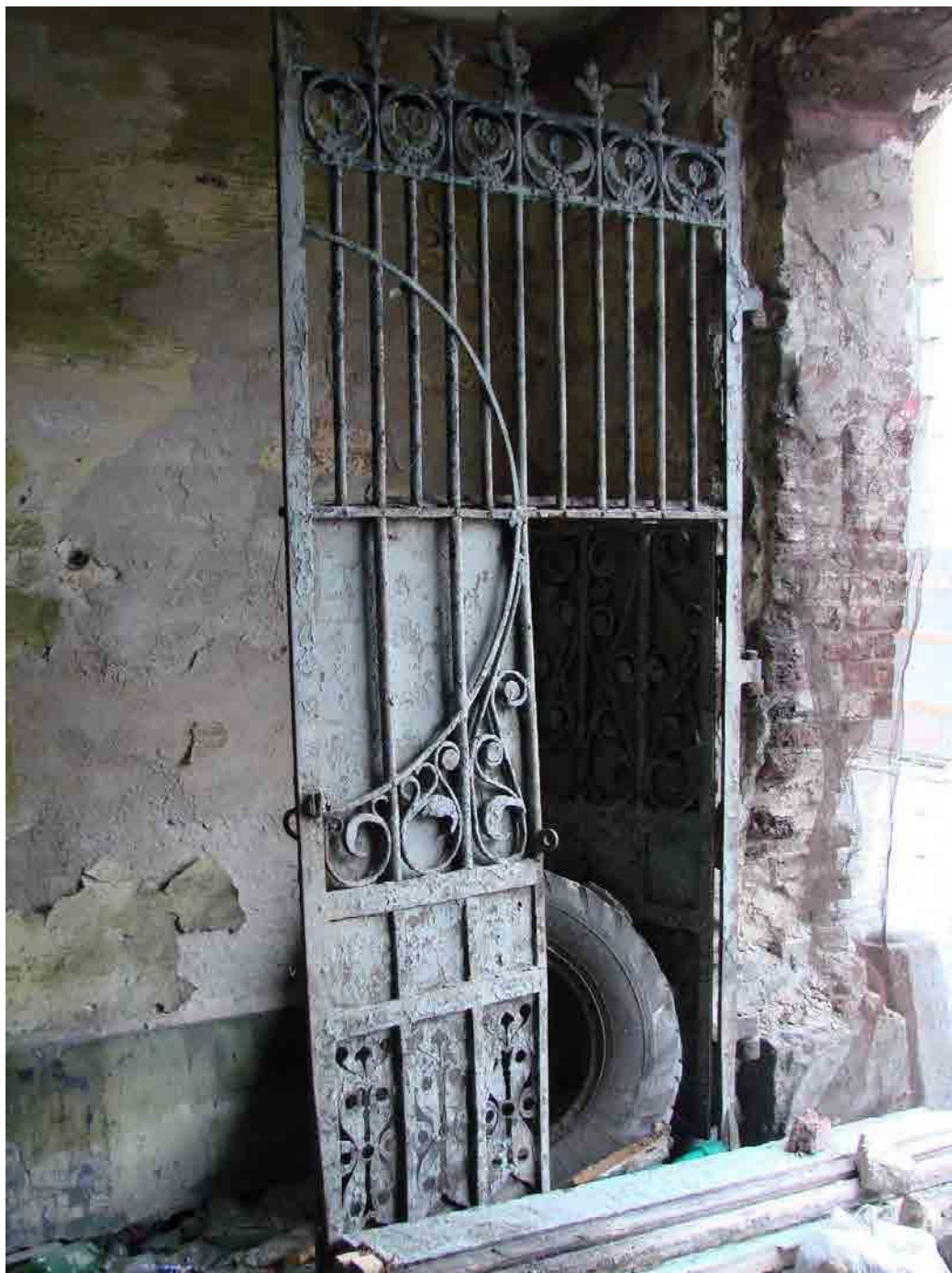
Фото 85. Крепостная ул., д. 15. Ворота в проездной арке (в настоящее время утрачены). 2013 г. Фото из личного архива Дмитриева В.В.
