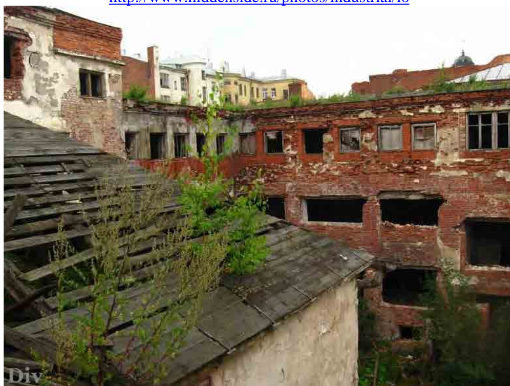
Илл. 117. Дворовые корпуса. Фото 2008 г. http://www.hiddenside.ru/photos/industrial/lo
