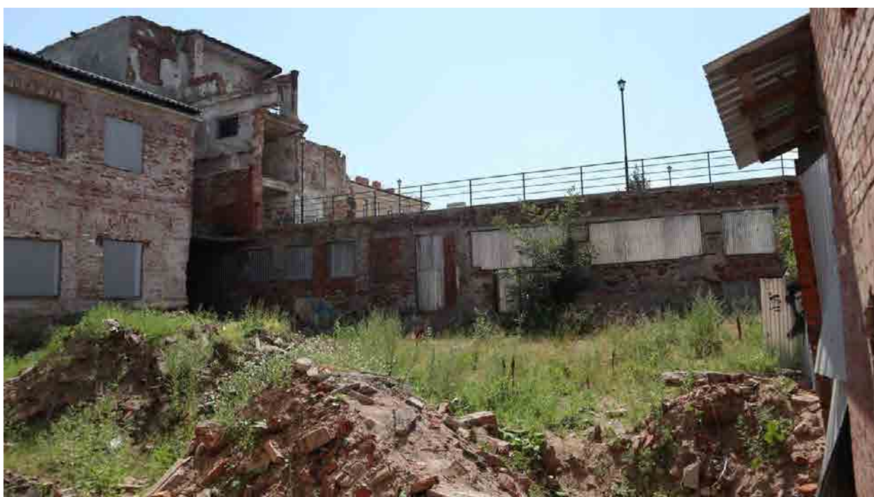
Фото 71. Дворовые фасады здания.
