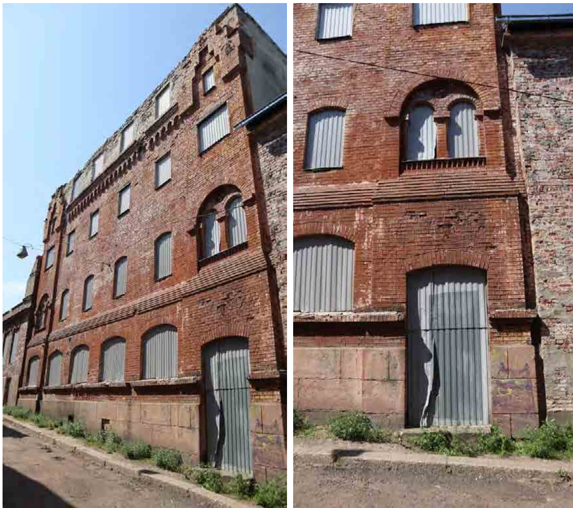
Фото 63, 64. Лицевой фасад. Общий вид и фрагмент.
