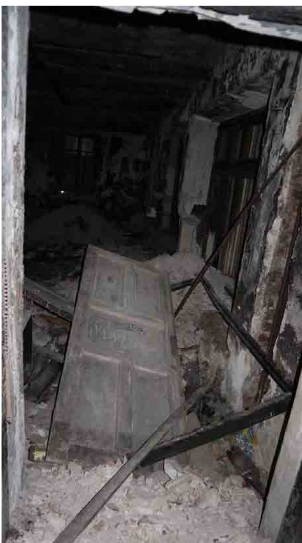
Фото 35. Помещение первого этажа. Оконные проемы, выходящие на ул. Крепостная.
