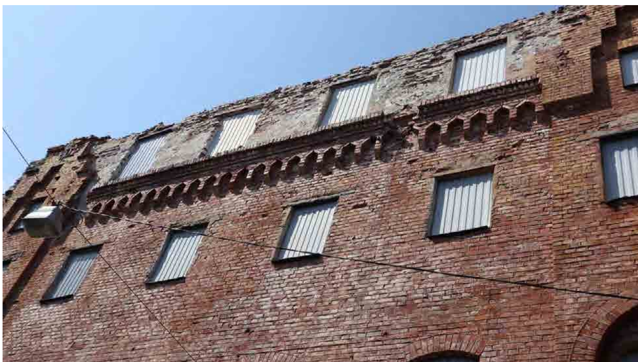
Фото 65. Фрагмент лицевого фасада: третий, четвертый этажи.
