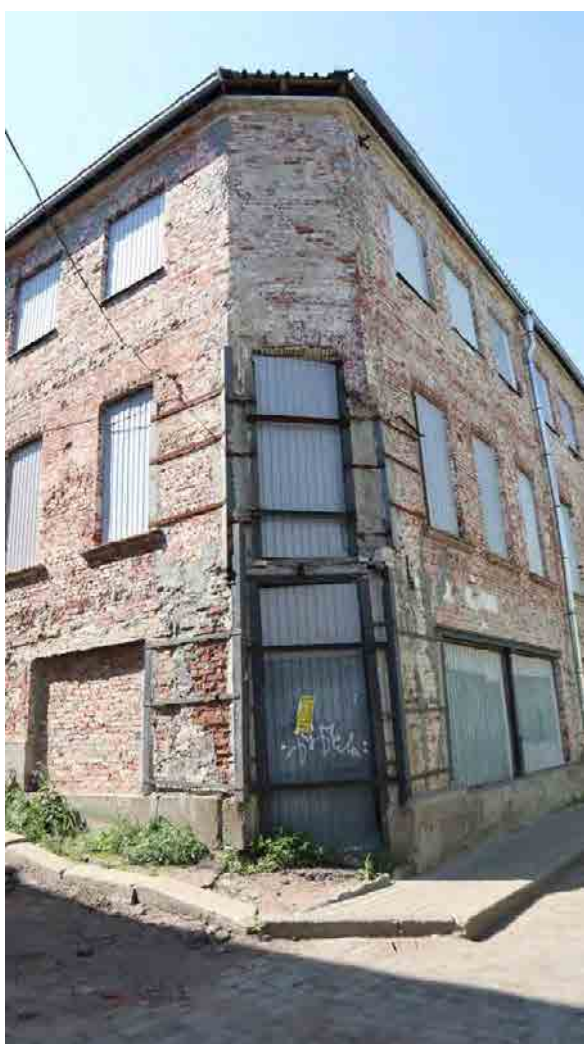
Фото 18. Угол здания, выходящий на пересечение ул. Крепостная и ул. Красноармейская. Конструкции усиления.
