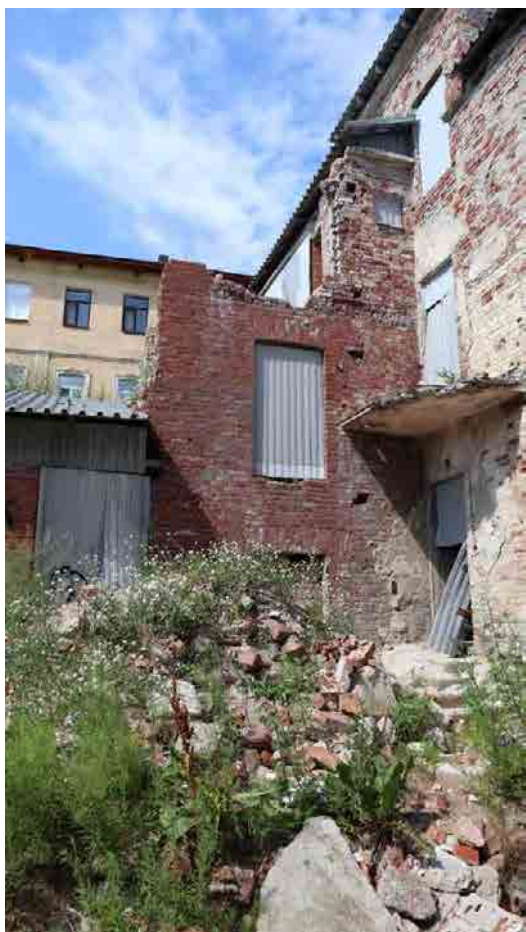
Фото 10. Фрагмент дворового фасада здания по ул. Красина, д. 11.
