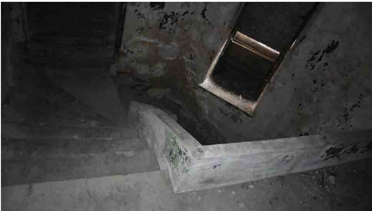
Фото 49. Лестница в южной части здания.
