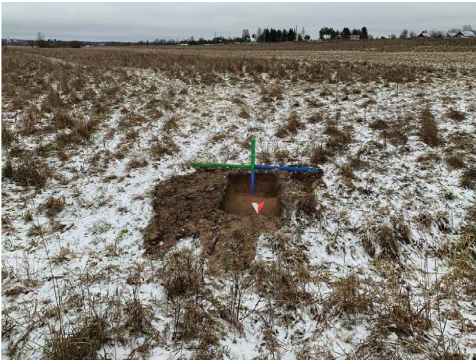
Рис.28. Шурф 1. Общий вид по матерiku. Контрольный прокоп. Вид с севера.
