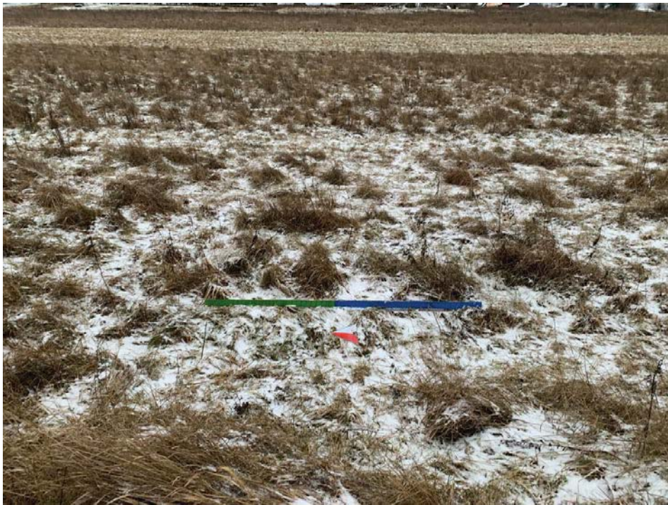
Рис.37. Шурф 3. Вид до начала работ. Вид с запада.
