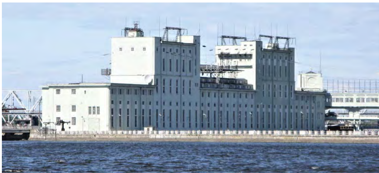
Фото 3. Общий вид ледозащитной стенки Волховской ГЭС с западной стороны
