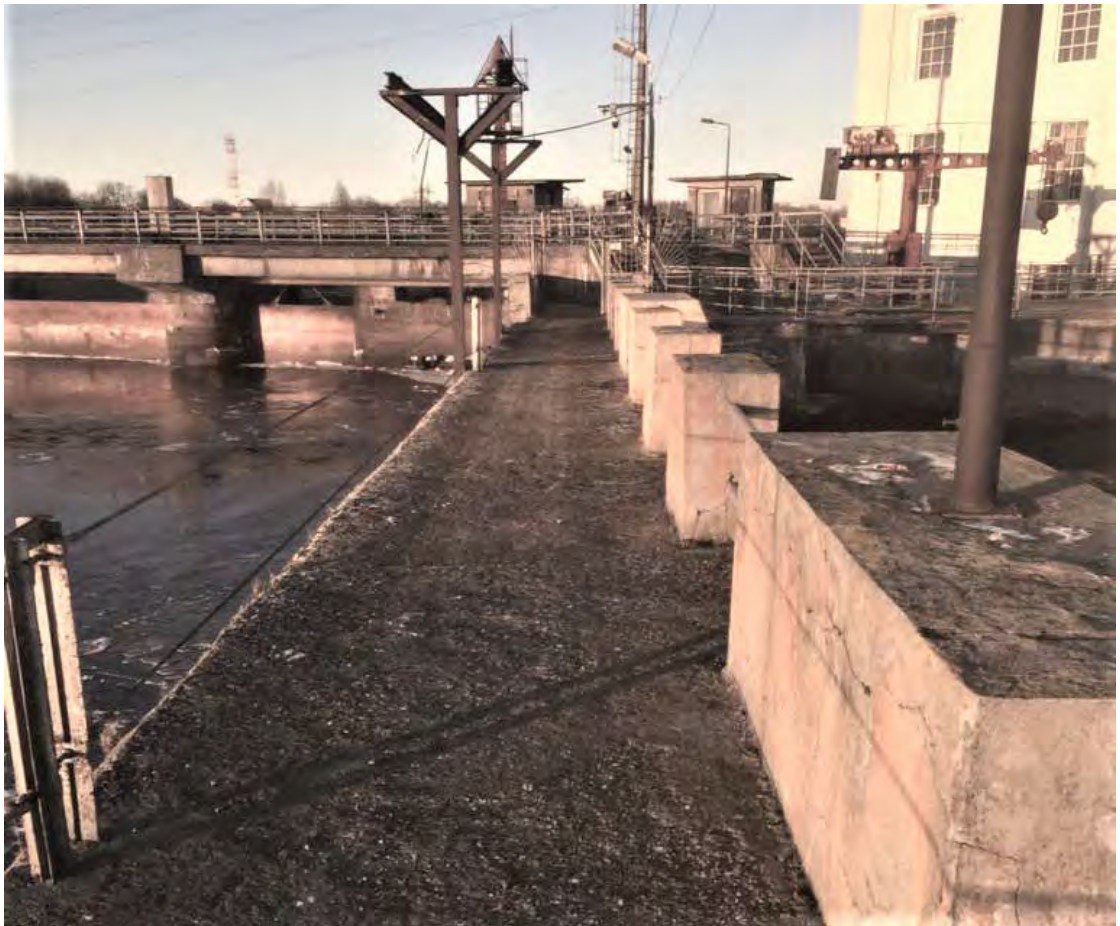
Фото 5. Ледозащитная стенка Волховской ГЭС. Вид в сторону ГЭС
