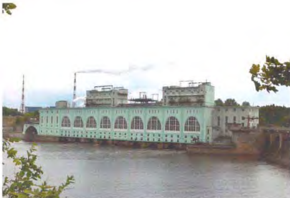
Фото 12. Ленинградская область, г. Волхов, Волховская ГЭС. Северо-западный фасад. Вид с запада.
