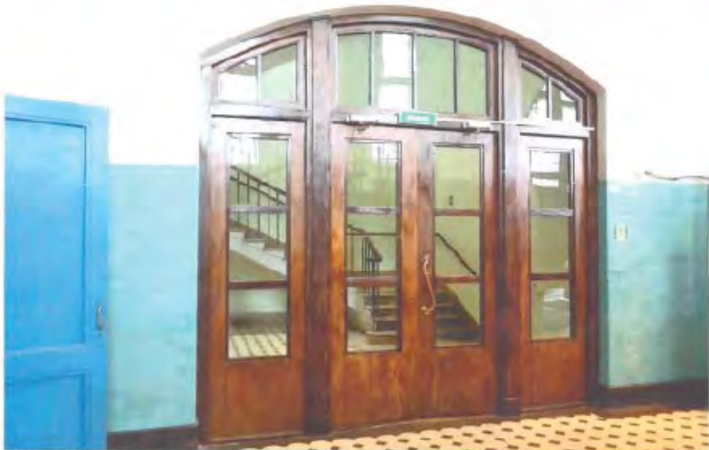
Фото 27. Ленинградская область, г. Волхов, Волховская ГЭС. Первый этаж. Историческая дверь в машинный зал. Вид с юго-востока.
