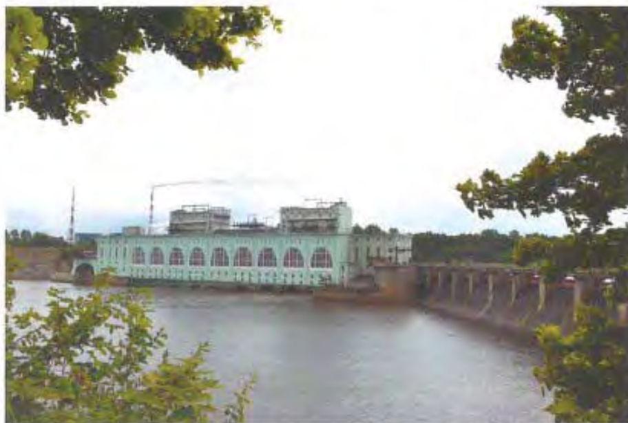
Фото 1. Ленинградская область, г. Волхов, Волховская ГЭС. Общий вид с востока.
