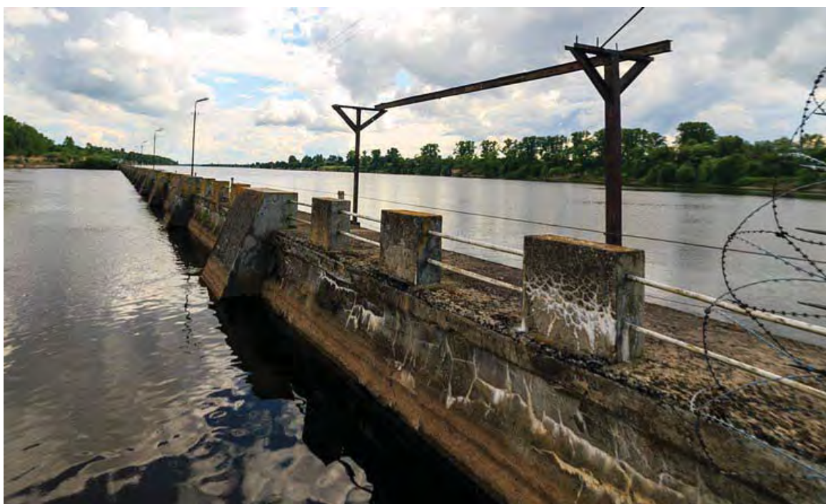
Фото 4. Ледозащитная стенка Волховской ГЭС со стороны аванкамеры
