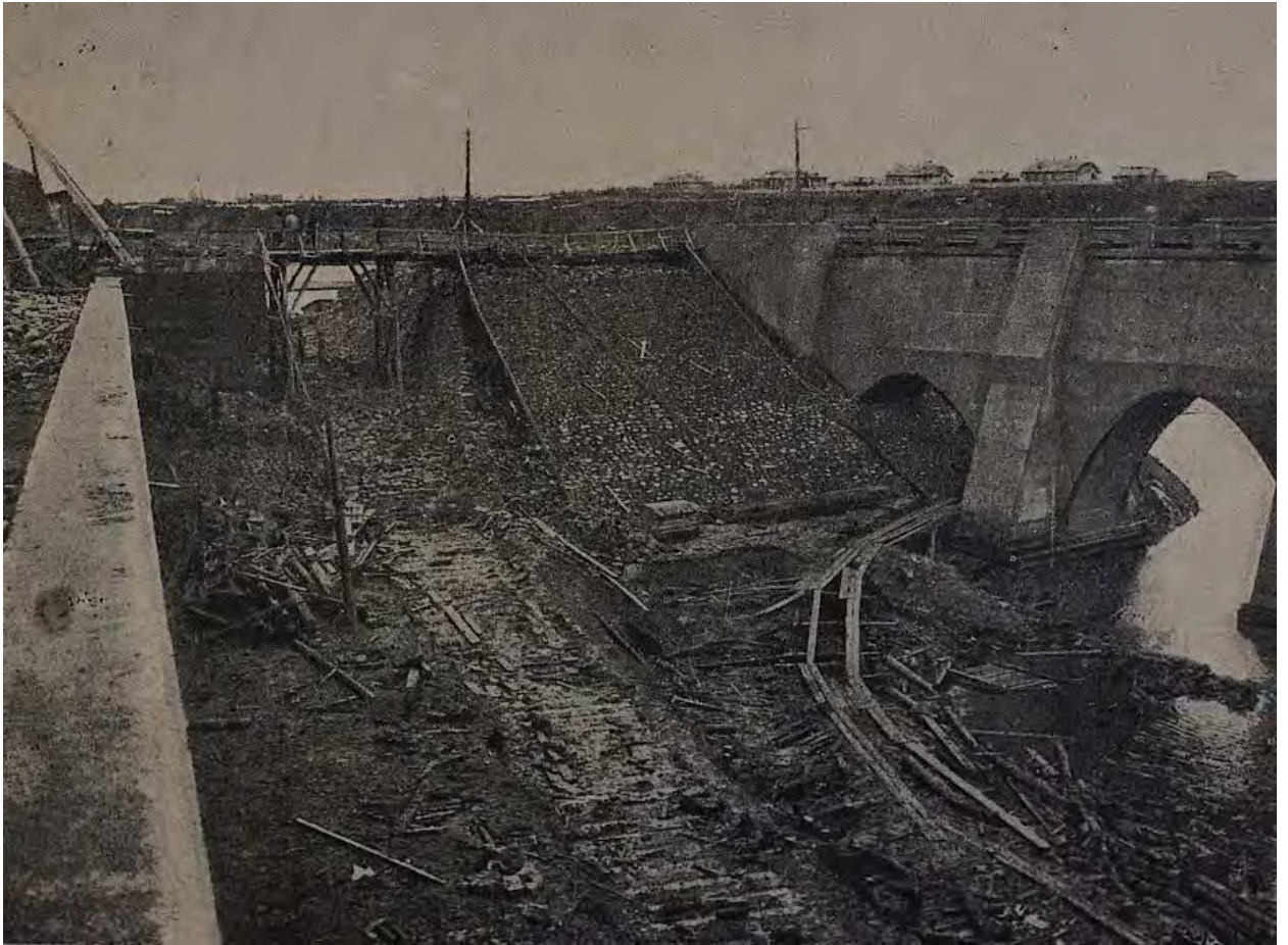
Фото 4. Вид в 1924 г. Справа видна ледозащитная стенка. http://tgcl.ru/press-center/special/2016-i-ranee/volkhovskaya90/photo/
