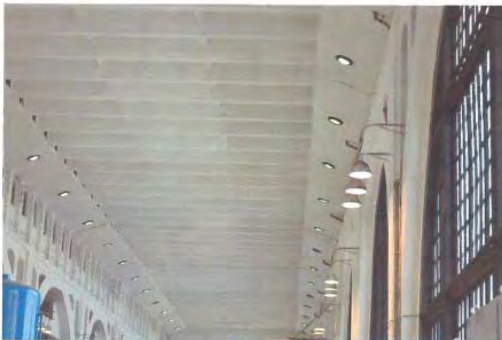
Фото 30. Ленинградская область, г. Волхов, Волховская ГЭС. Первый этаж. Потолок машинного зала. Вид с юга.
