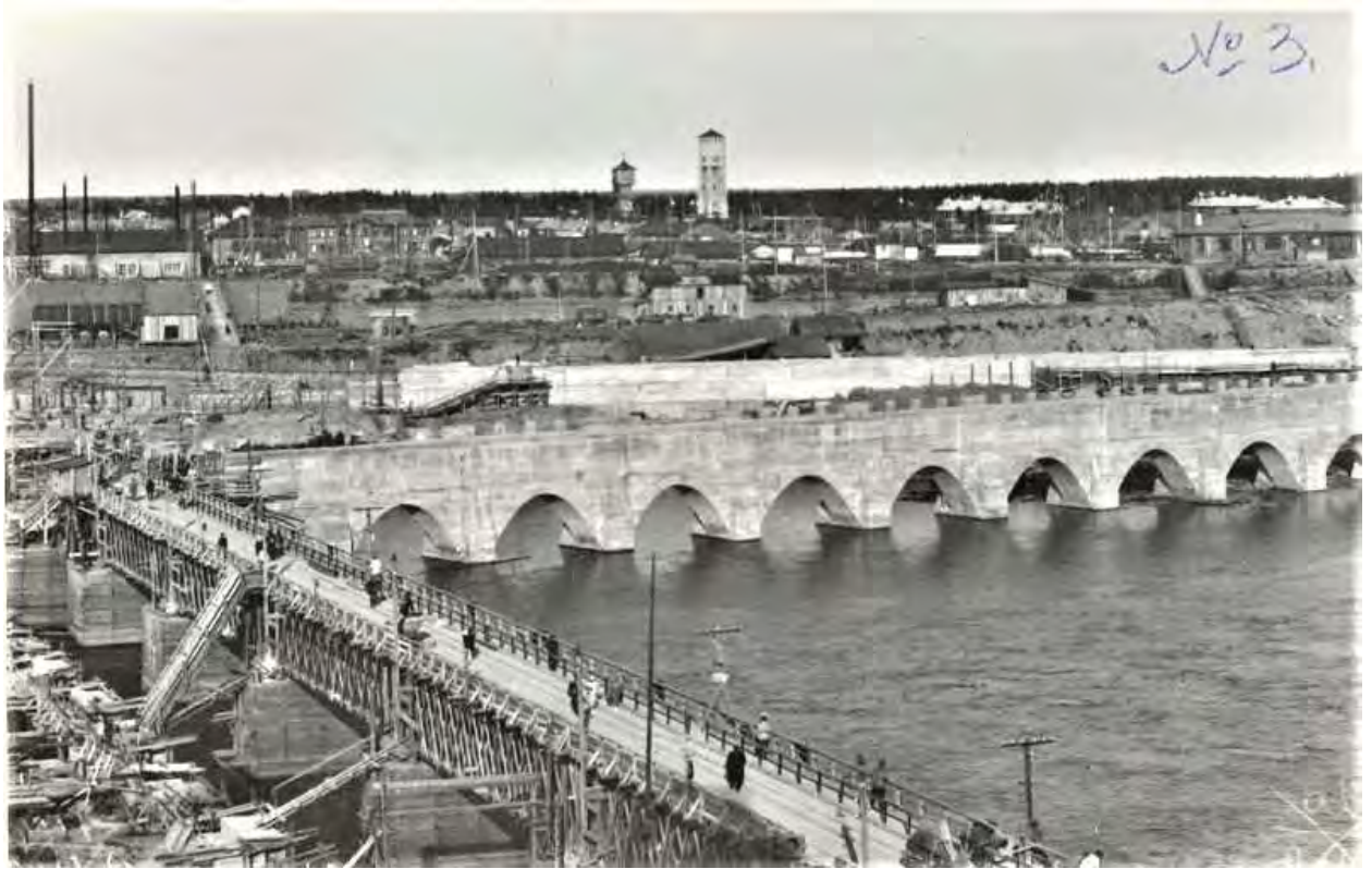
Фото 2. Строительство Волховской ГЭС в 1925 году. В центре на фотографии видна ледозащитная стенка. http://goskatalog.ru/portal/#/collections?id=4016082
