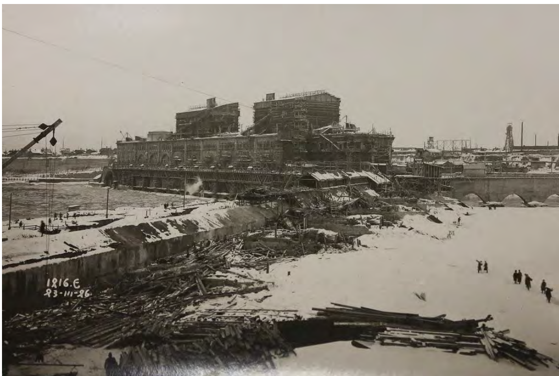
Фото 5. Волховская ГЭС 23.03.1926 г. С правой стороны видна ледозащитная стенка. https://zavodfoto.livejournal.com/3726616.html
