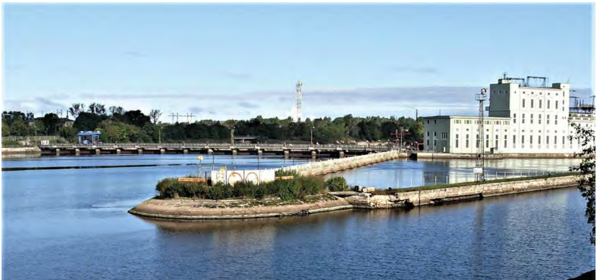
Фото 1. Общий вид ледозащитной стенки Волховской ГЭС с южной стороны
