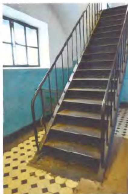
Фото 28. Ленинградская область, г. Волхов, Волховская ГЭС. Первый этаж. Чугунная лестница к пульту управления. Вид с севера.
