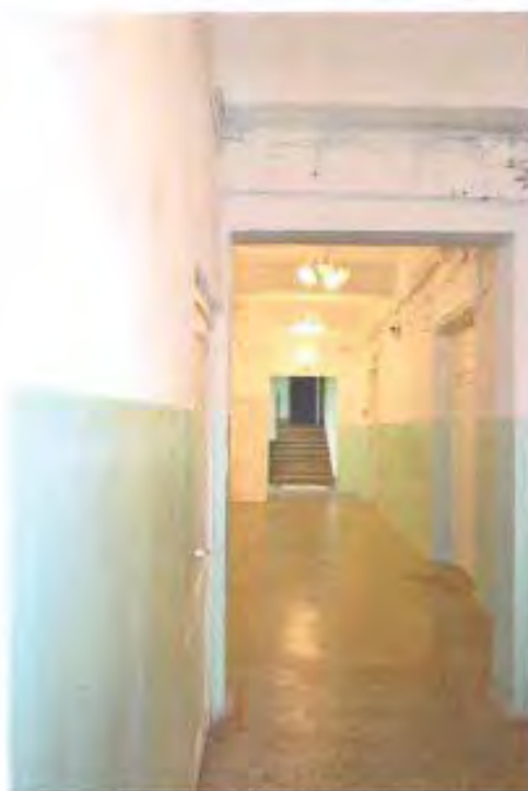
Фото 23. Ленинградская область, г. Волхов, Волховская ГЭС. Третий этаж. Коридор. Вид с северо-востока.
