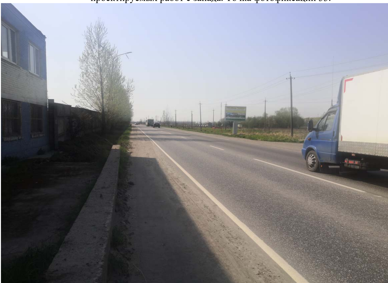
Илл. 34. Вид на автодорогу "Подъезд к г. Колпино" (41К-169) и участок проектируемых работ с севера. Точка фотофиксации 34.
