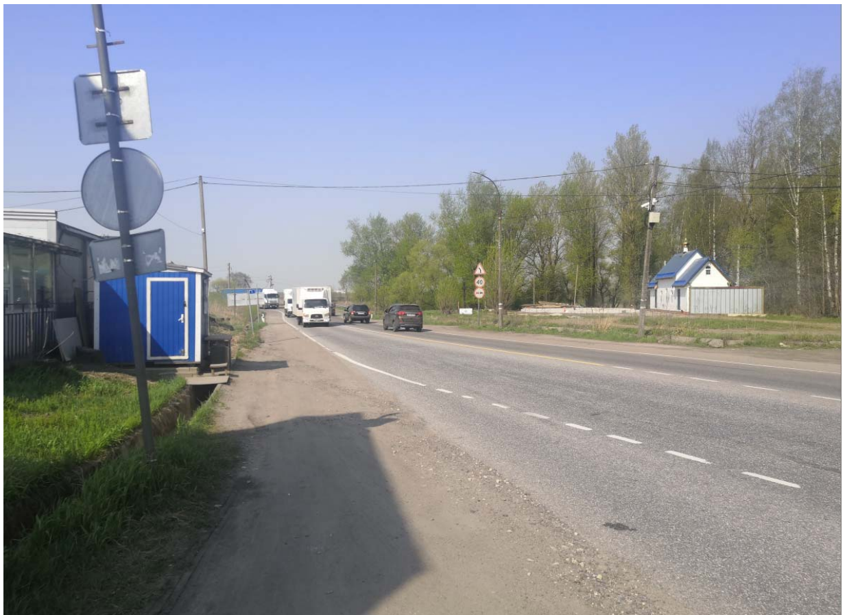
Илл. 31. Вид на автодорогу "Подъезд к г. Колпино" (41К-169) и участок проектируемых работ с востока. Точка фотофиксации 31.
