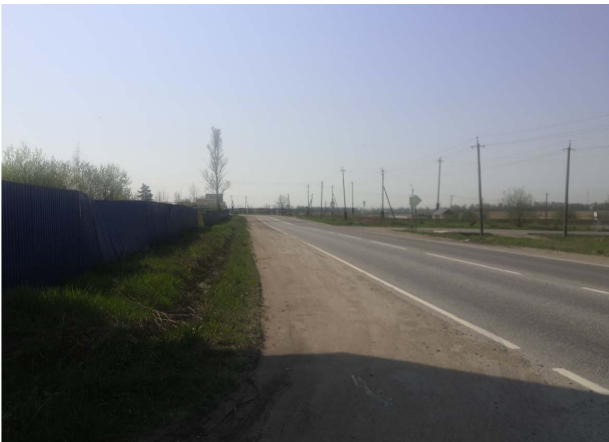
Илл. 37. Вид на автодорогу "Подъезд к г. Колпино" (41К-169) и участок проектируемых работ с севера. Точка фотофиксации 37.
