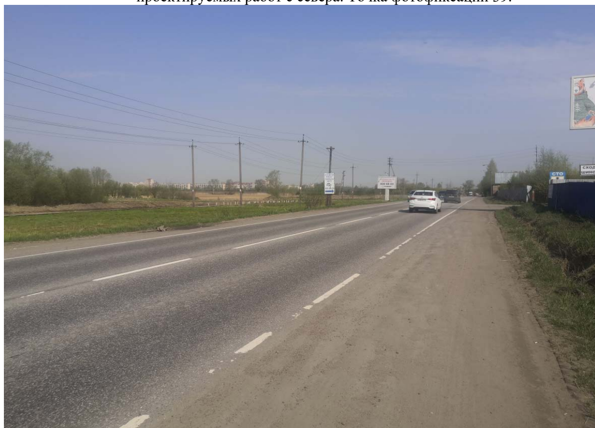
Илл. 40. Вид на автодорогу "Подъезд к г. Колпино" (41К-169) и участок проектируемых работ с юга. Точка фотофиксации 40.
