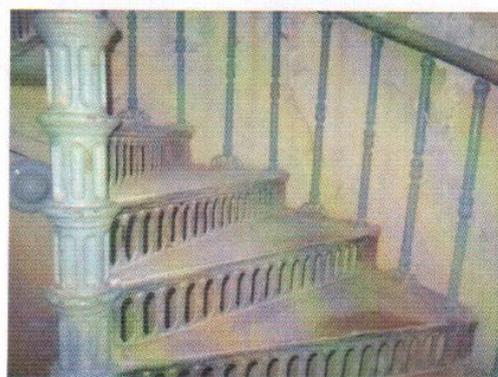
Две металлические винтовые лестницы (чугунное литье) с чугунными ступенями, ажурными литыми подступенками и стойками ограждения.
