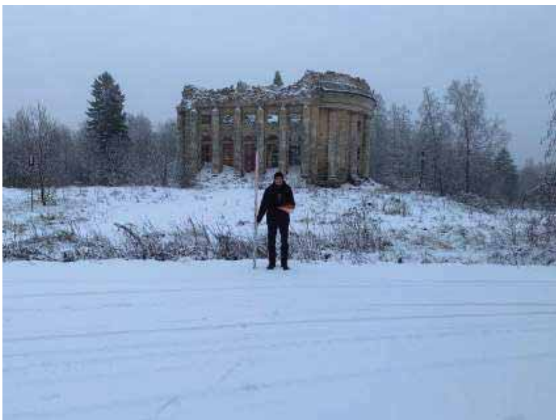
Илл.23. Ленинградская обл. Калитинское сельское поселение, Волосовский район. Точка фотофиксации 11. Общий вид на участок обследования с запада. Для масштаба использована нивелировочная рейка длиной 2 м.
