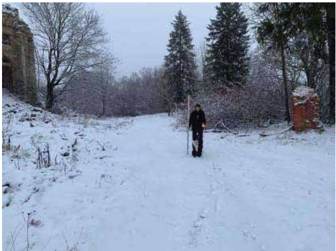
Илл.27. Ленинградская обл. Калитинское сельское поселение, Волосовский район. Точка фотофиксации 11. Общий вид на участок обследования с юга. Для масштаба использована нивелировочная рейка длиной 2 м.
