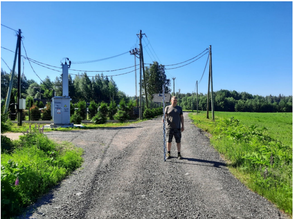
Илл. 34. Ленинградская обл., Выборгский район. Точка фотофиксации 4.
