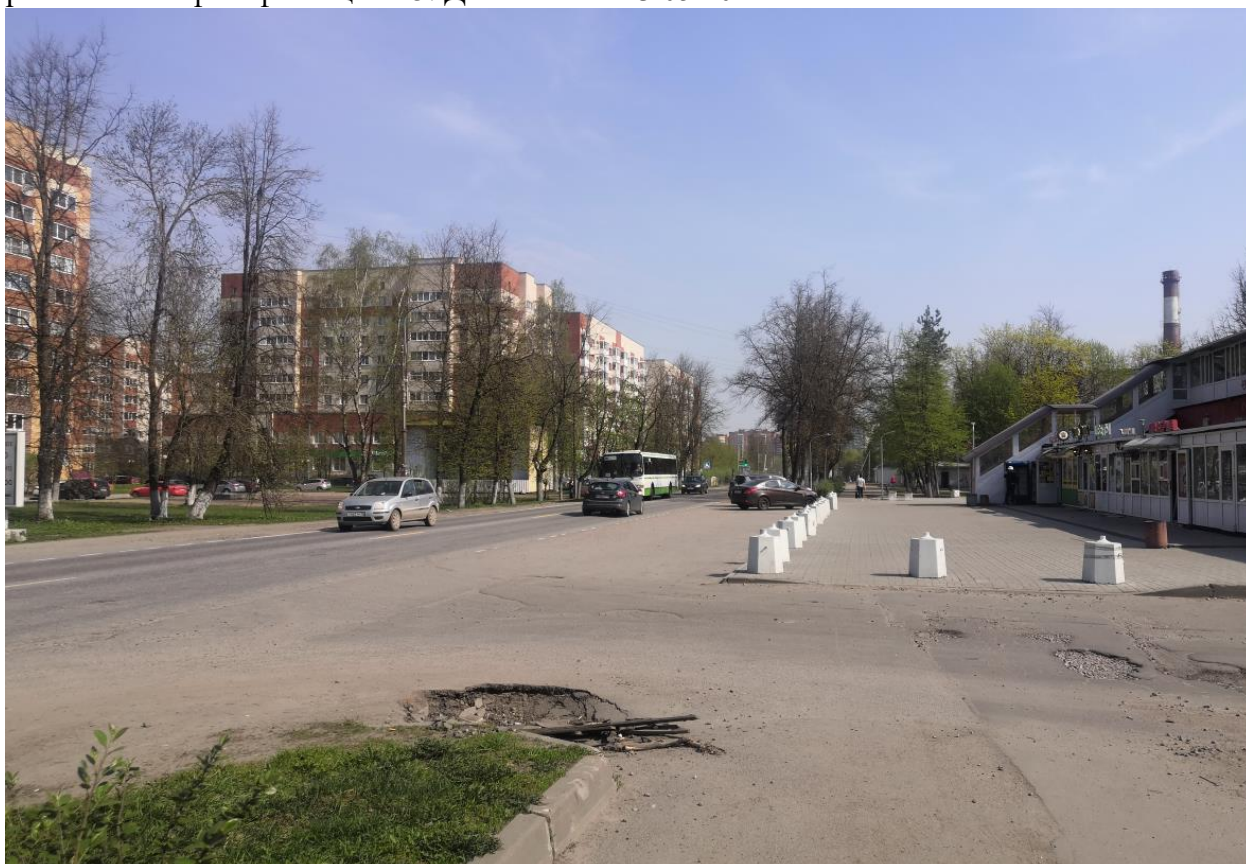
Рис. 44 Вид на автодорогу "Подъезд к г. Колпино" (41К-169) и участок проектируемых работ. Точка фотофиксации 16. Дата съемки 13.05.2021.
