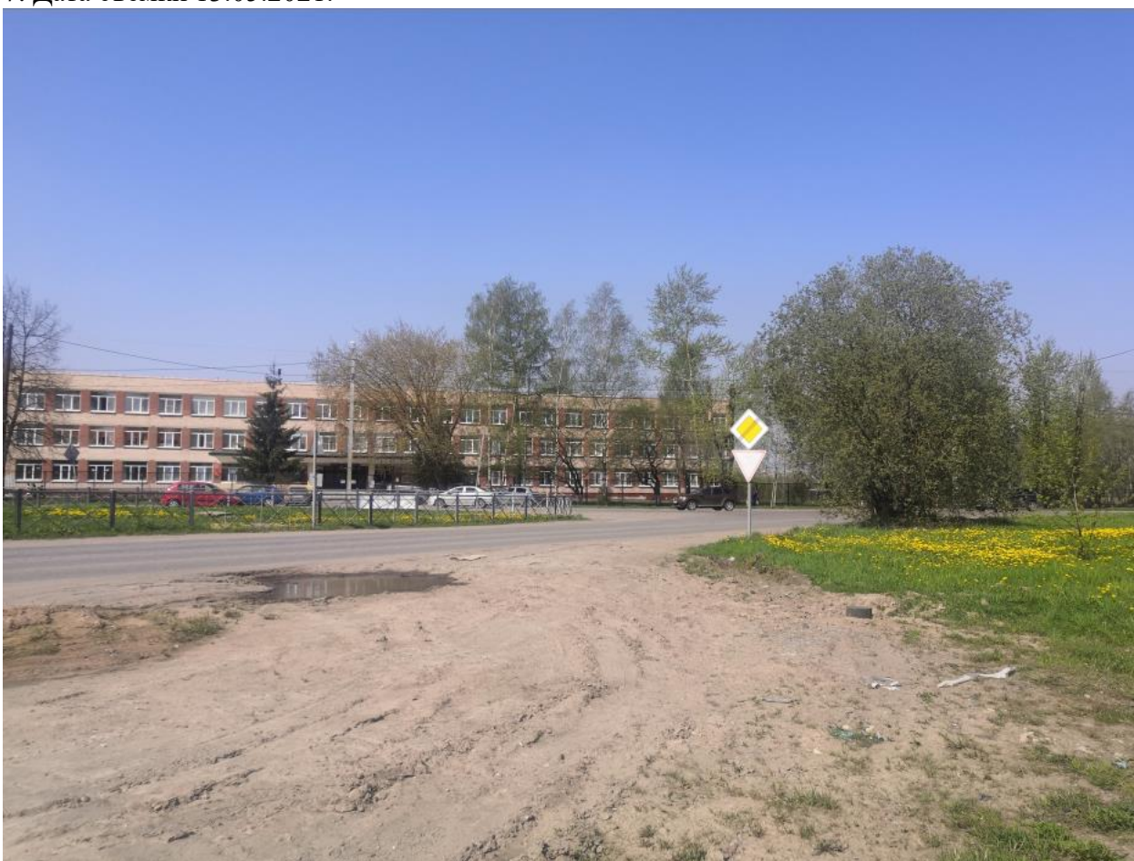
Рис. 36 Вид на Красноборскую ул. и участок проектируемых работ. Точка фотофиксации 8. Дата съемки 13.05.2021.
