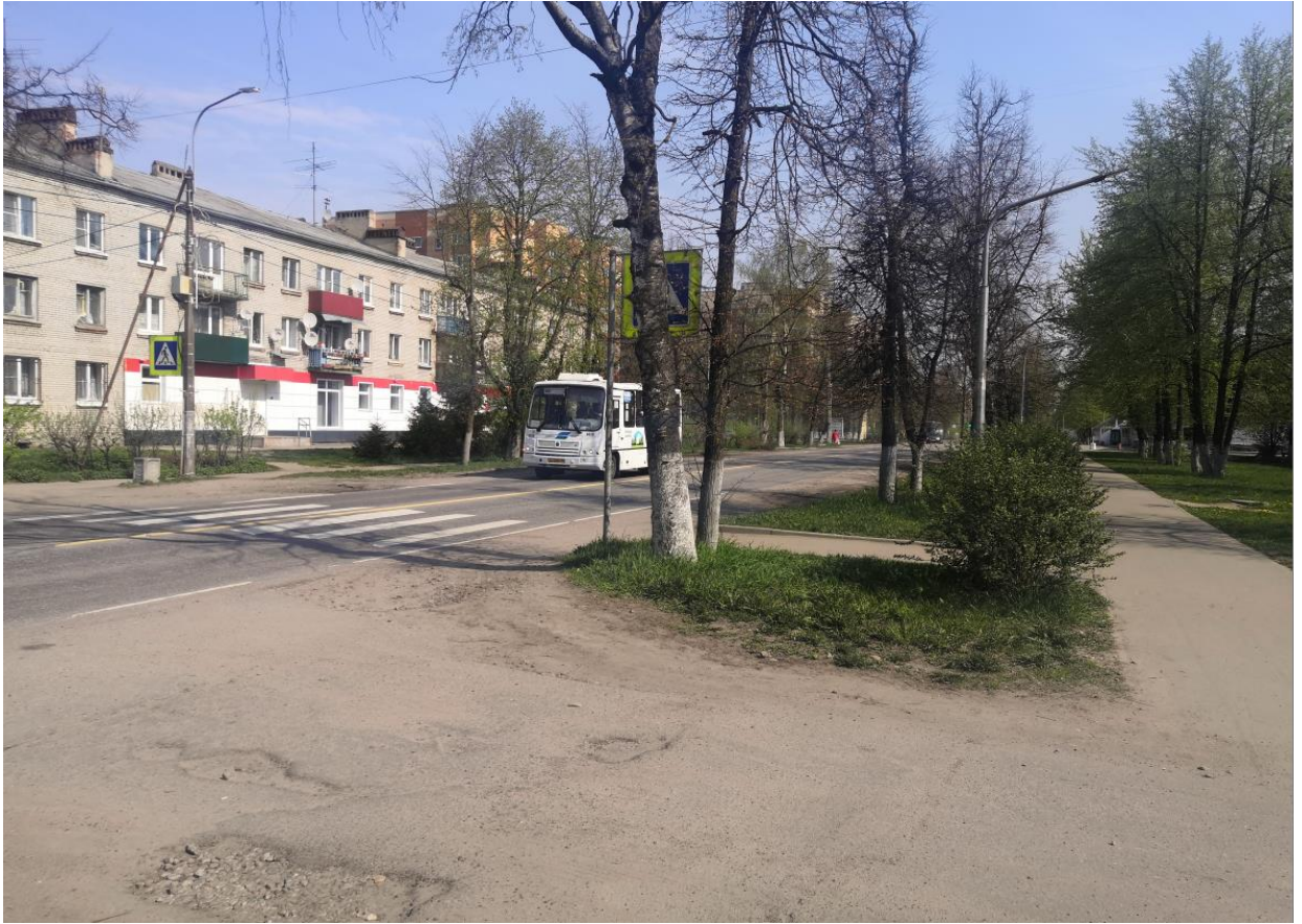
Рис. 45 Вид на автодорогу "Подъезд к г. Колпино" (41К-169) и участок проектируемых работ. Точка фотофиксации 17. Дата съемки 13.05.2021.
