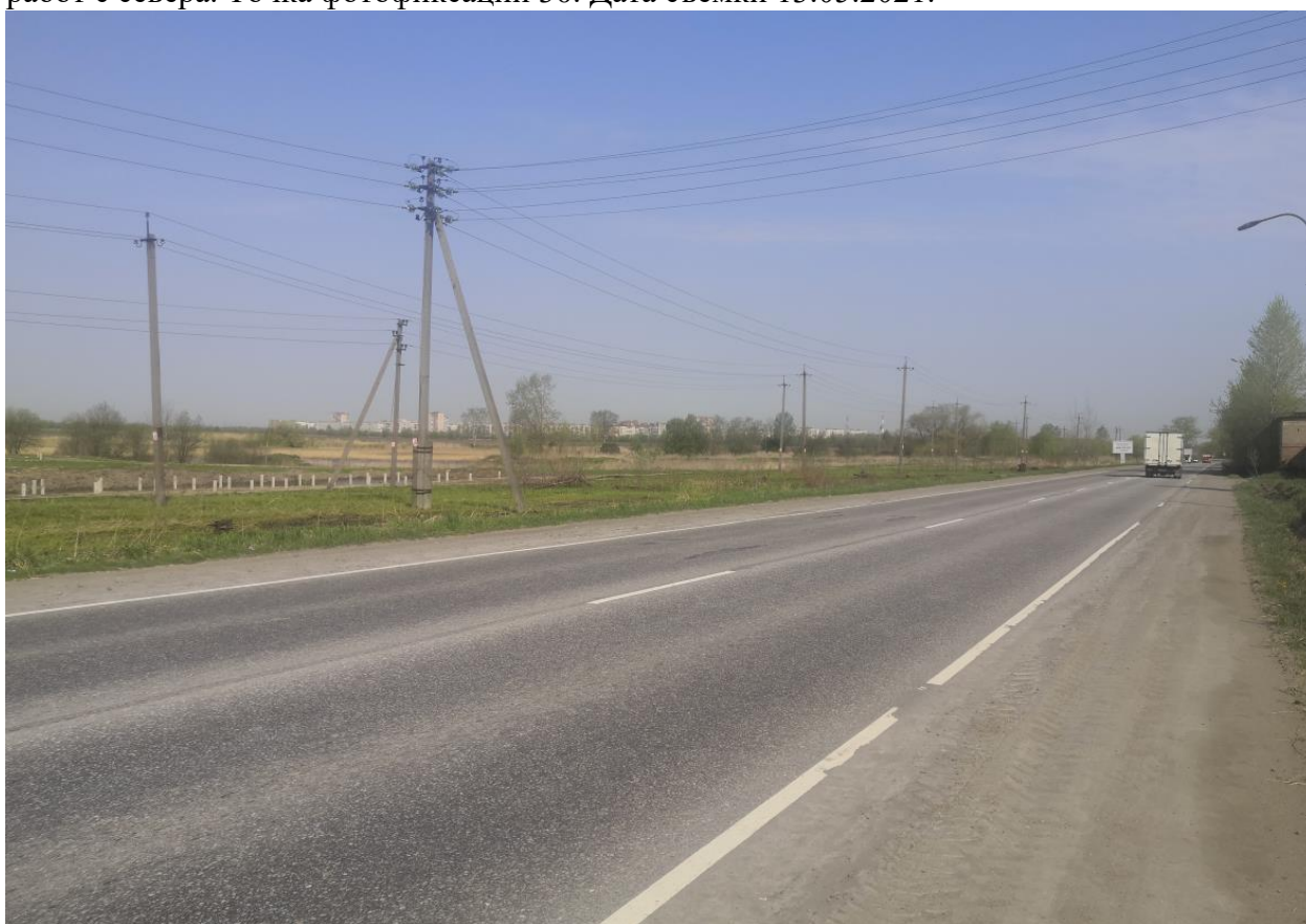
Рис. 59 Вид на автодорогу "Подъезд к г. Колпино" (41К-169) и участок проектируемых работ с юга. Точка фотофиксации 31. Дата съемки 13.05.2021.
