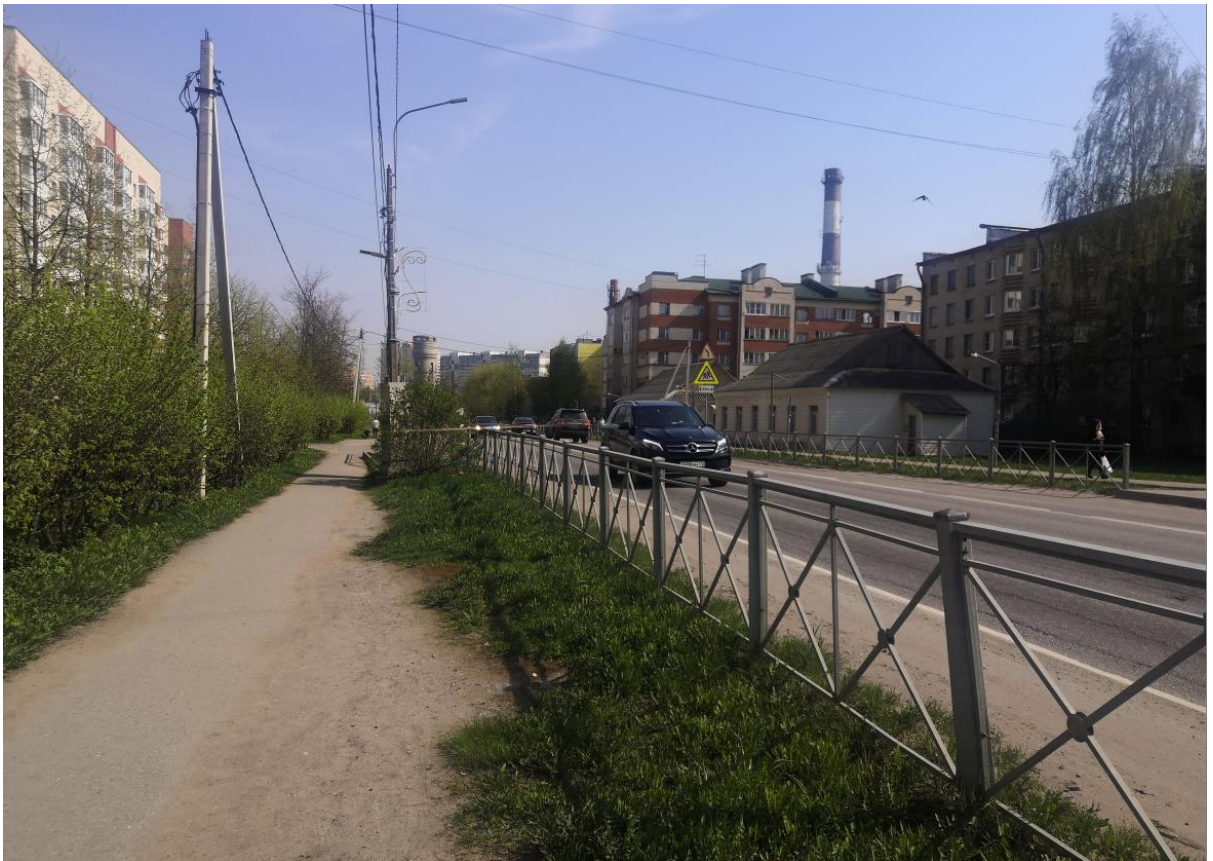
Рис. 41 Вид на автодорогу "Подъезд к г. Колпино" (41К-169) и участок проектируемых работ. Точка фотофиксации 13. Дата съемки 13.05.2021.
