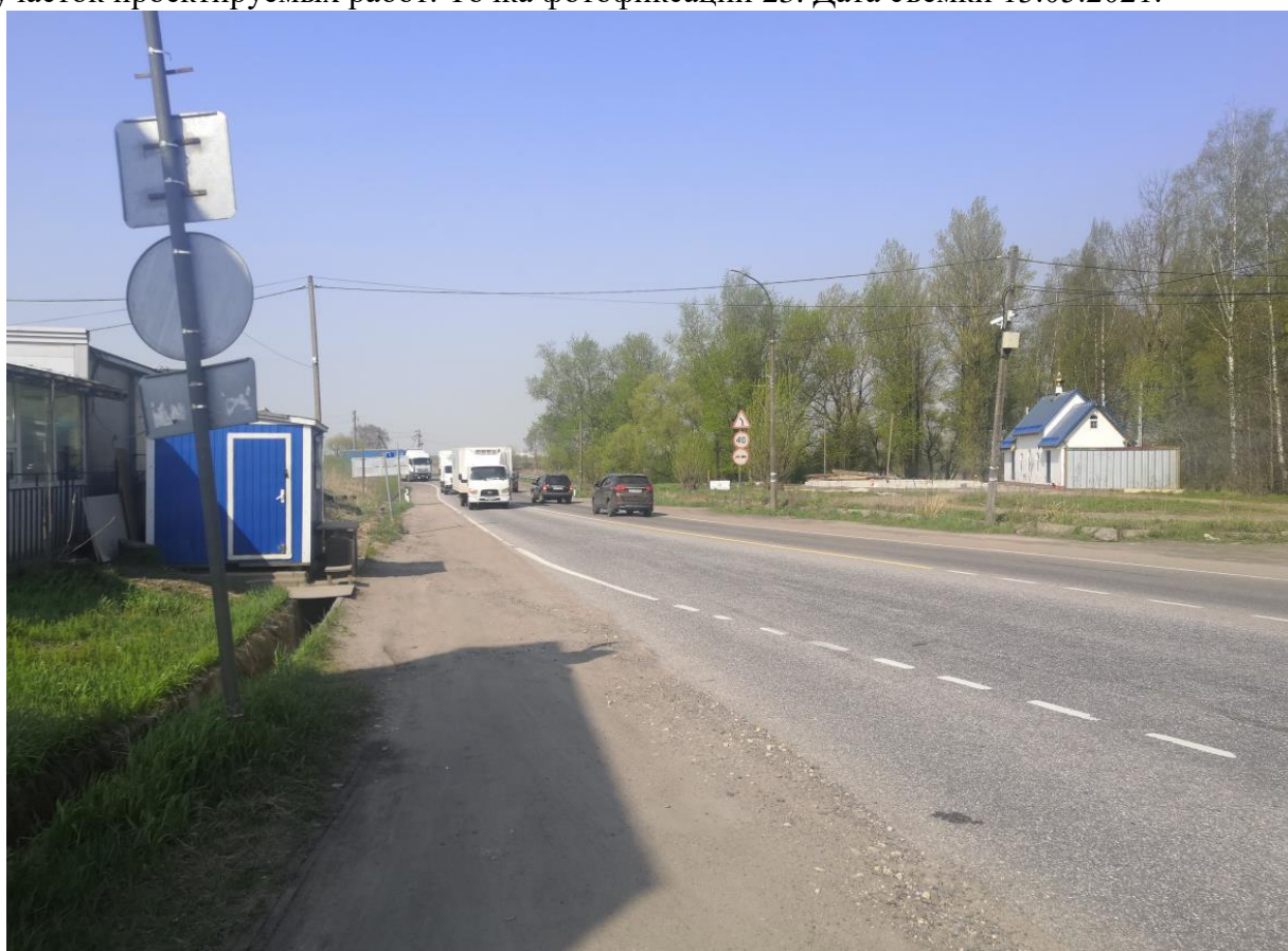
Рис. 52 Вид на автодорогу "Подъезд к г. Колпино" (41К-169) и участок проектируемых работ с востока. Точка фотофиксации 24. Дата съемки 13.05.2021.
