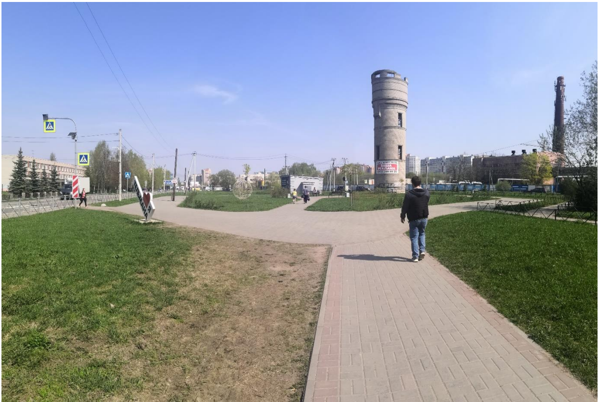
Рис. 39 Вид на участок проектируемых работ между ул. Красноборской и автодорогой "Подъезд к г. Колпино" (41К-169). Точка фотофиксации 11. Дата съемки 13.05.2021.
