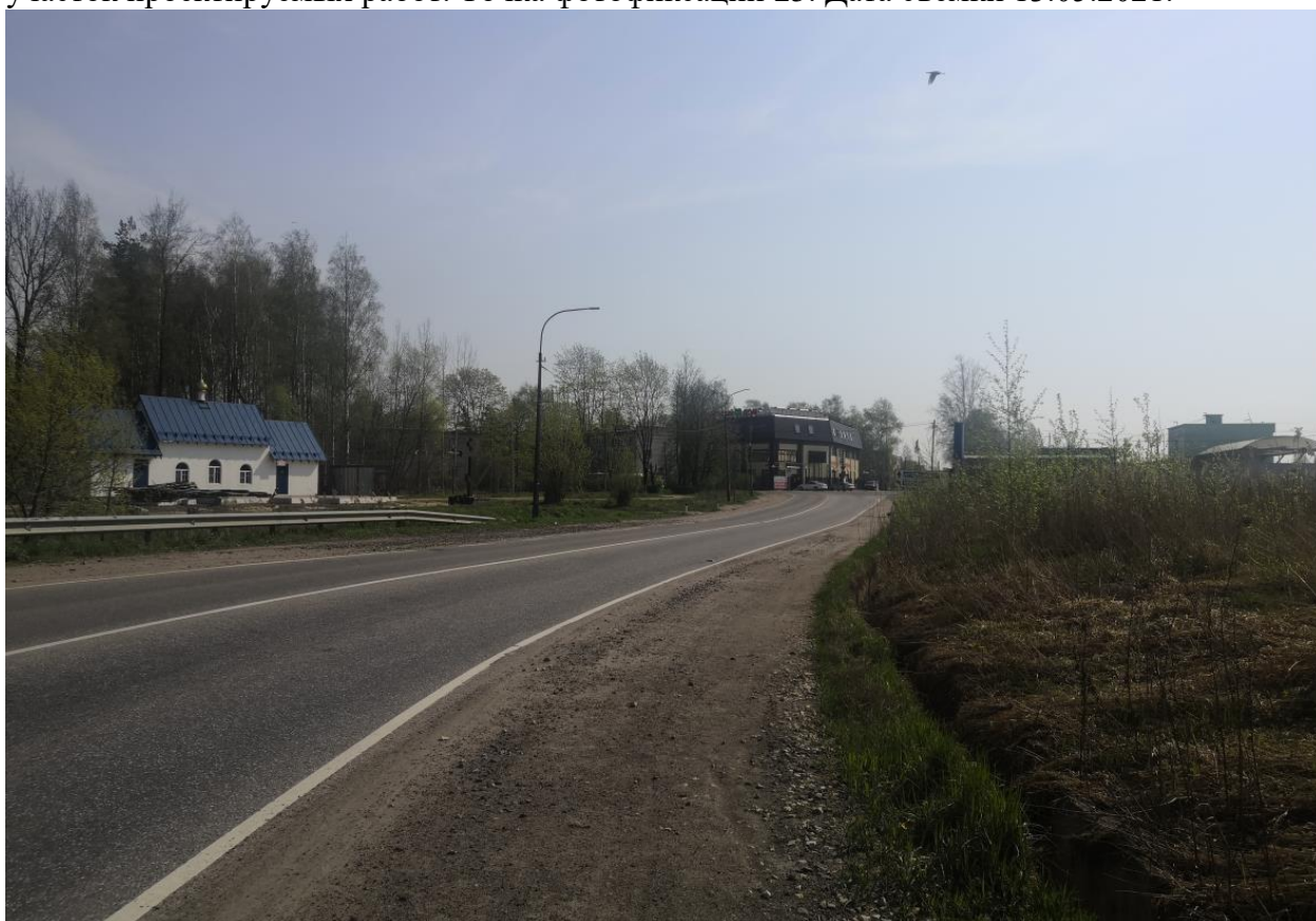
Рис. 54 Вид на автодорогу "Подъезд к г. Колпино" (41К-169) и участок проектируемых работ с запада. Точка фотофиксации 26. Дата съемки 13.05.2021.
