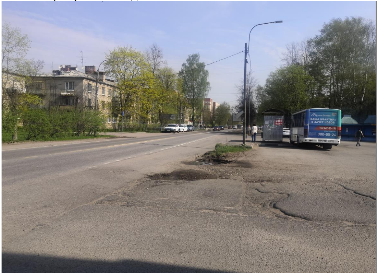
Рис. 48 Вид на автодорогу "Подъезд к г. Колпино" (41К-169) и участок проектируемых работ. Точка фотофиксации 20. Дата съемки 13.05.2021.
