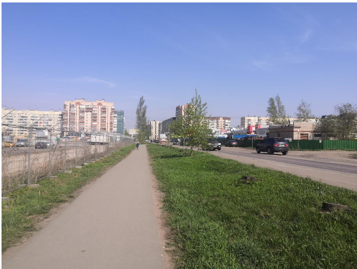
Рис. 33 Вид на автодорогу "Подъезд к г. Колпино" (41К-169) и участок проектируемых работ. Точка фотофиксации 5. Дата съемки 13.05.2021.
