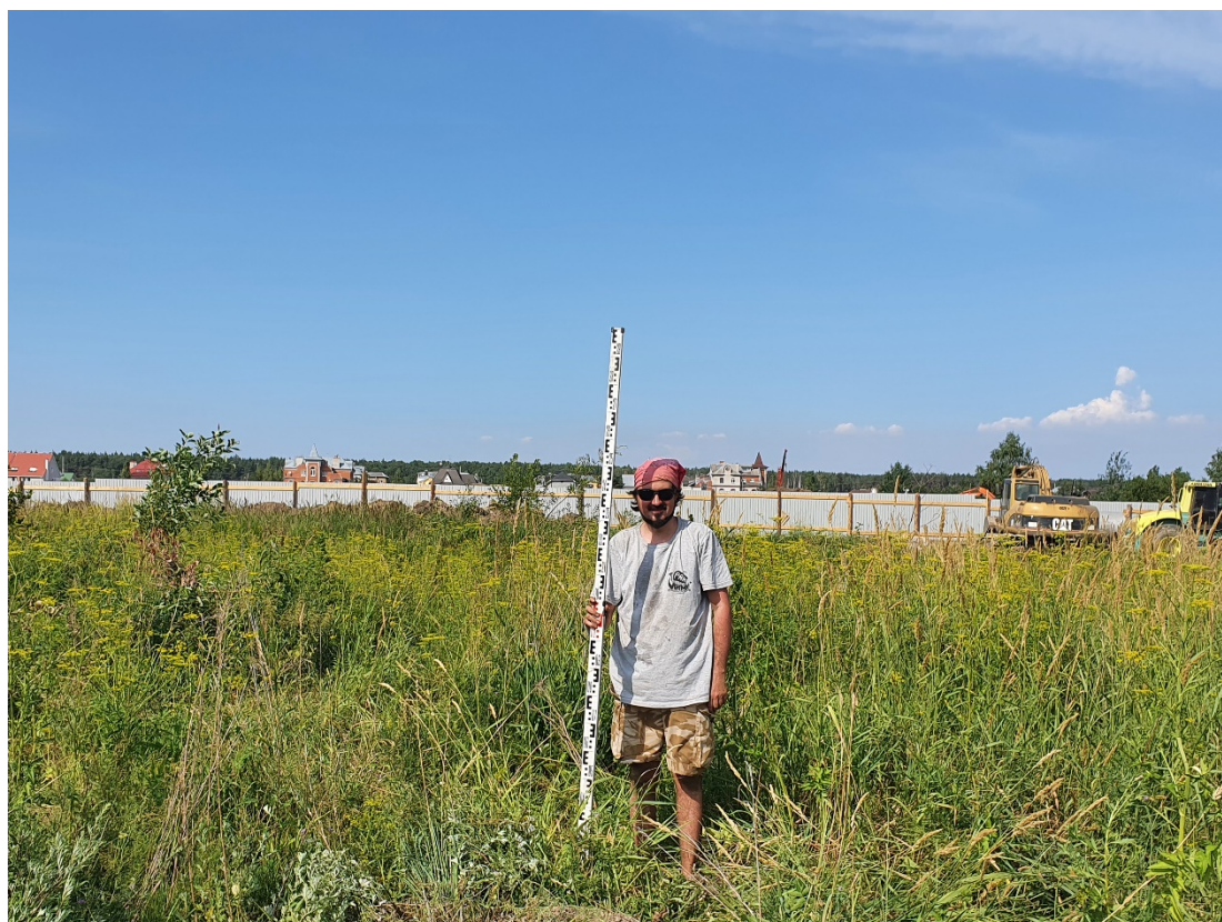
Рис. 55. ЛО-2021. Ломоносовский район. Аннинское городское поселение, гп. Новоселье. Общий вид участка обследования. Шурф 6. До начала работ. Вид с юга
