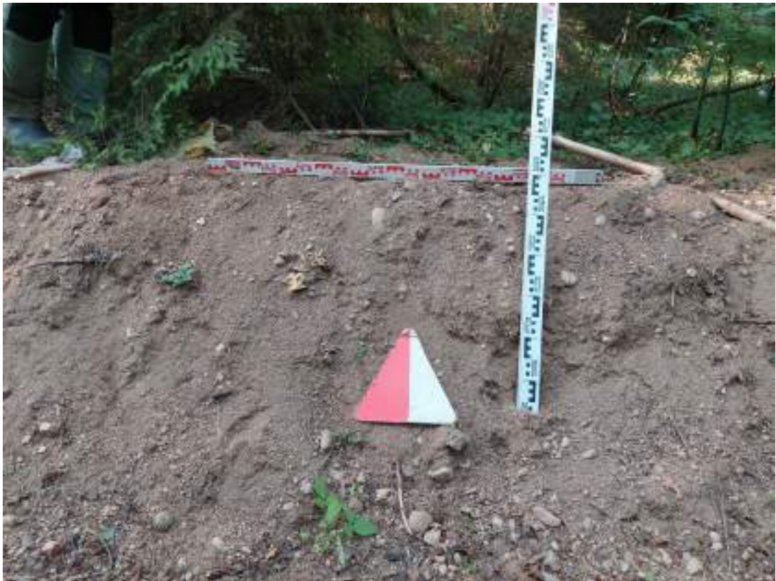
Рис. 136. Ленинградская обл., Всеволожский район, Рахьинское городское поселение -2019 г. Зачистка №3. До начала работ. Вид с Ю.
