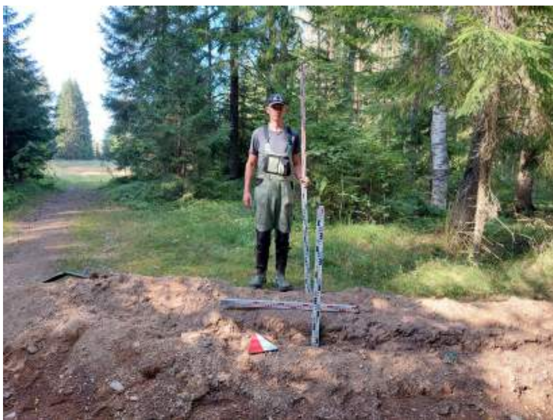
Рис. 131. Ленинградская обл., Всеволожский район, Рахьинское городское поселение -2019 г. Зачистка №2. Местоположение. Вид с Ю-ЮЗ.
