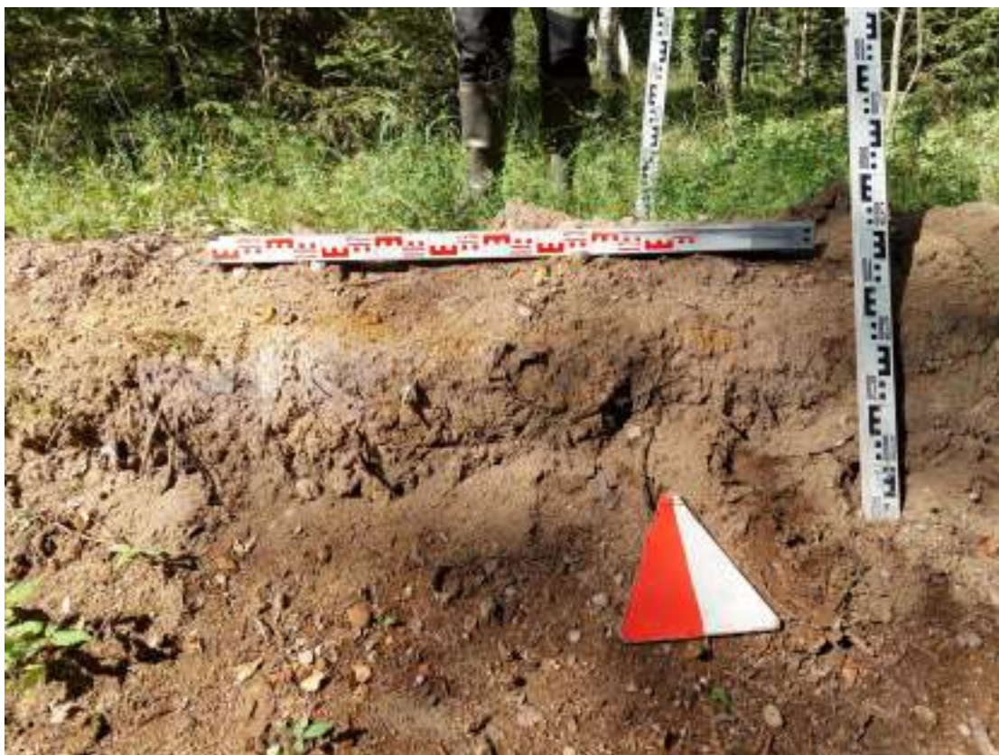
Рис. 128. Ленинградская обл., Всеволожский район, Рахьинское городское поселение -2019 г. Зачистка №1. До начала работ. Вид с Ю.
