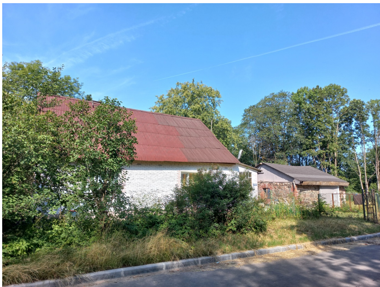
Фото 5. Северо-западная часть парка. Справа на фото – “Служебный корпус” северный. Направление съемки – север.
