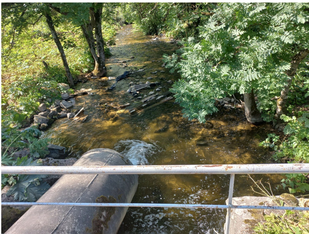
Фото 4. Вид с моста-плотины. Фрагменты конструкций исторической кладки устоев моста из известняковых плит. Направление съемки – юго-запад.
