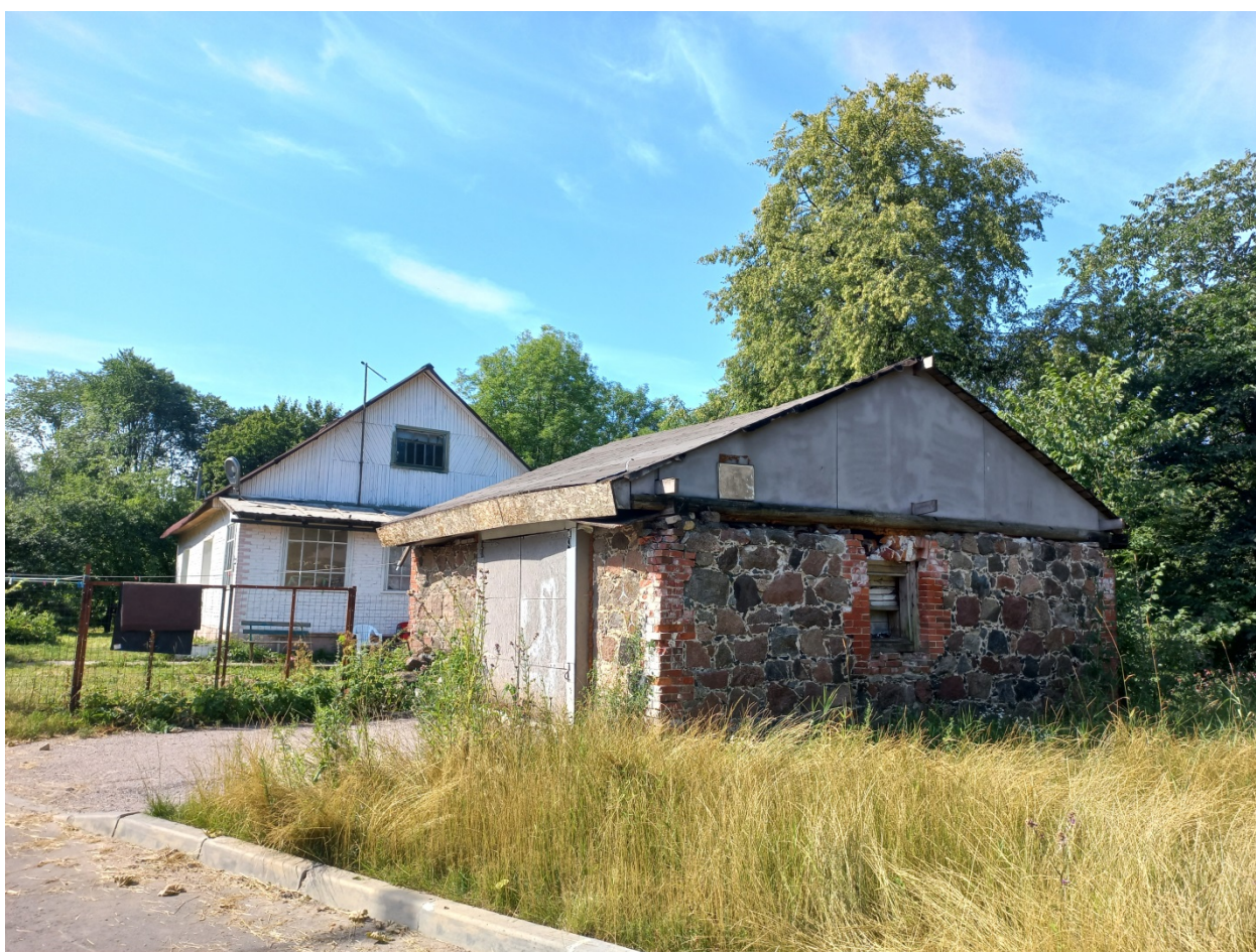
Фото 6. Северо-западная часть парка. Справа на фото – “Служебный корпус” северный. Направление съемки – юг.
