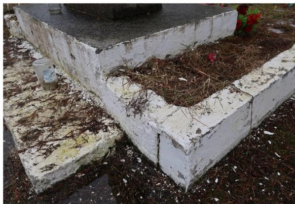
Дефекты бетонного основания, деструкция окрасочного покрытия
