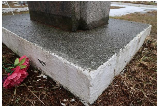
Основание обелиска из блока серого гранита, фиксируются биопоражения в местах скопления влиги, обрастание мхами, поздняя окраска поверхности камня
