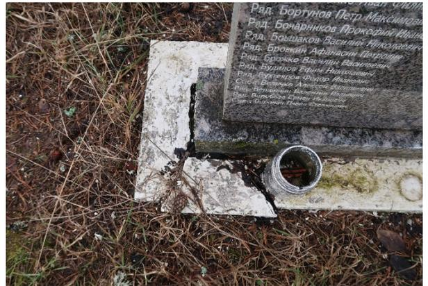
Фиксируются загрязнения, дефекты оснований, трещины, фрагментирование
