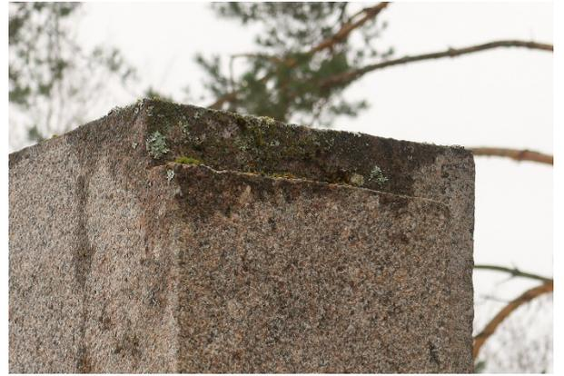
Определяются биопоражения, обрастание поверхности мхом лишайником
