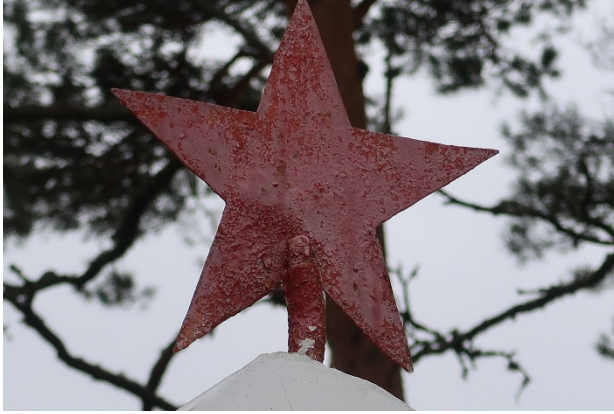
Звезда, определяются множественные дефекты, шелушение окрасочного покрытия
