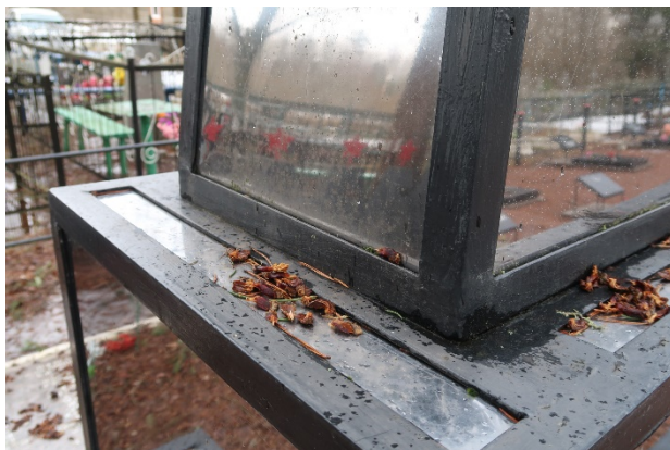
Звезда, определяются дефекты, деструкция окрасочного покрытия
