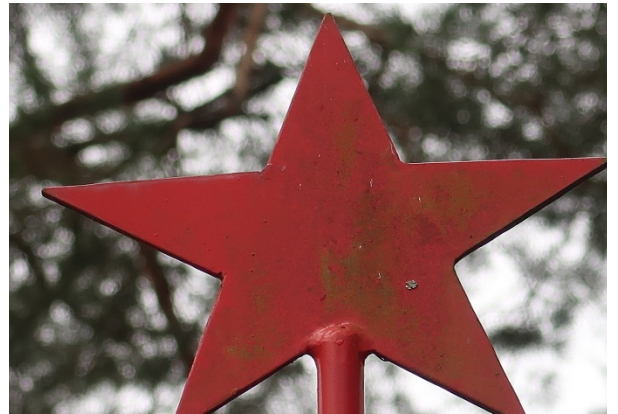
Звезда, определяются дефекты, деструкция окрасочного покрытия
