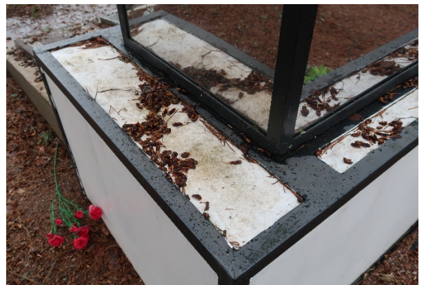
Звезда, определяются дефекты, деструкция окрасочного покрытия
