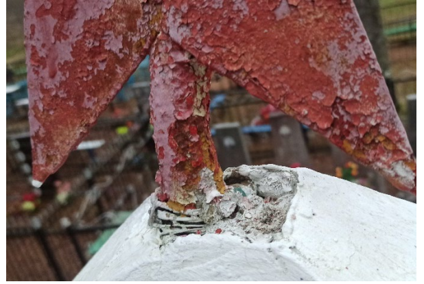
Звезда, определяются множественные дефекты, шелушение окрасочного покрытия
