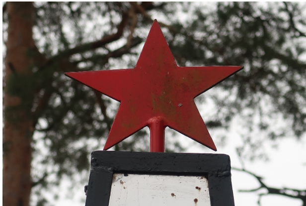
Звезда, определяются дефекты, деструкция окрасочного покрытия
