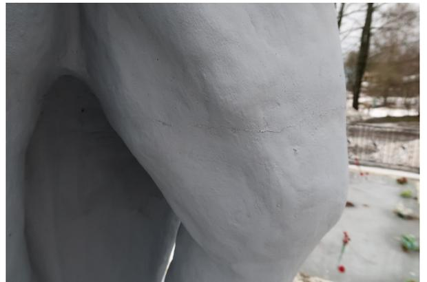
Поперечные трещины составных элементов в местах армирующих элементов
