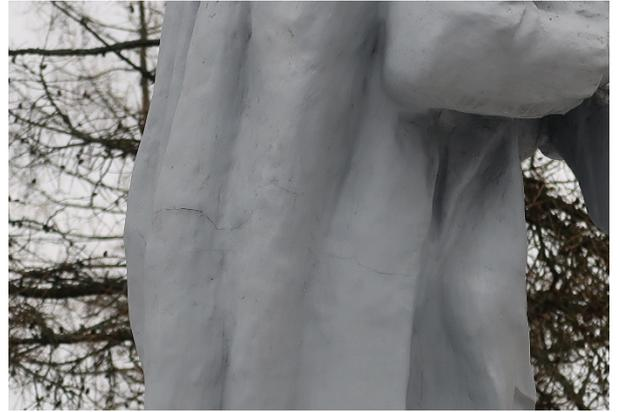
Трещины, местами осыпи, поверхностная и глубокая деструкция раствора
