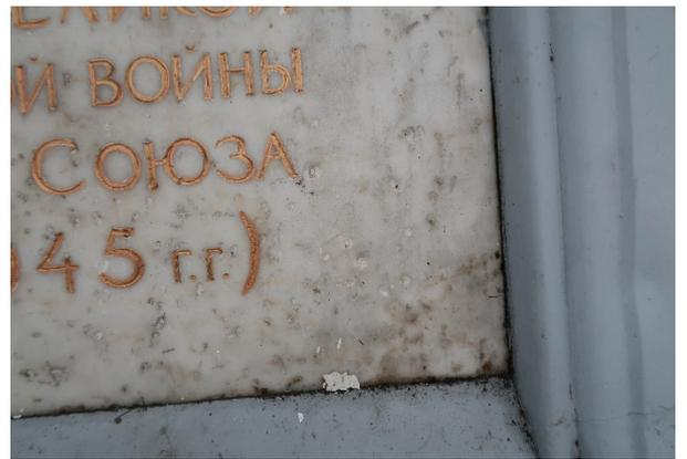
Определяются загрязнения, биопоражения, эрозия и выветривание поверхности
