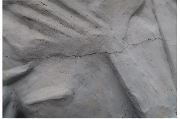
Поперечные трещины составных элементов скульптуры и в местах армирующих элементов, при доступе влаги – коррозия армирующих элементов
