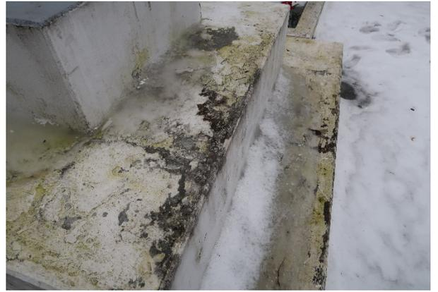
Определяются множественные дефекты, загрязнения, развитие очагов биопоражений, глубокие трещины, отслоения от основы, деструкция окрасочного покрытия
