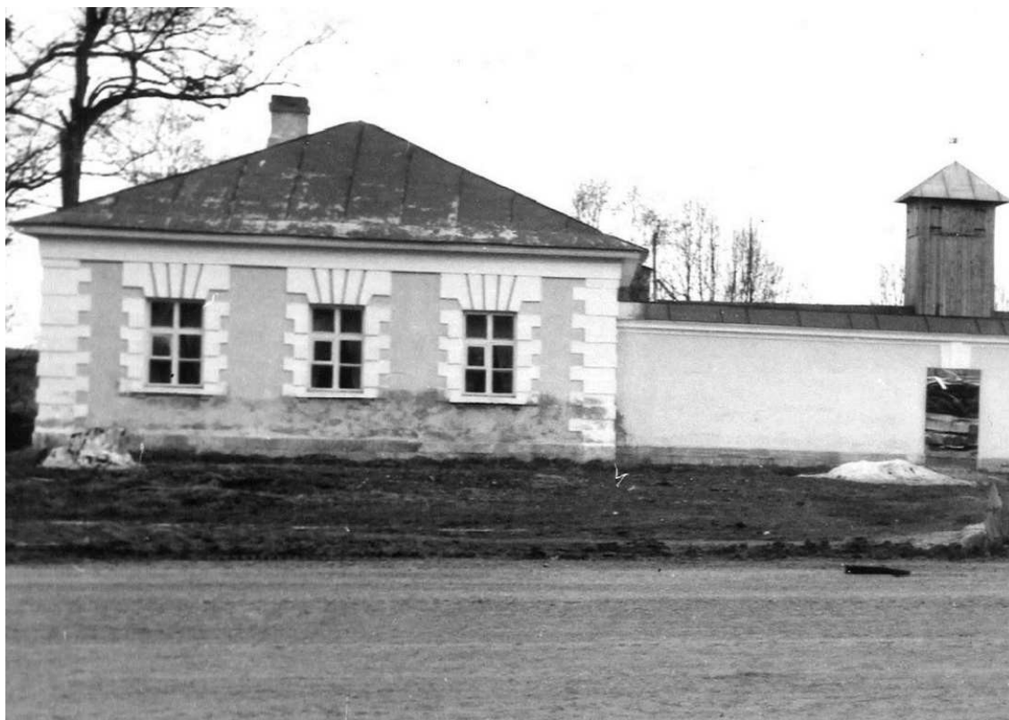
30. Главный фасад южного почтового корпуса. 1986 г. Фото А. Плошко.
