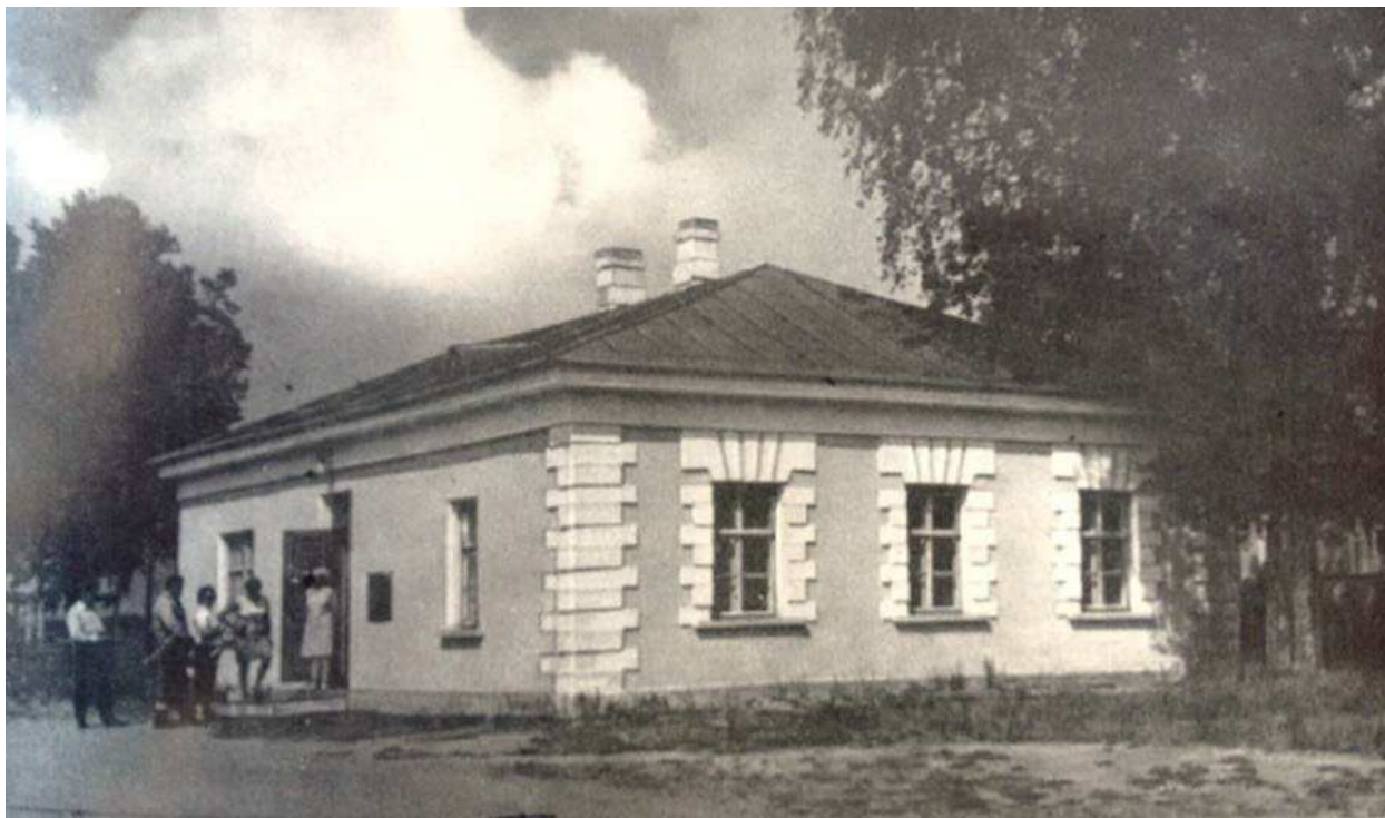
16. Дом станционного смотрителя. Фото 1977 г.
