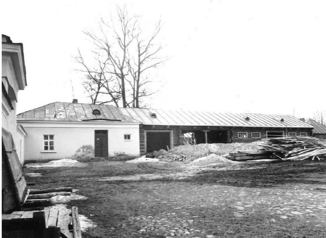
31. Дворовые фасады южного почтового корпуса и конюшен в процессе завершения работ. 1986 г. Фото А. Плошко.
