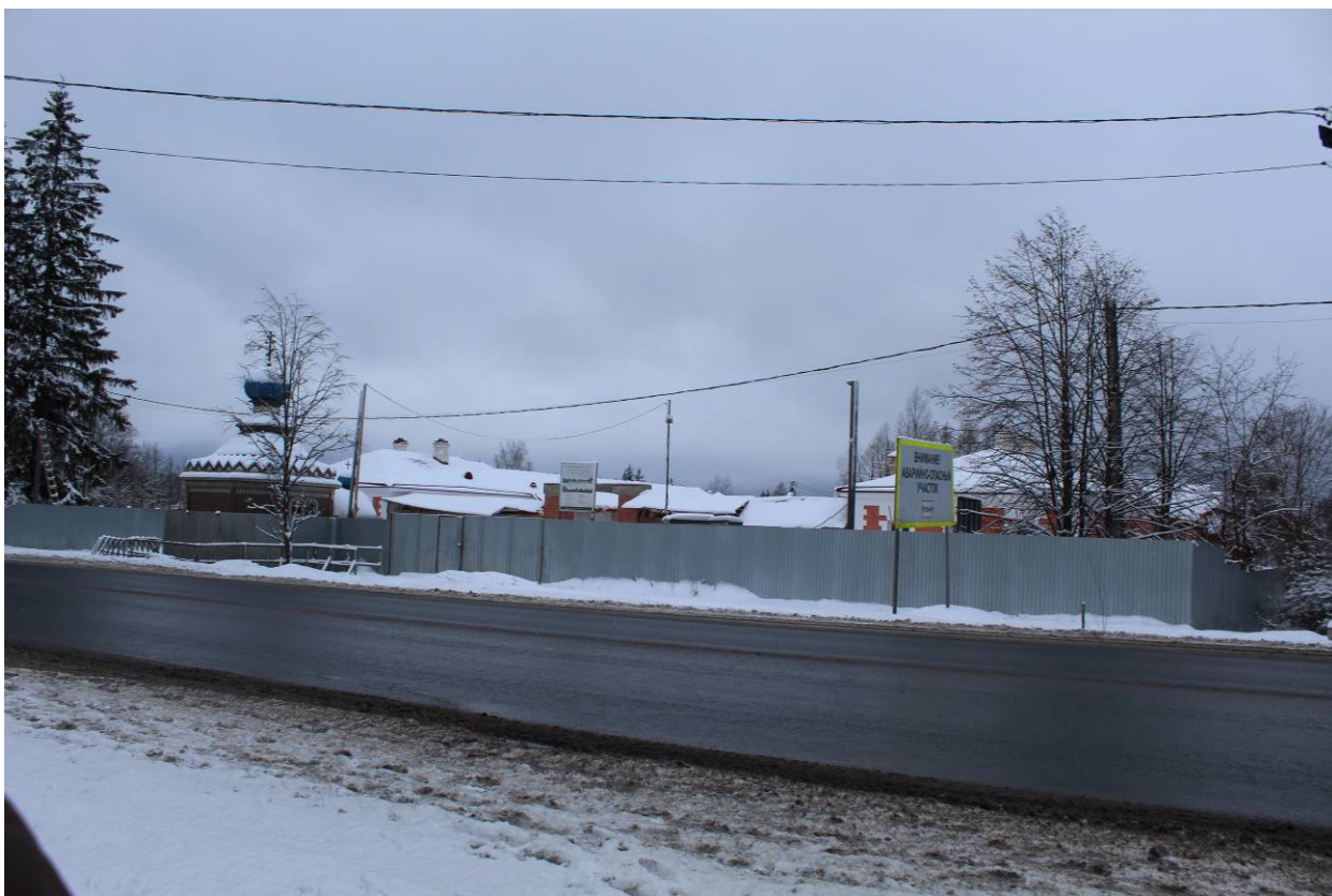
5. ГИКЭ. Вид на «Дом для проезжающих», «Здание почтовой станции» с северо-востока. Фото Н. М. Петуховой, 12.01.2021.
