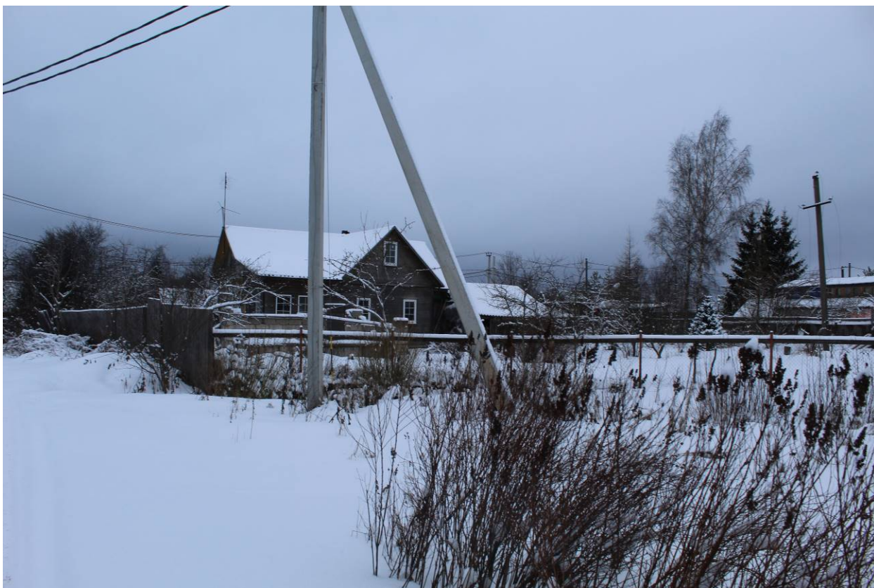
13. «Здание почтовой станции», «Дом для проезжающих» в д. Выра (Гатчинский район, Ленинградская область). Вид на окружающую застройку на юге от «Дома для проезжающих». Вид на северо-запад. Фото Н. М. Петуховой, 12.01.2021.
