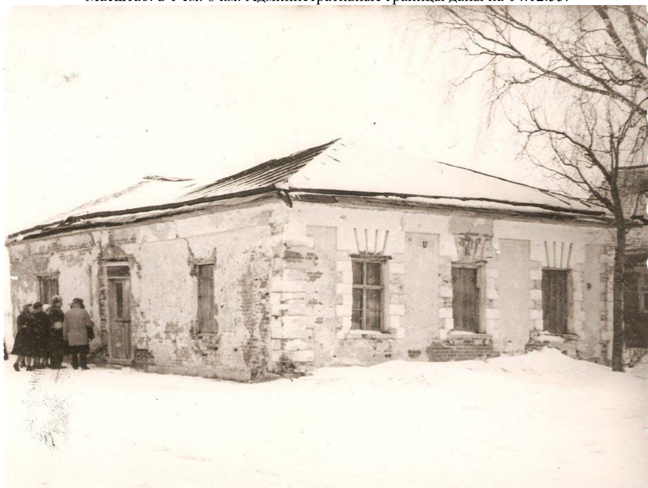
11. Домик станционного смотрителя. 1964. Источник: https://pastvu.com/p/117039
