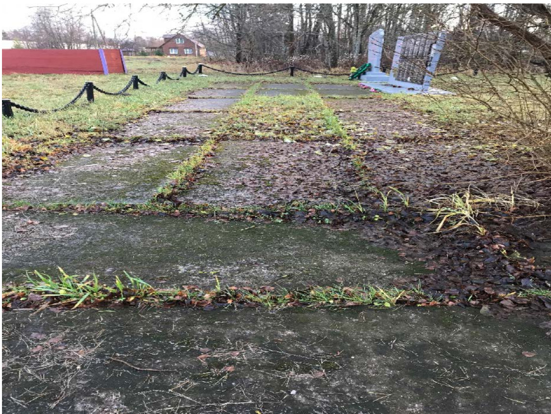
Илл. 12. Мощение площадки
