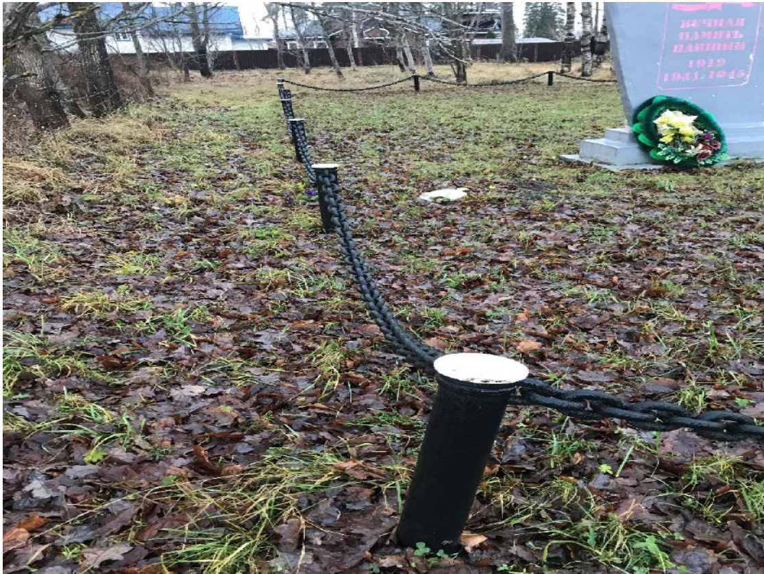
Илл. 11. Металлическое ограждение
