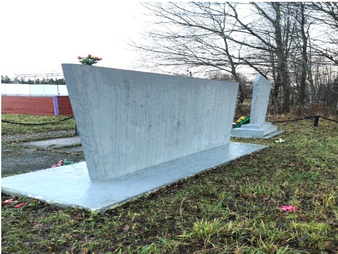
Илл. 10. Бетонная стела с мемориальными гранитными плитами, вид сзади
