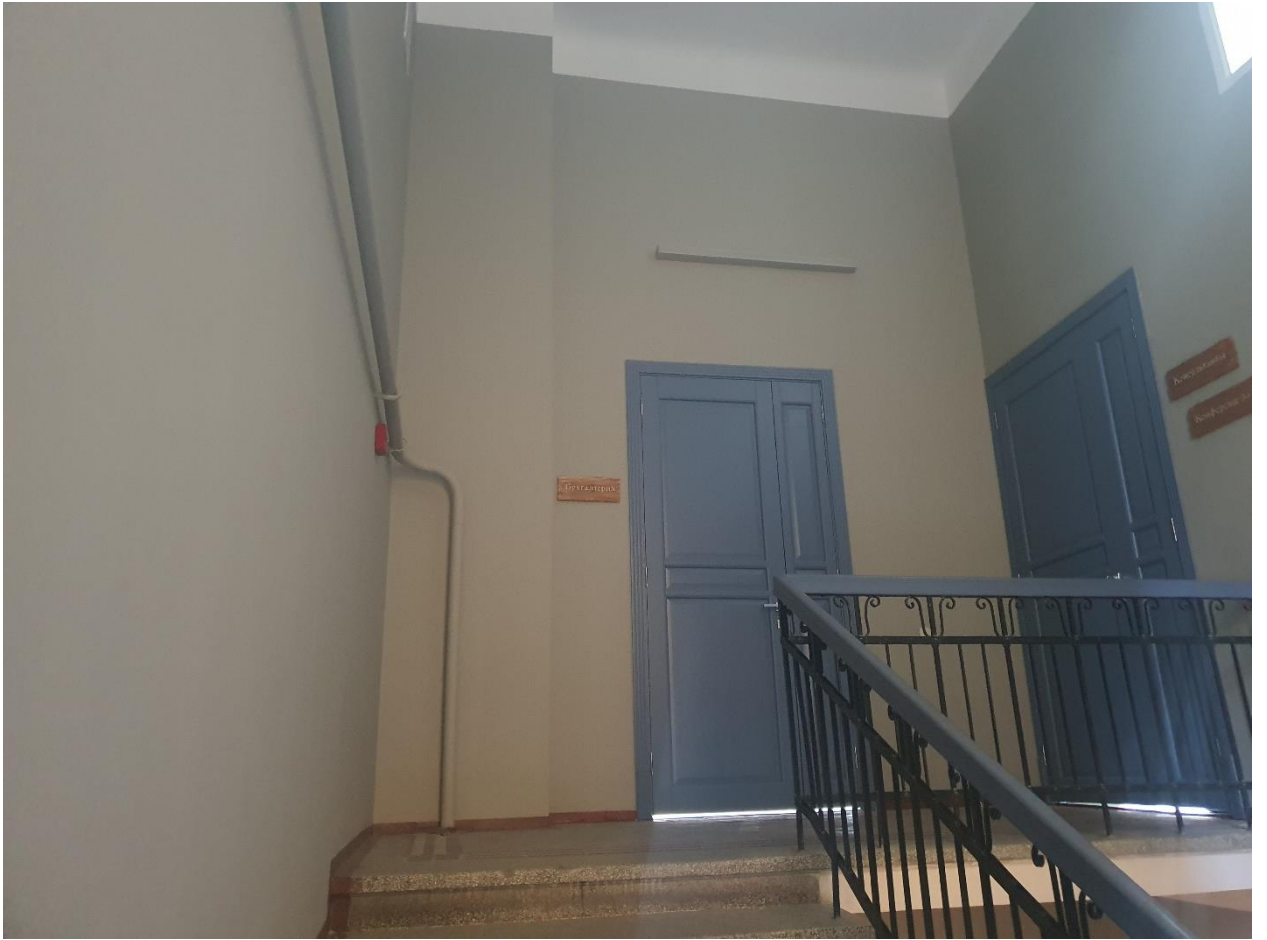
Фото №15. Лестничная клетка
