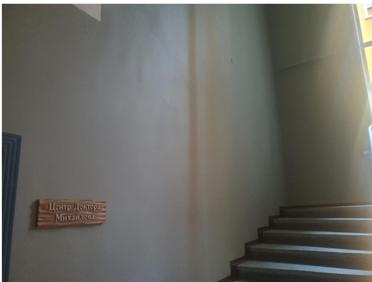
Фото №14. Лестничная клетка
