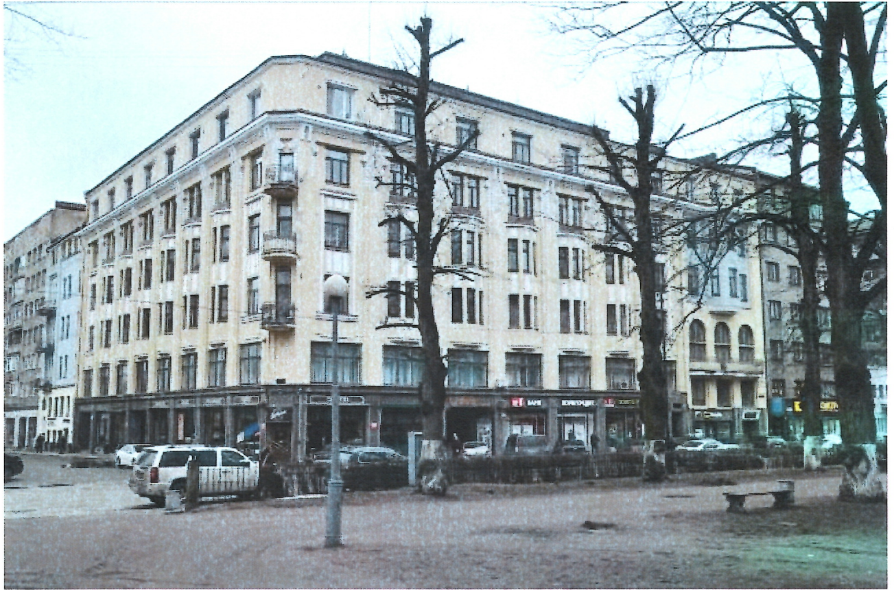
Фото 1. Общий вид. «Жилой дом»
