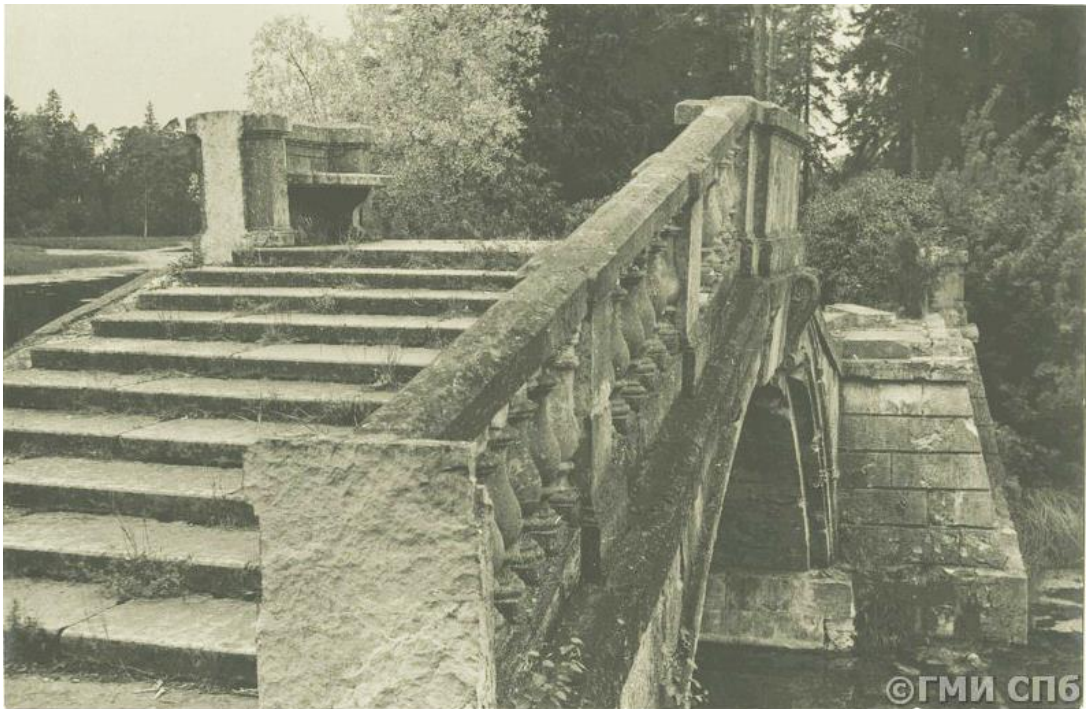
Илл.71. Гатчина. Горбатый мост на Длинном острове. Вид с юго-восточной стороны ГМИ СПб (инв. №-П-Б30035/36ф). Отпечаток с негатива ГИОП (1949 г.)
