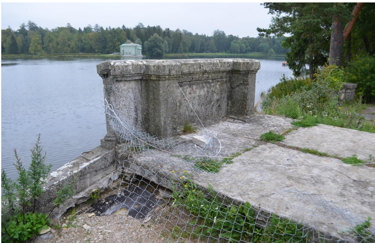
Фото 21. ОКН федерального значения «Горбатый мост (на Длинном острове)», 1793 г. в составе ОКН федерального значения «Ансамбль Гатчинского дворца и парка». Ограждение верхней террасы. Съёмка 25.08.2021 г.
