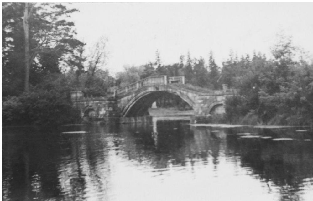
Илл.74. Горбатый мост. Вид с северо-восточной стороны. Фотография ГлавАПУ. 1949 г. Архив КГИОП
