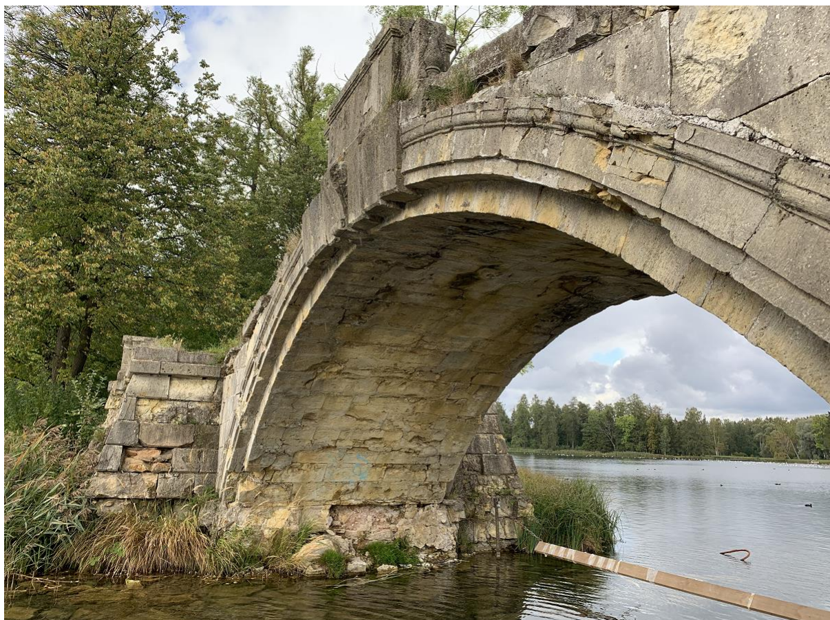
Фото 06. ОКН федерального значения «Горбатый мост (на Длинном острове)», 1793 г. в составе ОКН федерального значения «Ансамбль Гатчинского дворца и парка». Юго-западная сторона моста. Арочный свод пролёта моста. Съёмка 25.08.2021 г.
