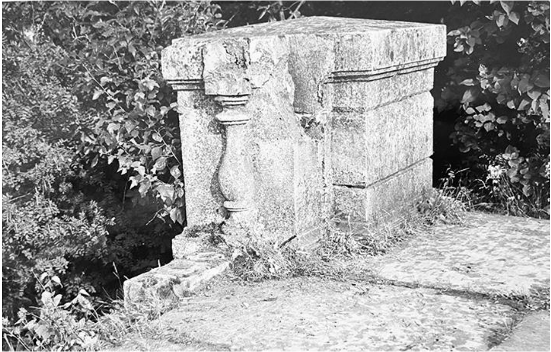
Илл.101. Горбатый мост. Тумба восточного устоя моста. Фотография З.П. Гуриненко. 1962 г. СНРПМ. ГМЗ «Гатчина»
