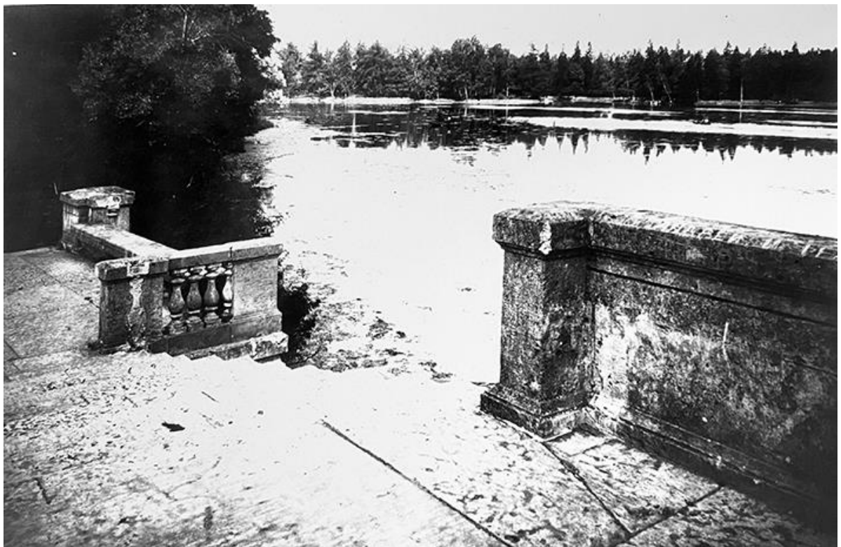
Илл.36. Горбатый мост. Вид на ограждение моста, обращенные к Белому озеру Фотография. 1930-е гг. ГМЗ «Гатчина»
