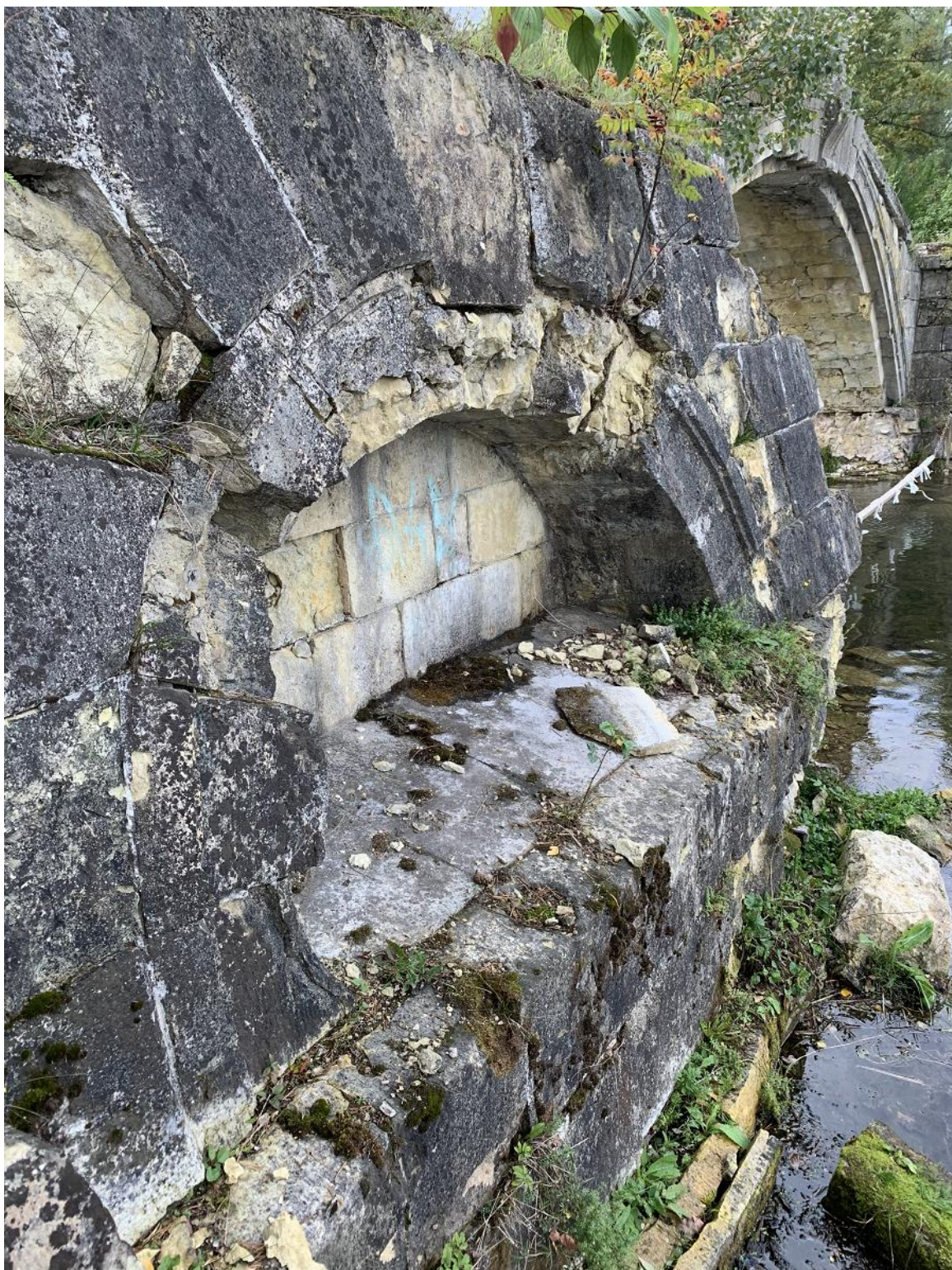
Фото 14. ОКН федерального значения «Горбатый мост (на Длинном острове)», 1793 г. в составе ОКН федерального значения «Ансамбль Гатчинского дворца и парка». Северо-восточная сторона моста. Береговой устой моста. Съёмка 25.08.2021 г.
