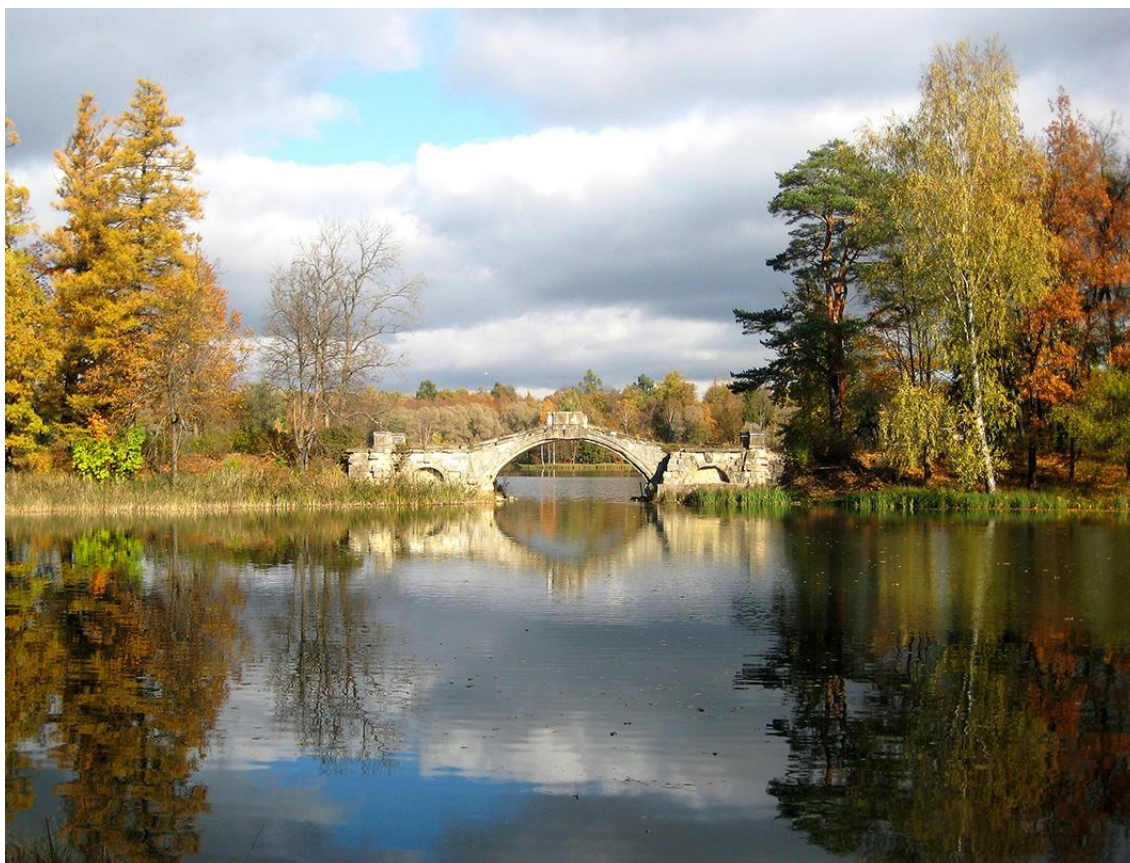
Илл.143 Горбатый мост. Вид с юго-западной стороны. Частный архив. 2014 г.
