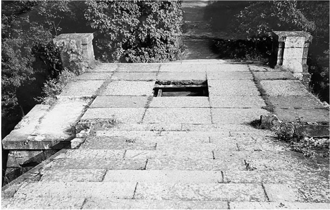
Илл.97. Горбатый мост. Вид с верхней площадки на юго-восток. Фотография З.П. Гуриненко. 1962 г. СНРПМ. ГМЗ «Гатчина»
