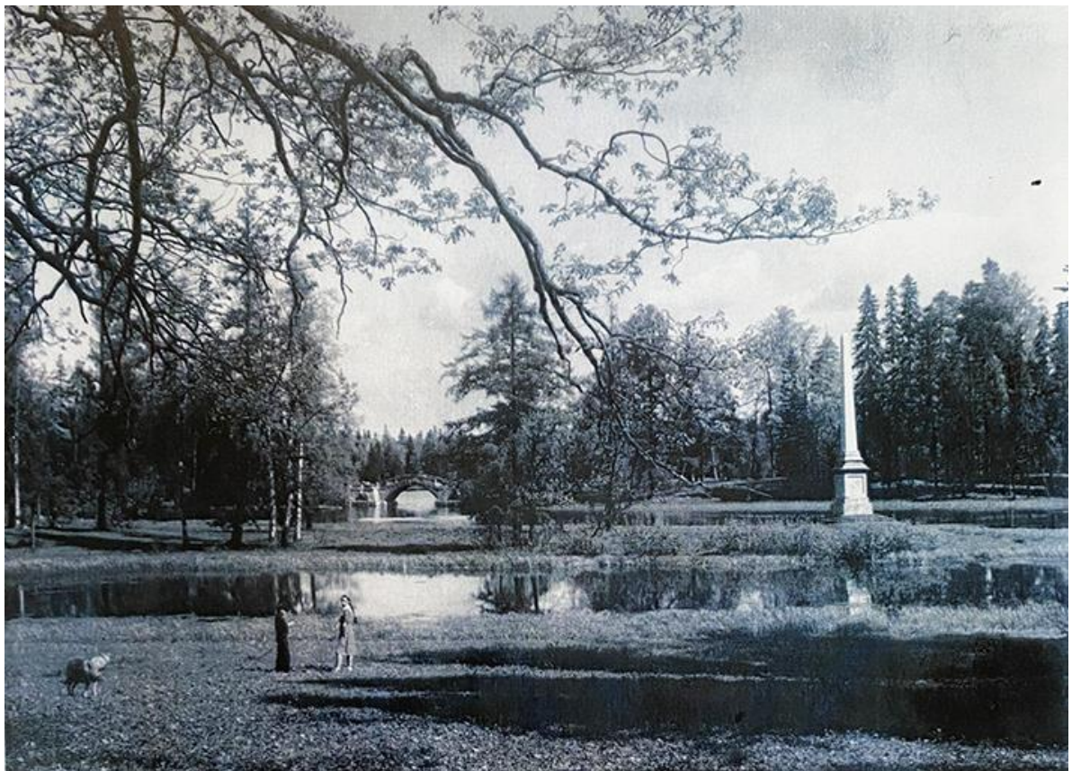
Илл.30. Гатчинский парк. Вид на Чесменский обелиск и Горбатый мост с западной стороны. Фотография. 1930-е гг. ГМЗ «Гатчина»
