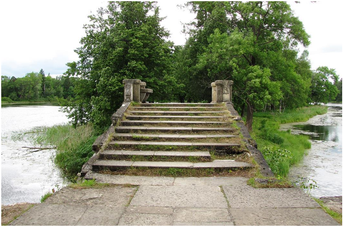
Илл.139 Горбатый мост. Вид с юго-восточной стороны. Фотография Т.Н. Ладыгиной. 2011 г.
