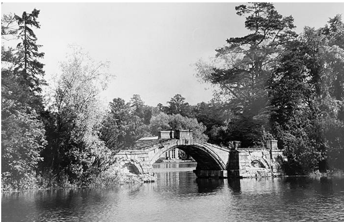
Илл.89. Горбатый мост. Вид с юго-западной стороны. Фотография З.П. Гуриненко. 1962 г. СНРПМ. ГМЗ «Гатчина»
