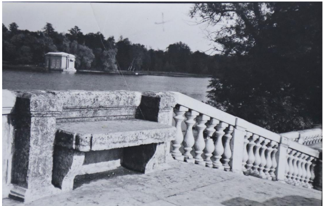
Илл.120. Горбатый мост. Вид с моста в сторону Павильона Венеры с частично отремонтированным ограждением. Фотография Г.С. Приходько. 1984 г. Архив КГИОП
