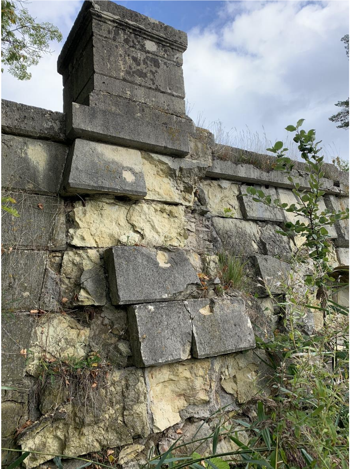
Фото 08. ОКН федерального значения «Горбатый мост (на Длинном острове)», 1793 г. в составе ОКН федерального значения «Ансамбль Гатчинского дворца и парка». Юго-западная сторона моста. Фрагмент. Облицовка берегового устоя моста. Съёмка 25.08.2021 г.
