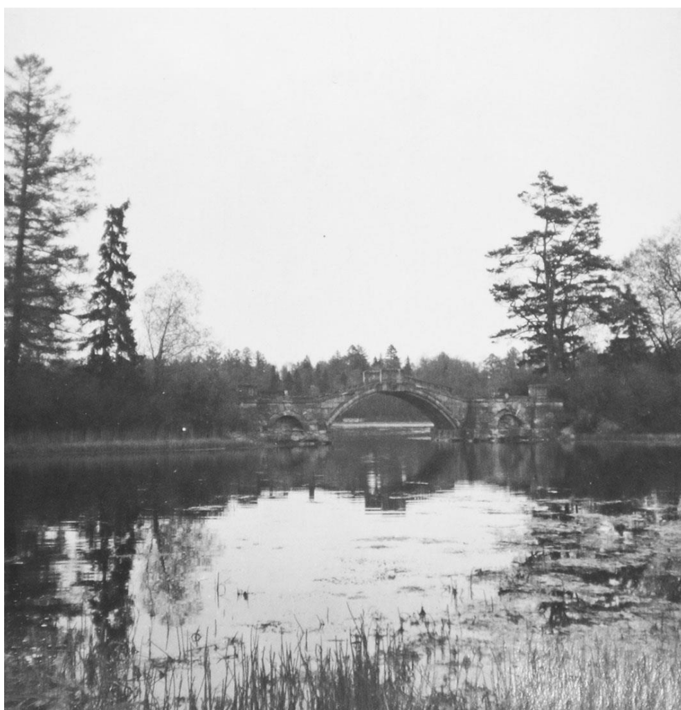
Илл.75. Горбатый мост. Вид с юго-западной стороны. Фотография Г.В. Смирнова. 1950 г.
