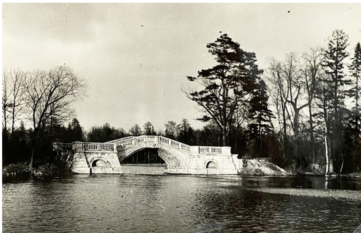
Илл.32. Горбатый мост. Вид с северо-восточной стороны от Белого озера Фотография. 1930-е гг. ГМЗ «Гатчина»
