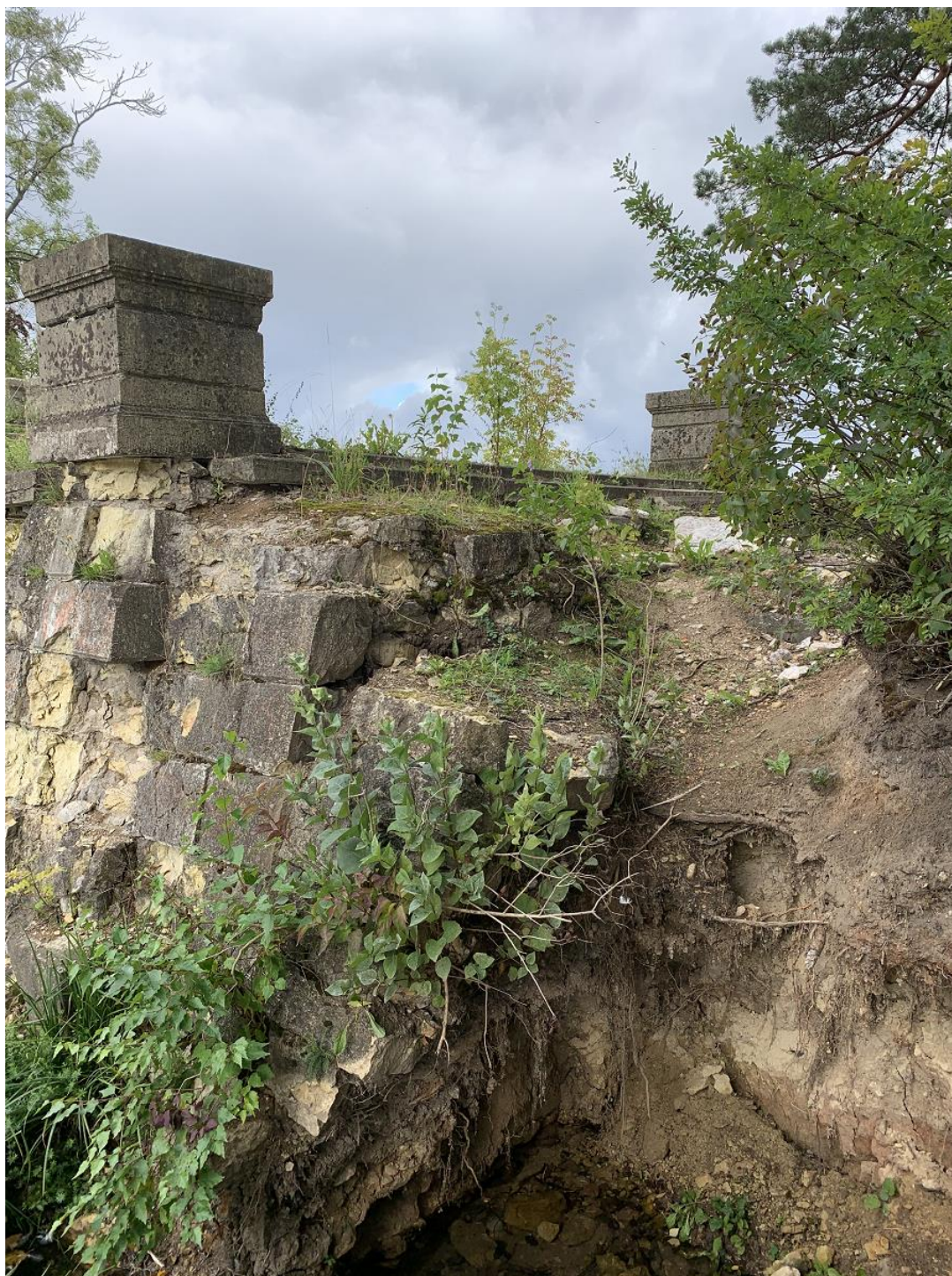
Фото 05. ОКН федерального значения «Горбатый мост (на Длинном острове)», 1793 г. в составе ОКН федерального значения «Ансамбль Гатчинского дворца и парка». Южная нижняя терраса берегового устоя. Съёмка 25.08.2021 г.
