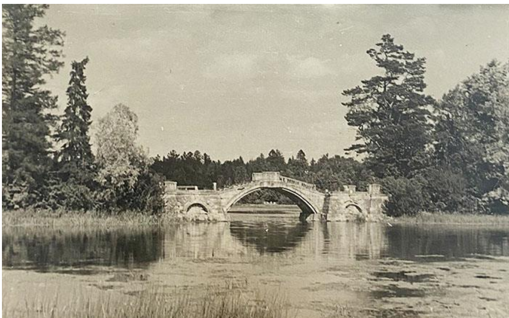
Илл.73. Горбатый мост. Вид с юго-западной стороны. Фотография. 1949 г. ГМЗ «Гатчина» (инв. № А-81)
