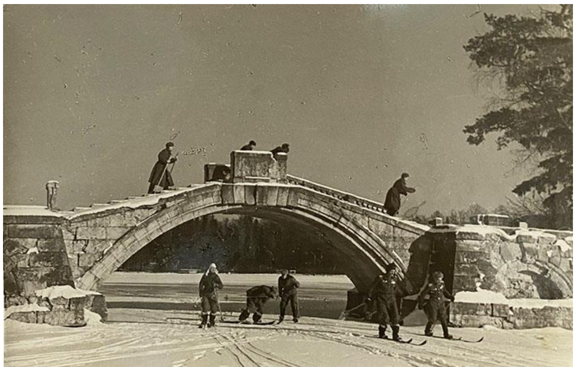
Илл.51. Гатчинский парк. Участники лыжного пробега на фоне Горбатого моста. Вид с южной стороны. Фотография И.Я. Наровлянского. 1947 г. ГМЗ «Гатчина»
