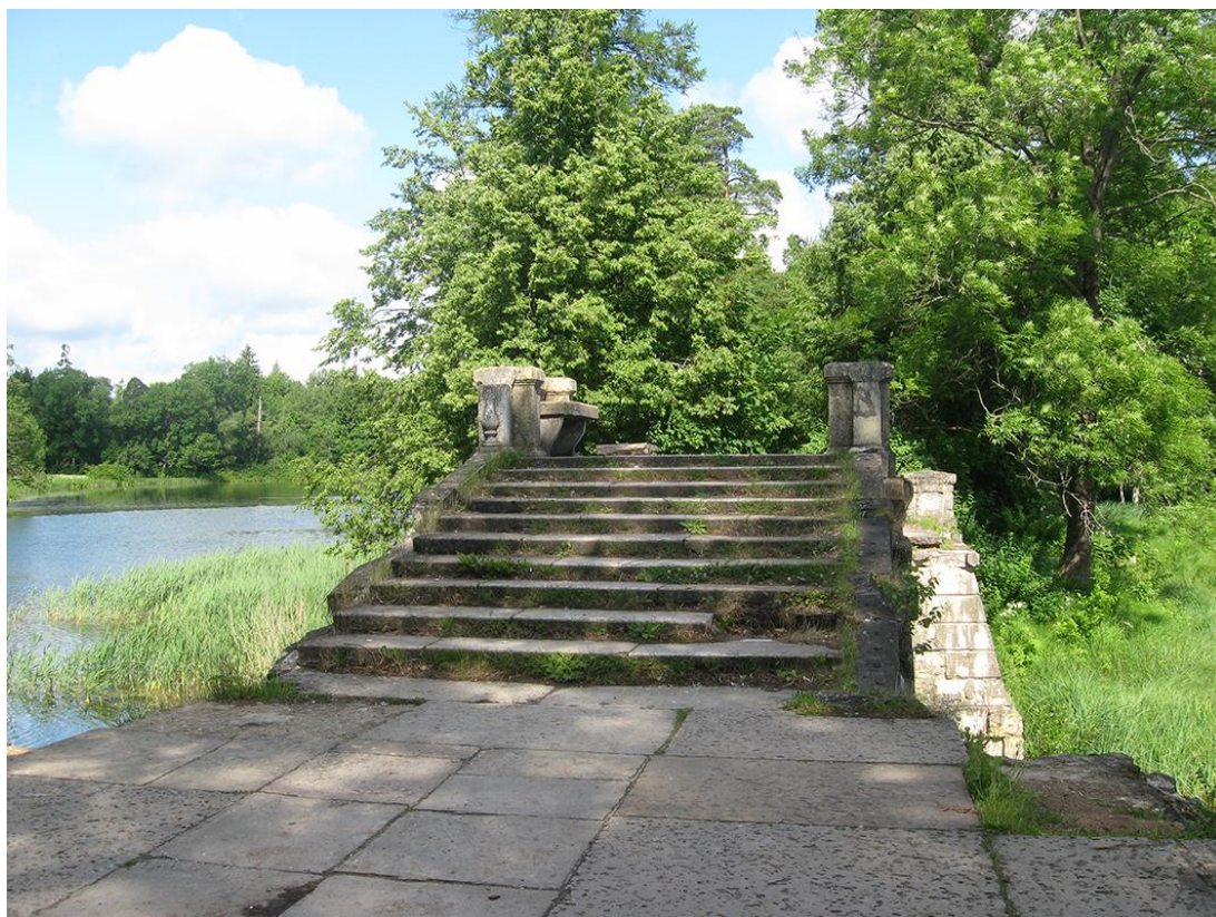
Илл.135. Горбатый мост. Вид с юго-восточной стороны. Фотография Т.Н. Ладыгиной. 2011 г.
