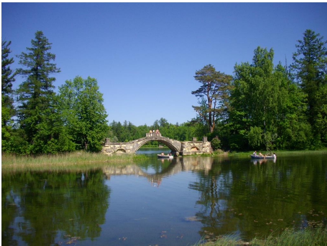
Илл.131. Горбатый мост. Вид с западной стороны. Фотография Т.Н. Ладыгиной. 2009 г.
