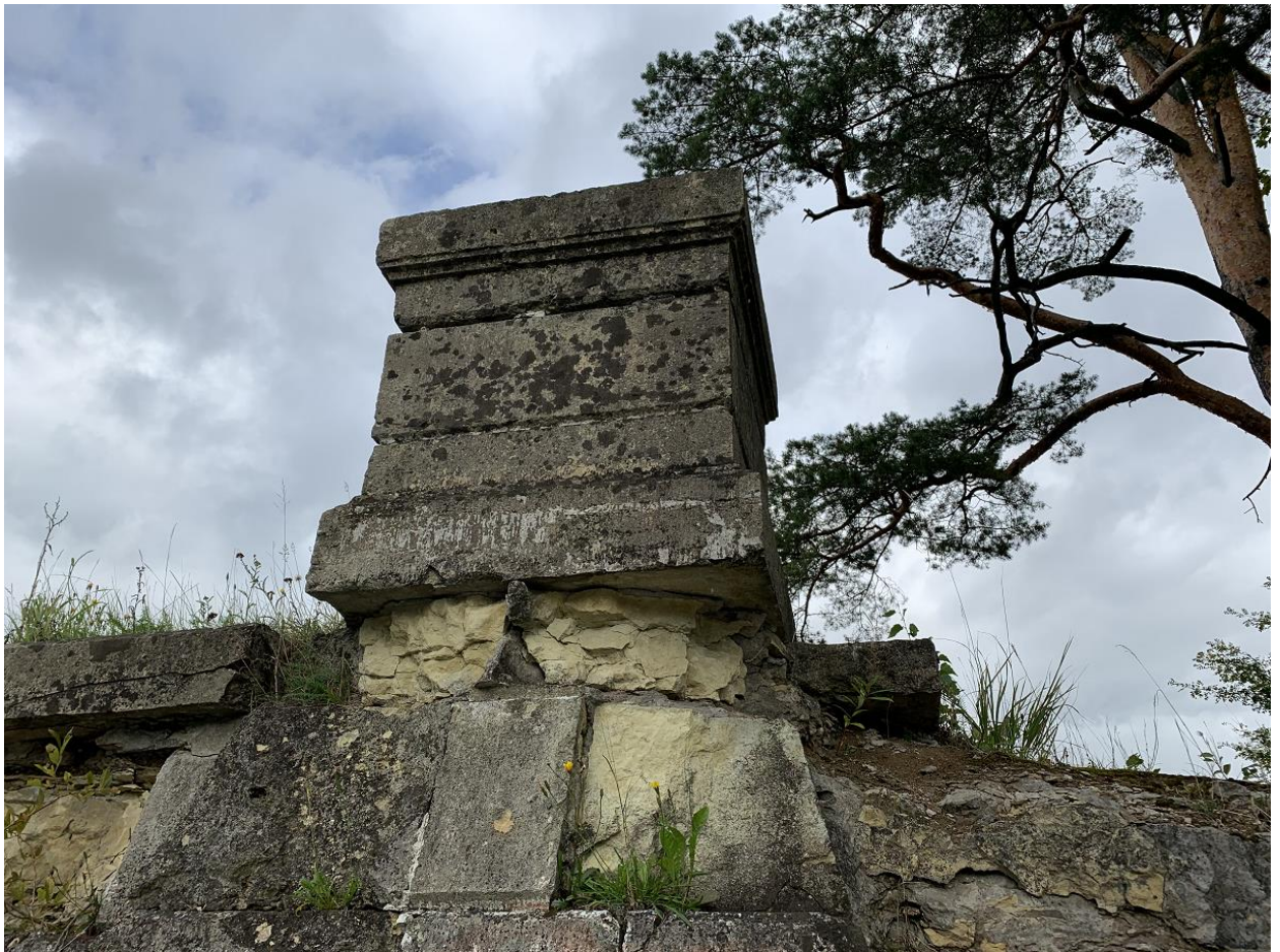
Фото 04. ОКН федерального значения «Горбатый мост (на Длинном острове)», 1793 г. в составе ОКН федерального значения «Ансамбль Гатчинского дворца и парка». Юго-западная сторона моста. Фрагмент. Тумба ограждения на нижней террасе берегового устоя. Съёмка 25.08.2021 г.
