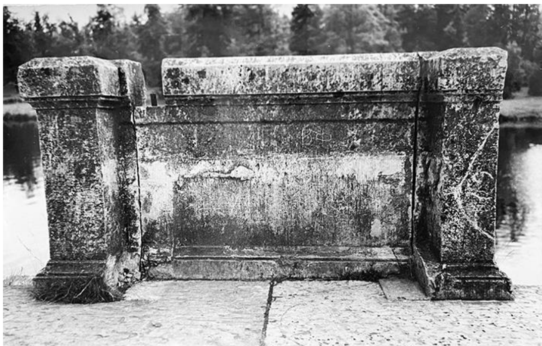
Илл.100. Горбатый мост. Верхняя тумба ограждения, обращенного к Серебряному пруду Фотография З.П. Гуриненко. 1962 г. СНРПМ. ГМЗ «Гатчина»
