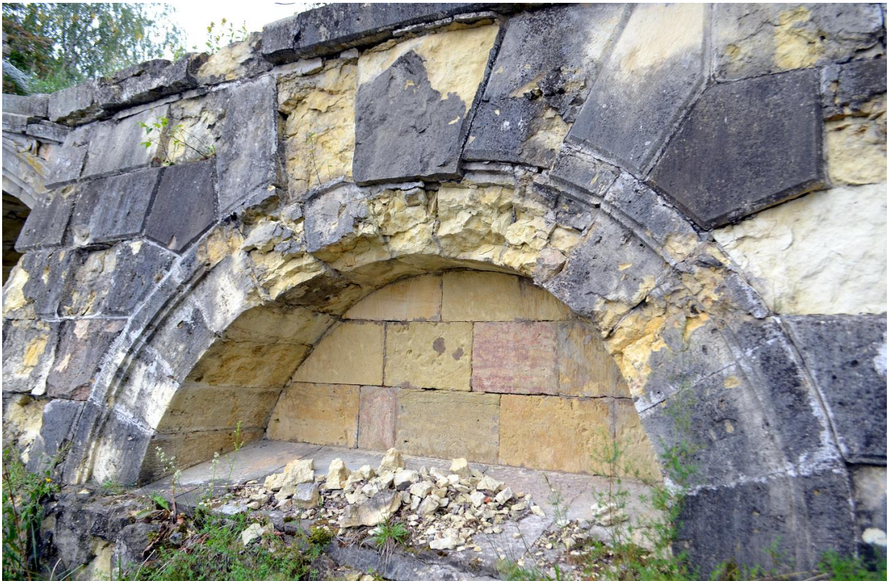
Фото 17. ОКН федерального значения «Горбатый мост (на Длинном острове)», 1793 г. в составе ОКН федерального значения «Ансамбль Гатчинского дворца и парка». Северо-восточная сторона моста. Береговой устой моста. Съёмка 25.08.2021 г.
