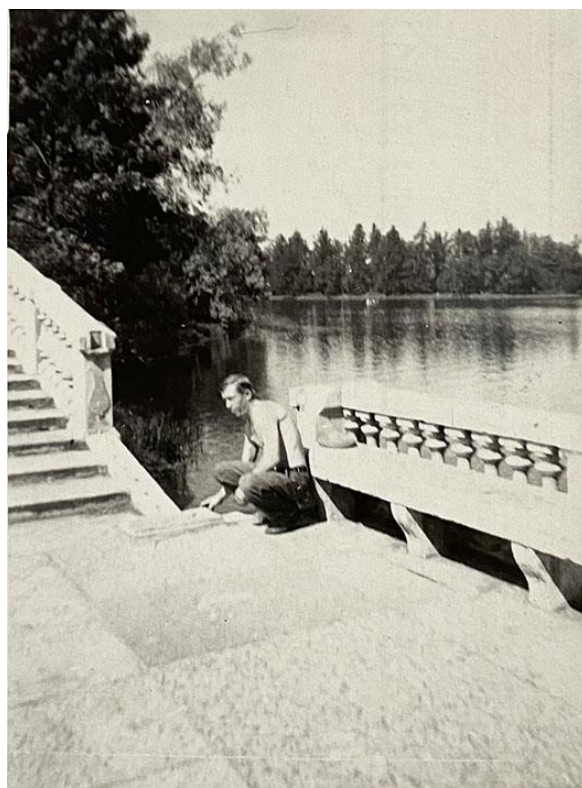
Илл.78. Горбатый мост. Состояние балюстрады ограждения моста. Фотография.1950-е гг. ГМЗ «Гатчина»
