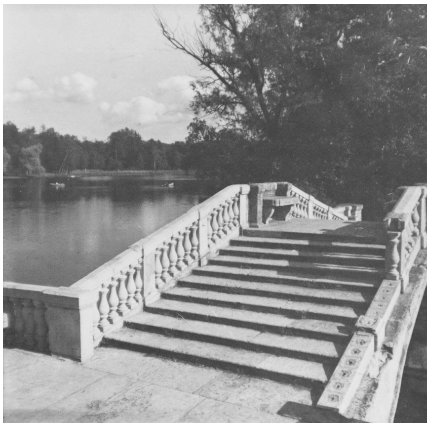
Илл.115. Горбатый мост. Вид с севера-западной стороны. Г.С. Приходько. 1982 г. Архив КГИОП
