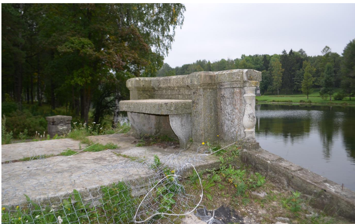
Фото 22. ОКН федерального значения «Горбатый мост (на Длинном острове)», 1793 г. в составе ОКН федерального значения «Ансамбль Гатчинского дворца и парка». Ограждение верхней террасы. Съёмка 25.08.2021 г.
