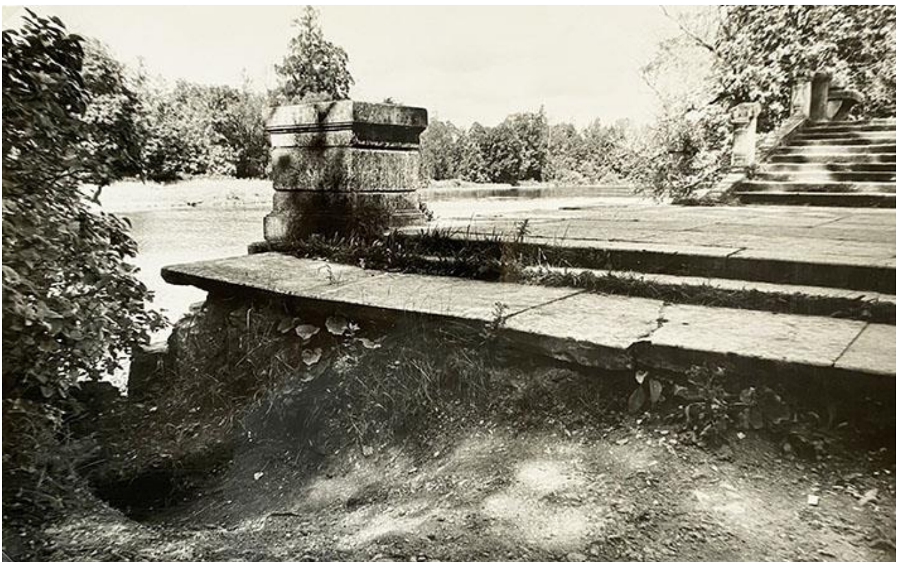
Илл.124. Горбатый мост. Состояние ограждения моста, обращенного к Серебряному пруду. Фотография. 1998 г. ГМЗ «Гатчина»
