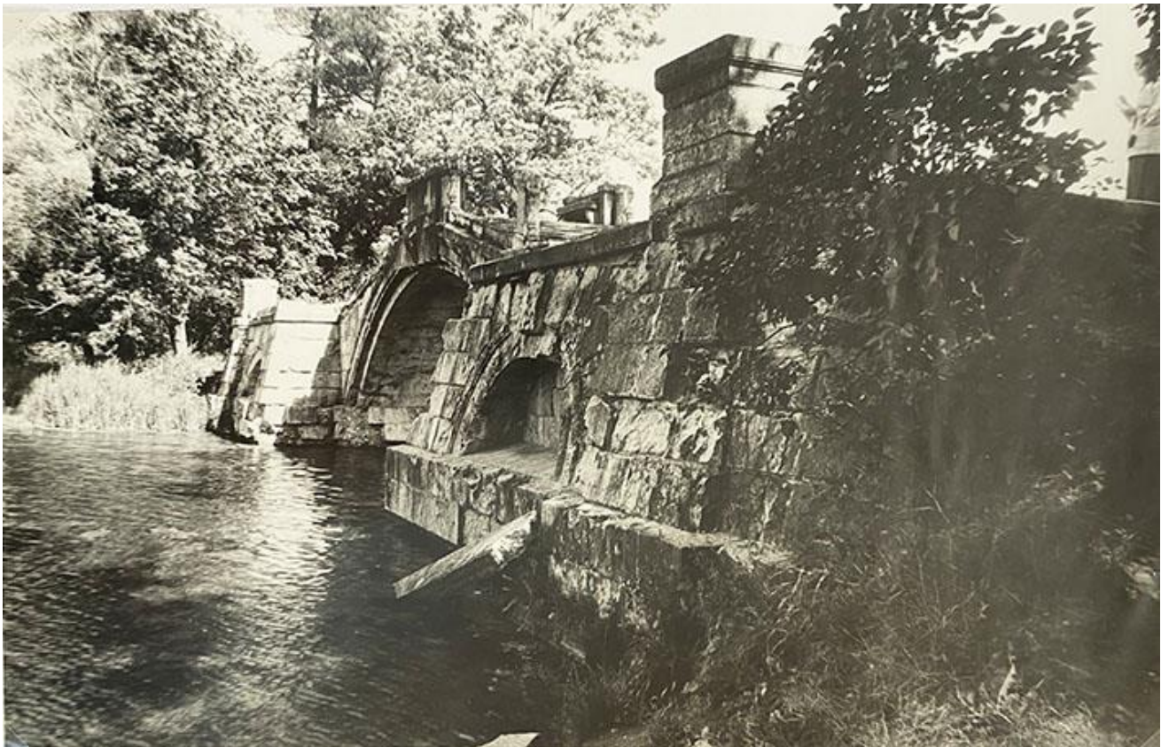
Илл.123. Горбатый мост. Состояние фасада моста, обращенного к Серебряному пруду. Фотография. 1998 г. ГМЗ «Гатчина»
