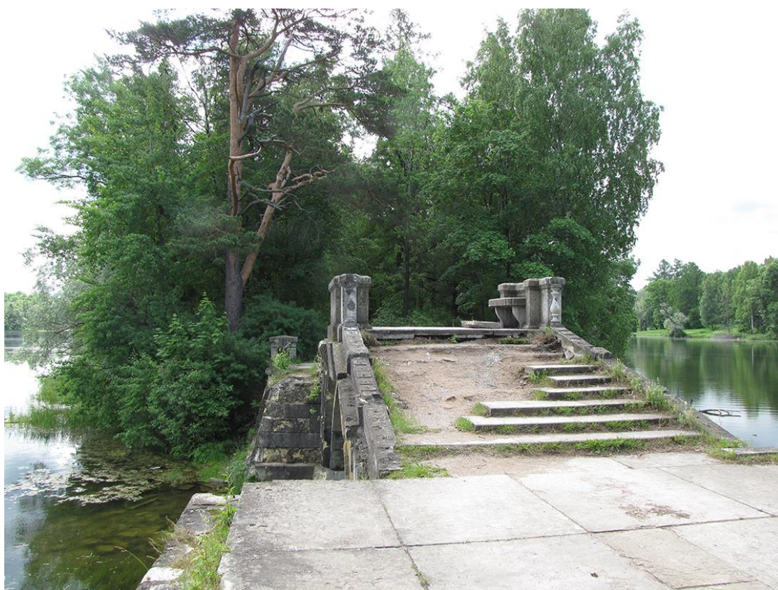
Илл.136 Горбатый мост. Вид с северо-западной стороны. Фотография Т.Н. Ладыгиной.2011 г.
