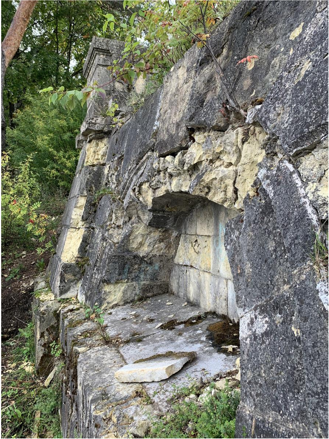
Фото 15. ОКН федерального значения «Горбатый мост (на Длинном острове)», 1793 г. в составе ОКН федерального значения «Ансамбль Гатчинского дворца и парка». Северо-восточная сторона моста. Береговой устой моста. Съёмка 25.08.2021 г.
