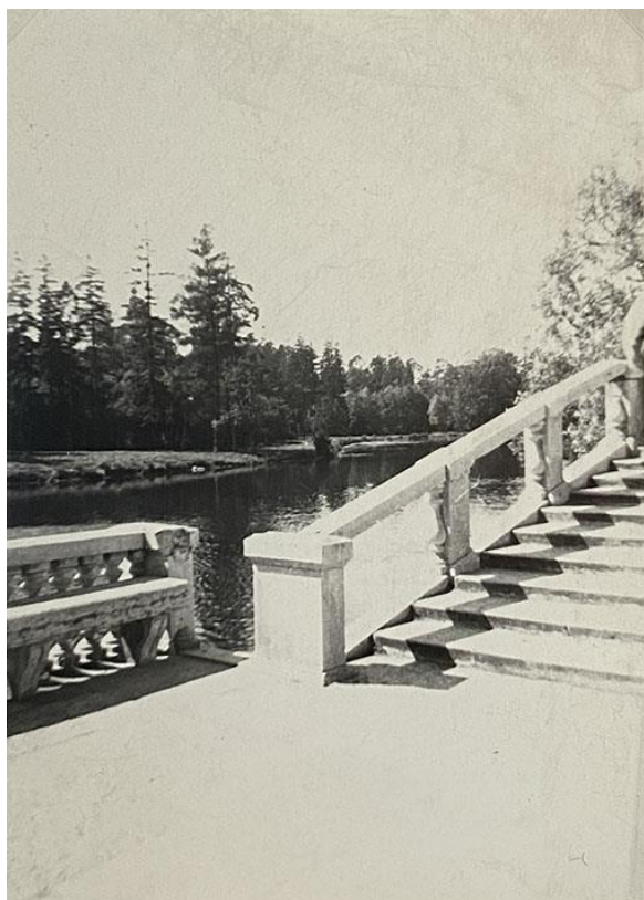
Илл.77. Горбатый мост. Состояние балюстрады ограждения моста. Фотография.1950-е гг. ГМЗ «Гатчина»
