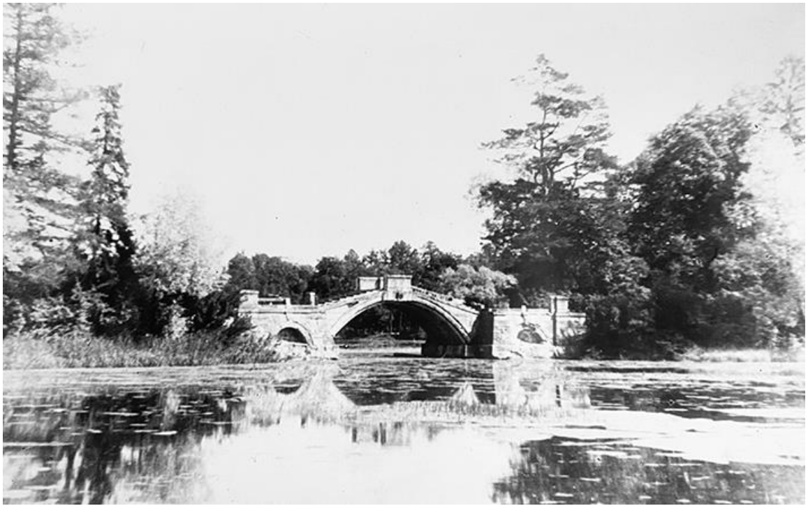
Илл.66. Горбатый мост. Вид с юго-западной стороны. Фотография. Кон. 1940-х гг. ГМЗ «Гатчина».
