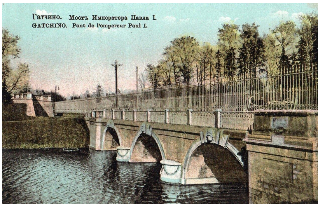
Илл.11 Открытое письмо «Гатчино. Мост Императора Павла I» (Карпичный (Львиный) мост) 1900-е гг.
