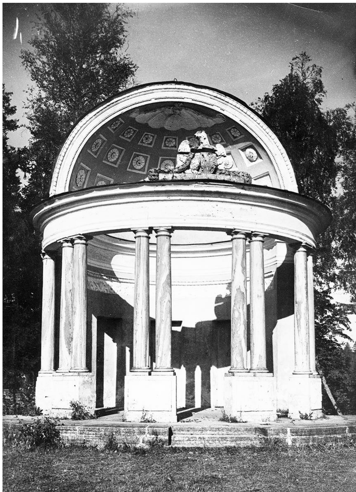
Илл. 46 Павильон Орла. Общий вид с западной стороны. НА КГИОП (инв. № 18649)
