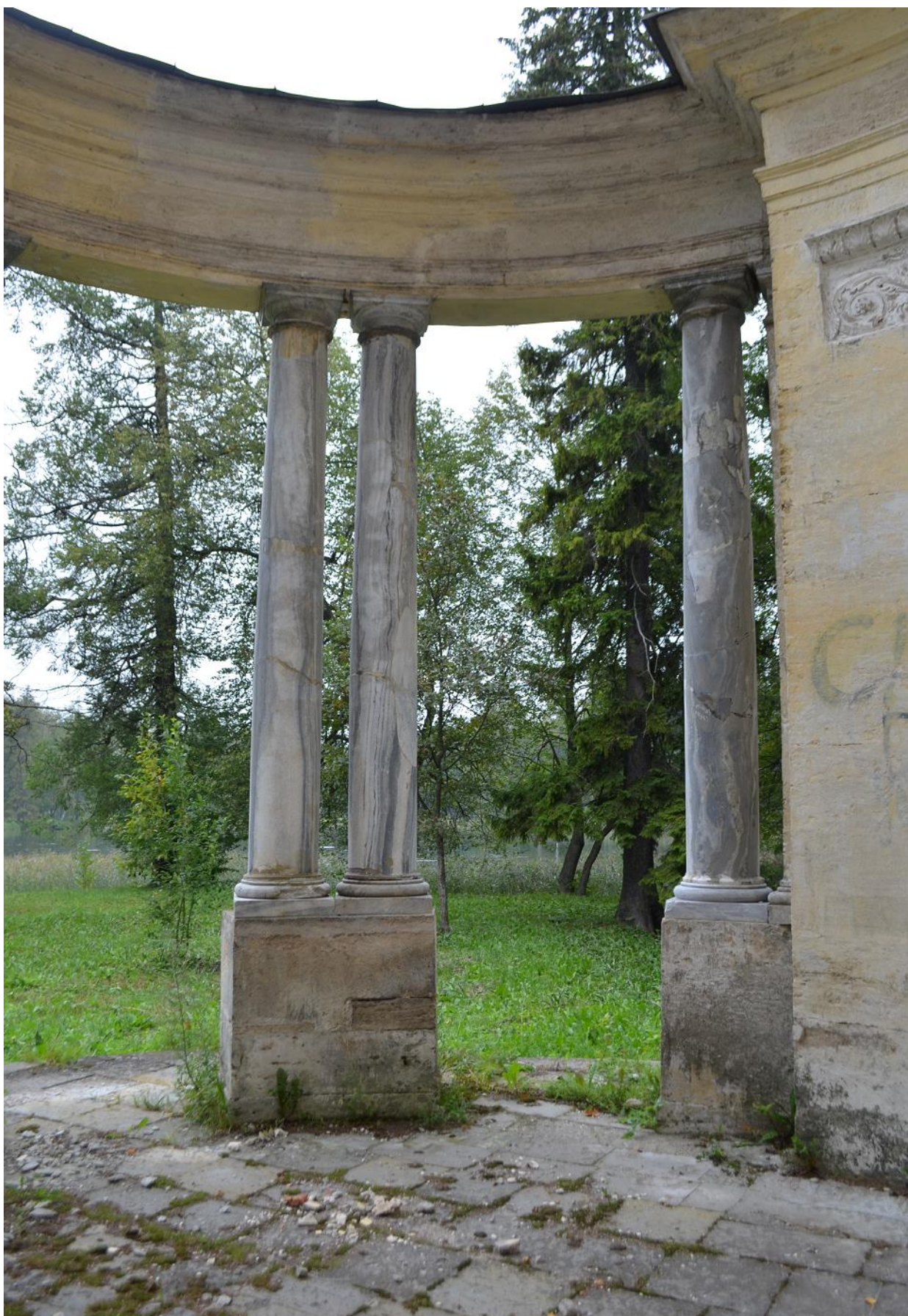
Фото 20. ОКН федерального значения «Павильон «Орла», 1790-е гг. в составе ОКН федерального значения «Ансамбль Гатчинского дворца и парка». Колонны по северо-западной четверти. Фрагмент. Съёмка 23.08.2021г.
