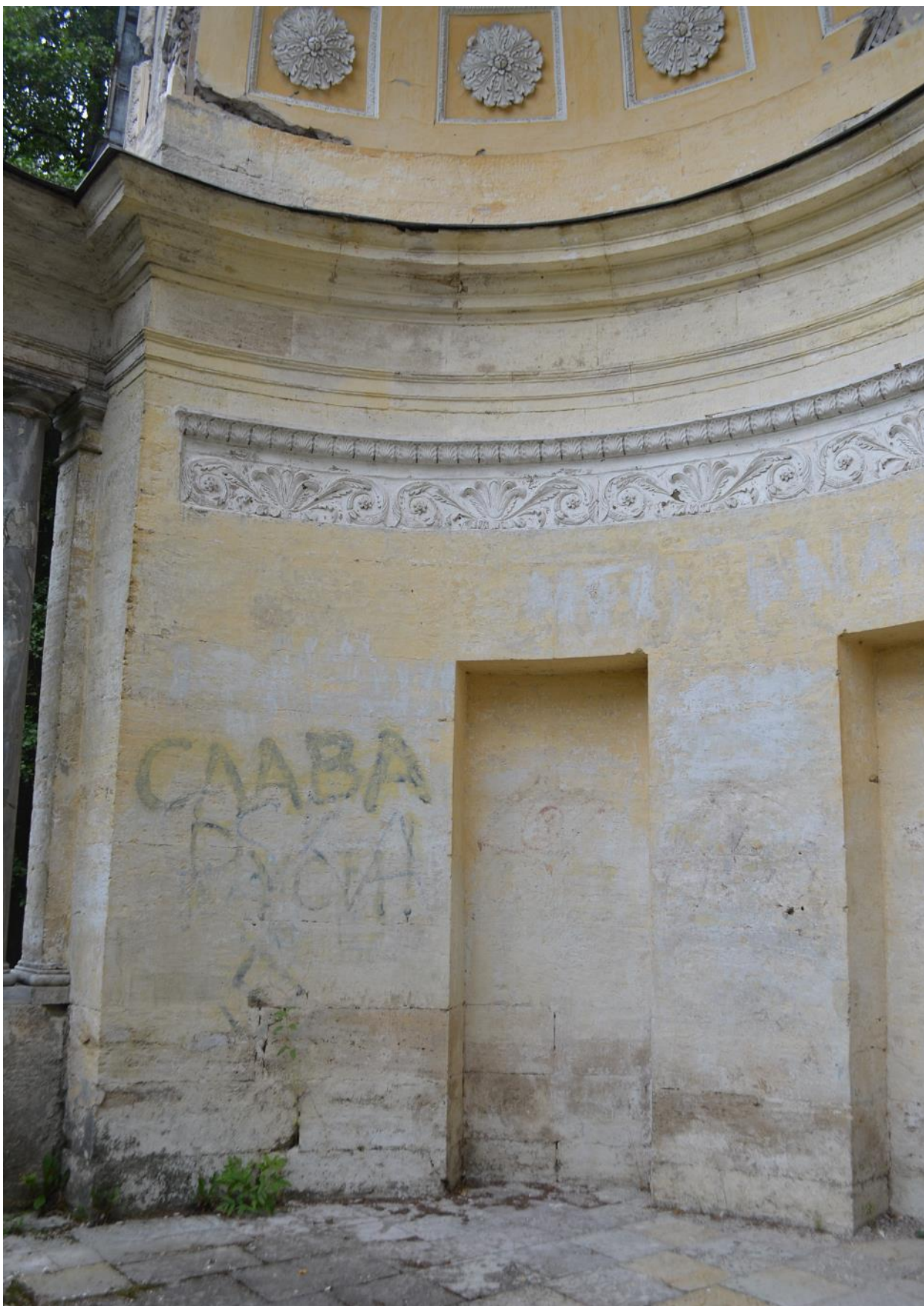
Фото 27. ОКН федерального значения «Павильон «Орла», 1790-е гг. в составе ОКН федерального значения «Ансамбль Гатчинского дворца и парка». Стена павильона и лепной фриз, вид с юго-запада. Фрагмент. Съёмка 23.08.2021г.
