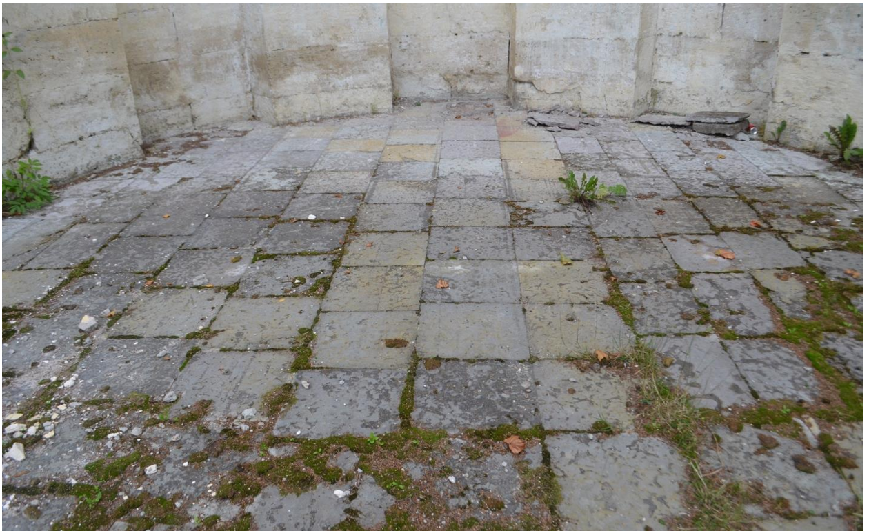
Фото 24. ОКН федерального значения «Павильон «Орла», 1790-е гг. в составе ОКН федерального значения «Ансамбль Гатчинского дворца и парка». Площадка, вид с запада. Фрагмент. Съёмка 23.08.2021г.
