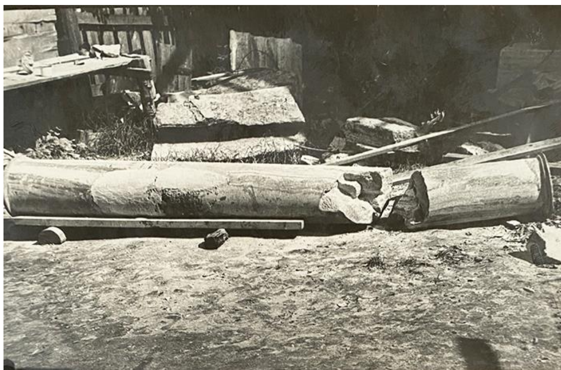
Илл. 103 Павильон Орла в процессе реставрационных работ. Фотография. 1972 г. СНРПМ. ГМЗ «Гатчина»
