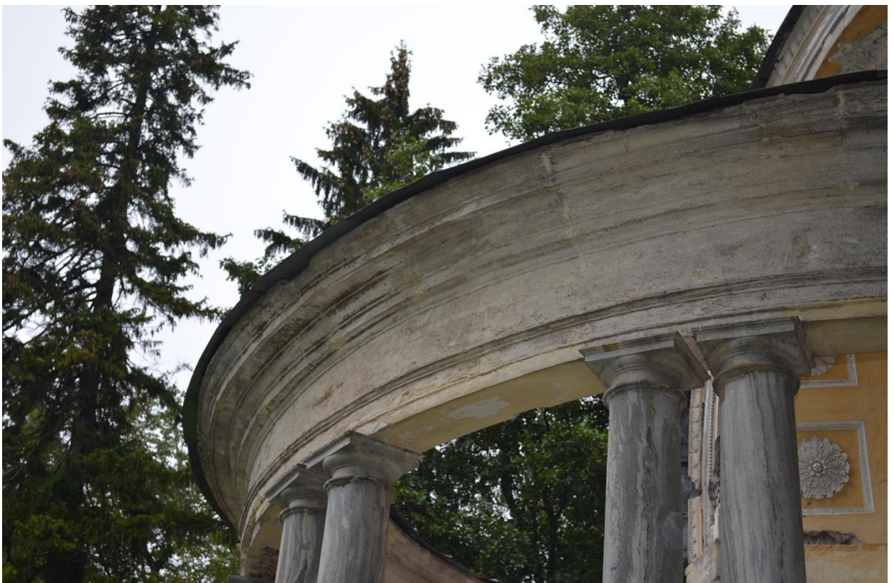
Фото 07. ОКН федерального значения «Павильон «Орла», 1790-е гг. в составе ОКН федерального значения «Ансамбль Гатчинского дворца и парка». Антаблемент, вид с юга. Фрагмент. Съёмка 23.08.2021г.
