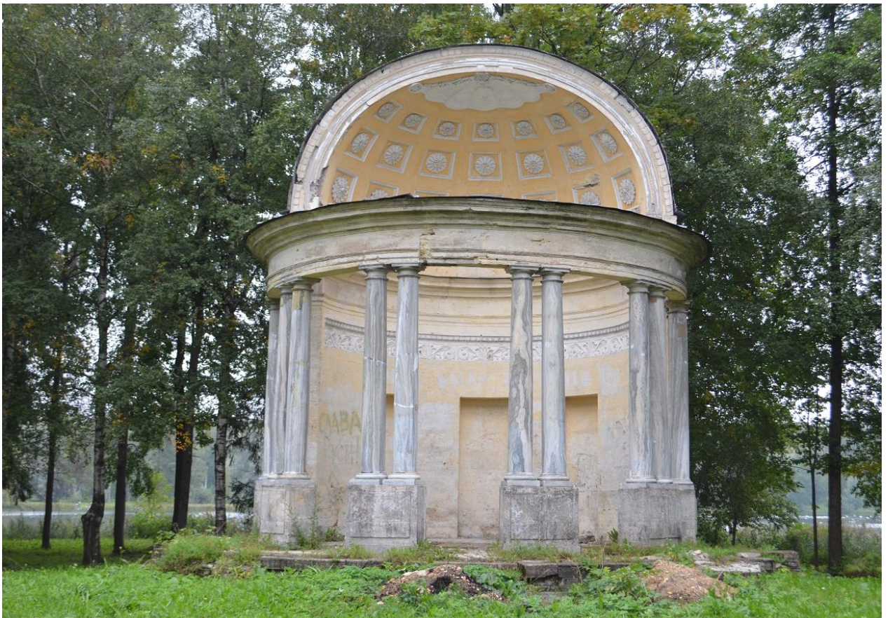
Фото 02. ОКН федерального значения «Павильон «Орла», 1790-е гг. в составе ОКН федерального значения «Ансамбль Гатчинского дворца и парка». Вид с юго-запада. Съёмка 23.08.2021г.
