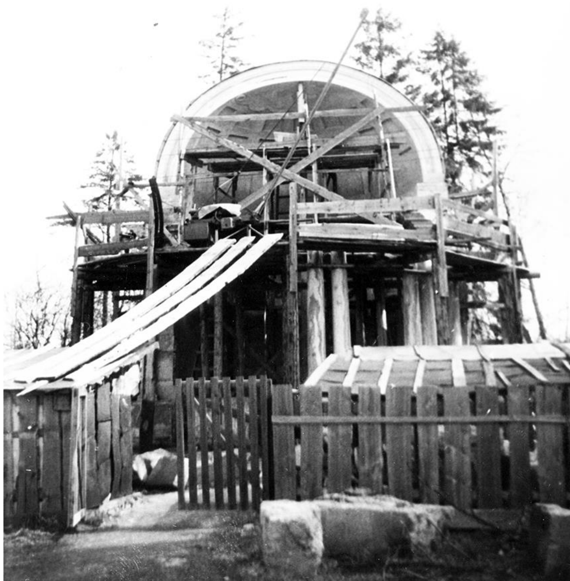
Илл.93 Павильон Орла в процессе реставрационных работ. Фотография (приобретена у Наумовой в 1995 г.). 1971 г. НА КГИОП
