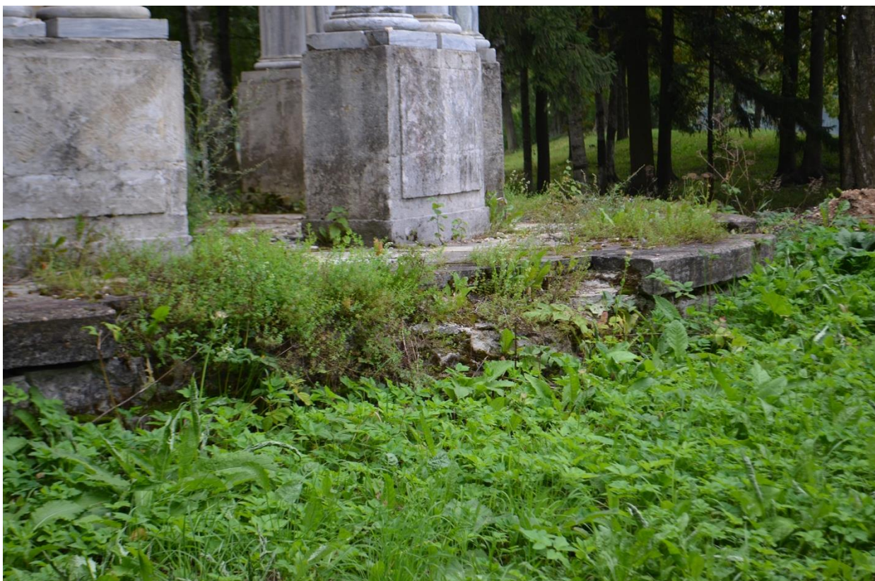
Фото 16. ОКН федерального значения «Павильон «Орла», 1790-е гг. в составе ОКН федерального значения «Ансамбль Гатчинского дворца и парка». Каменная площадка и базы колонн, вид с севера. Фрагмент. Съёмка 23.08.2021г.
