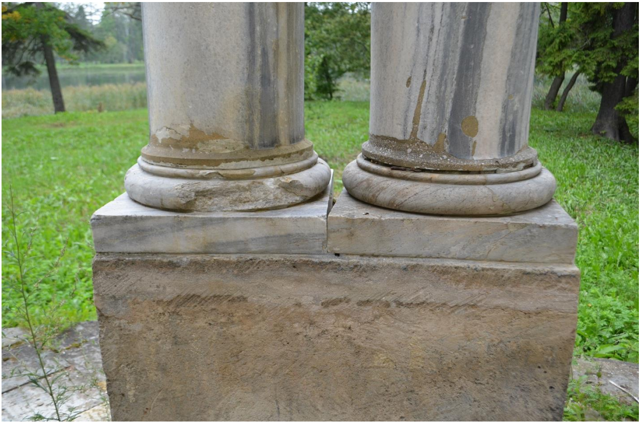
Фото 21. ОКН федерального значения «Павильон «Орла», 1790-е гг. в составе ОКН федерального значения «Ансамбль Гатчинского дворца и парка». Базы и постаменты колонн, вид с юго-востока. Фрагмент. Съёмка 23.08.2021г.
