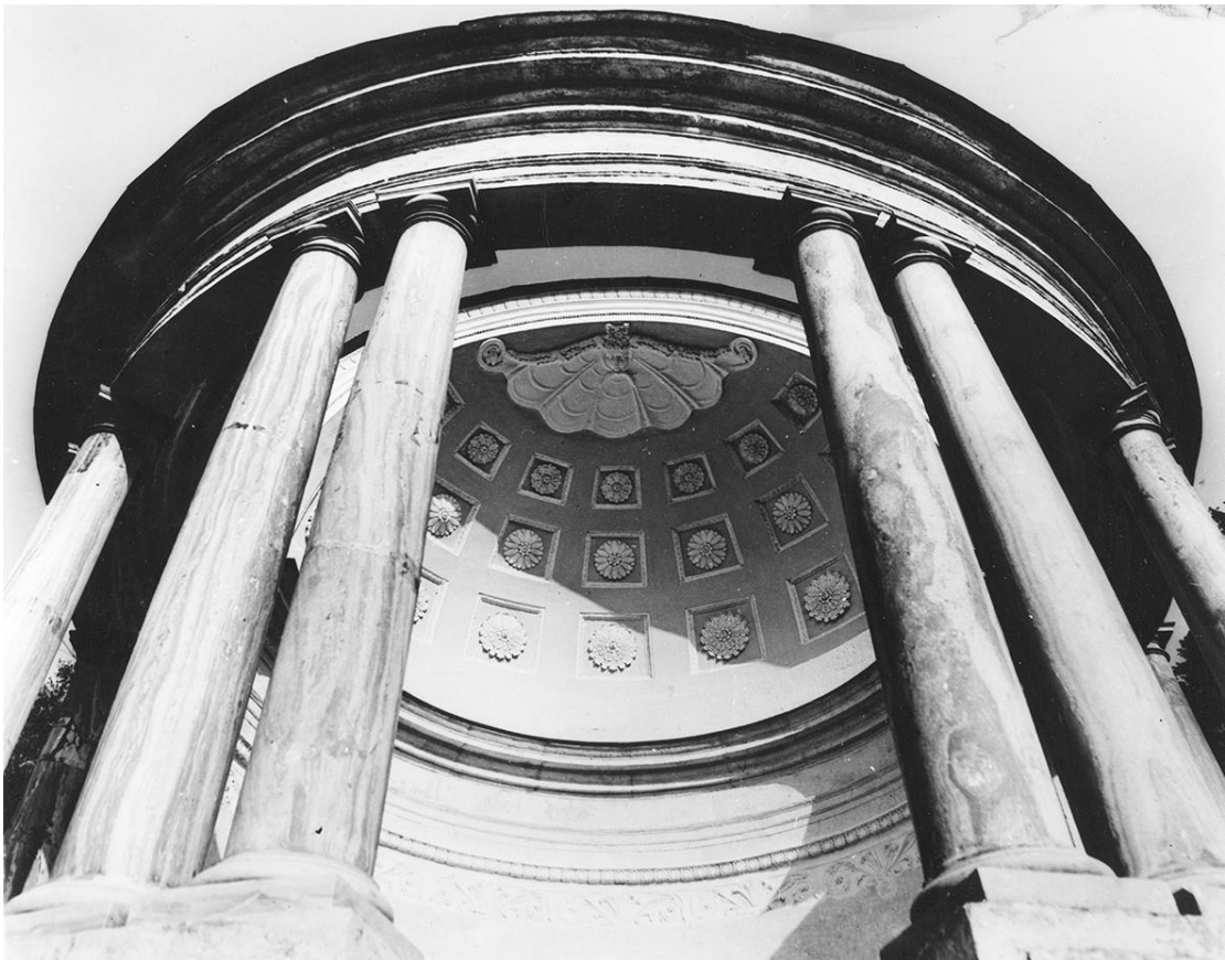
Илл.110 Павильон Орла. Состояние колонн, антаблемента и полукупола. Фотография Г.С. Приходько. 1983 г. НА КГИОП (инв. №129246)
