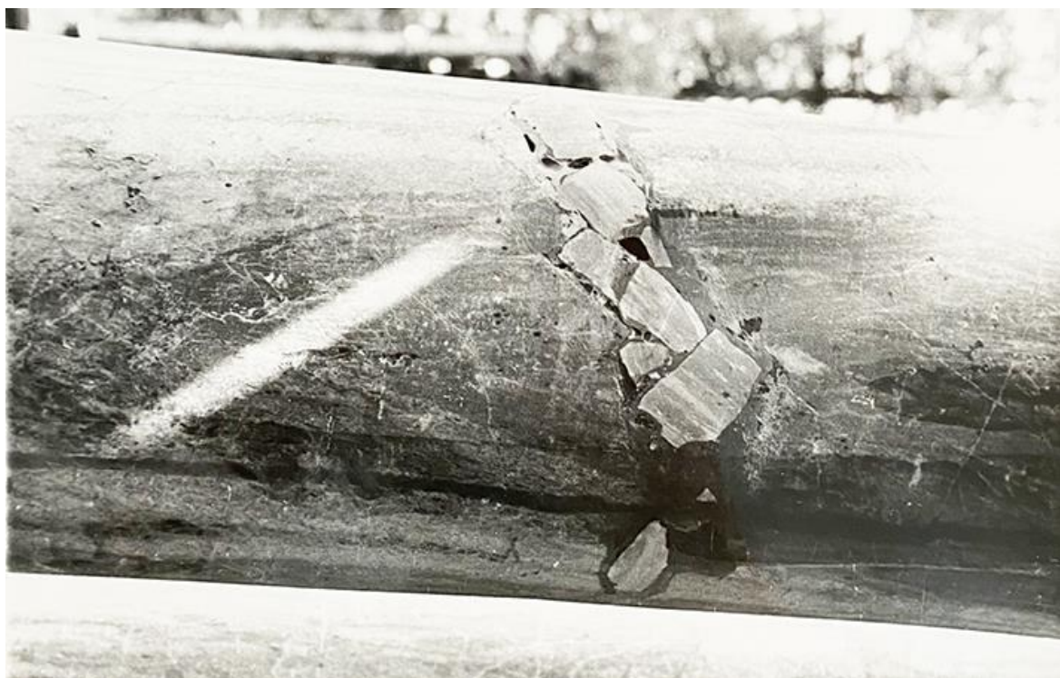
Илл. 101 Павильон Орла в процессе реставрационных работ. Фотография. 1972 г. СНРПИМ. ГМЗ «Гатчина»
