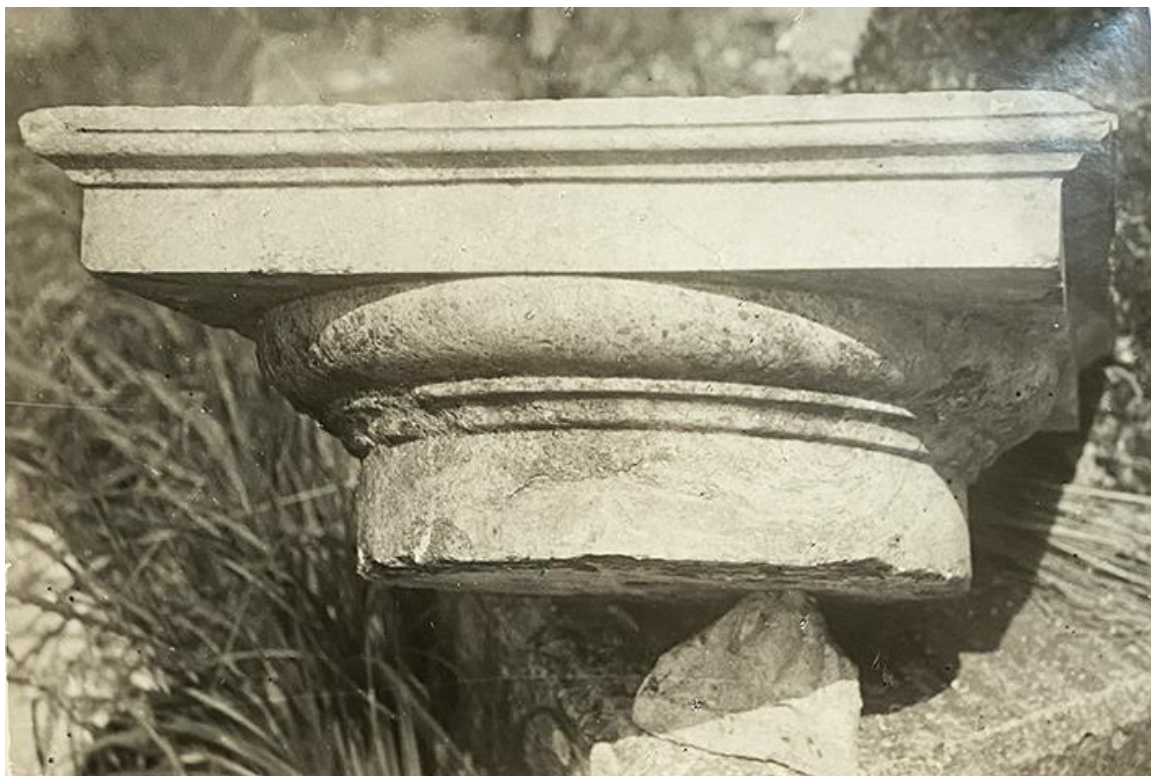
Илл.72 Павильон Орла. Капитель разрушенной мраморной колонны. Фотография. ЛЕНФОТО. 1950 г. ГМЗ «Гатчина»
