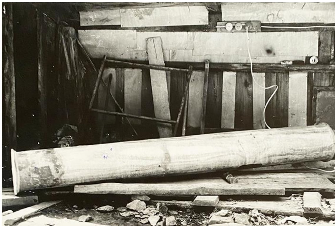
Илл. 102 Павильон Орла в процессе реставрационных работ. Фотография. 1972 г. СНРПМ. ГМЗ «Гатчина»
