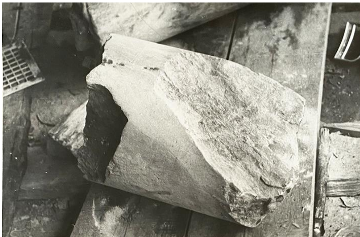
Илл. 99 Павильон Орла в процессе реставрационных работ. Фотография. 1972 г. СНРПМ. ГМЗ «Гатчина»
