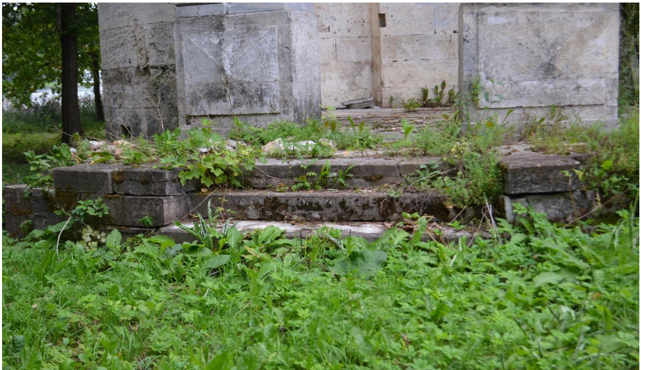
Фото 15. ОКН федерального значения «Павильон «Орла», 1790-е гг. в составе ОКН федерального значения «Ансамбль Гатчинского дворца и парка». Каменная площадка и лестница, вид с северо-запада. Фрагмент. Съёмка 23.08.2021г.
