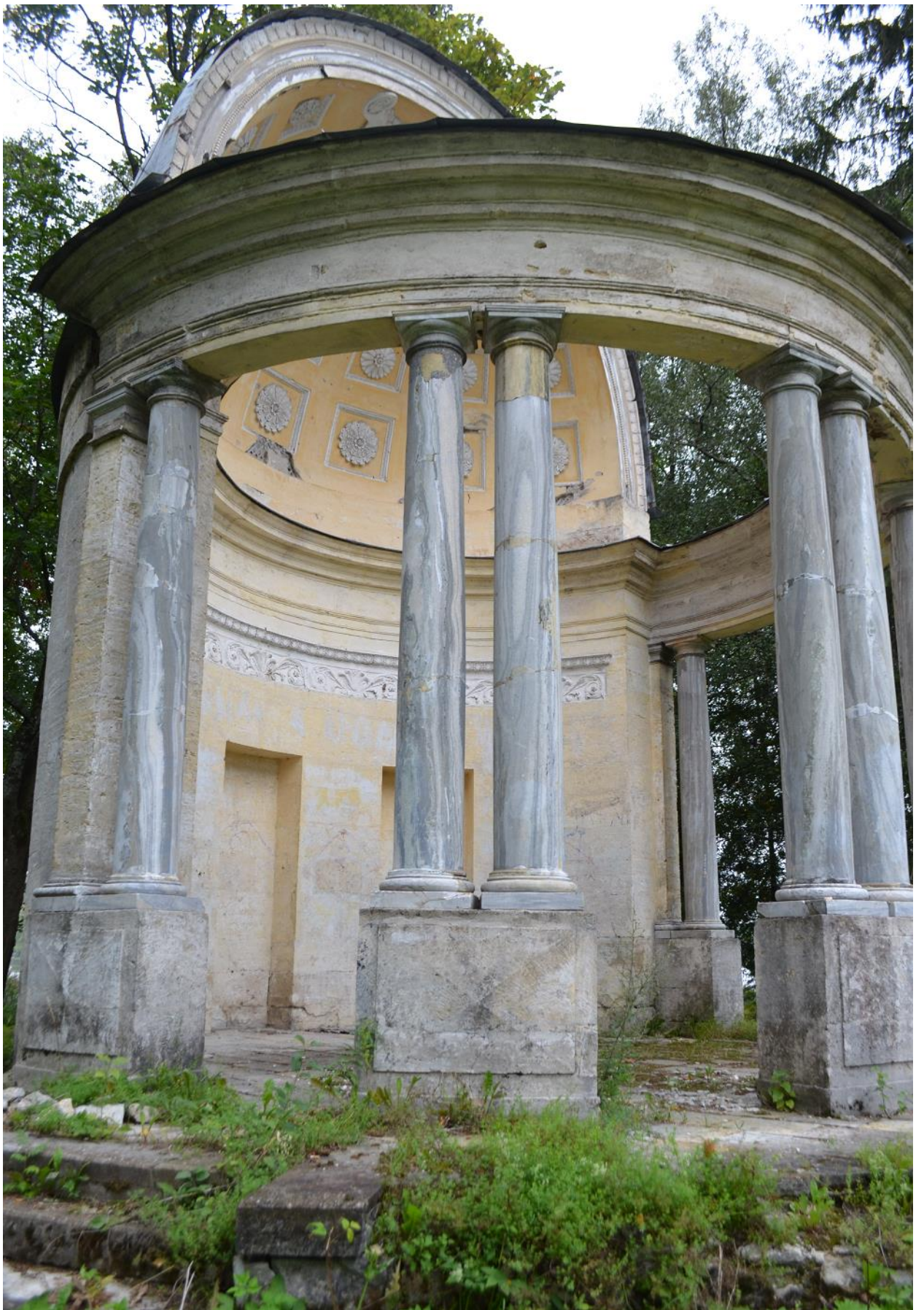
Фото 03. ОКН федерального значения «Павильон «Орла», 1790-е гг. в составе ОКН федерального значения «Ансамбль Гатчинского дворца и парка». Колоннада, вид с северо-запада. Съёмка 23.08.2021г.
