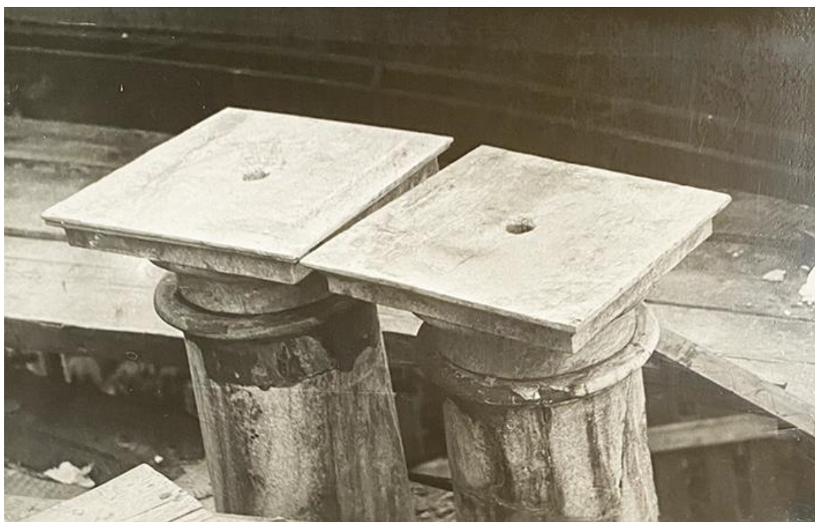
Илл. 97 Павильон Орла в процессе реставрационных работ. Фотография. 1972 г. СНРПИМ. ГМЗ «Гатчина»
