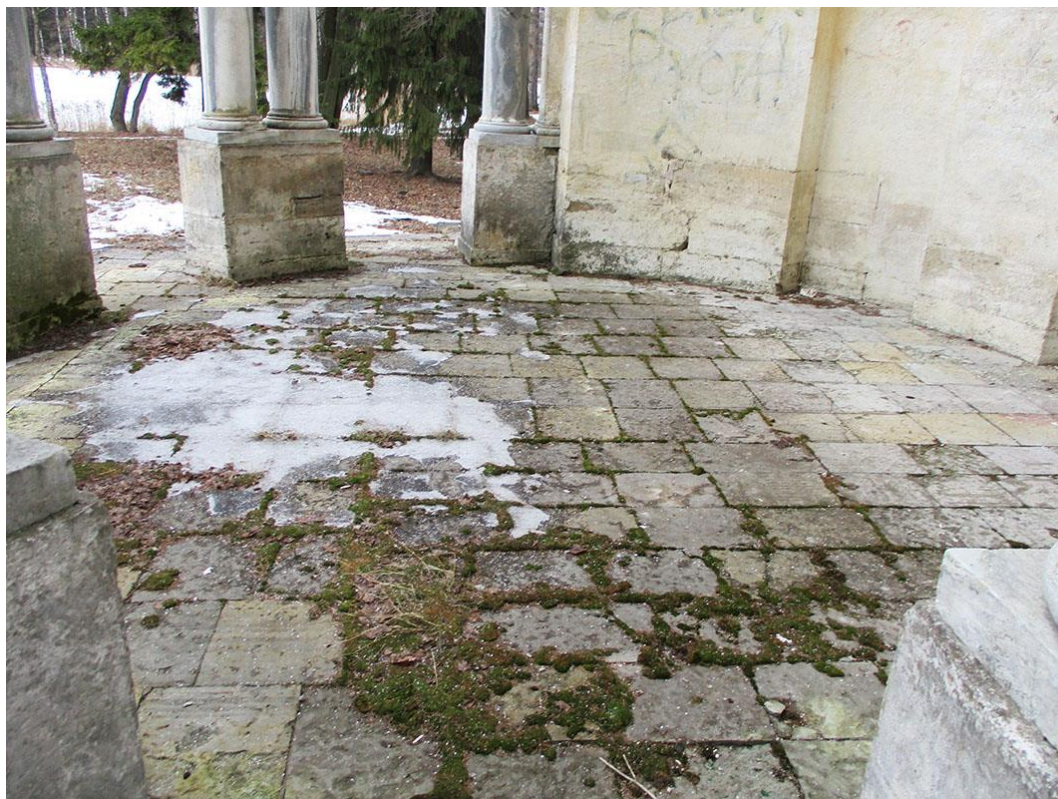
Илл.124 Павильон Орла. Состояние площадки. Фотография В. Герасимова. 2021 г.
