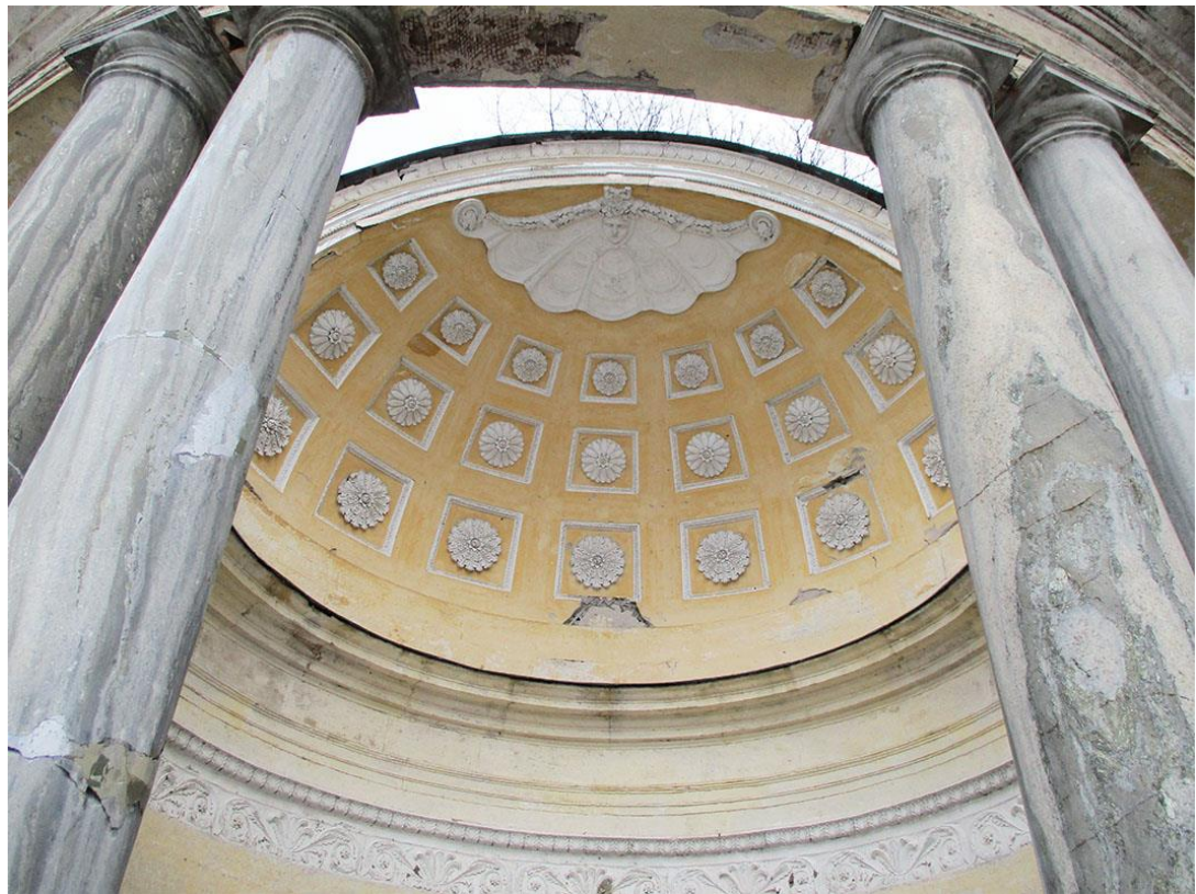
Илл.122 Павильон Орла. Состояние колонн, фриза, полукупольного свода. Фотография В. Герасимова. 2021 г.
