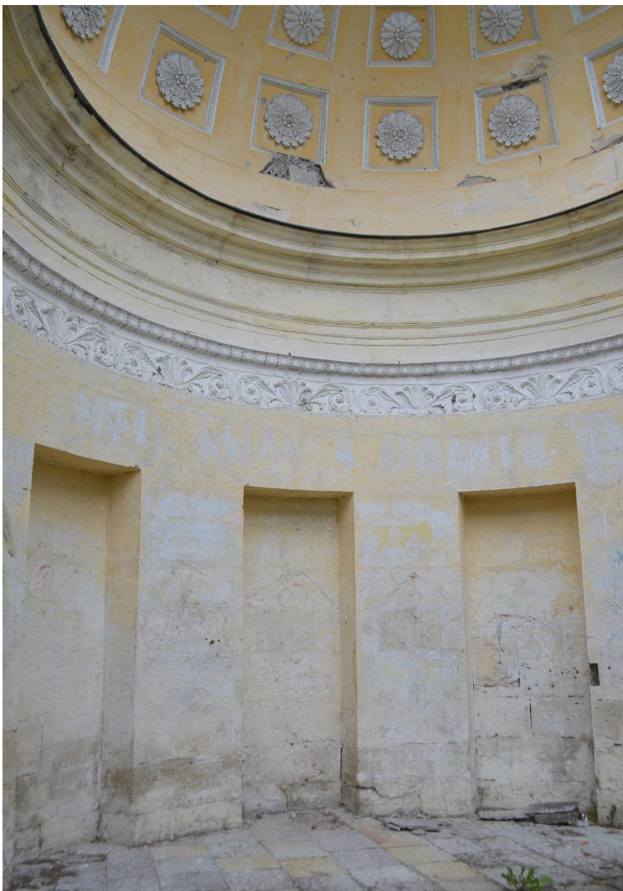
Фото 28. ОКН федерального значения «Павильон «Орла», 1790-е гг. в составе ОКН федерального значения «Ансамбль Гатчинского дворца и парка». Ниши в стене павильона, вид с запада. Фрагмент. Съёмка 23.08.2021г.
