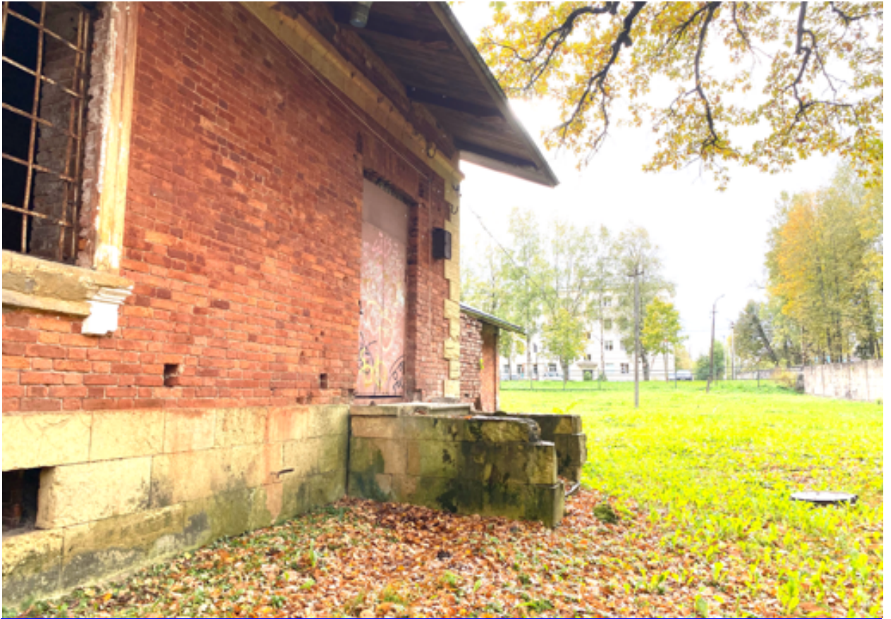
Рис. 13. Фото 2. Вид на объект культурного наследия «Здание караулки №4, 1881-1885 гг.», западный фасад. Дата создания фото 25.09.2021 г.
