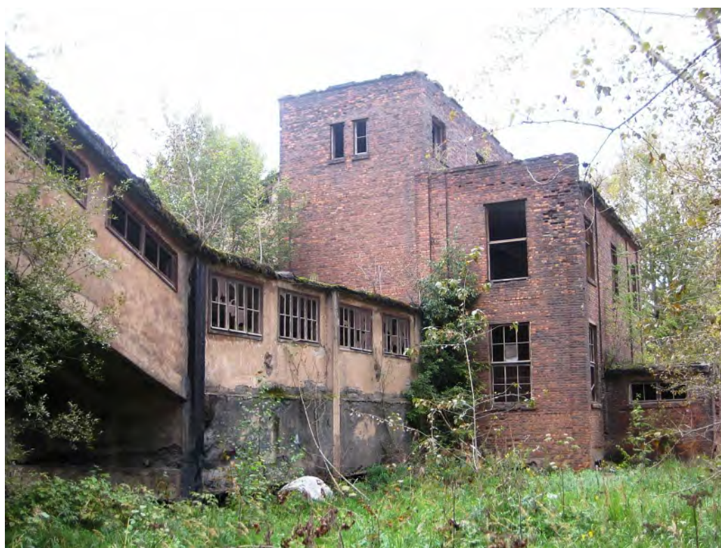
24. Корпус биохимического завода. 2011 г. Архив завода ООО "Бокситогорский завод "ПОЛИМЕР" vk.com/album-17900701_142594363
