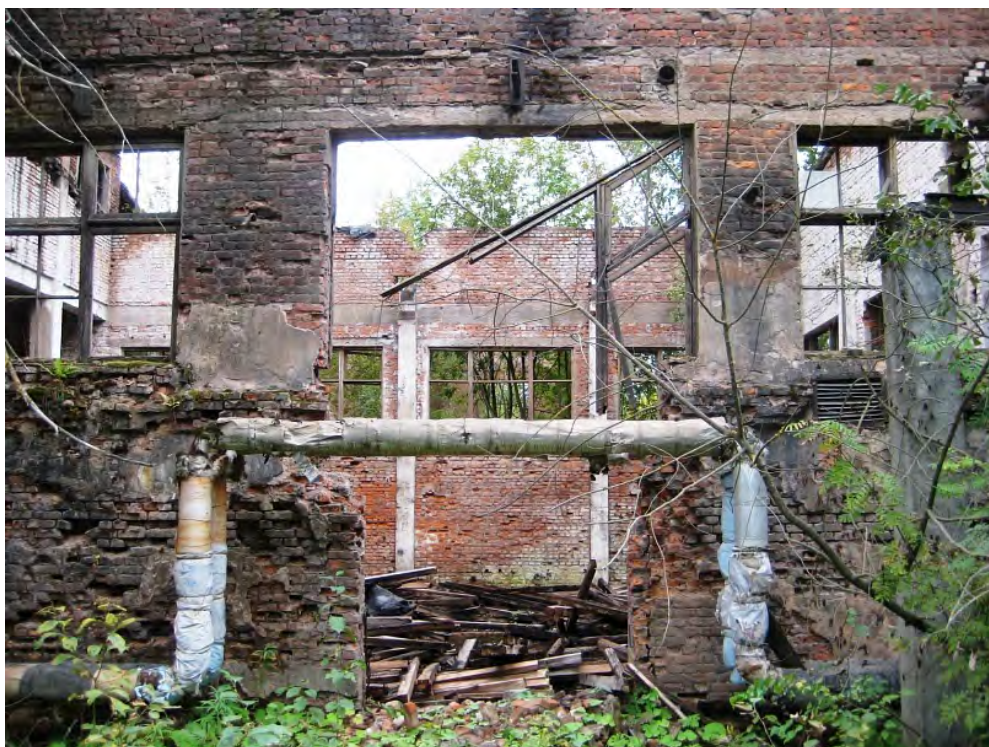
25. Корпус биохимического завода. 2011 г. Архив завода ООО "Бокситогорский завод "ПОЛИМЕР" vk.com/album-17900701_142594363
