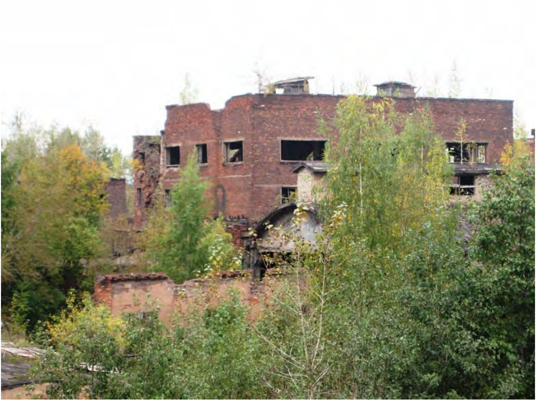
27. Корпус биохимического завода. 2011 г. Архив завода ООО "Бокситогорский завод "ПОЛИМЕР" vk.com/album-17900701_142594363
