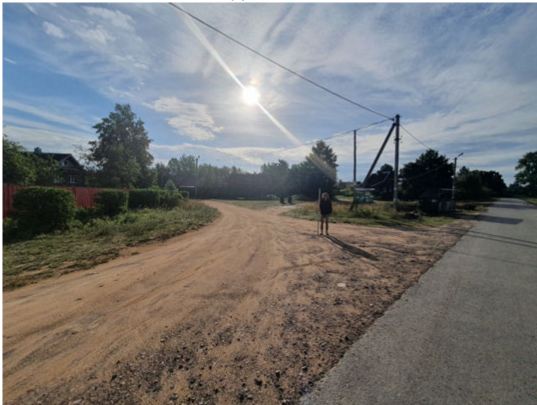
Рис. 24. ЛО-2021. Киришский район. Пчёвжинское сельское поселение, пос. Пчёвжа. Общий вид трассы обследования. Точка фотофиксации 7. Вид с запада
