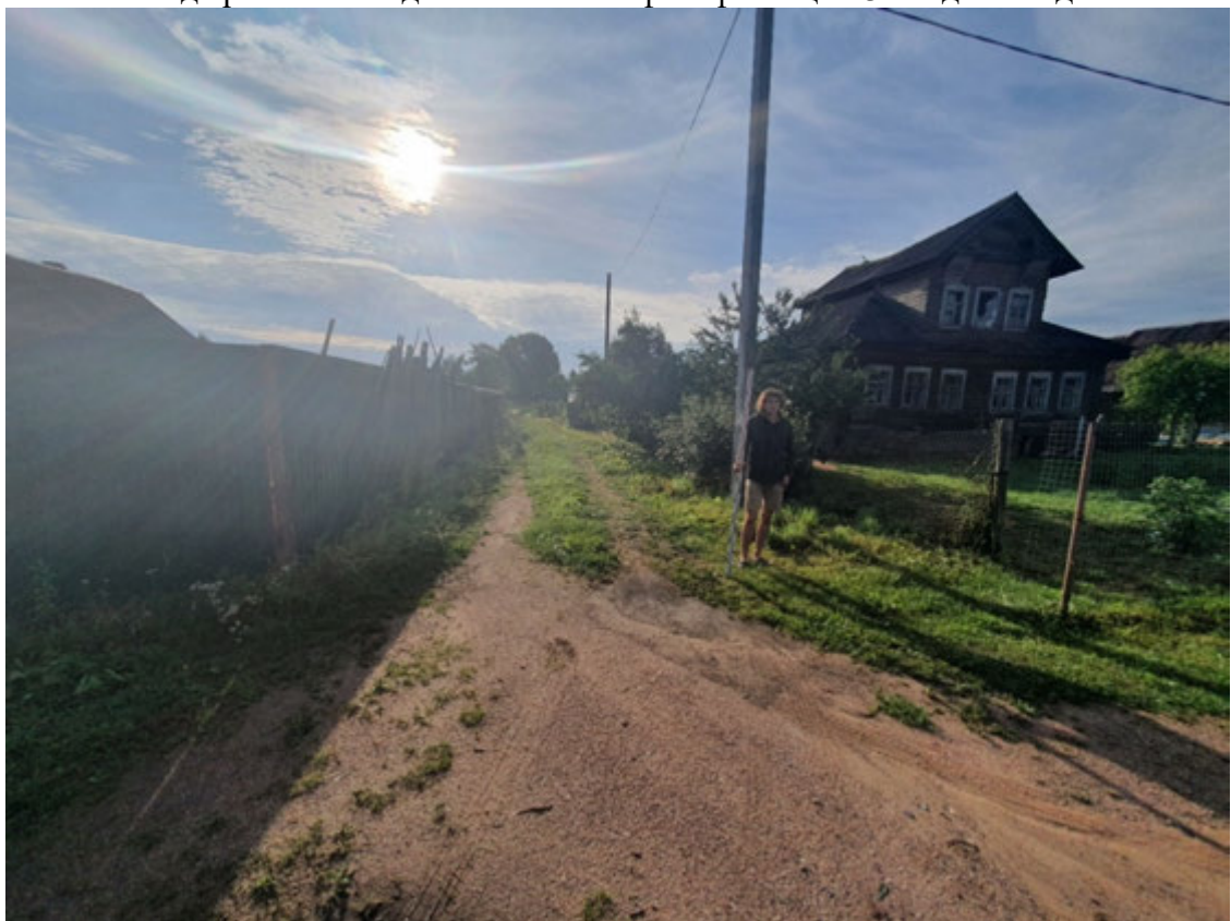
Рис. 21. ЛО-2021. Киришский район. Пчёвжинское сельское поселение, пос. Пчёвжа. Общий вид трассы обследования. Точка фотофиксации 4. Вид с запада
