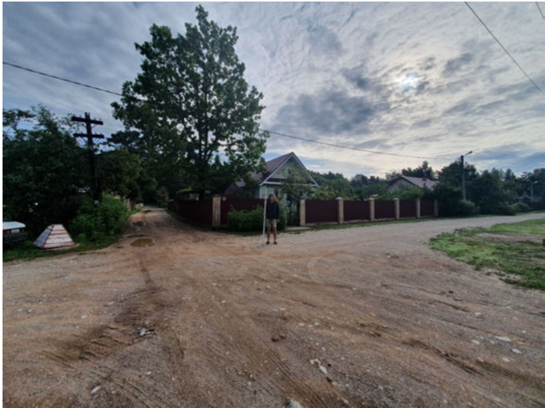
Рис. 38. ЛО-2021. Киришский район. Пчёвжинское сельское поселение, пос. Пчёвжа. Общий вид трассы обследования. Точка фотофиксации 23. Вид с запада
