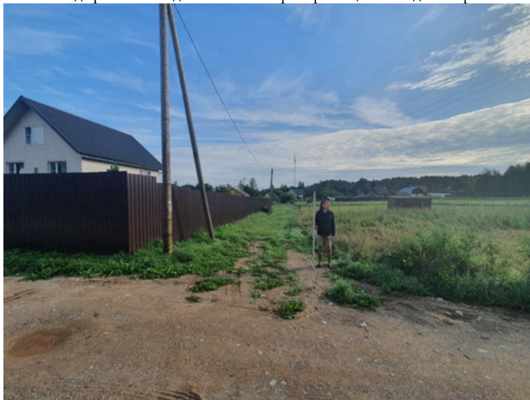
Рис. 19. ЛО-2021. Киришский район. Пчёвжинское сельское поселение, пос. Пчёвжа. Общий вид трассы обследования. Точка фотофиксации 3. Вид с запада
