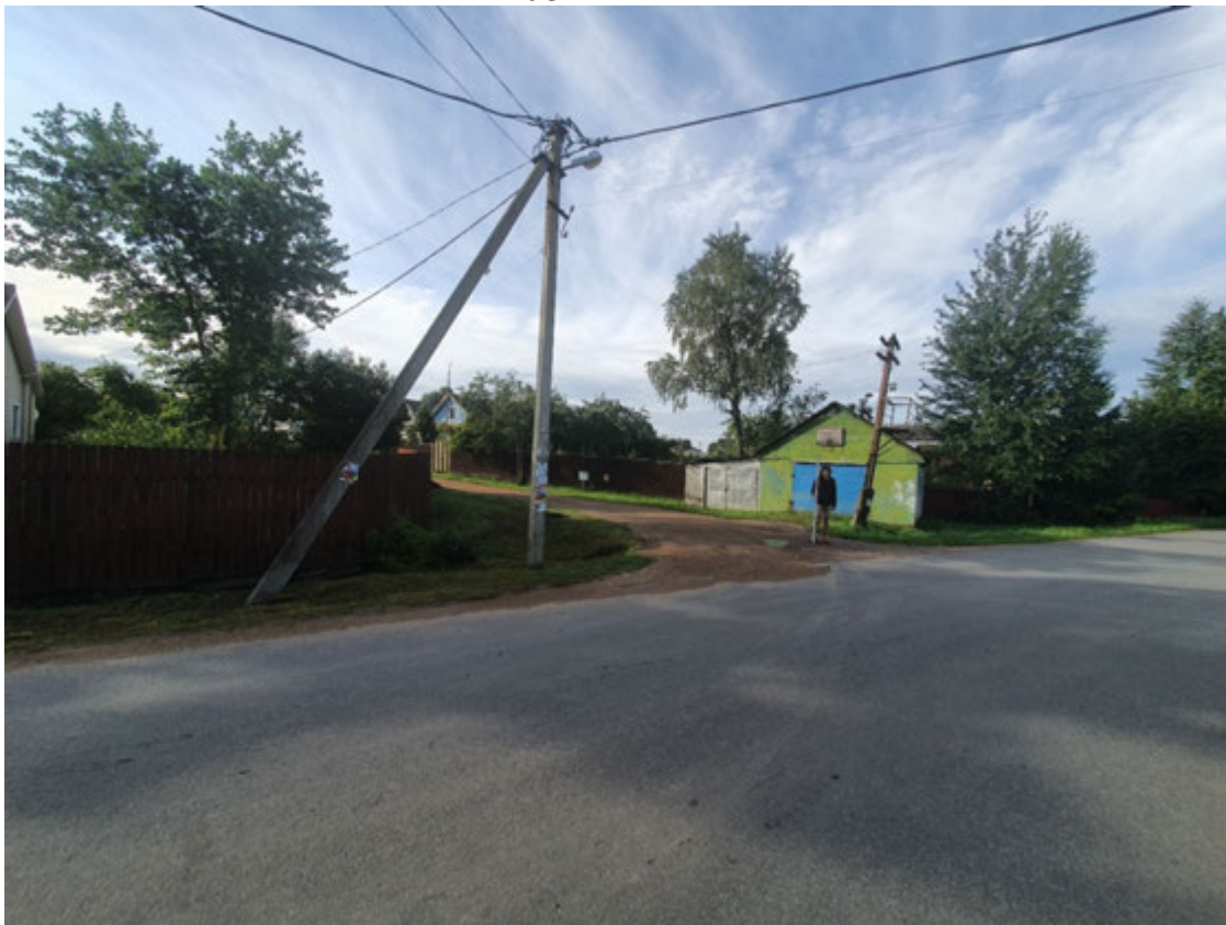
Рис. 18. ЛО-2021. Киришский район. Пчёвжинское сельское поселение, пос. Пчёвжа. Общий вид трассы обследования. Точка фотофиксации 2. Вид с севера
