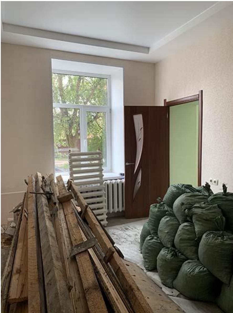
Фото 12. Общий вид помещения 1.6 с северо-востока. Фото 07.09.2021 г.
