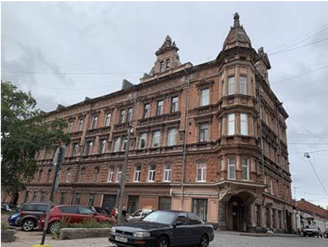
Фото 1. Общий вид здания с востока. Фото 07.09.2021 г.
