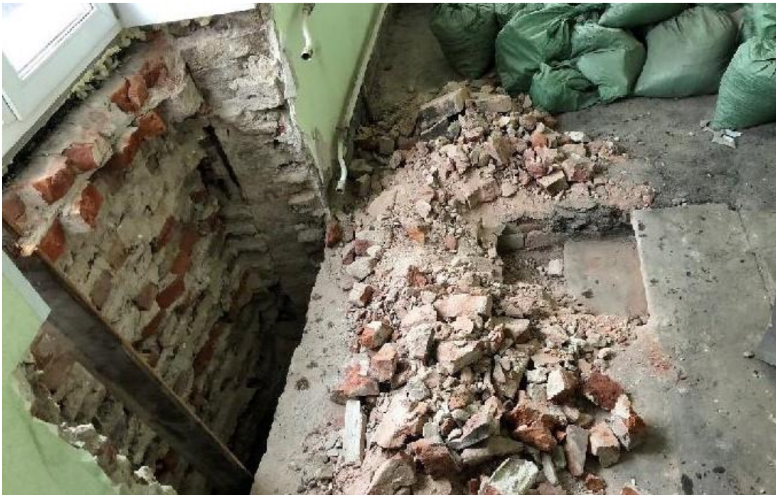
Фото 16. Раскрытие первоначальной входной лестницы в пом. 1.8.
