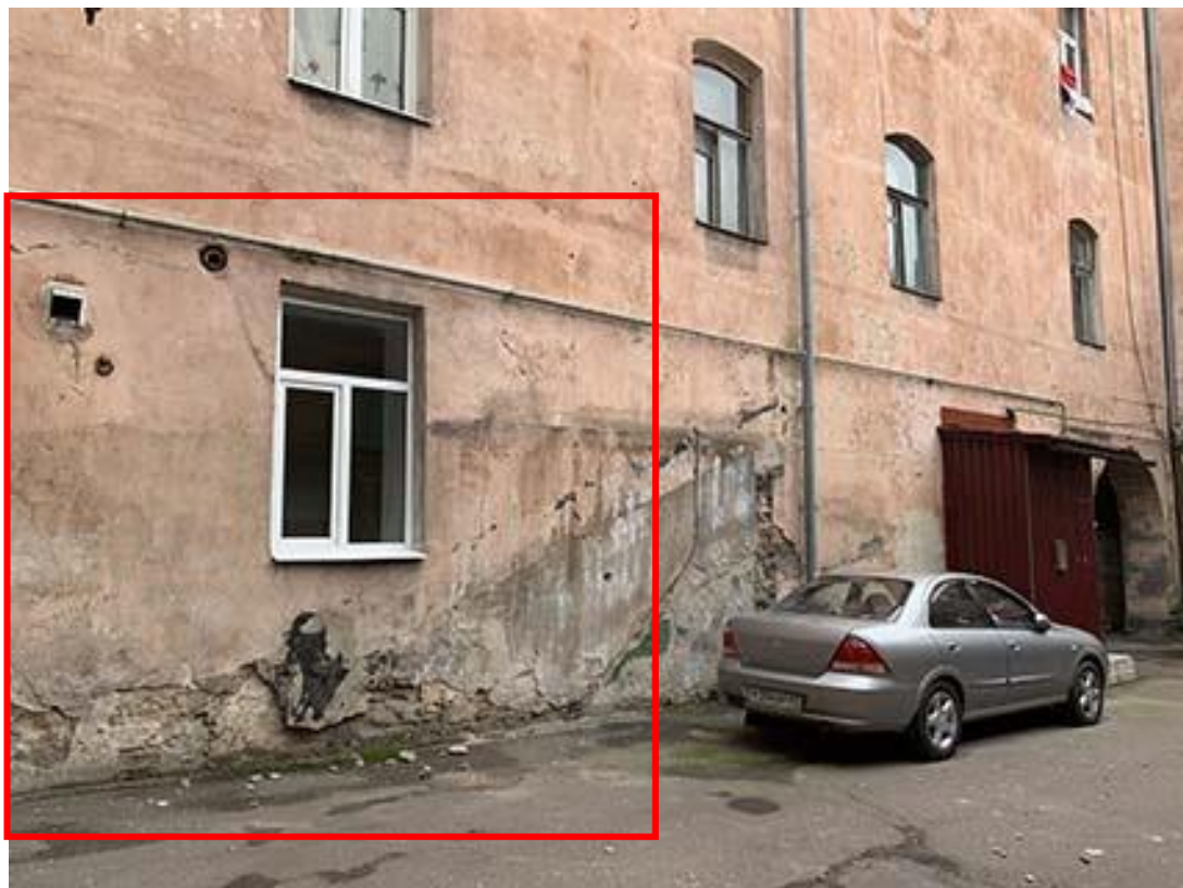
Фото 8. Фрагмент 1-го этажа дворового северо-западного фасада, соответствующего помещениям собственника. Фото 07.09.2021 г.
