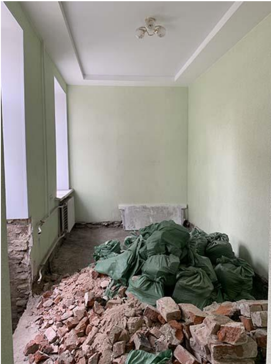
Фото 14. Общий вид помещения 1.8 с северо-востока. Фото 07.09.2021 г.
