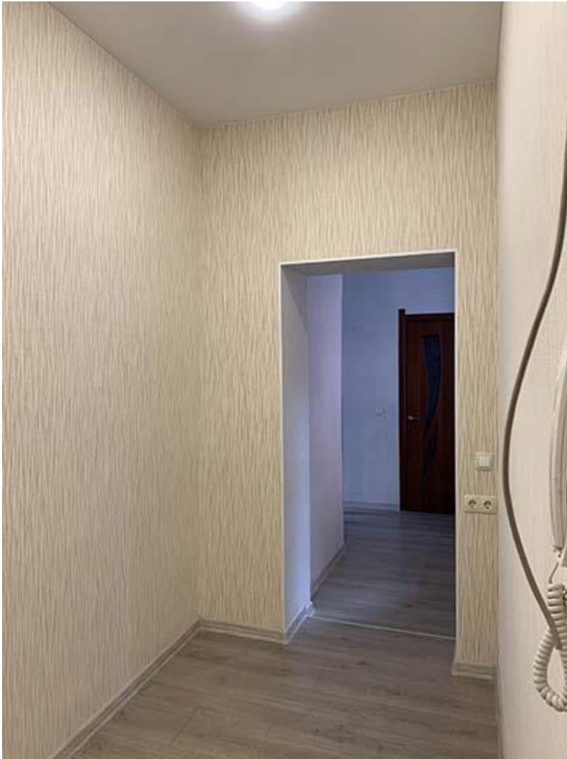
Фото 9. Общий вид пом. 1.1 с севера. Фото 07.09.2021 г.
