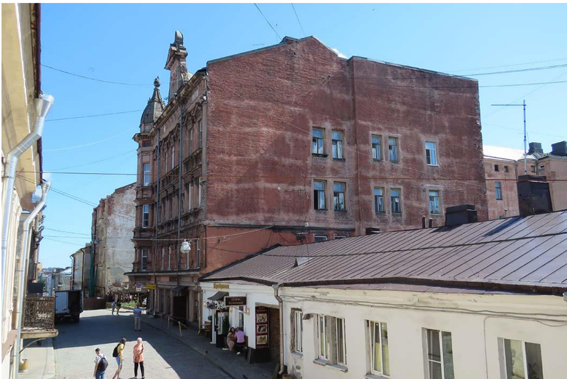
Фото 2. Общий вид здания с севера. Фото 07.09.2021 г.
