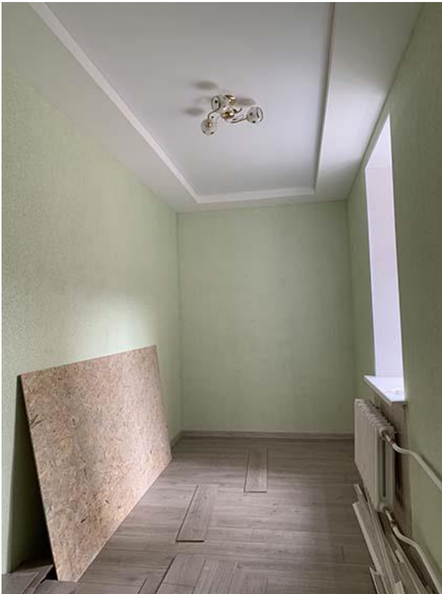
Фото 13. Общий вид помещения 1.7 с северо-востока. Фото 07.09.2021 г.
