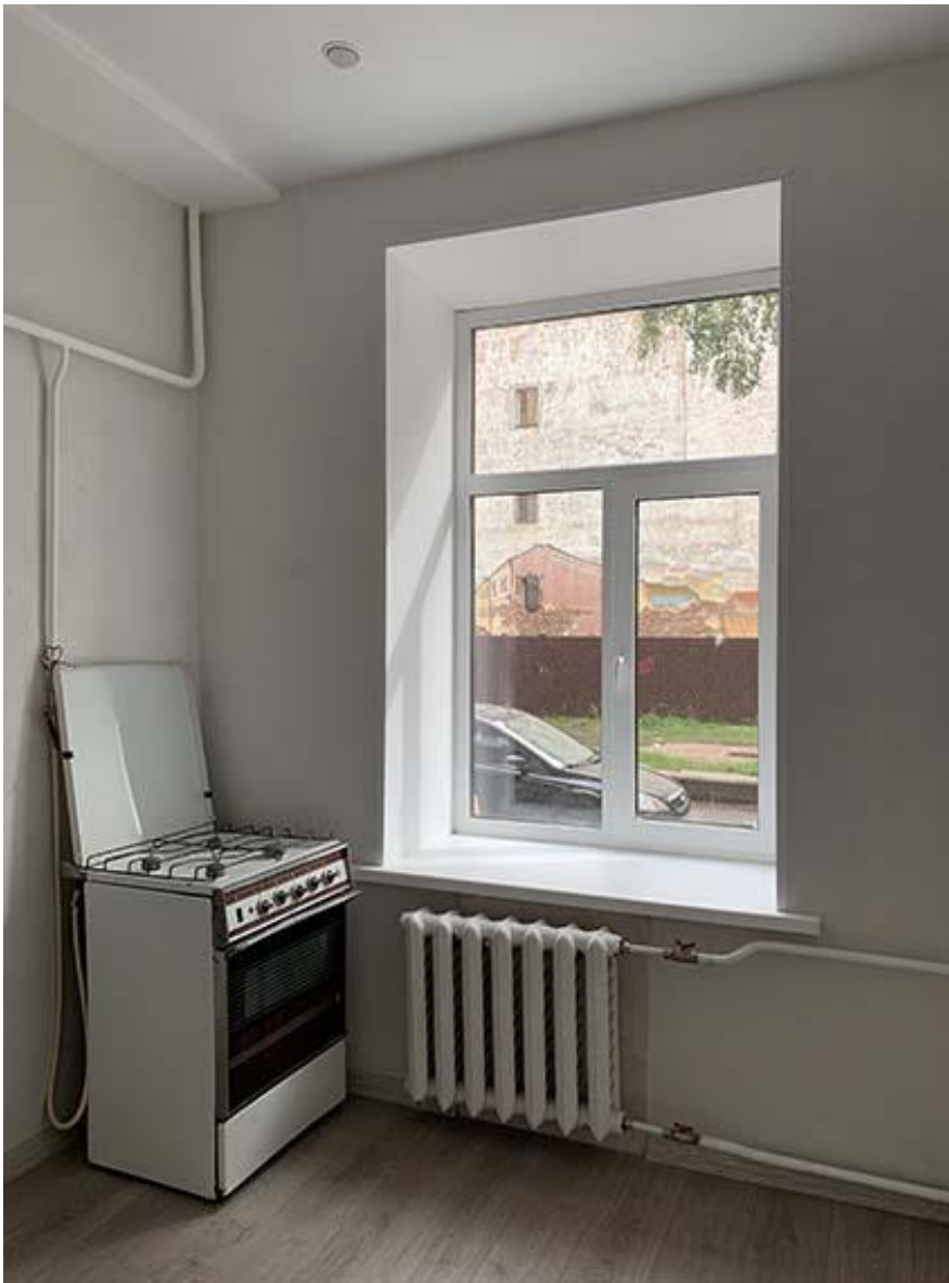
Фото 10. Вид на восточную часть помещения 1.4. Фото 07.09.2021 г.
