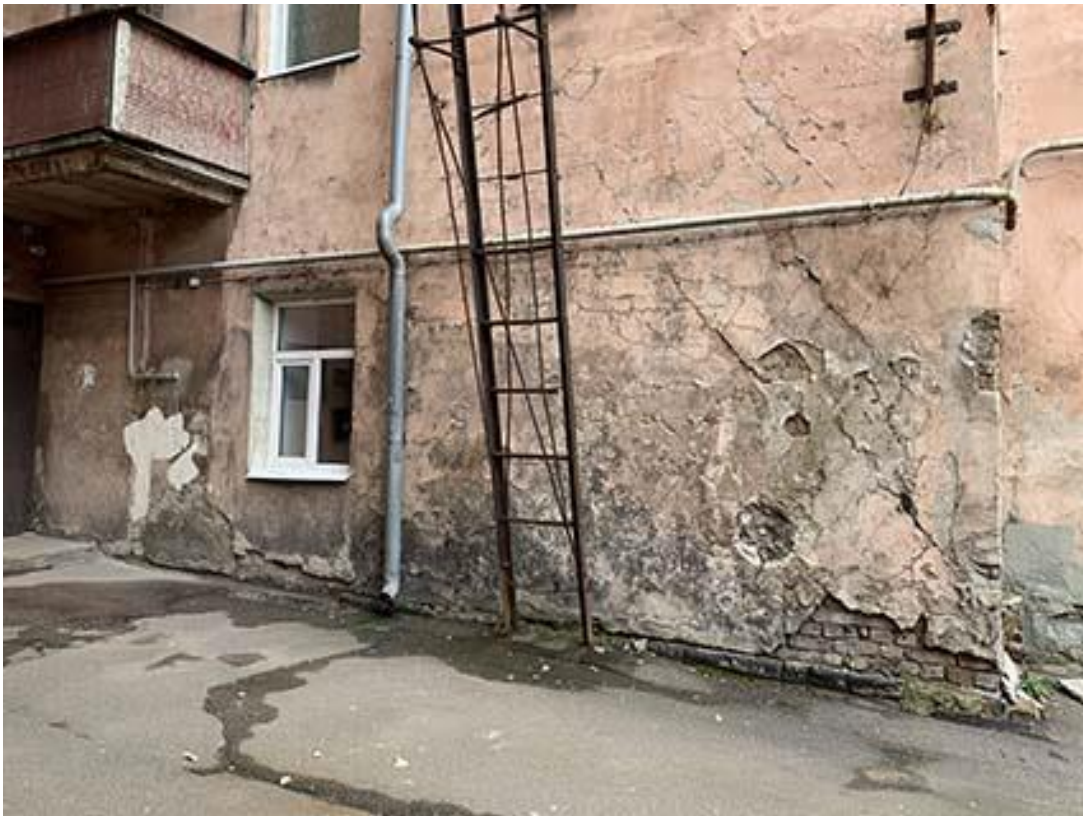
Фото 7. Фрагмент 1-го этажа дворового северо-западного фасада, соответствующего помещениям собственника. Фото 07.09.2021 г.
