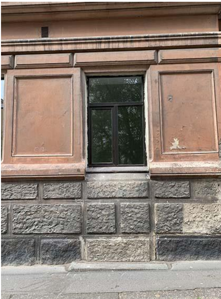
Фото 6. Фрагмент уличного юго-восточного фасада. Заложенный низ первоначального дверного проема. Фото 07.09.2021 г.
