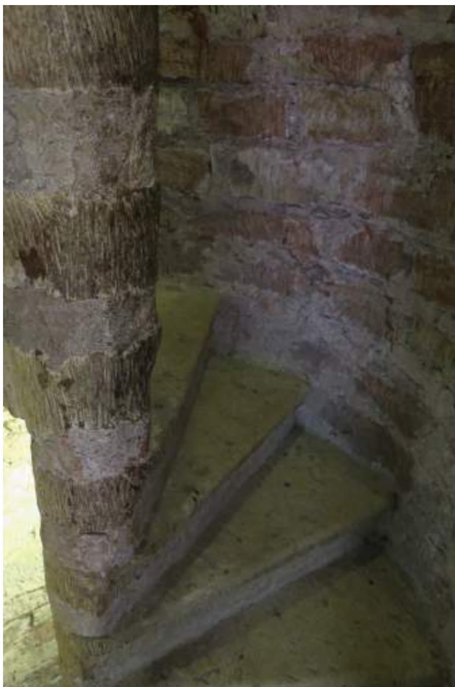
118. Винтовая лестница с опорным столбом в башне (помещения №15-19 (1-Н). 12.09.2017
