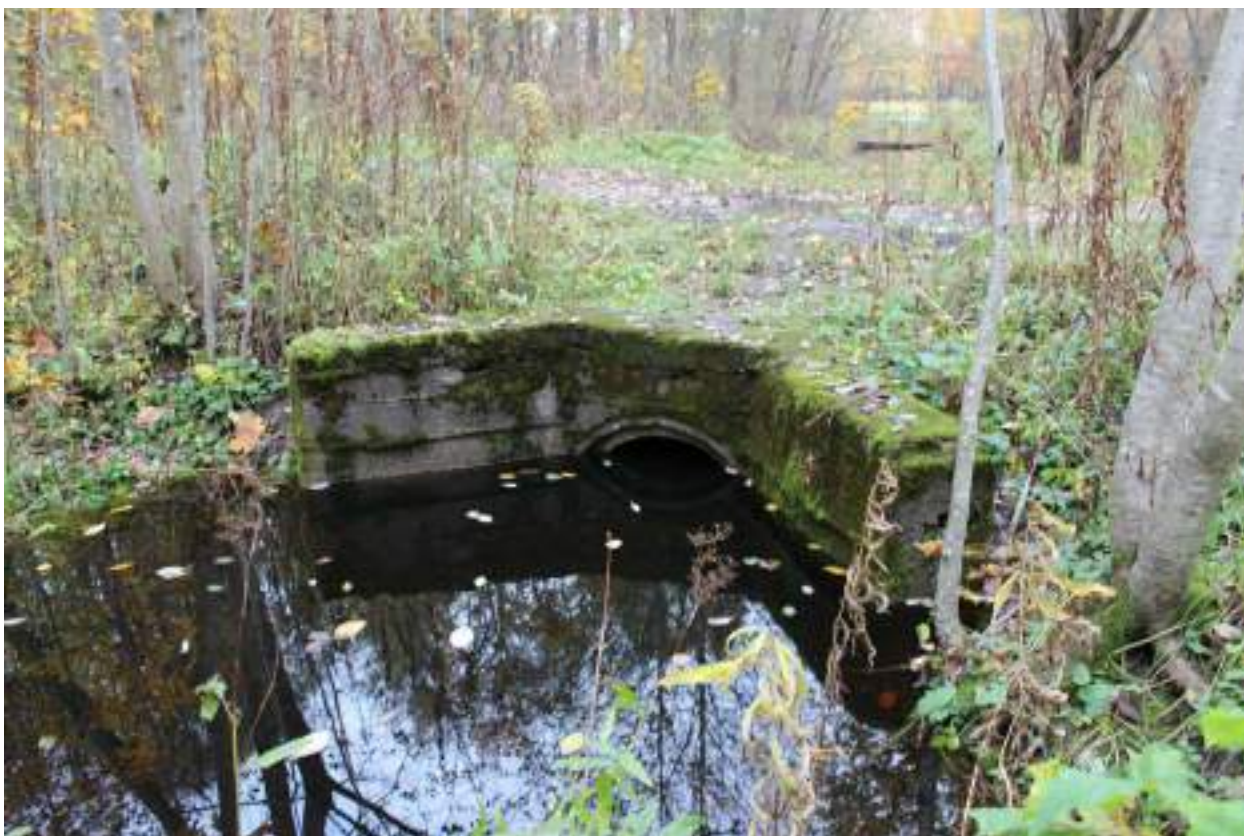
91. Поздний советский мост-труба через Колпанский водовод. 12.09.2017
