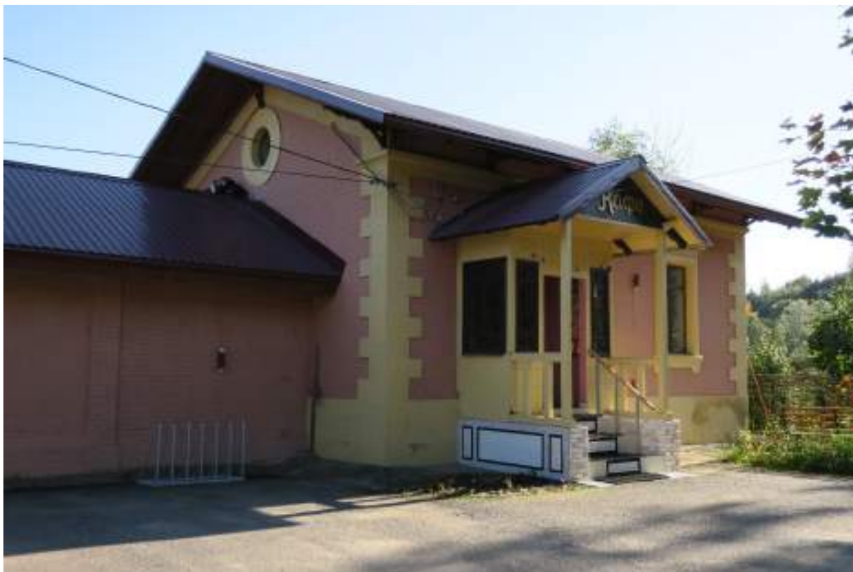
7. Северо-западные фасады здания «Караулки №3», расположенного по адресу: г. Гатчина, ул. Чкалова, д. 64а. Фрагмент. 12.09.2017
