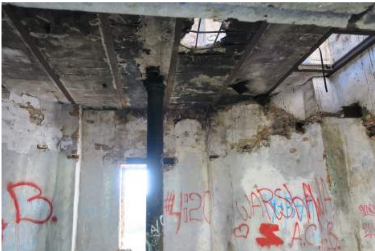
25. Интерьер водонапорной башни в уровне 1-ого яруса. 12.09.2017
