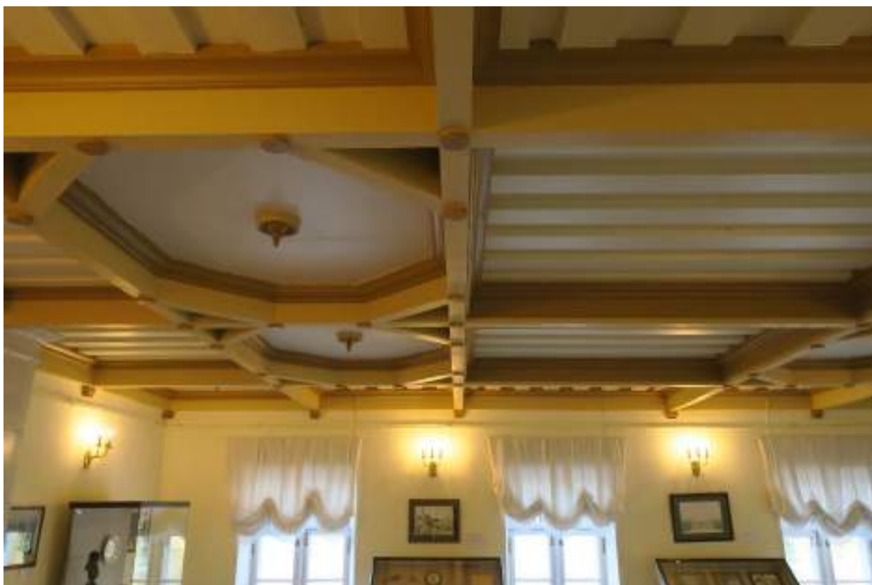
116. Кессоны в основании перекрытия помещения №16 (1-Н) в уровне 2-го этажа. 12.09.2017
