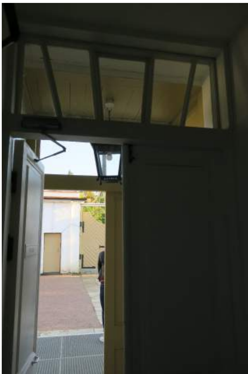
104. Дверные заполнения с фрамугами тамбура помещения №2-3 (1-Н) «Приоратского дворца». 12.09.2017
