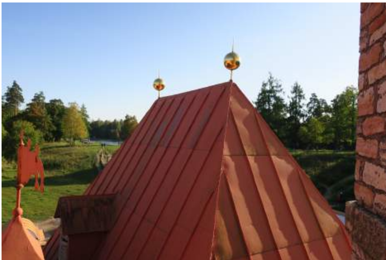
42. Кровли «Приоратского дворца», увенчанные золотыми шарами. 12.09.2017
