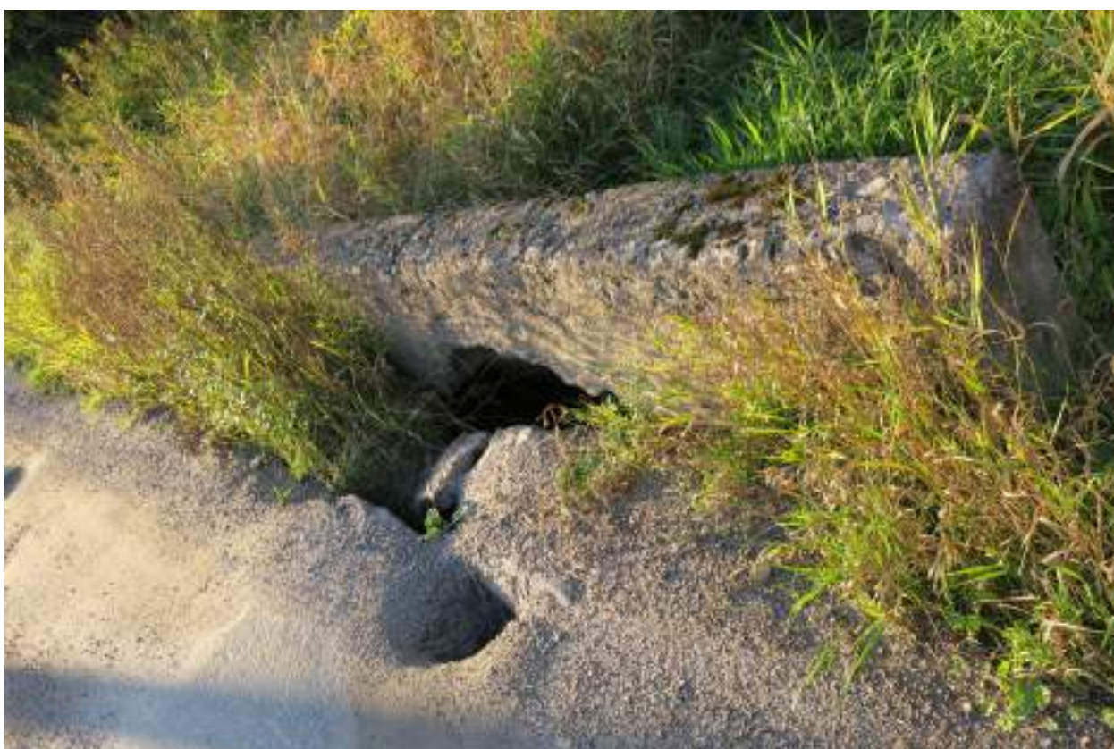
68. Поздний советский мост-труба через Колпанский водовод по ул. Сойту. 12.09.2017
