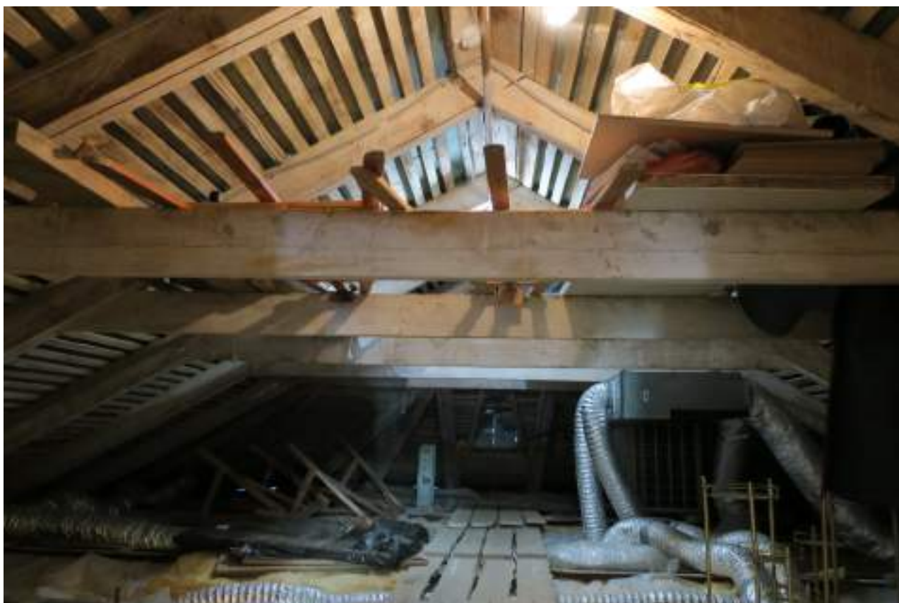
113. Стропильная система крыши «капеллы». 12.09.2017
