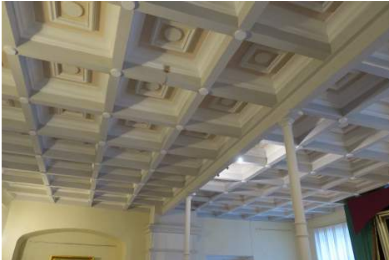
108. Кессоны в основании перекрытия помещения №10 (1-Н), опирающегося на металлические столбы. 12.09.2017
