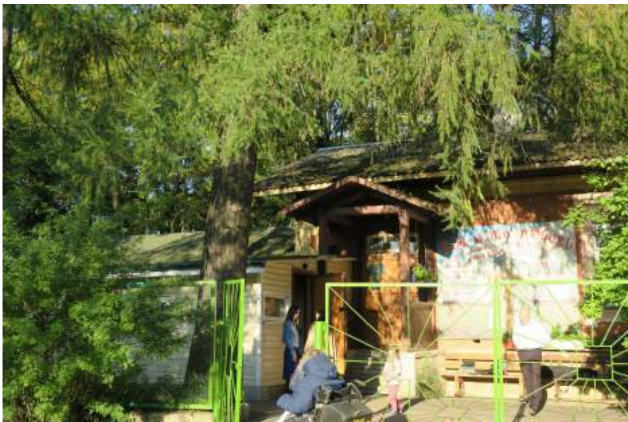
53. Западные фасады здания «Караулки №1», расположенного по адресу: г. Гатчина, ул. Чкалова, д. 2А. 12.09.2017
