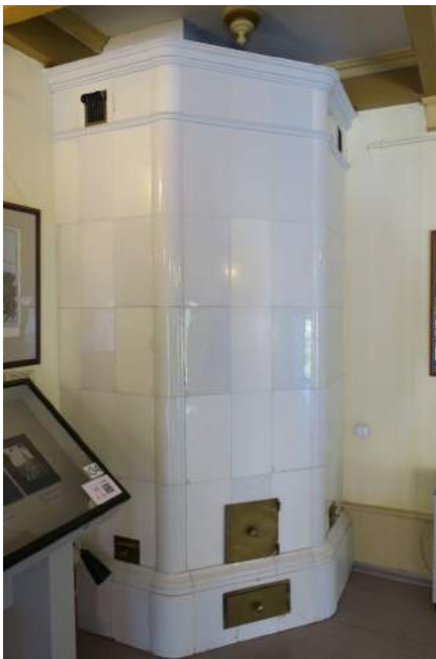
115. «Голландская» печь в помещении №17(1-Н) в уровне 2-го этажа. 12.09.2017
