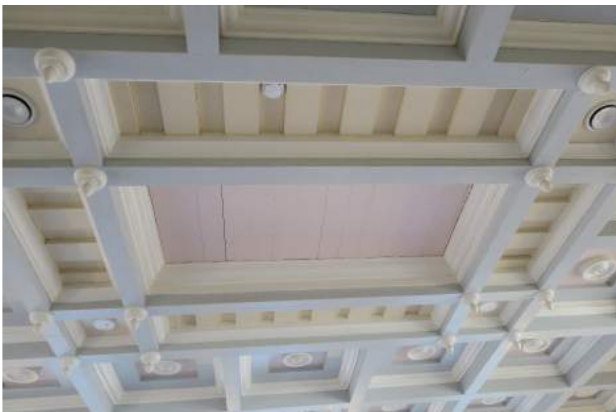
98. Кессоны в основании перекрытия помещения №4 (1-Н) «капеллы» «Приоратского дворца». Фрагмент. 12.09.2017
