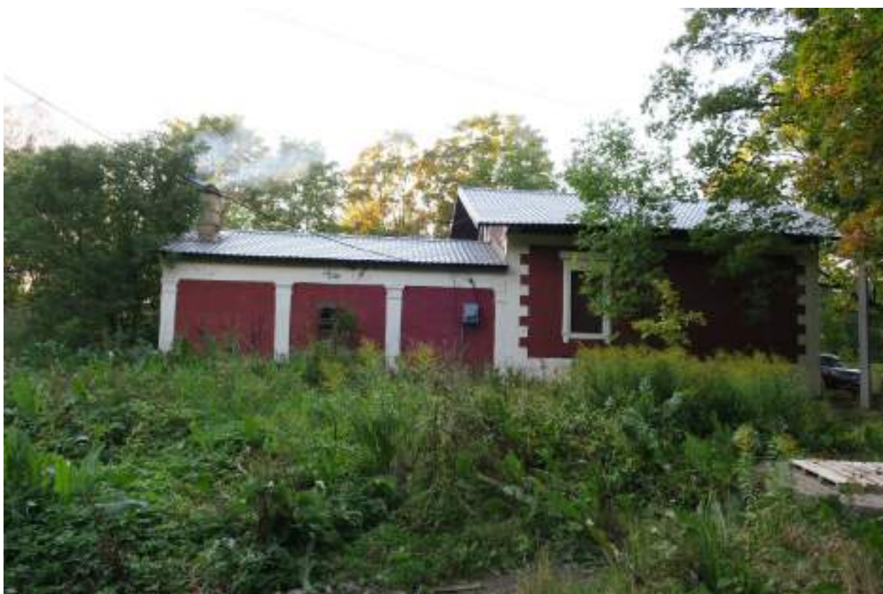
80. Восточные фасады здания «Караулки №4», расположенного по адресу: г. Гатчина, ул. Киевская, д. 2. 12.09.2017
