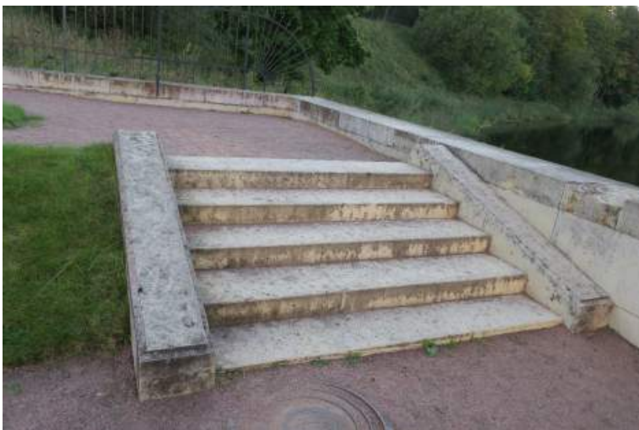
45. Лестница из известняковых блоков для перехода между террасами регулярного партерного сада. 12.09.2017
