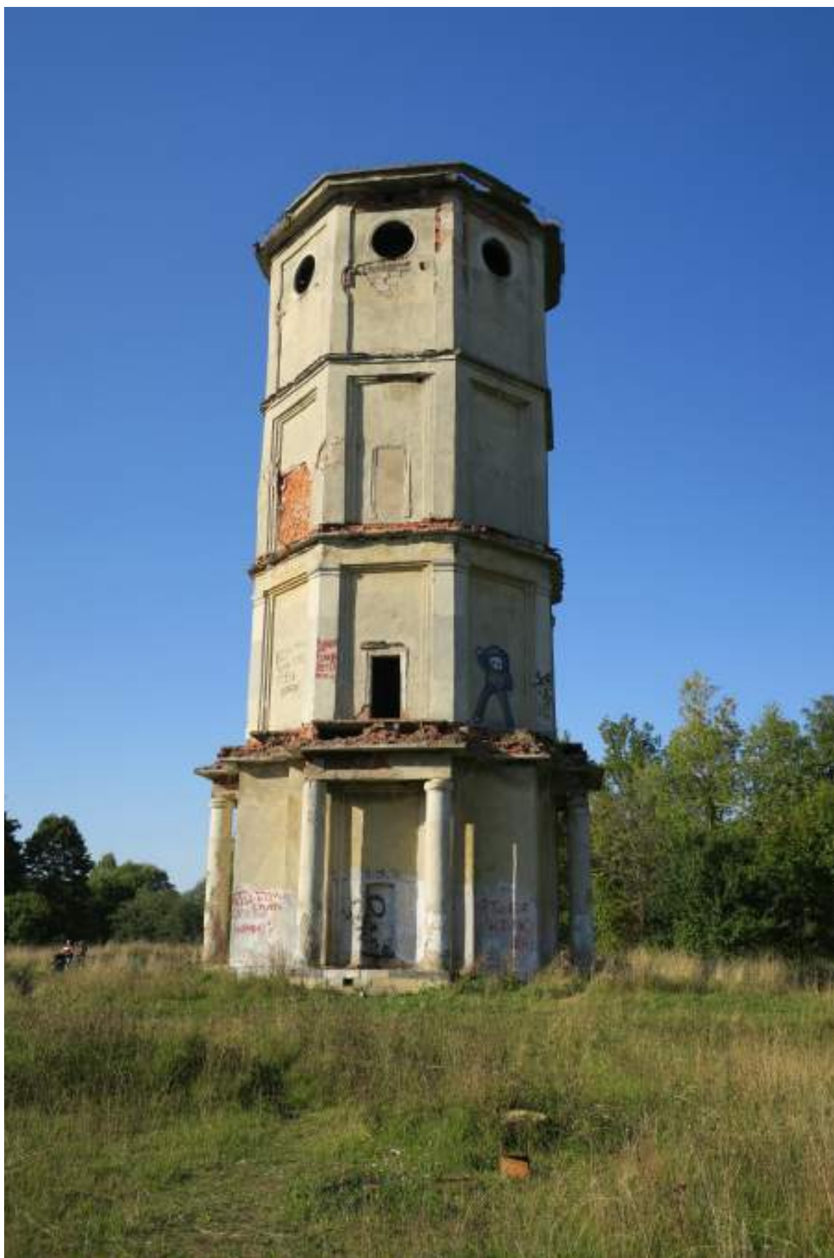
23. Южный фасад водонапорной башни. 12.09.2017
