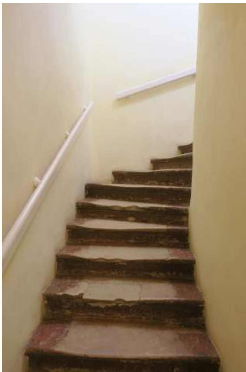
110. Одномаршевая лестница со ступенями, облицованными известняком, ведущая на 2-ой этаж «Приоратского дворца». 12.09.2017
