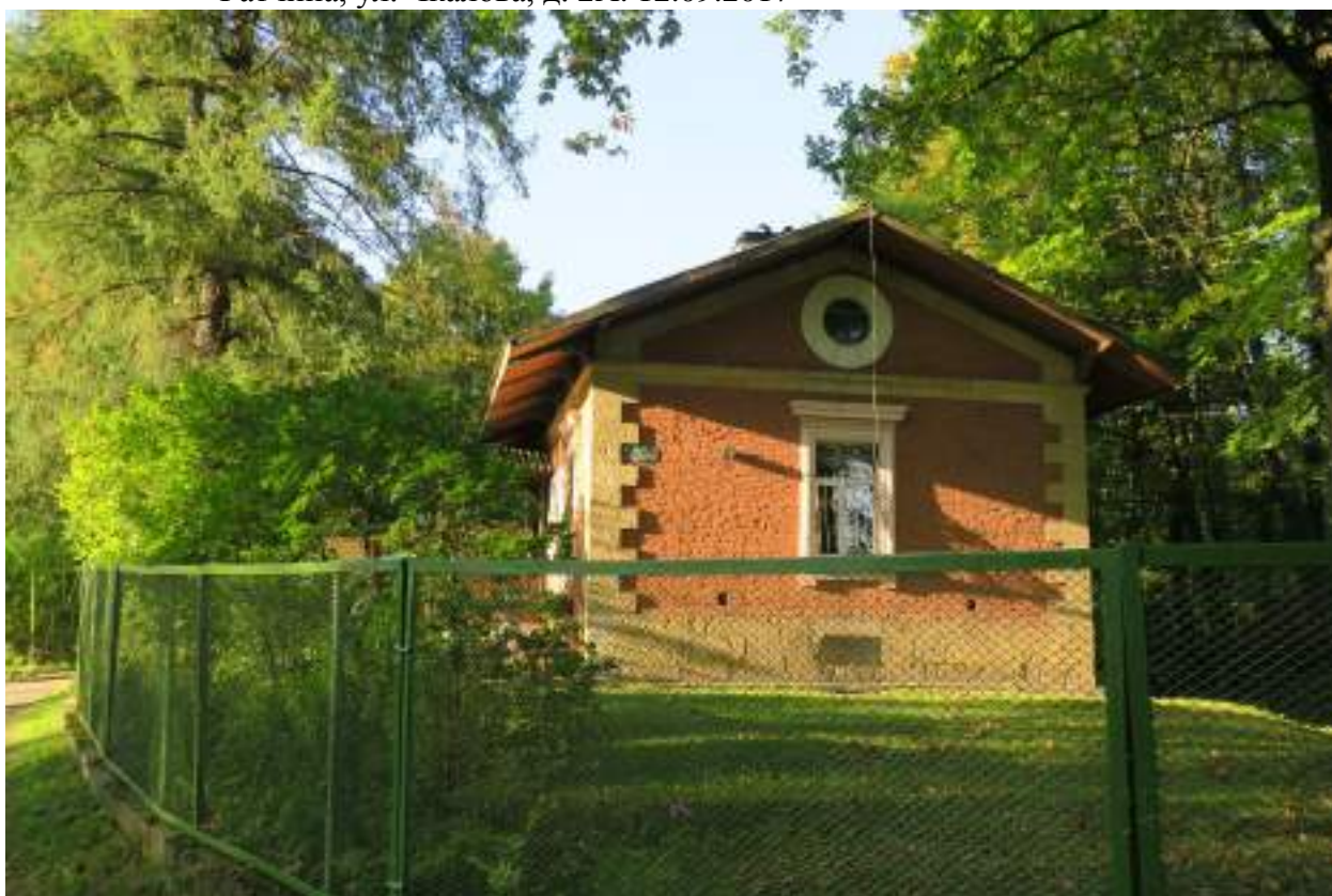
54. Южный фасад здания «Караулки №1», расположенного по адресу: г. Гатчина, ул. Чкалова, д. 2А. 12.09.2017
