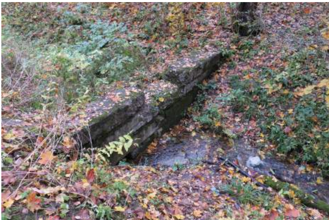
95. Поздняя советская плотина из бетонных блоков на ручье, впадающем в озеро Филькино с севера. 12.09.2017
