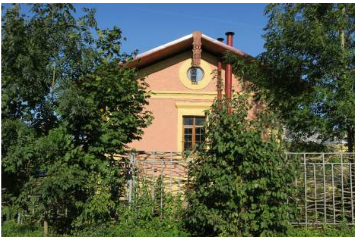
4. Юго-западный фасад здания «Караулки №3», расположенного по адресу: г. Гатчина, ул. Чкалова, д. 64а. 12.09.2017
