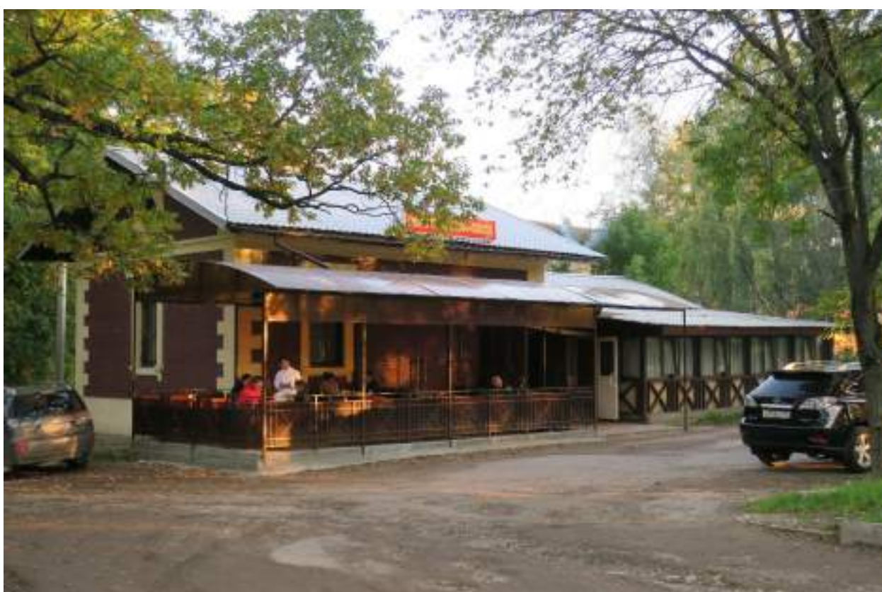
78. Западные фасады здания «Караулки №4», расположенного по адресу: г. Гатчина, ул. Киевская, д. 2. 12.09.2017
