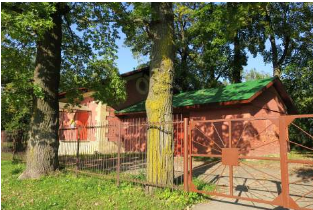
17. Западные фасады здания «Караулки №2», расположенного по адресу: г. Гатчина, ул. Чкалова, д. 2 к2. 12.09.2017
