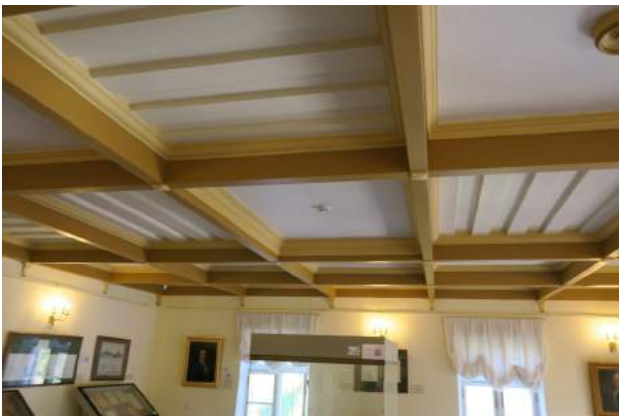
114. Кессоны в основании перекрытия помещения №17(1-Н) в уровне 2-го этажа. 12.09.2017
