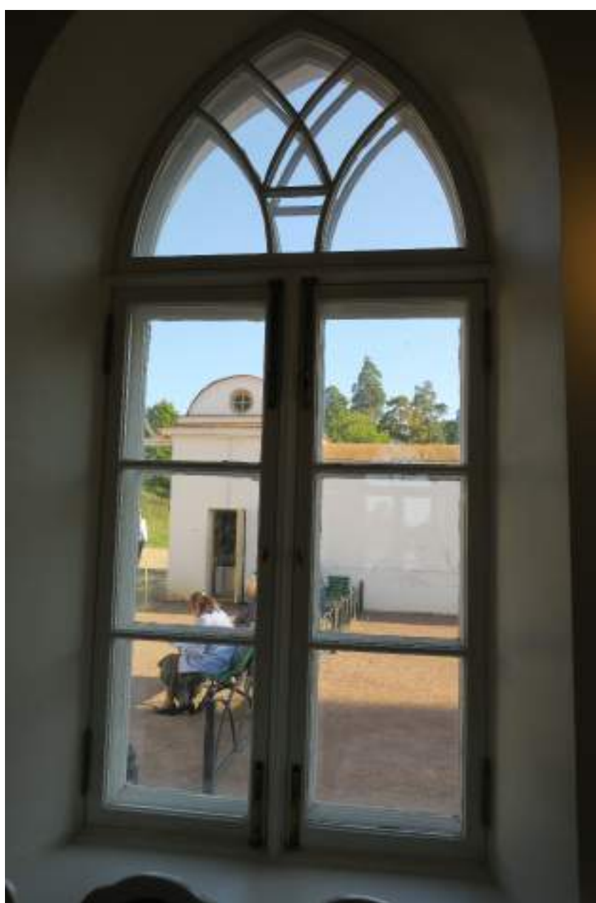
99. Стрельчатые деревянные оконные заполнения помещения №4 (1-Н) «капеллы» «Приоратского дворца». 12.09.2017
