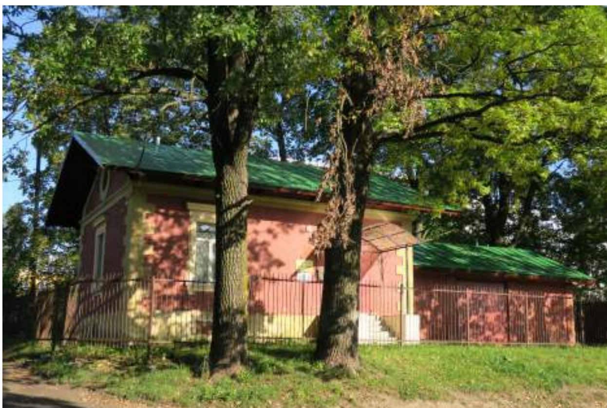
16. Западные фасады здания «Караулки №2», расположенного по адресу: г. Гатчина, ул. Чкалова, д. 2 к2. 12.09.2017
