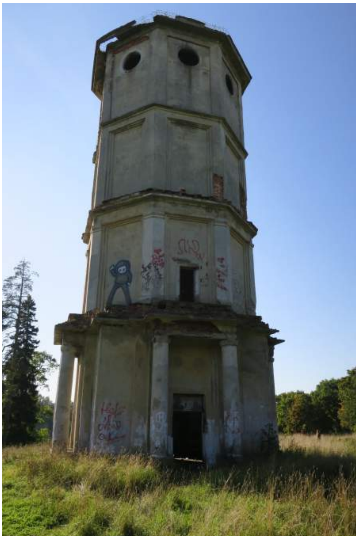
22. Восточный фасад водонапорной башни 12.09.2017
