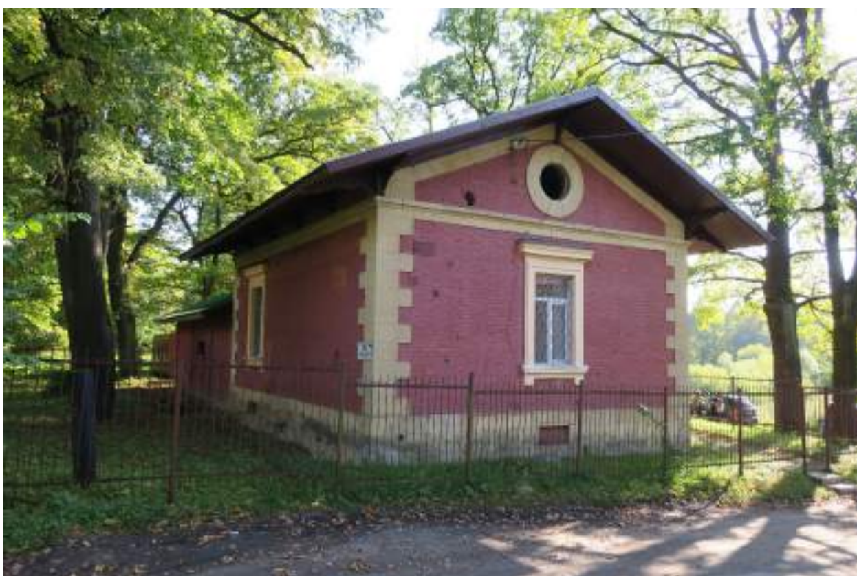
18. Северный фасад здания «Караулки №2», расположенного по адресу: г. Гатчина, ул. Чкалова, д. 2 к2. 12.09.2017
