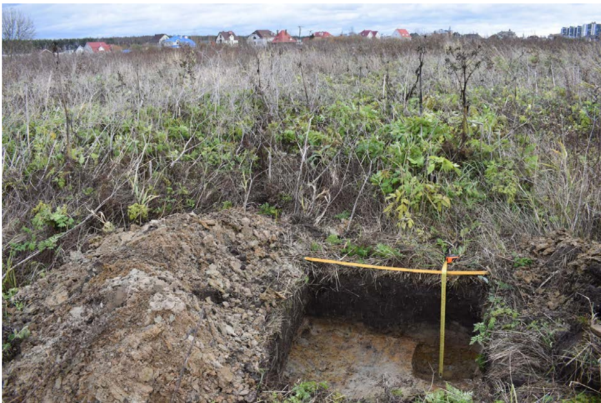
Рис. 34. Ленинградская область, Ломоносовский район, Новоселье-2021. Шурф-4. Вид на место закладки шурфа. Вид на восток.
