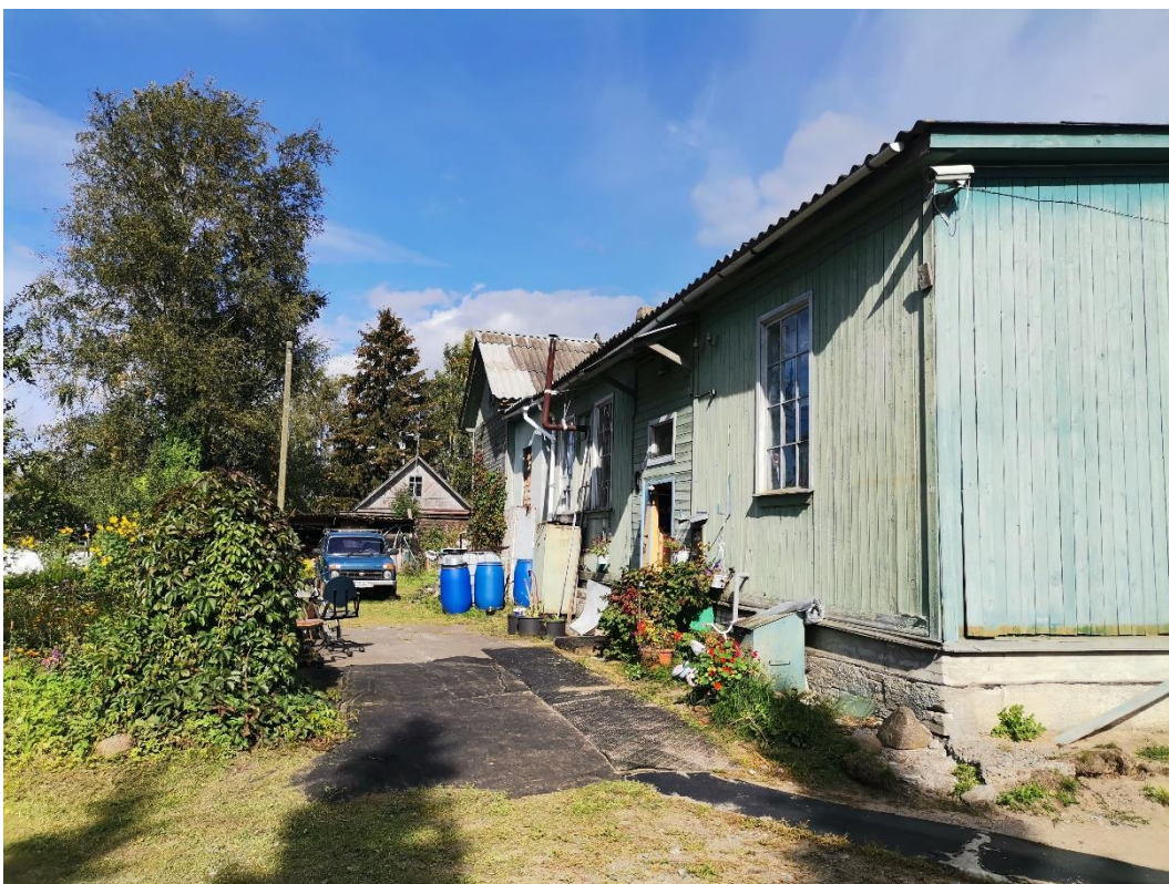
3. «В этом доме в 1941-43 гг. находился штаб автомобилистов, осуществляющих автоперевозки через Ладожское озеро по «Дороге жизни». На доме установлена памятная доска», Ленинградская обл., Всеволожский район, д. Коккорево, д. 27. Западный фасад. Общий вид. Фото 11.08.2021 г.
