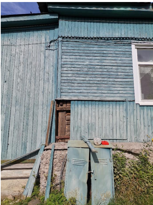
9. «В этом доме в 1941-43 гг. находился штаб автомобилистов, осуществляющих автоперевозки через Ладожское озеро по «Дороге жизни». На доме установлена памятная доска», Ленинградская обл., Всеволожский район, д. Коккореево, д. 27. Южный фасад. Фрагмент. Фото 11.08.2021 г.
