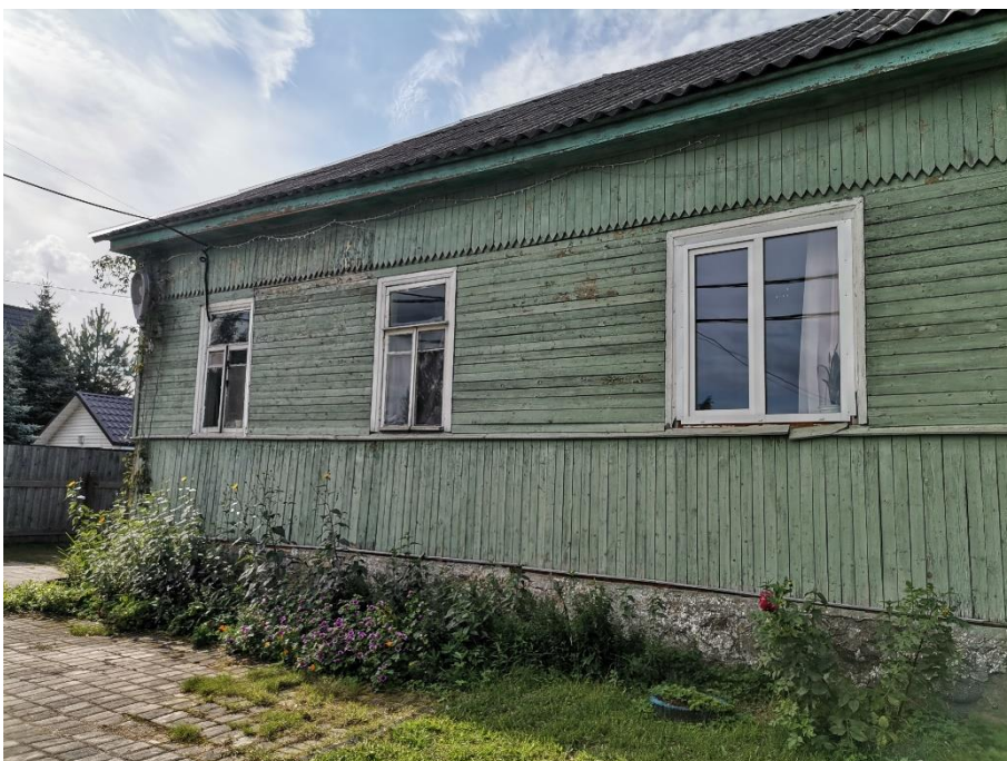
5. «В этом доме в 1941-43 гг. находился штаб автомобилистов, осуществляющих автоперевозки через Ладожское озеро по «Дороге жизни». На доме установлена памятная доска», Ленинградская обл., Всеволожский район, д. Коккореве, д. 27. Восточный фасад. Фрагмент. Фото 11.08.2021 г.
