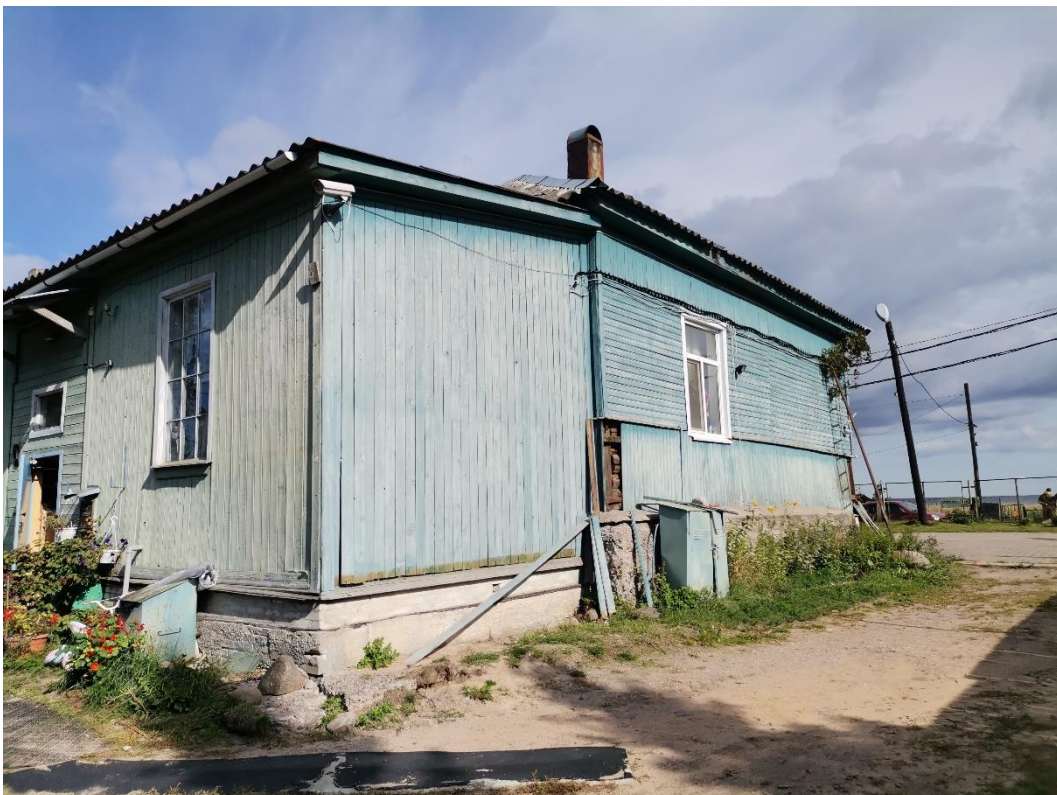
2. «В этом доме в 1941-43 гг. находился штаб автомобилистов, осуществляющих автоперевозки через Ладожское озеро по «Дороге жизни». На доме установлена памятная доска», Ленинградская обл., Всеволожский район, д. Коккореево, д. 27. Южный фасад. Общий вид. Фото 11.08.2021 г.
