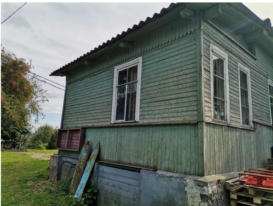
16. «В этом доме в 1941-43 гг. находился штаб автомобилистов, осуществляющих автоперевозки через Ладожское озеро по «Дороге жизни». На доме установлена памятная доска», Ленинградская обл., Всеволожский район, д. Коккореве, д. 27. Северный фасад. Фрагмент. Фото 11.08.2021 г.
