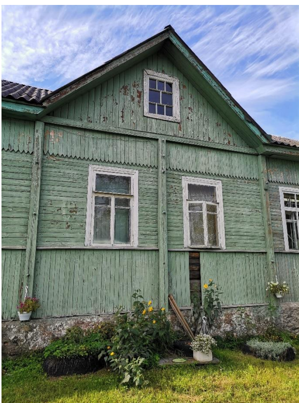
6. «В этом доме в 1941-43 гг. находился штаб автомобилистов, осуществляющих автоперевозки через Ладожское озеро по «Дороге жизни». На доме установлена памятная доска», Ленинградская обл., Всеволожский район, д. Коккореве, д. 27. Восточный фасад. Фрагмент. Фото 11.08.2021 г.
