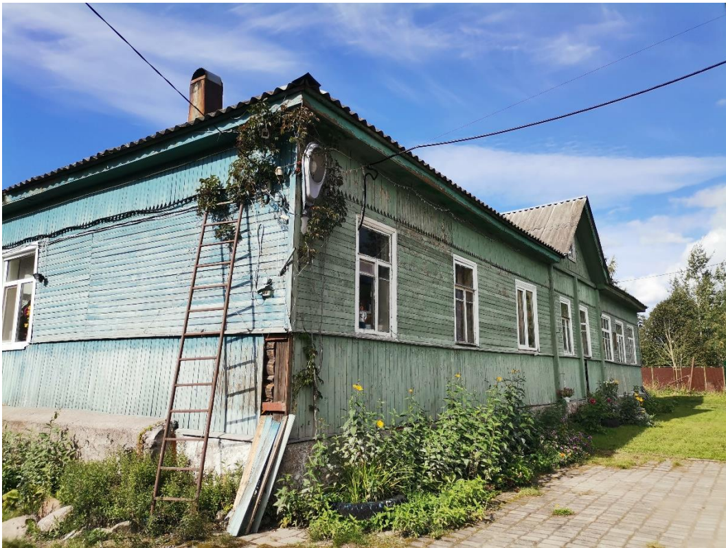
1. «В этом доме в 1941-43 гг. находился штаб автомобилистов, осуществляющих автоперевозки через Ладожское озеро по «Дороге жизни». На доме установлена памятная доска», Ленинградская обл., Всеволожский район, д. Коккореево, д. 27. Восточный фасад. Общий вид. Фото 11.08.2021 г.
