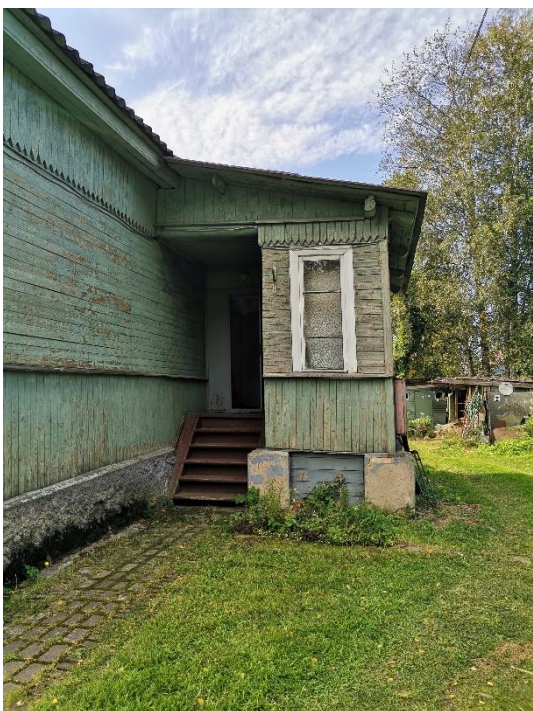
18. «В этом доме в 1941-43 гг. находился штаб автомобилистов, осуществляющих автоперевозки через Ладожское озеро по «Дороге жизни». На доме установлена памятная доска», Ленинградская обл., Всеволожский район, д. Коккорево, д. 27. Северный фасад. Фрагмент. Фото 11.08.2021 г.
