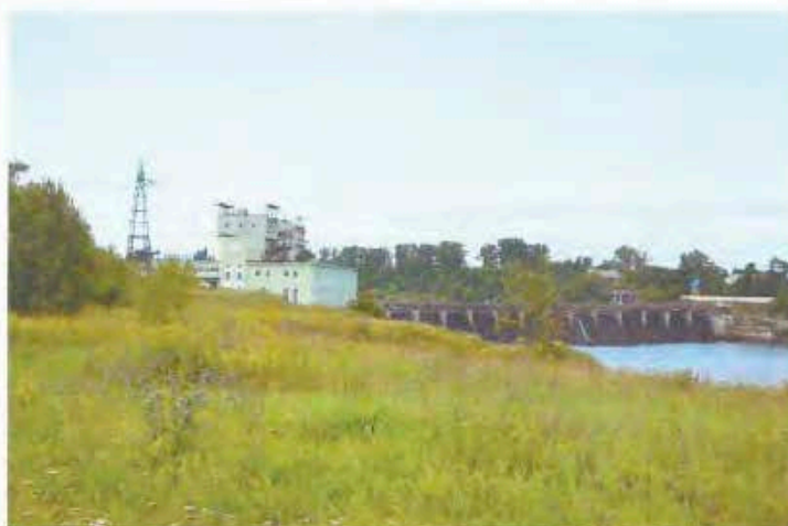
Фото 2. Ленинградская область, г. Волхов, Волховская ГЭС. Общий вид с северо-востока.
