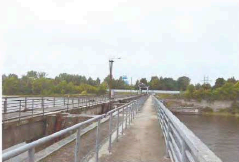
Фото 14. Ленинградская область, г. Волхов, Волховская ГЭС. Водосборная плотина. Вид с востока.
