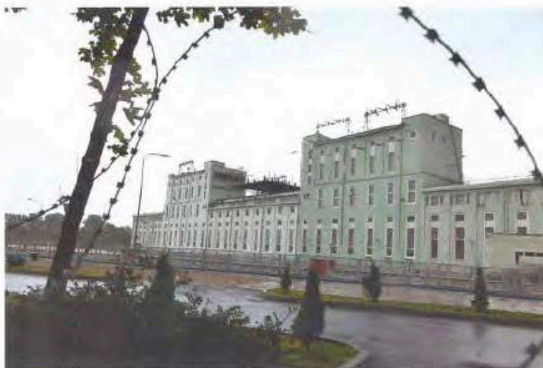
Фото 3. Ленинградская область, г. Волхов, Волховская ГЭС. Юго-западный фасад, вид с запада.
