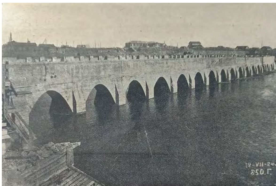
Илл. 14. Ледозащитная стенка, ограждающая аванкамеру от нанесения из реки льда и плавающих предметов. Вид 1924 год, до затопления. Retro View of Mankind's Habitat [Электронный ресурс]. Режим доступа: https://pastvu.com/ .
