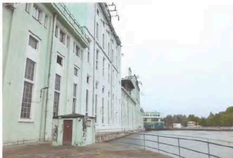
Фото 16. Ленинградская область, г. Волхов, Волховская ГЭС. Юго-восточный фасад. Вид с юга.
