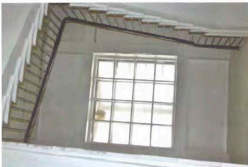
Фото 22. Ленинградская область, г. Волхов, Волховская ГЭС. Световой фонарь.
