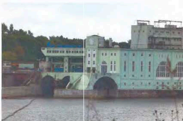
Фото 7. Ленинградская область, г. Волхов, Волховская ГЭС. Северо-восточный фасад. Вид с востока.
