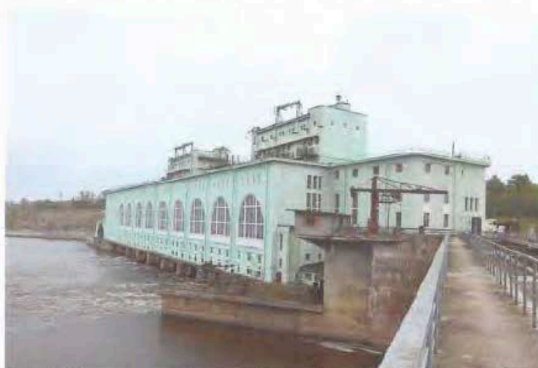
Фото 13. Ленинградская область, г. Волхов, Волховская ГЭС. Юго-западный фасад. Вид с плотины.
