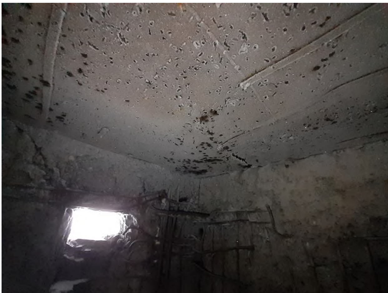
4. Вид на подорванную амбразуру изнутри
