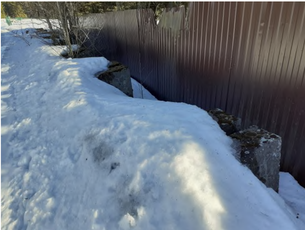
3. Вид на надолбы южнее дороги.
