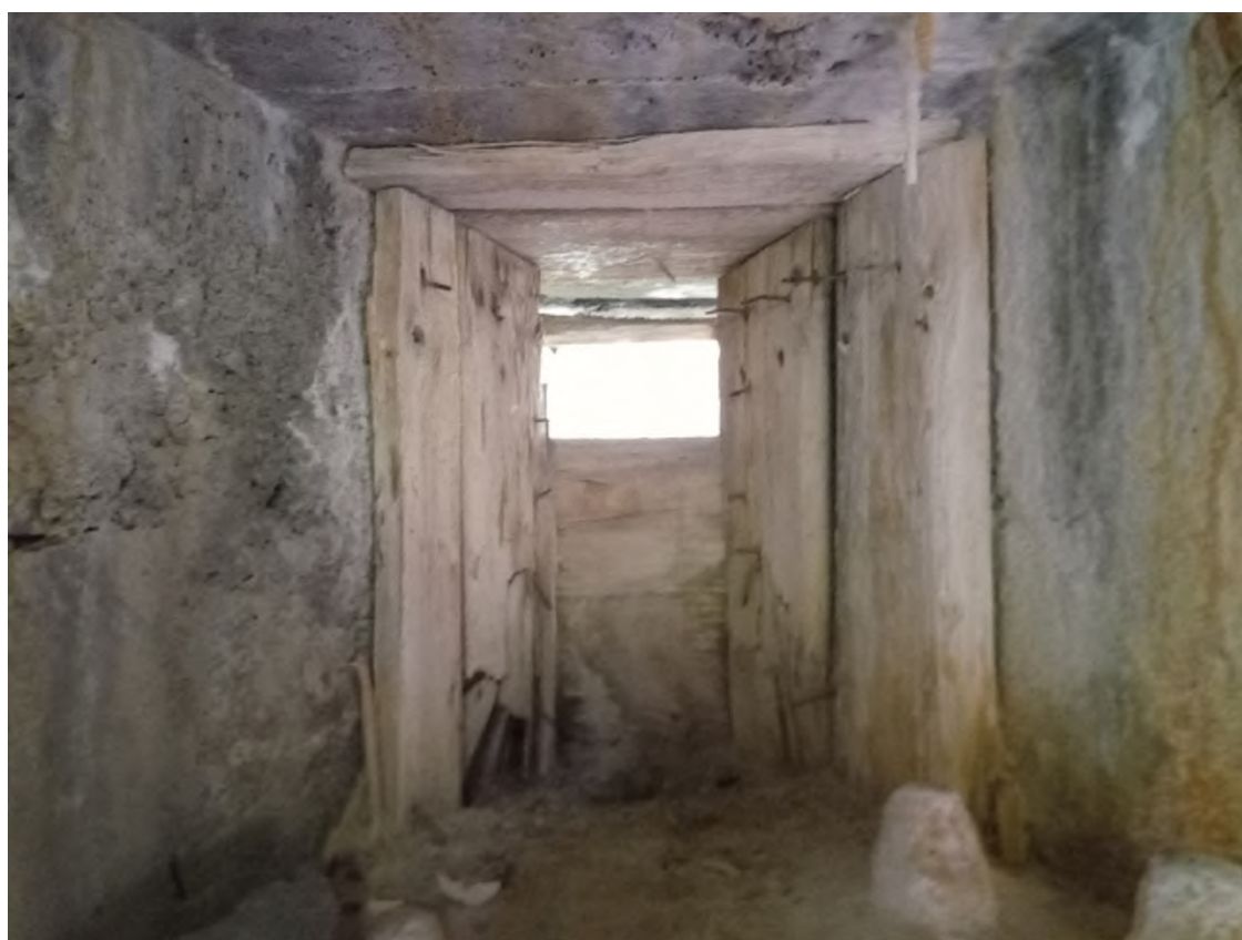
Сохранившаяся деревянная опалубка на амбразуре для ручного пулемёта капонира №28 на два пулемёта, укрепленный район Мьялкёля.
