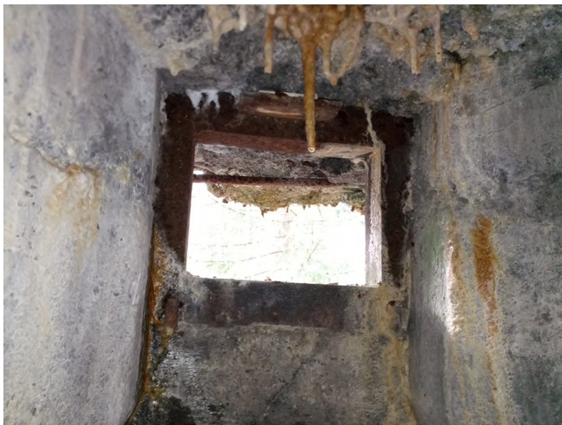
Амбразура для ручного пулемёта с сохранившейся рамкой бронезаслонки, недостроенное типовое убежище №51, укреплённый район Мьякёля.
