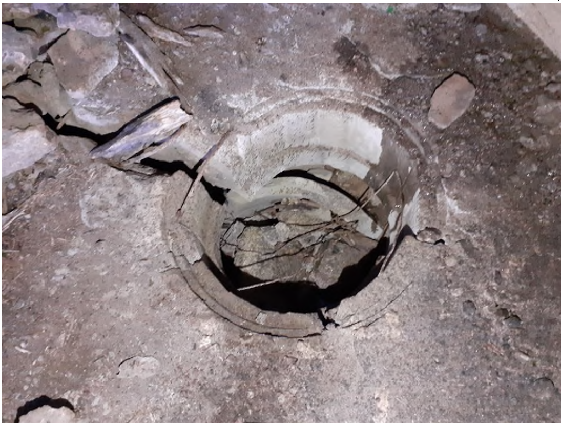
5. Дренажный колодец в главной галерее ДОТ
