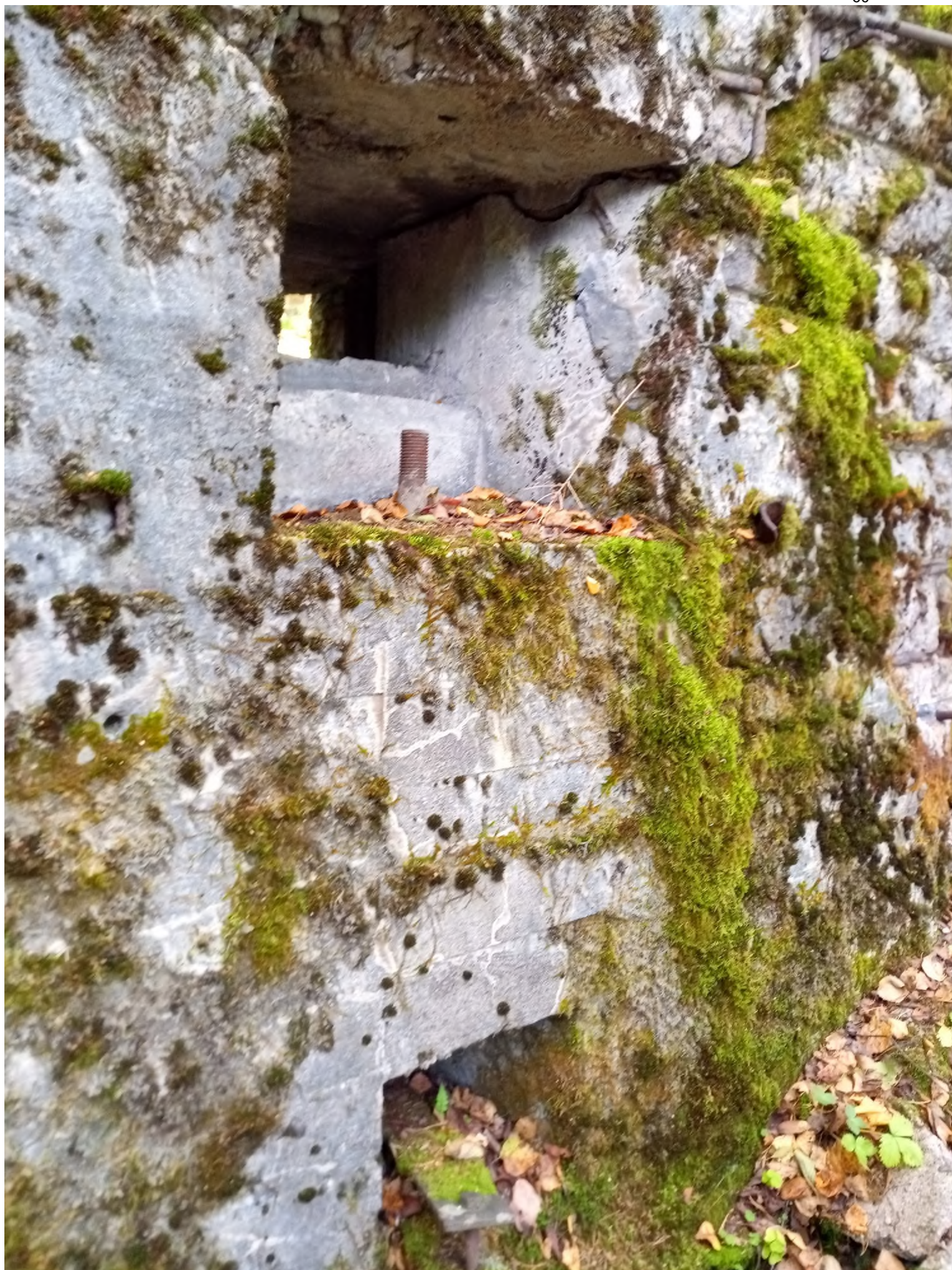
Сохранившаяся амбразура для пулемёта «Максим» с креплением для временного станка образца 1939 года капонира на два пулемёта №21, укреплённый район Мьякёля. Вид изнутри.
