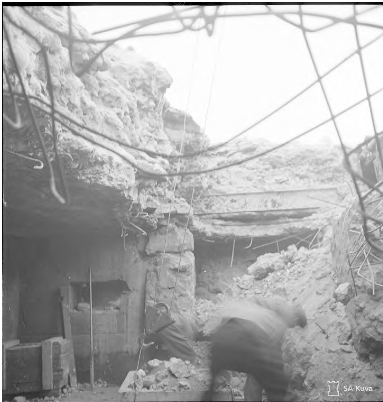
Рисунок 33. Разборка погреба для снарядов, батарея Ярисевя, 1942 год. Видно очень слабое армирование сооружения.
