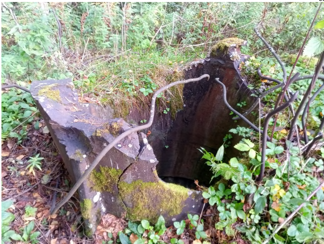
Фрагменты бронекупола на полукапонире на 1 пулемёт №10, укреплённый район Мялкёля. Скорее всего, бронекупол был демонтирован и вывезен в металлолом вандалами в период самоизоляции в 2020 году.
