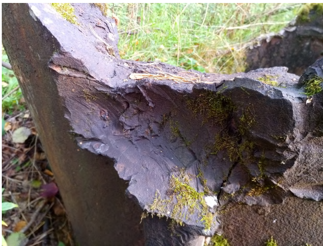
Вид на след от попадания тяжёлого снаряда в бронекупол на полукапонире на 1 пулемёт №10, укреплённый район Мялкёля.
