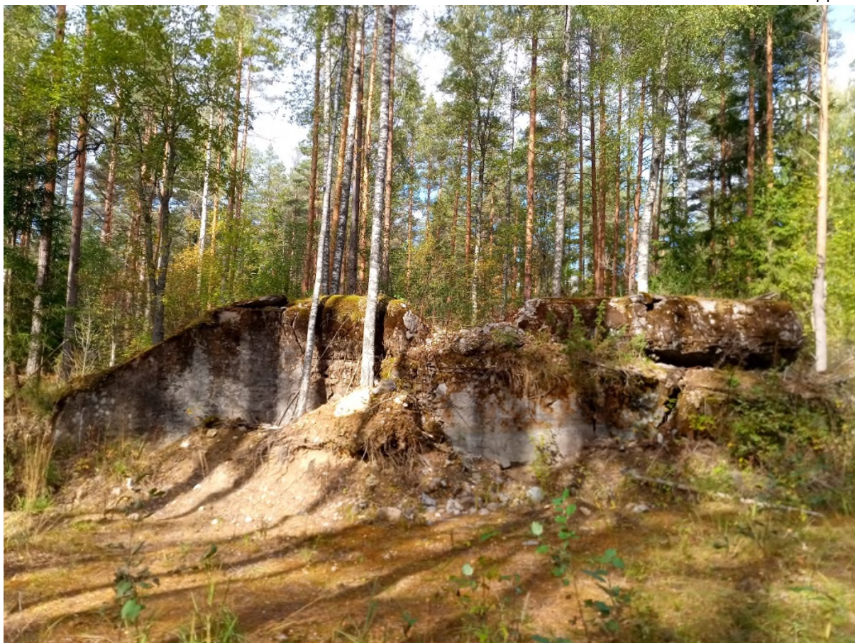
Общий вид полукапонира №26 на один пулемёт. Каменная подушка пущена на ограду близлежащего коттеджа.
