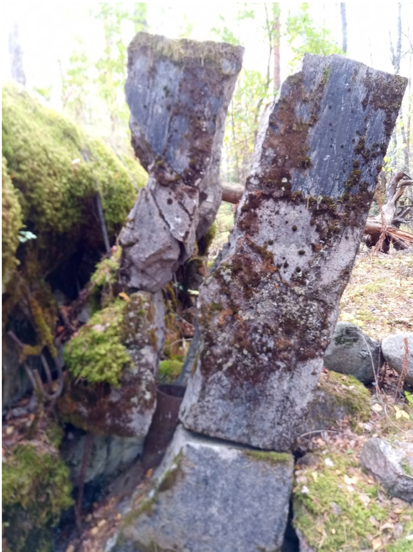
Расколота взрывом труба дымохода полукапонира на один пулемёт №25 укрепрайона Мьялкёля
