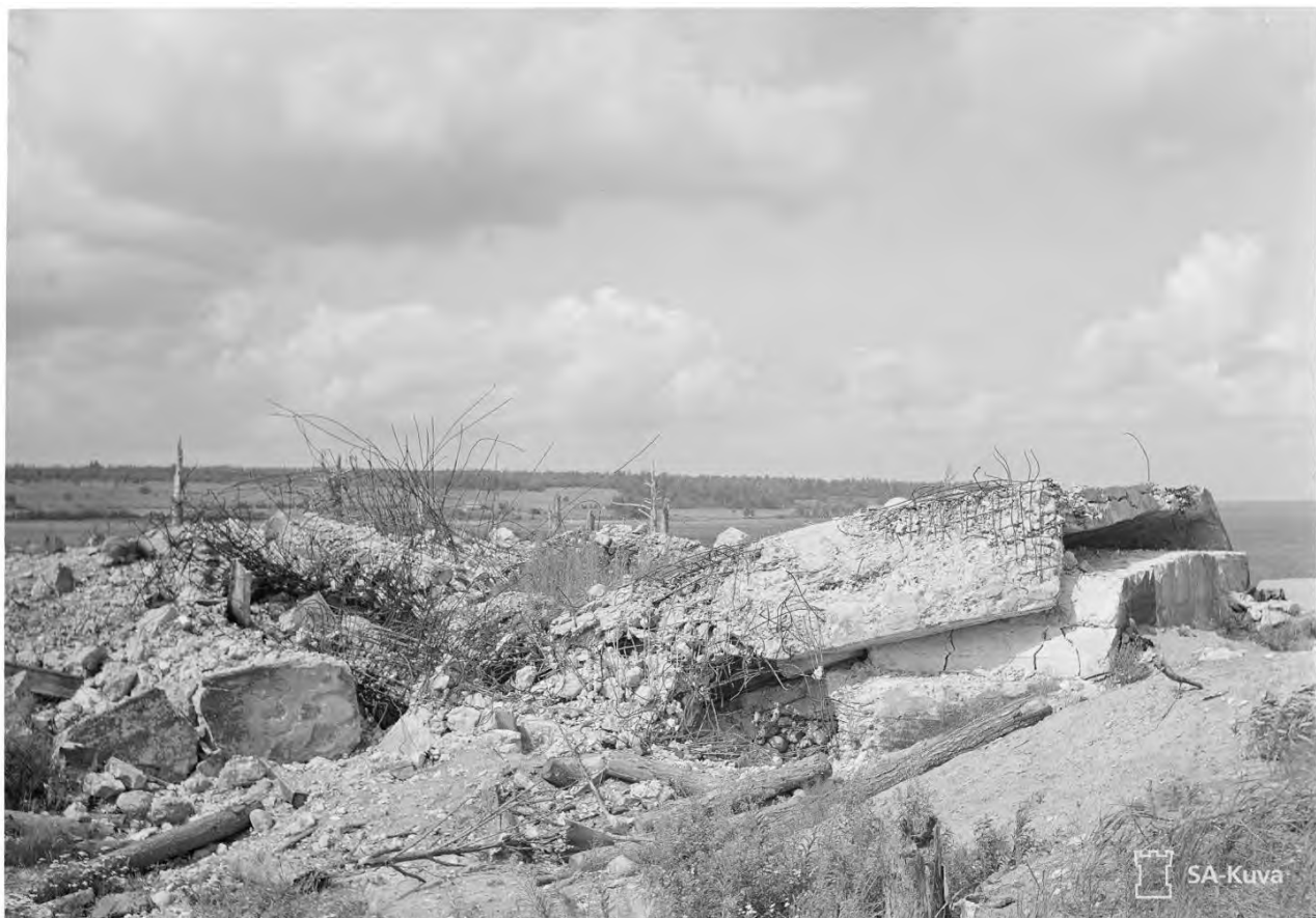
Рисунок 10. Подорванный форт Кивиниеми, 1942 год. Хорошо видна арматура.
