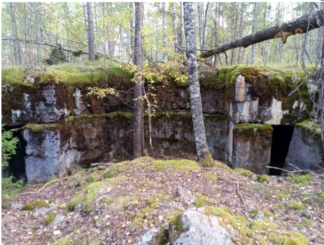
Типовое убежище №30, укрепленный район Мьякеля. Вид со стороны входа.
