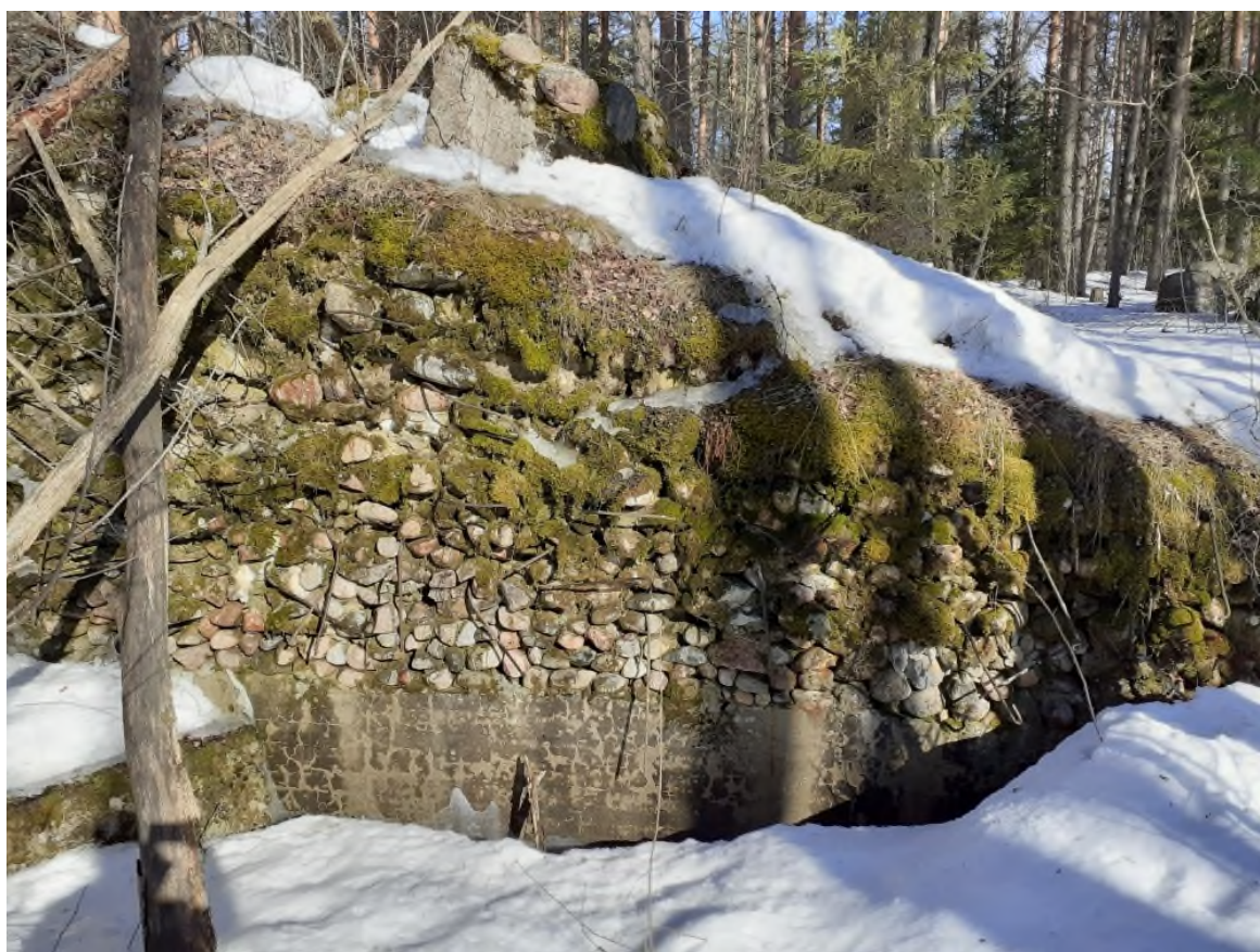
2. Вид на армированную стену-крыло, выложенную камнями
