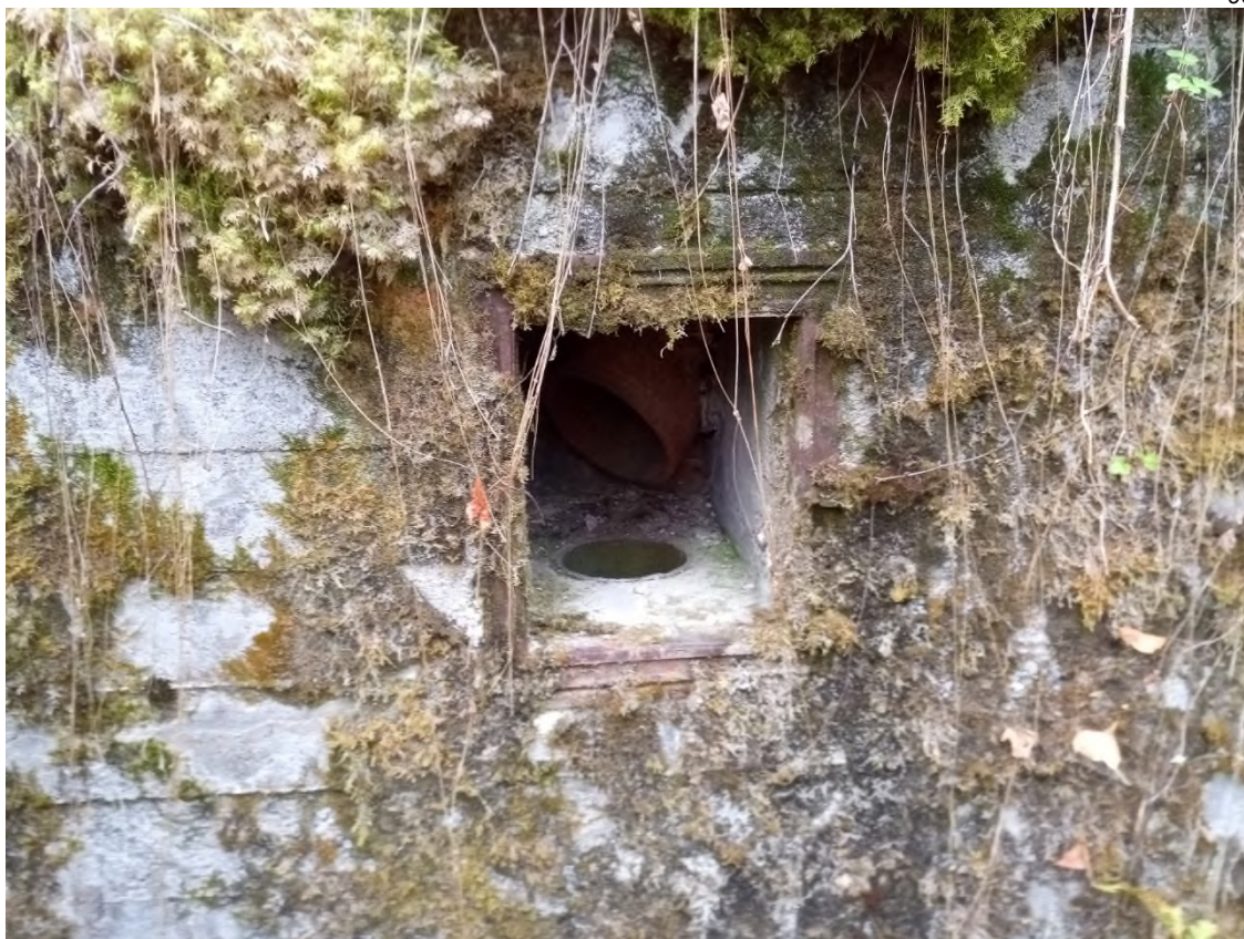
Система дымоходов, недостроенное типовое убежище №51, укрепленный район Мьякеля.
