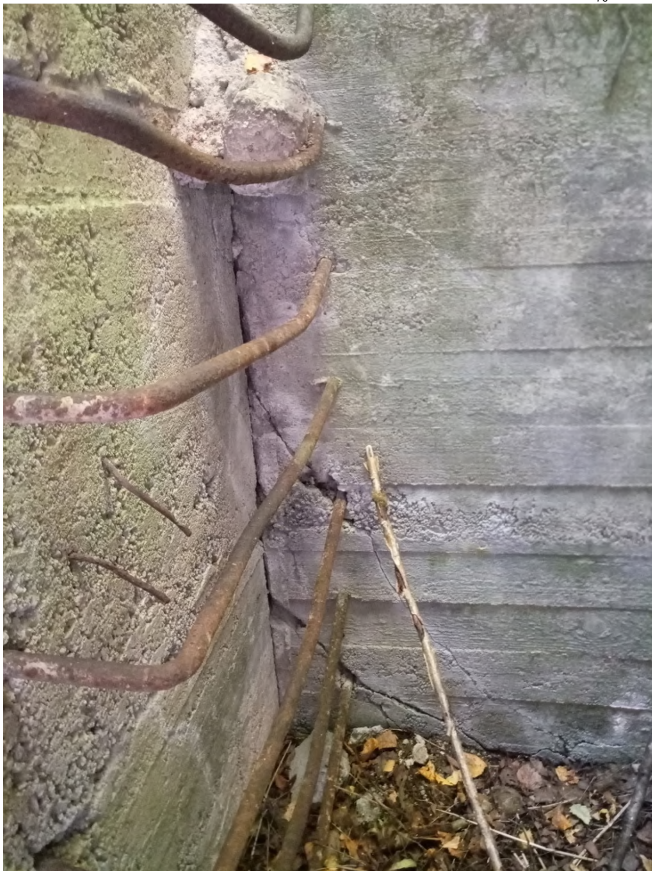
Сохранившаяся лестница в шахту бронекупола капонира №28 на два пулемёта, укреплённый район Мьякёля.
