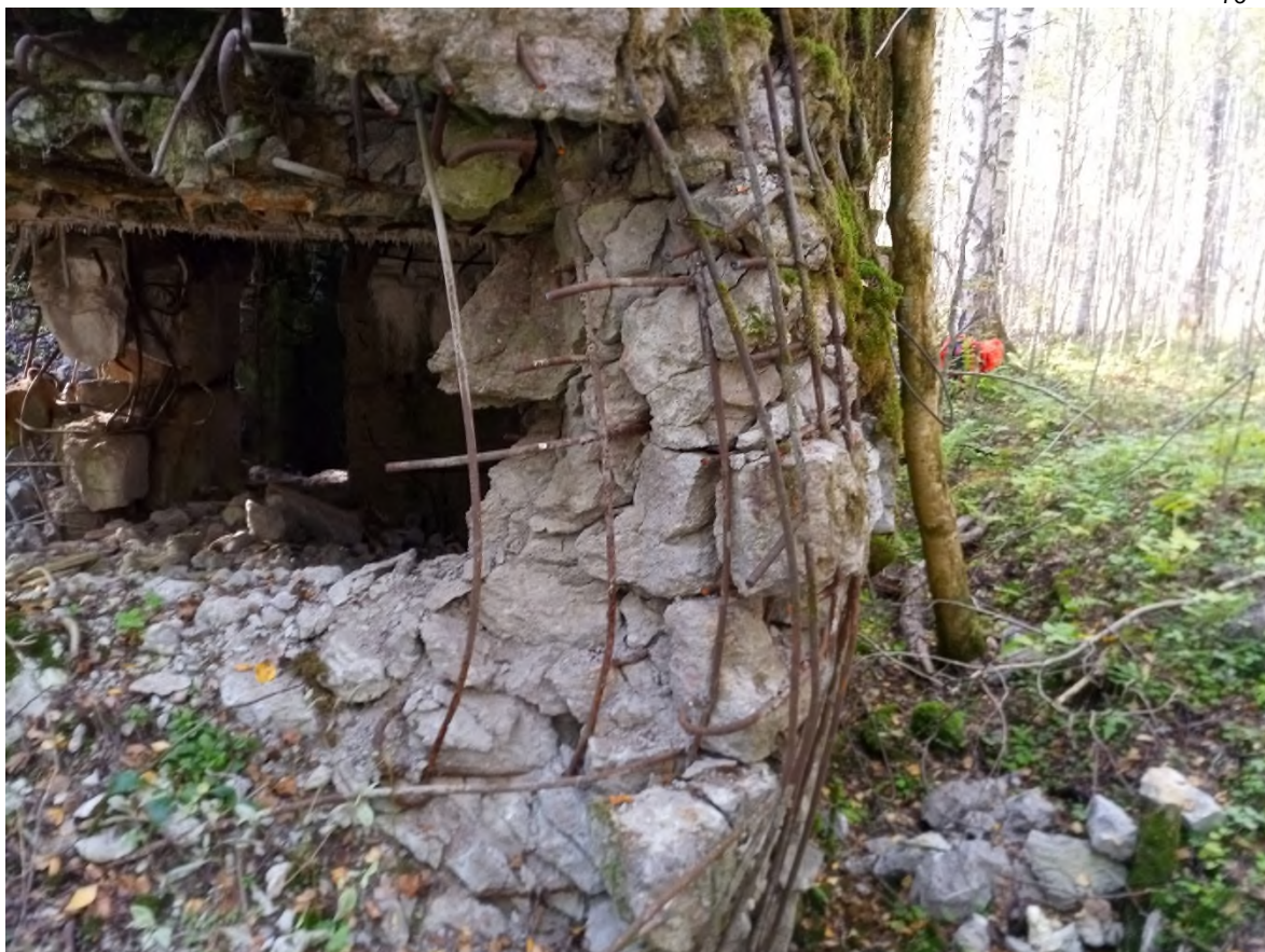
Подорванная стена капонира №28 на два пулемёта, укреплённый район Мьялкёля. Арматура была срезана вандалами в 2020 году в период самоизоляции.
