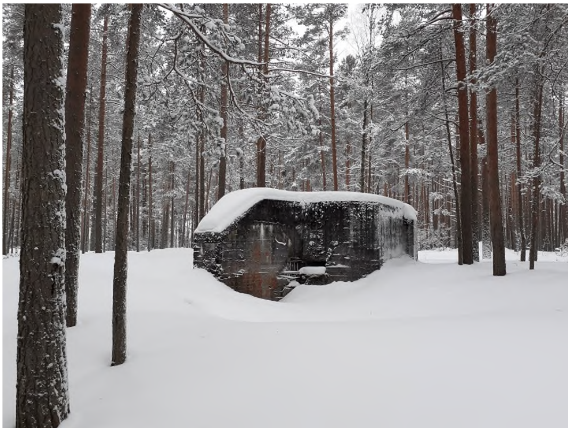
1. Общий вид на сооружение со стороны амбразуры
