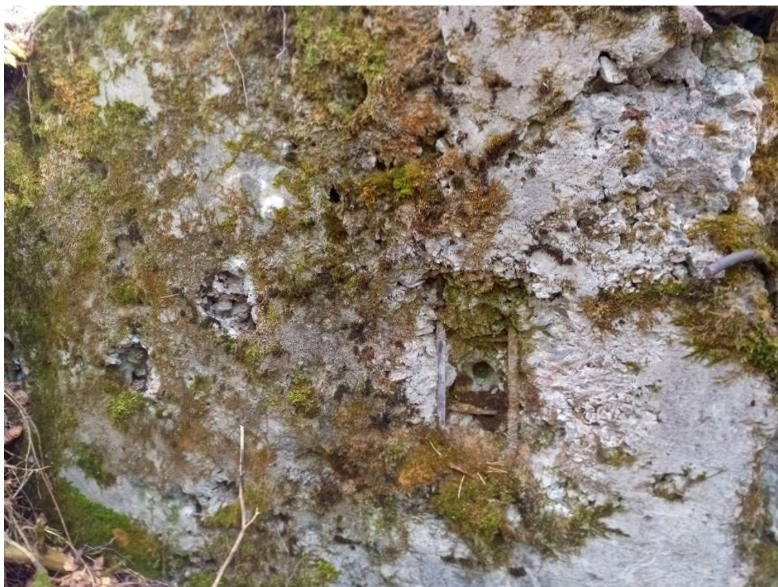
След попадания танкового снаряда и некачественная отливка бетона на стене полукапонира на один пулемёт №14 укрепрайона Мялкёля
