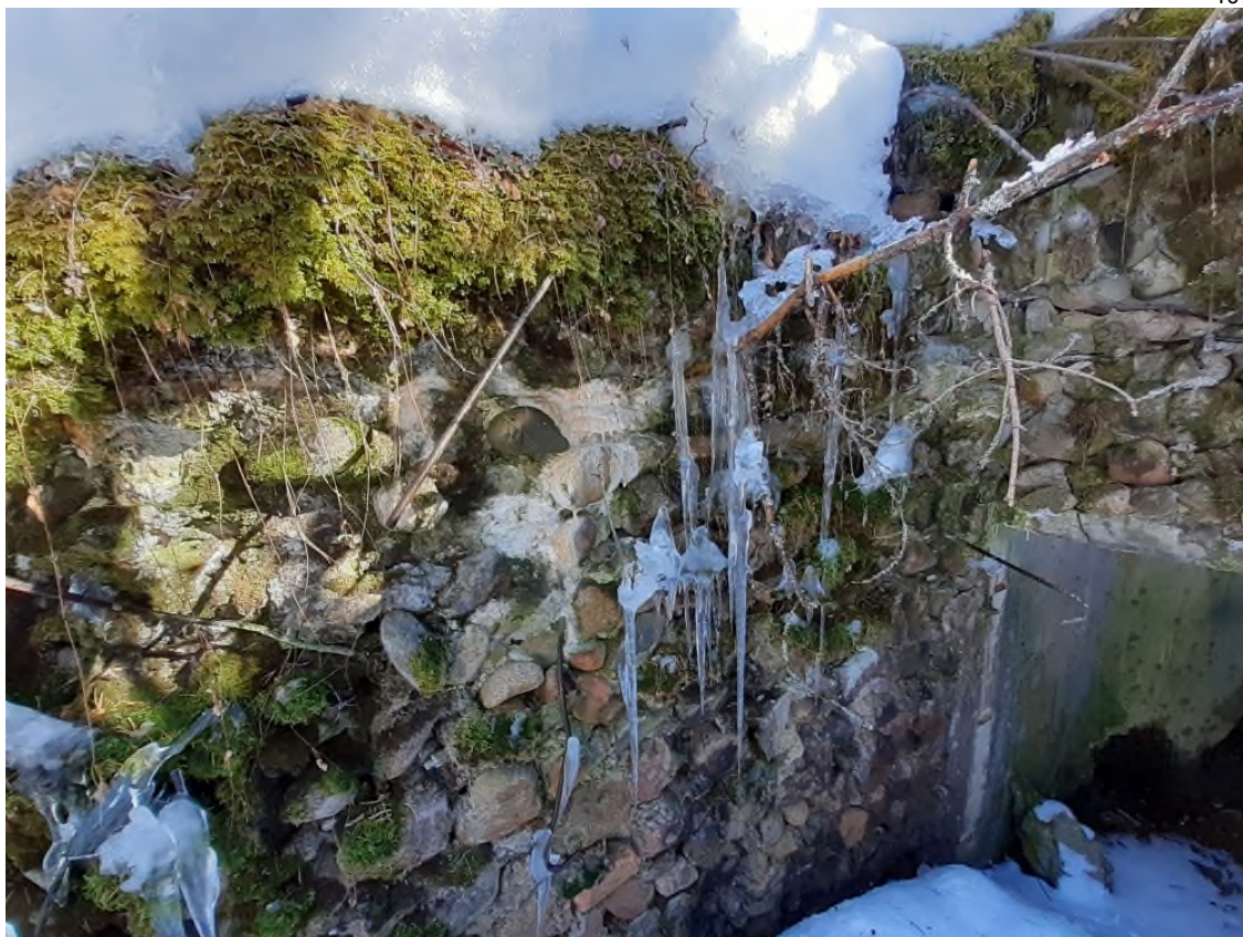
3. Армированная стена, выложенная камнями, при входе в главную галерею ДОТ
