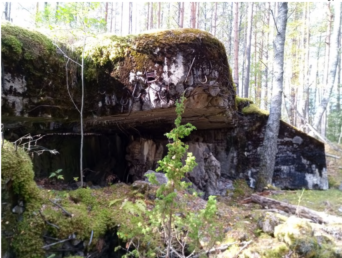
Общий вид полукапонира на один пулемёт №25 укрепрайона Мьялкёля были демонтированы и вывезены вандалами в период самоизоляции в 2020 году.
