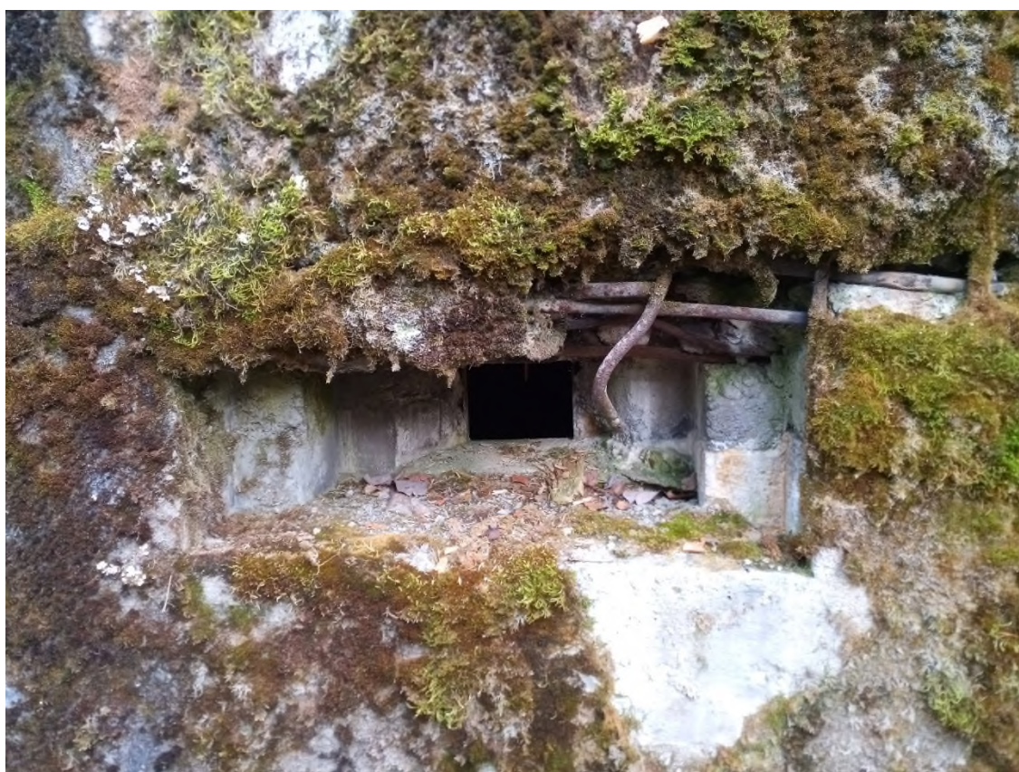
Амбразура под ручной пулемет, типовое убежище №30, укрепленный район Мьякеля. Вид снаружи.
