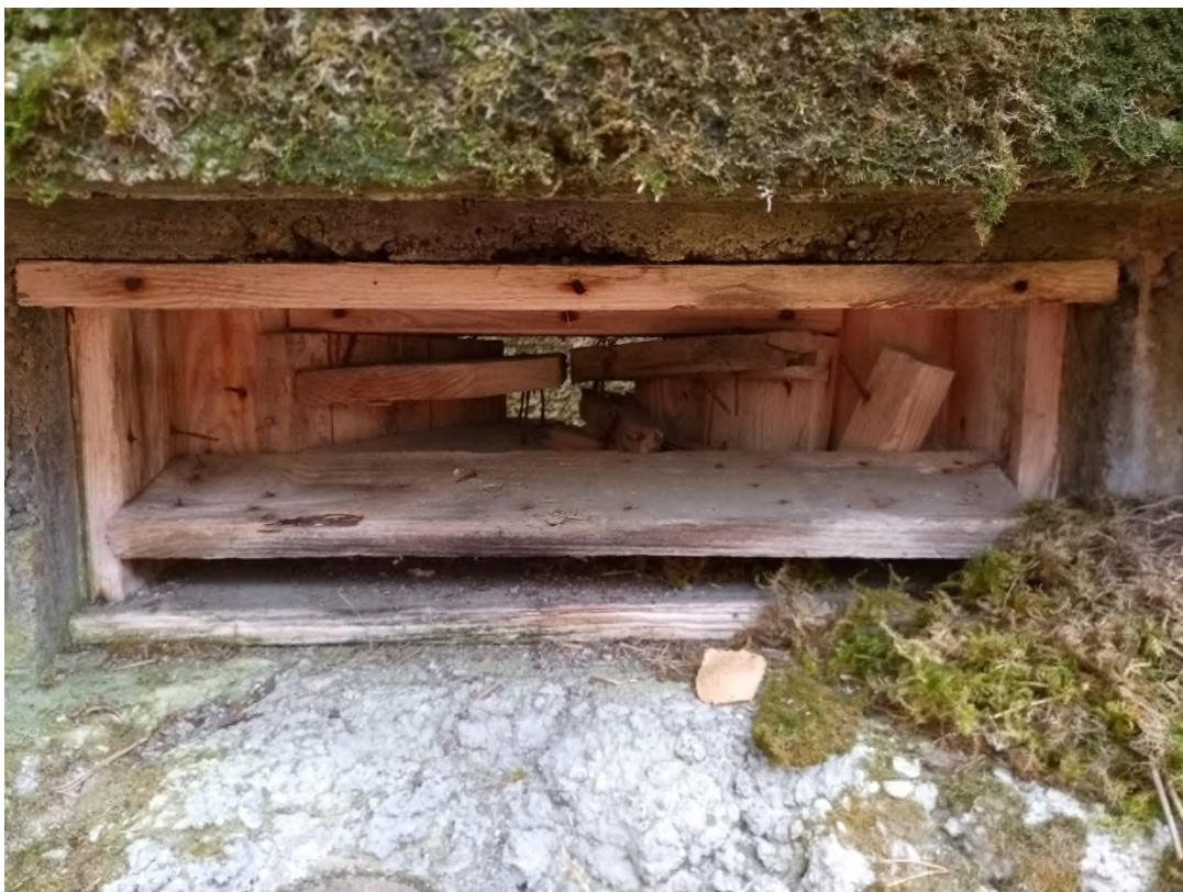
Сохранившаяся опалубка отливки амбразуры под ручной пулемет, недостроенное типовое убежище №51, укрепленный район Мялкёля. Вид снаружи.
