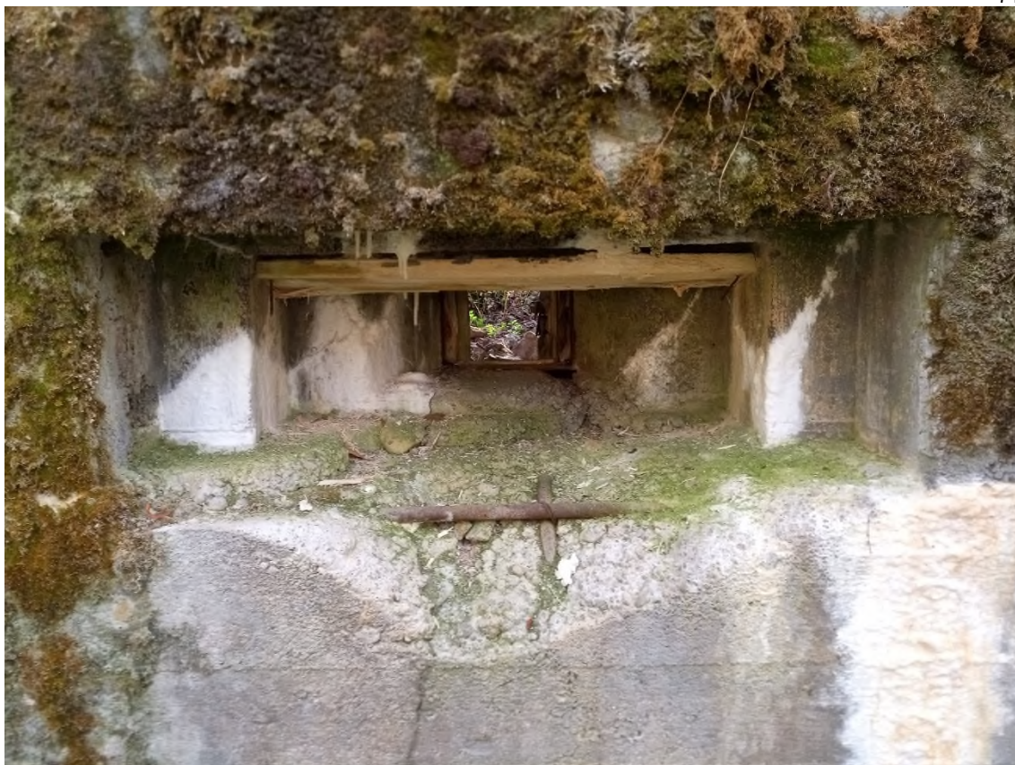
Сохранившаяся амбразура с опалубкой, капонир №28 на два пулемёта, укреплённый район Мьякёля.
