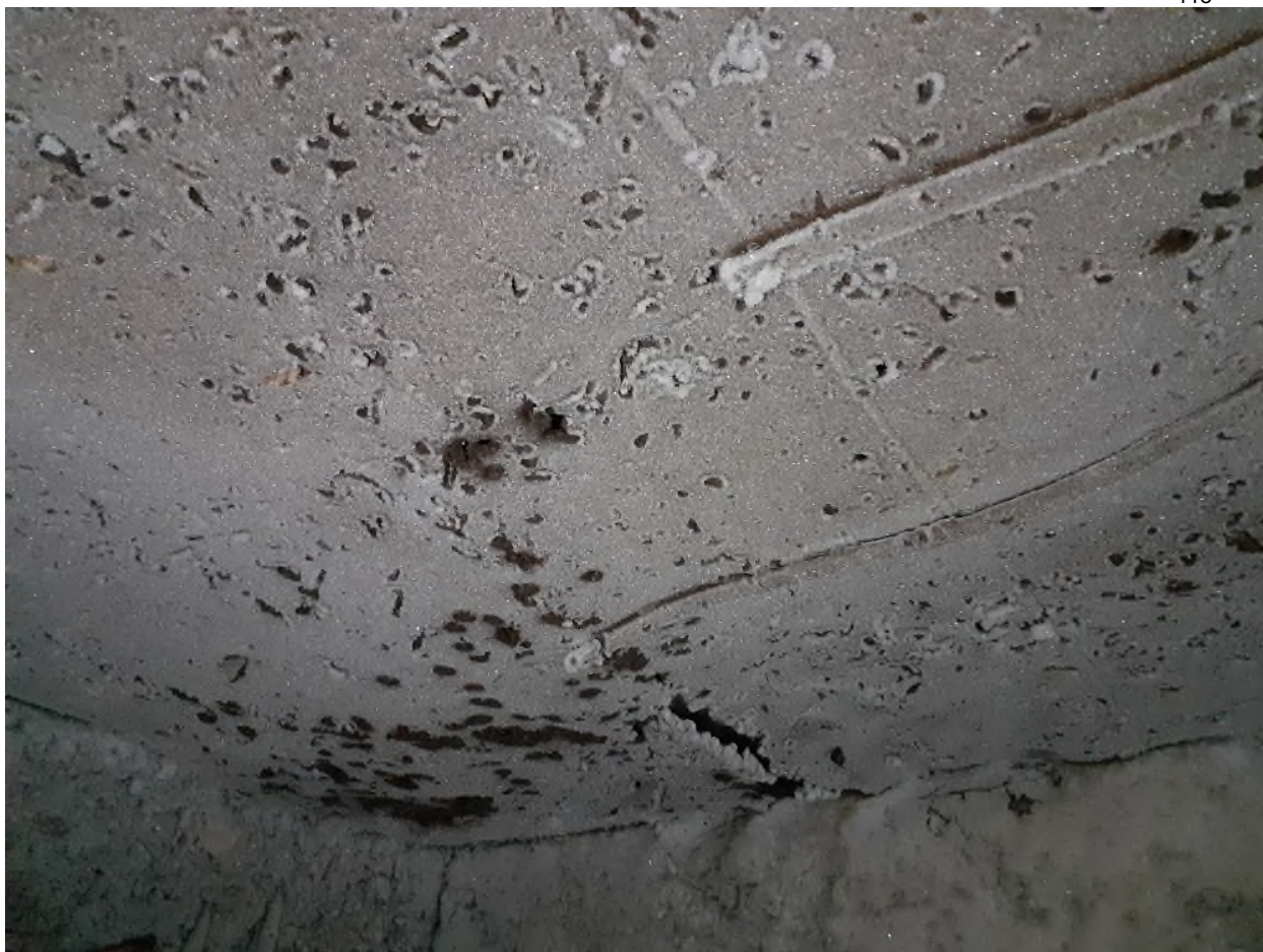
3. Сохранившийся стальной подбой на потолке сооружения
