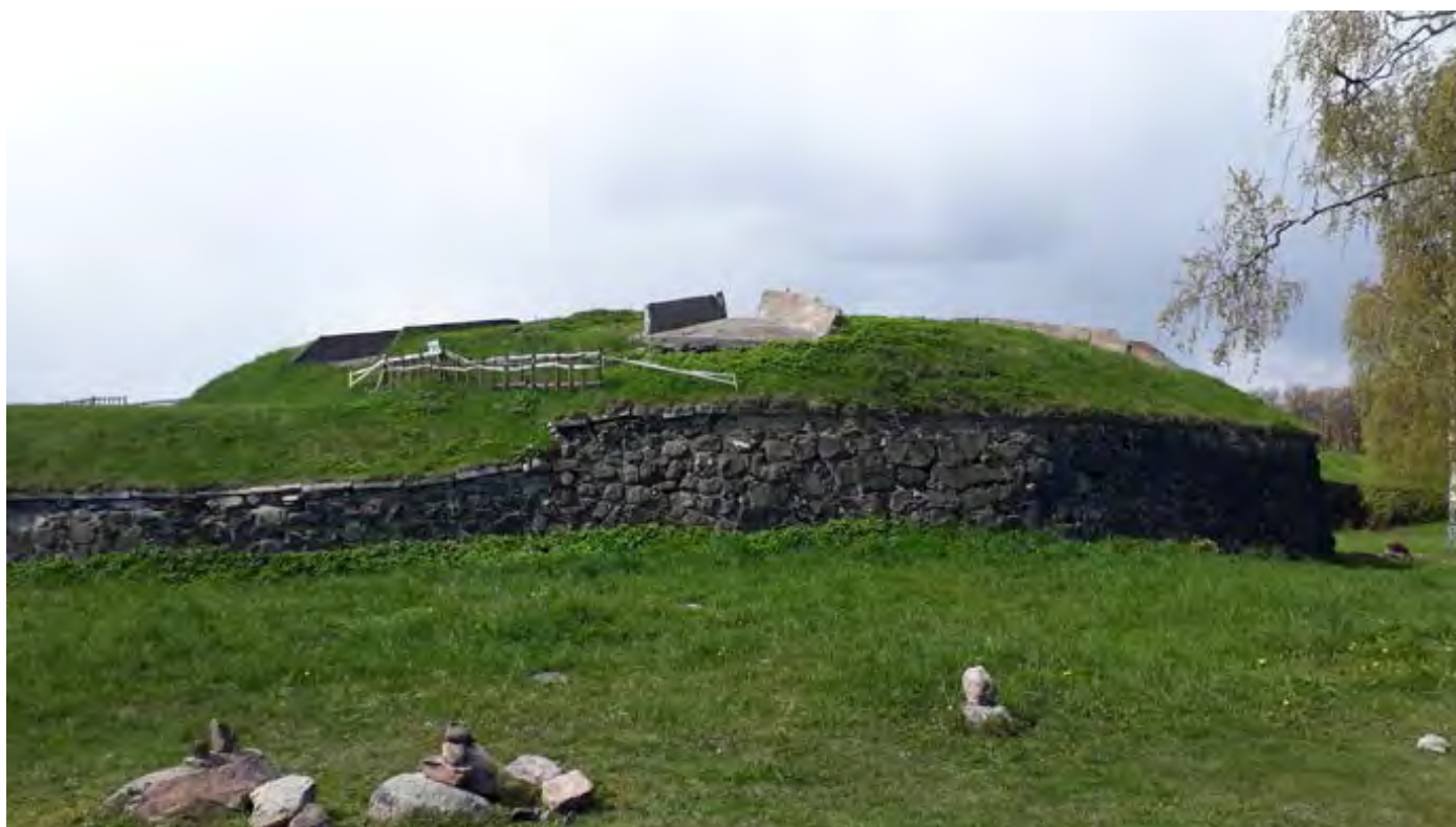
Фото 4.10. Объект культурного наследия федерального значения Крепость "Корела", XIV-XVIII вв., входящий в состав объект культурного наследия федерального значения "Комплекс крепостных сооружений" XIV-XVIII вв.
