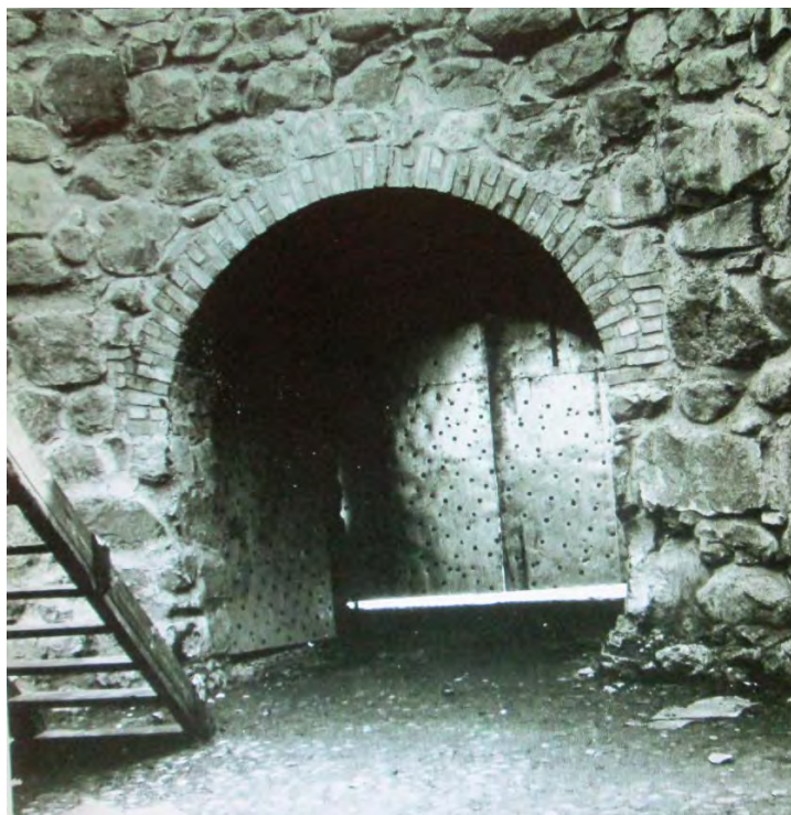
95. Круглая башня. Воротный проем восточного фасада. Министерство Культуры РСФСР. Трест «Росреставрация». Ленинградская Областная СНРПМ. Материалы исследований. Фотофиксация. Крепость Корела. Круглая башня в г. Приозерск. Т.Ш. Ленинград. 1977г.
