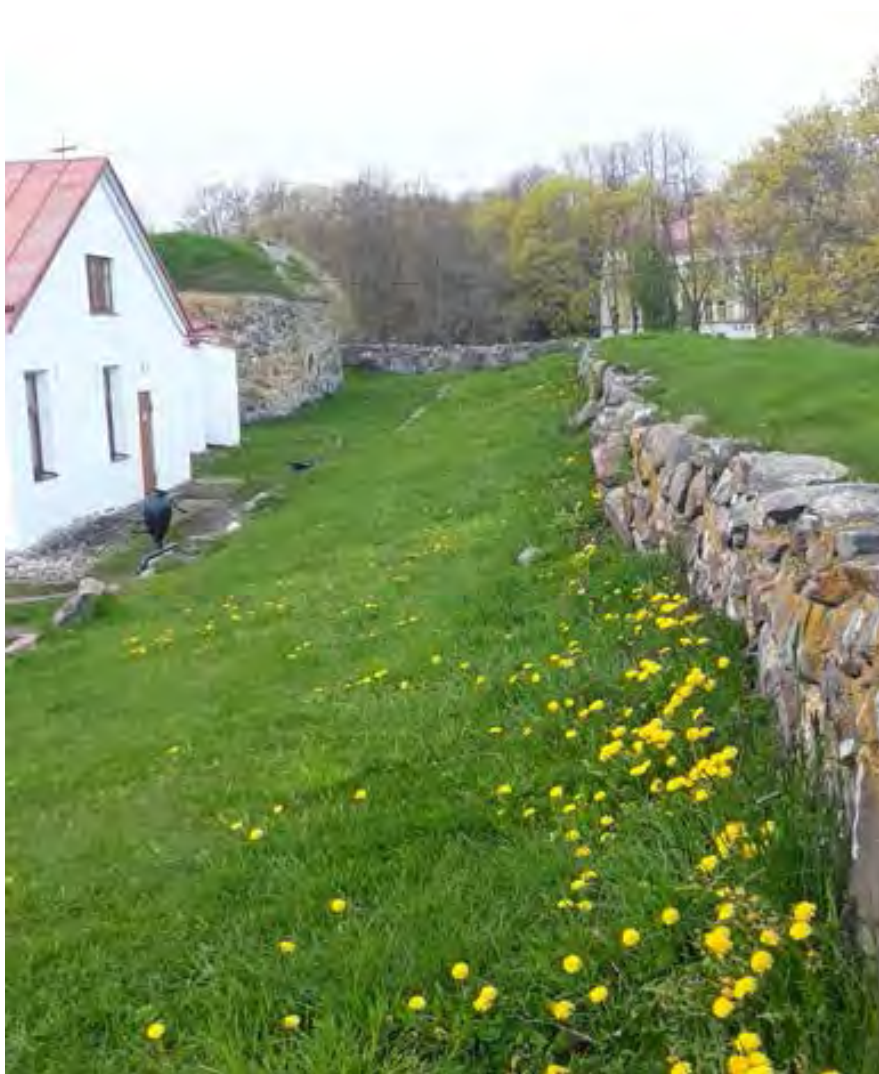
Фото 9.8. Объект культурного наследия федерального значения Крепость "Корела", XIV-XVIII вв., входящий в состав объект культурного наследия федерального значения "Комплекс крепостных сооружений" XIV-XVIII вв.
