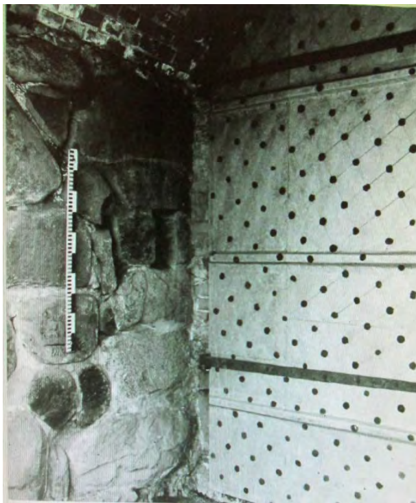
93. Круглая башня. Ниша для запорного бруса ворот. Восточный фасад, правая сторона. Министерство Культуры РСФСР. Трест «Росреставрация». Ленинградская Областная СНРПМ. Материалы исследований. Фотофиксация. Крепость Корела. Круглая башня в г. Приозерск. Т.Ш. Ленинград. 1977г.
