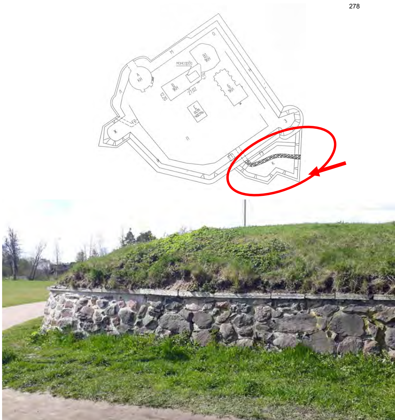
Фото 13.7. Объект культурного наследия федерального значения Крепость "Корела", XIV-XVIII вв., входящий в состав объект культурного наследия федерального значения "Комплекс крепостных сооружений" XIV-XVIII вв.
