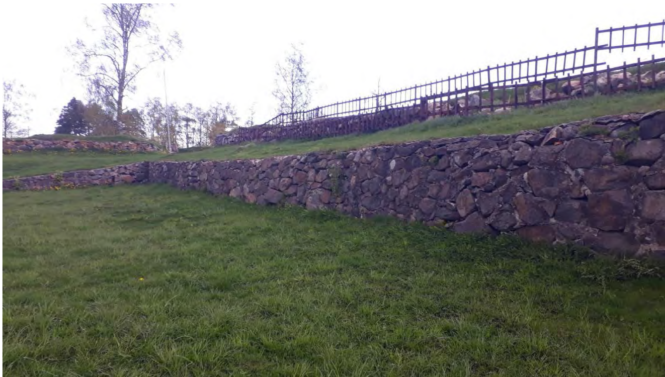
Фото 3.3. Объект культурного наследия федерального значения Крепость "Корела", XIV-XVIII вв., входящий в состав объект культурного наследия федерального значения "Комплекс крепостных сооружений" XIV-XVIII вв.
