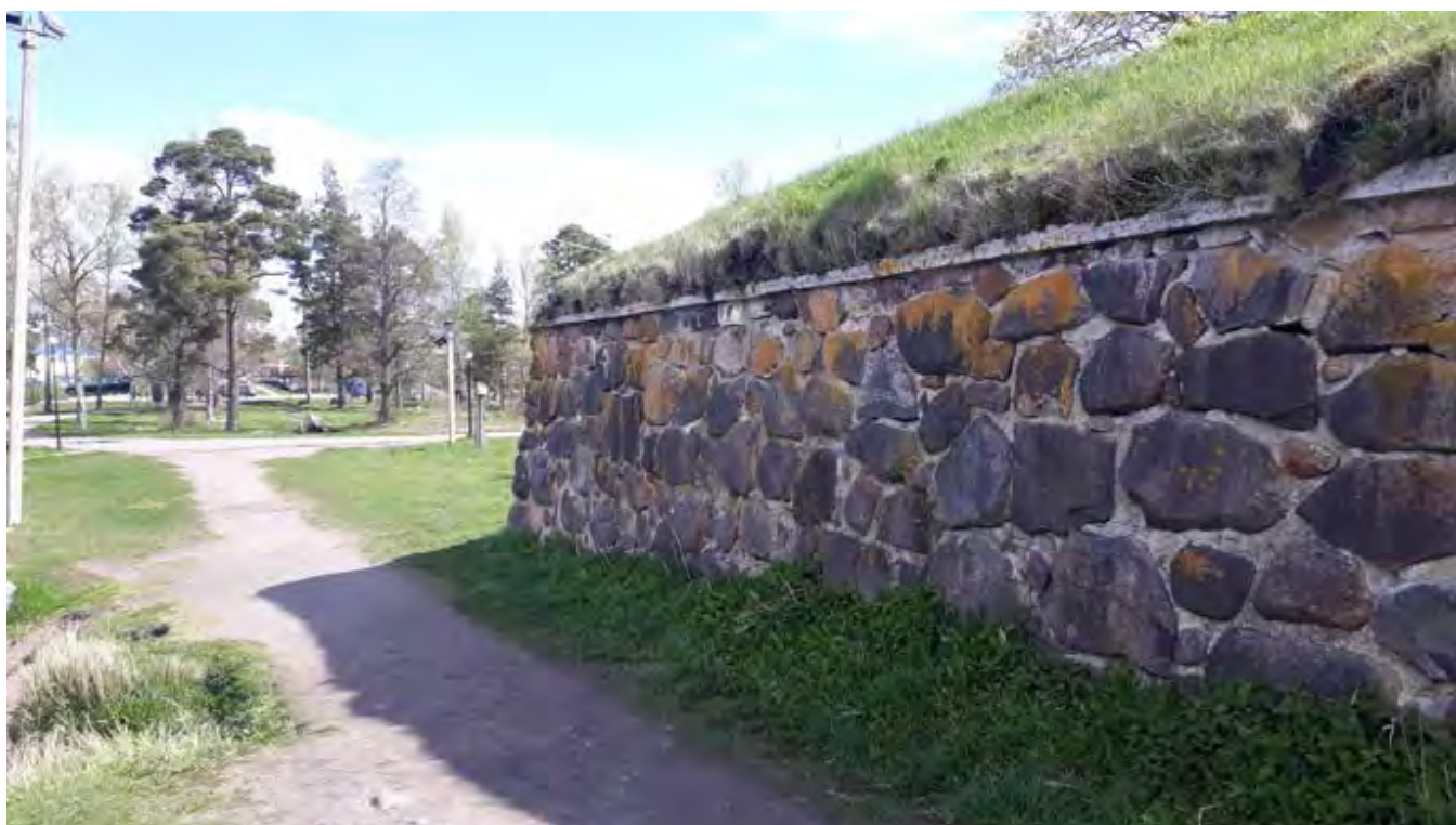
Фото 10.6. Объект культурного наследия федерального значения Крепость "Корела", XIV-XVIII вв., входящий в состав объект культурного наследия федерального значения "Комплекс крепостных сооружений" XIV-XVIII вв.
