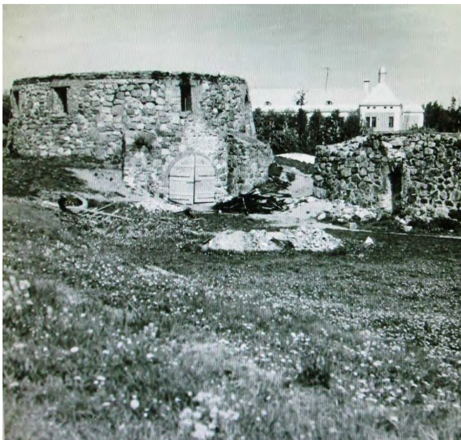
88. Круглая башня. Вид с юго-востока. Министерство Культуры РСФСР. Трест «Росреставрация». Ленинградская Областная СНРПМ. Материалы исследований. Фотофиксация. Крепость Корела. Круглая башня в г. Приозерск. Т.Ш. Ленинград. 1977г.
