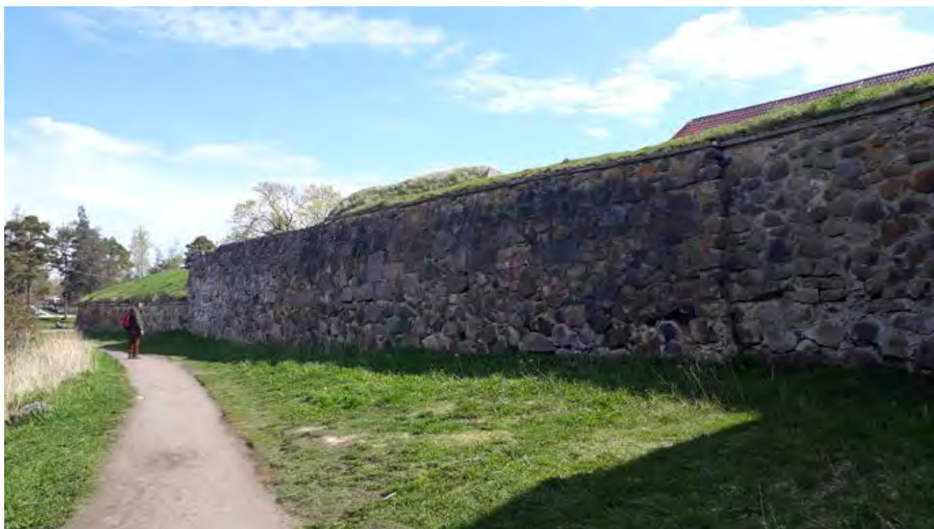
Фото 10.3. Объект культурного наследия федерального значения Крепость "Корела", XIV-XVIII вв., входящий в состав объект культурного наследия федерального значения "Комплекс крепостных сооружений" XIV-XVIII вв.
