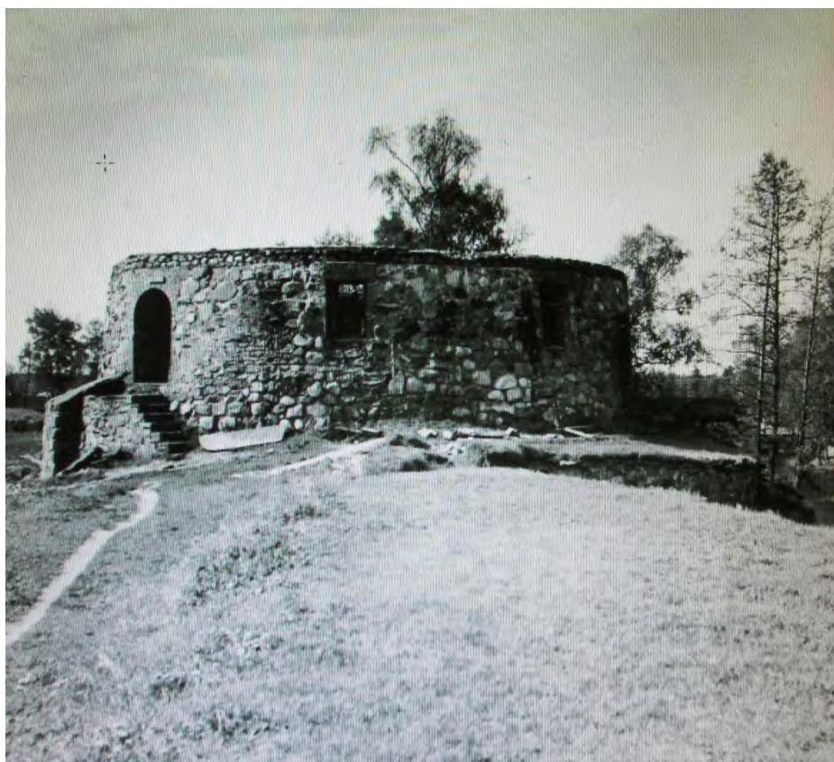
91. Круглая башня. Северный фасад. Министерство Культуры РСФСР. Трест «Росреставрация». Ленинградская Областная СНРПМ. Материалы исследований. Фотофиксация. Крепость Корела. Круглая башня в г. Приозерск. Т.Ш. Ленинград. 1977г.
