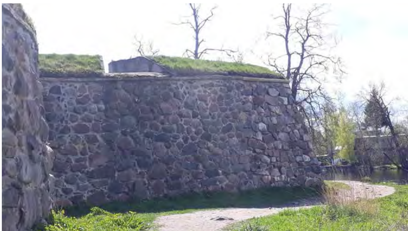
Фото 7.4. Объект культурного наследия федерального значения Крепость "Корела", XIV-XVIII вв., входящий в состав объект культурного наследия федерального значения "Комплекс крепостных сооружений" XIV-XVIII вв.
