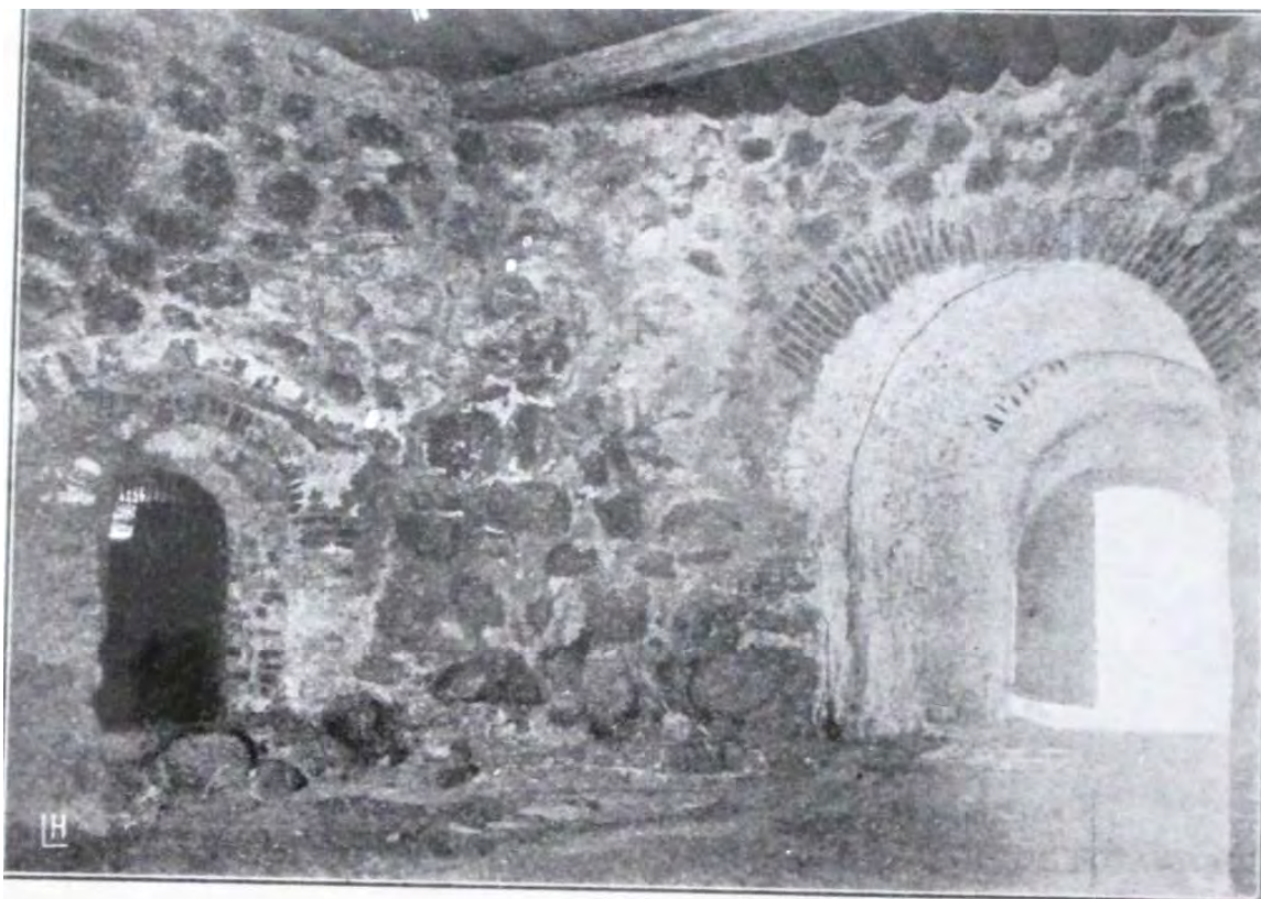
Kuv. 3. Porttihilvi pyöreän tornin sisältä ennen korjaamista.
