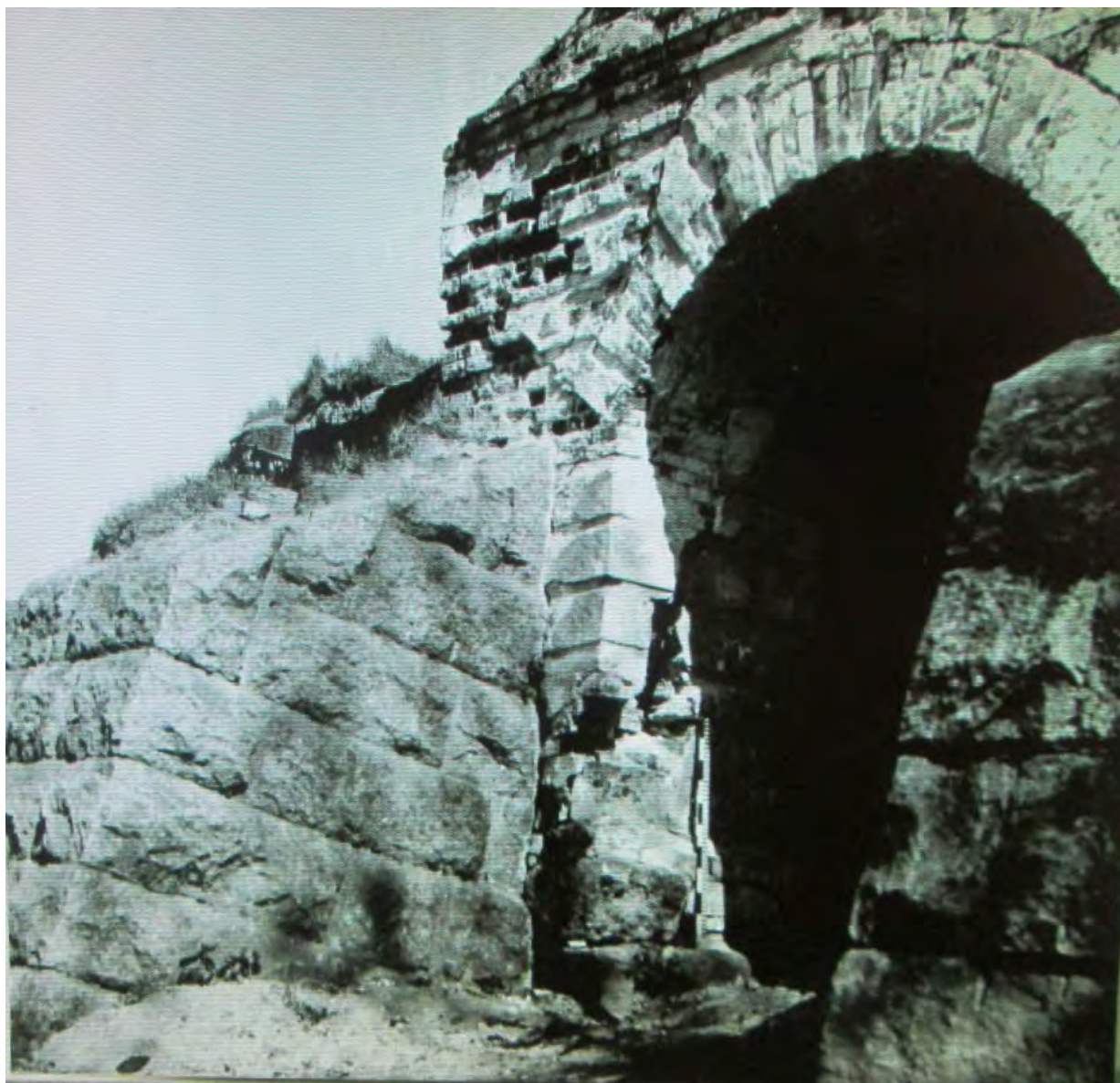
106. Круглая башня. Контрфорсы, пристроенные к portalу во время реставрации 1908г. Министерство Культуры РСФСР. Трест «Росреставрация». Ленинградская Областная СНРПМ. Материалы исследований. Фотофиксация. Крепость Корела. Круглая башня в г. Приозерск. Т.Ш. Ленинград. 1977г.
