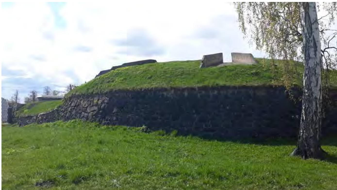
Фото 4.9. Объект культурного наследия федерального значения Крепость "Корела", XIV-XVIII вв., входящий в состав объект культурного наследия федерального значения "Комплекс крепостных сооружений" XIV-XVIII вв.
