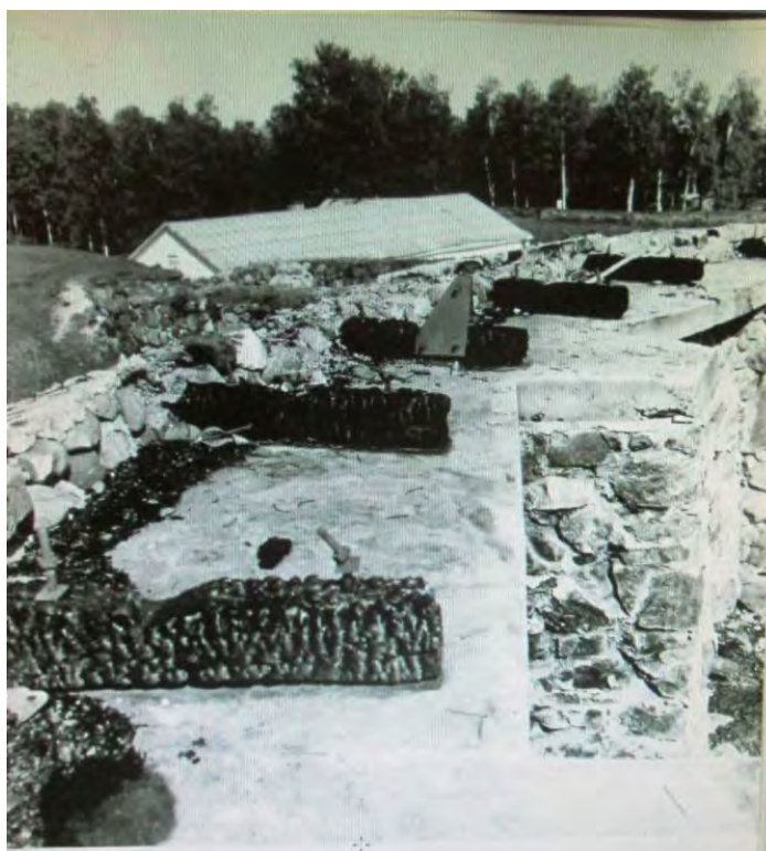
101. Круглая башня. Остатки конструкций шатра. Министерство Культуры РСФСР. Трест «Росреставрация». Ленинградская Областная СНРПМ. Материалы исследований. Фотофиксация. Крепость Корела. Круглая башня в г. Приозерск. Т.Ш. Ленинград. 1977г.
