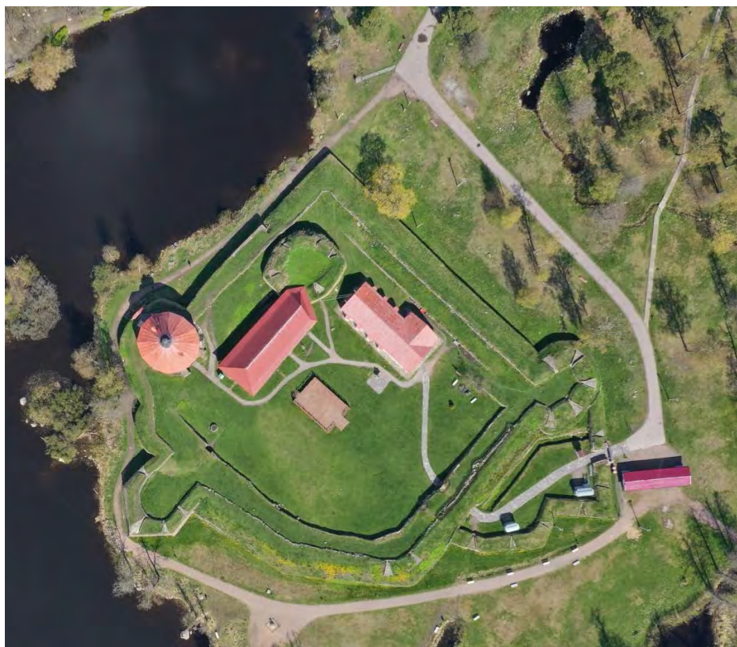
Фото 10.1. Объект культурного наследия федерального значения Крепость "Корела", XIV-XVIII вв., входящий в состав объект культурного наследия федерального значения "Комплекс крепостных сооружений" XIV-XVIII вв.
