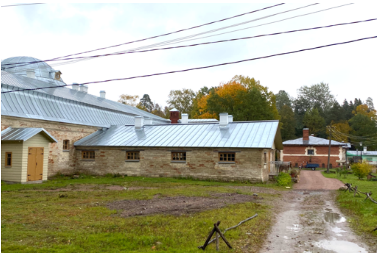
Рис 19. Фото 8. Вид на территорию объекта культурного наследия «Ферма».
