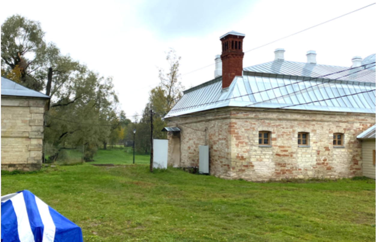
Рис 18. Фото 7. Вид на территорию объекта культурного наследия «Ферма». Место размещения ГРЩ на западной стене Главного здания Фермы.
