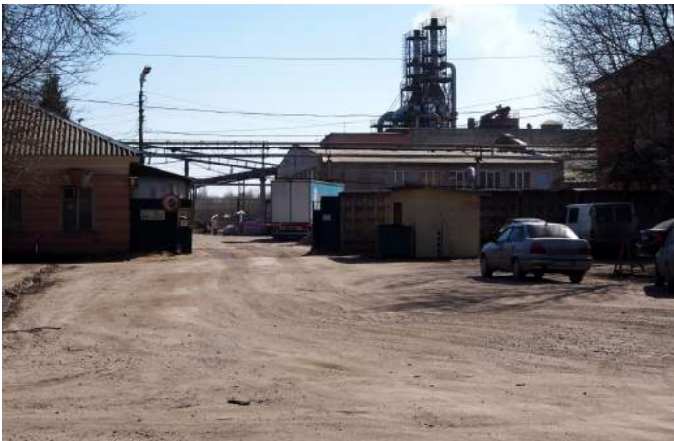
8. Промышленная застройка южной окраины г.п. Дубровка. Завод «Невский ламинат». Вид с севера.
