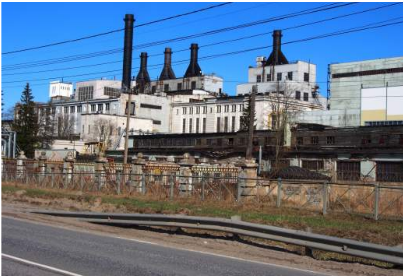
60. Дубровская ТЭЦ (бывшая ГРЭС-8). Вид с юго-запада, от Набережной улицы.
