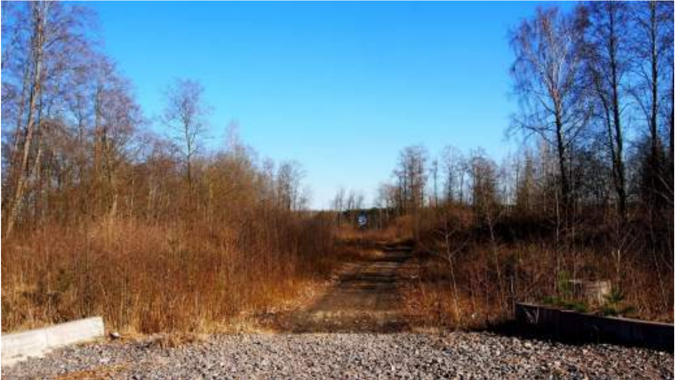
47. Дорога, ведущая от территории бывшей деревни Выборгская Дубровка к захоронениям и памятникам близ станции Теплобетонная. Вид с юго-запада.
