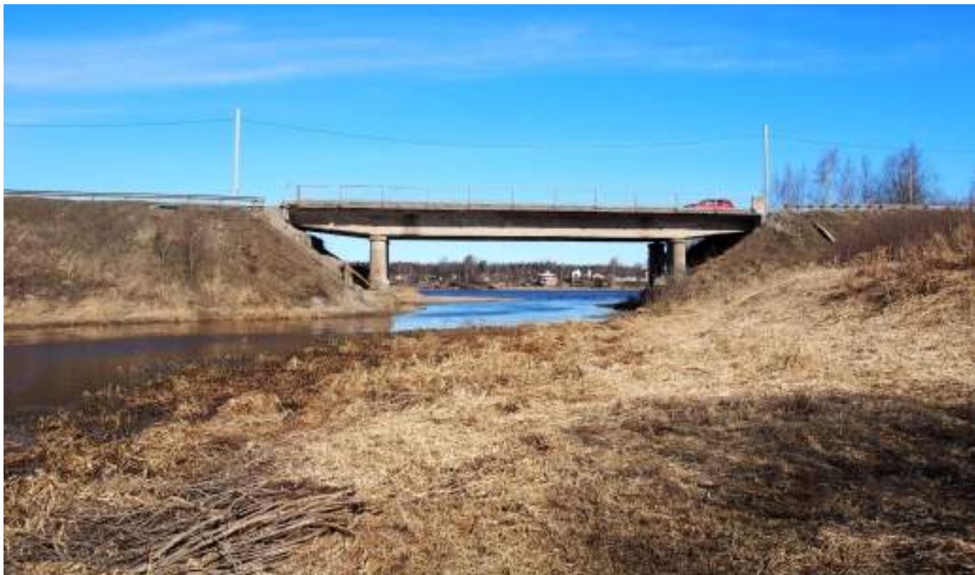
5. Мост через реку Мойку. Вид с юго-востока.
