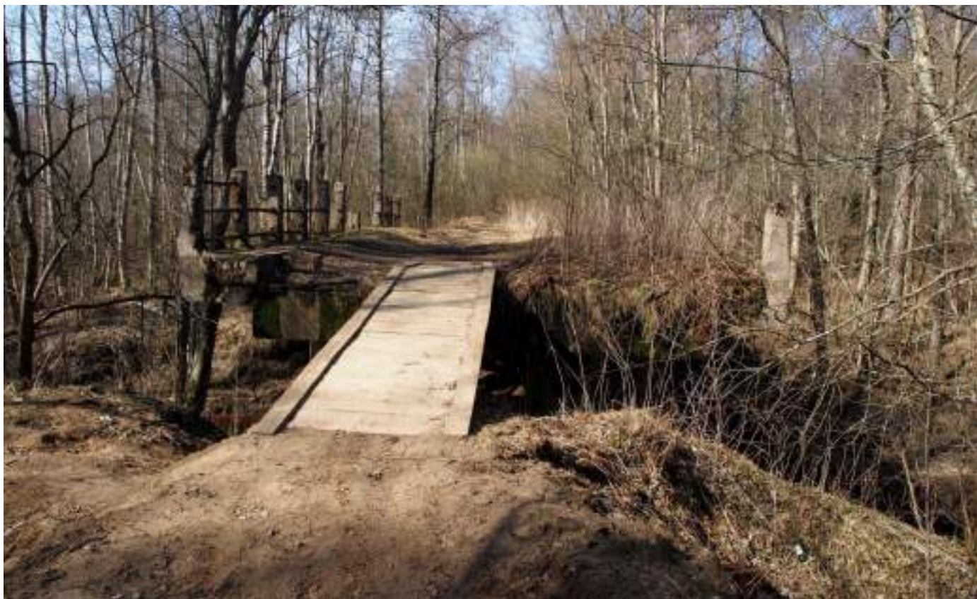
12. Бетонный мост через Тёткин ручей на бывшем Архангельском тракте. Вид с востока.
