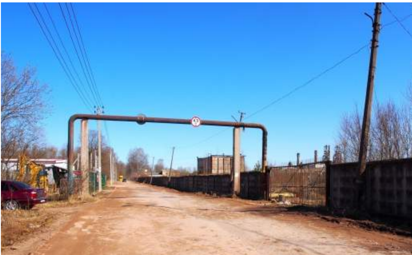
6. Промышленная застройка южной окраины г.п. Дубровка. Завод «Невский ламинат». Вид с запада.
