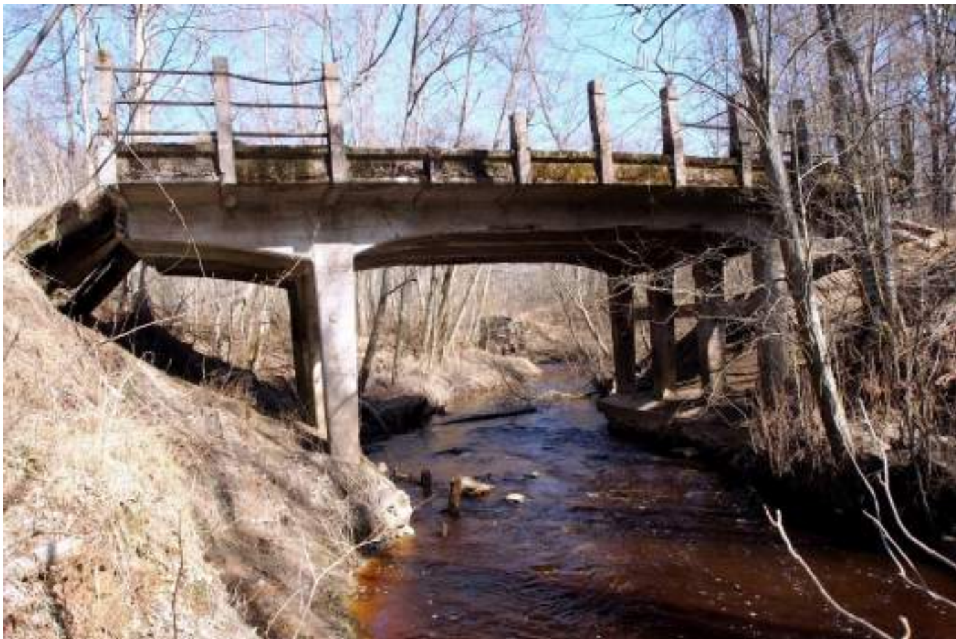
11. Бетонный мост через Тёткин ручей на бывшем Архангельском тракте. Вид с юго-запада.
