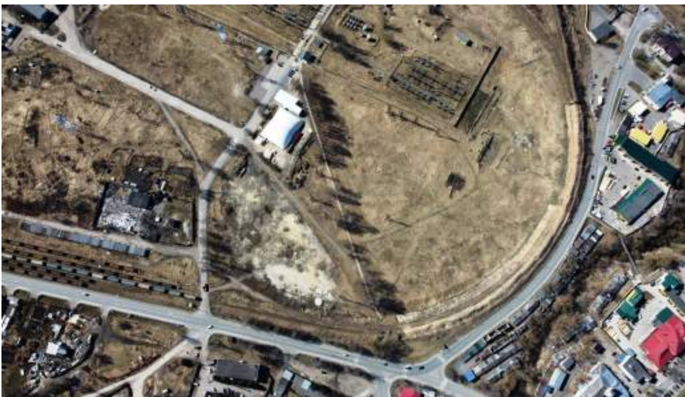
55. Дубровская ТЭЦ (бывшая ГРЭС-8). Вид с северо-востока. Кольцевой подъездной железнодорожный путь. Вид с востока от Железнодорожной улицы.
