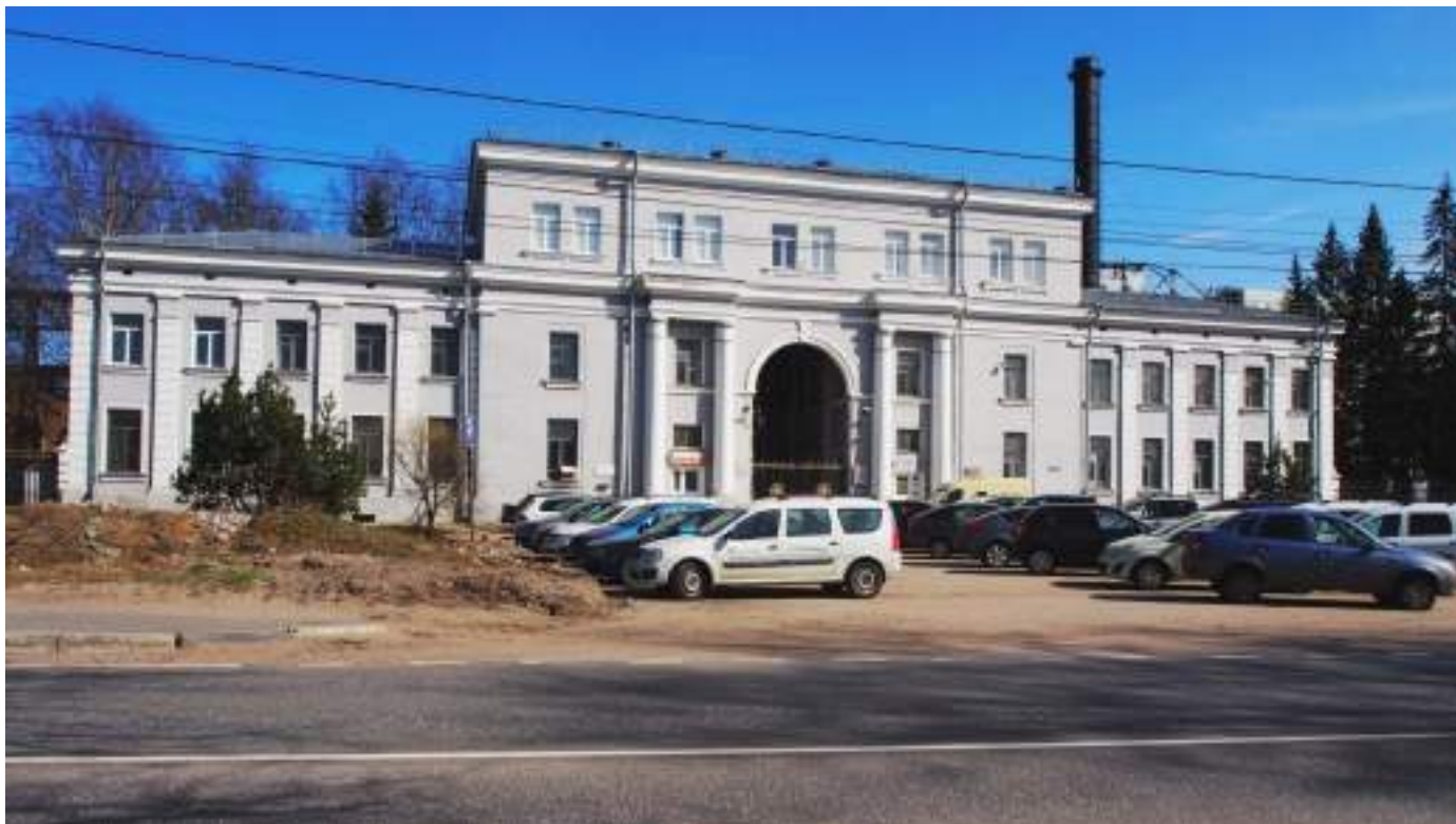
58. Дубровская ТЭЦ (бывшая ГРЭС-8). Административное здание. Вид с запада, от Набережной улицы.
