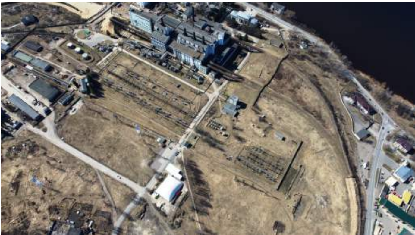
54. Дубровская ТЭЦ (бывшая ГРЭС-8). Вид с северо-востока. Справа кольцевой подъездной железнодорожный путь.
