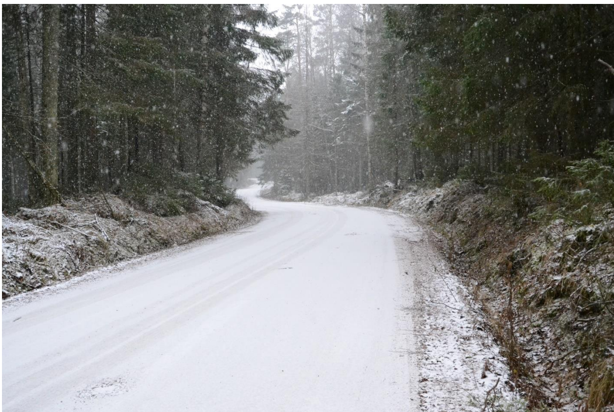
Рис. 19. Общий вид территории проектирования. Грунтовая дорога, проходящей с восточной стороны от песчаного карьера до СНТ «Светлая Гора».
