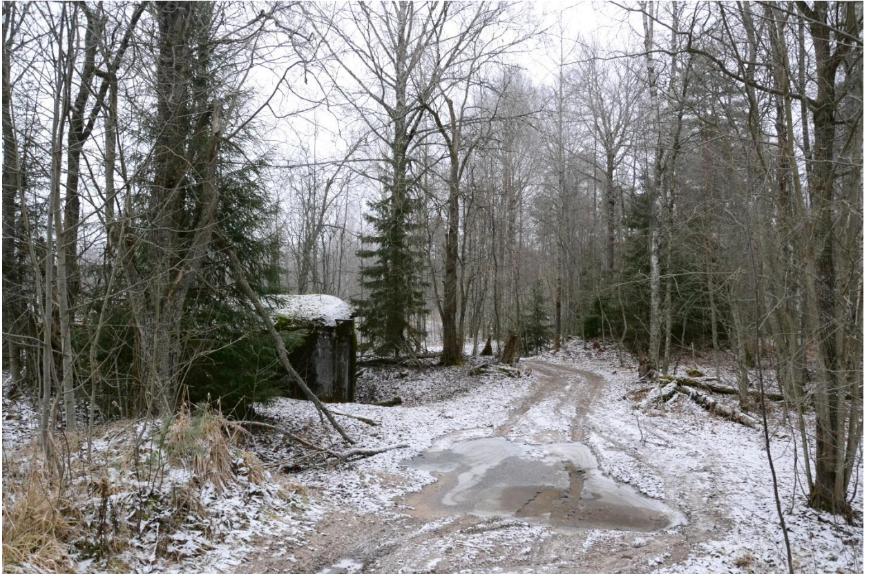
Рис. 9. Общий вид на выявленный ОКН «Карельский укрепленный район. Меднозаводский батальонный район обороны. Казематированная батарея с командным пунктом», расположенный от 5 до 20 м от территории проектирования.
