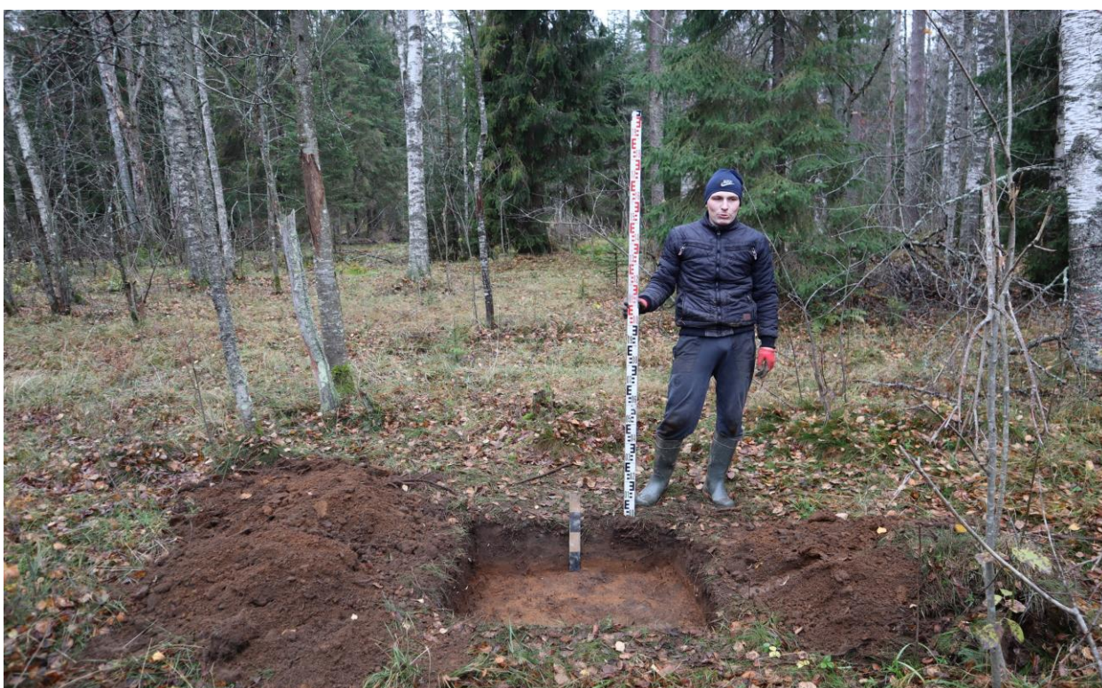
Рис. 69. Территория проектирования. Вид с юга на шурф №4.
