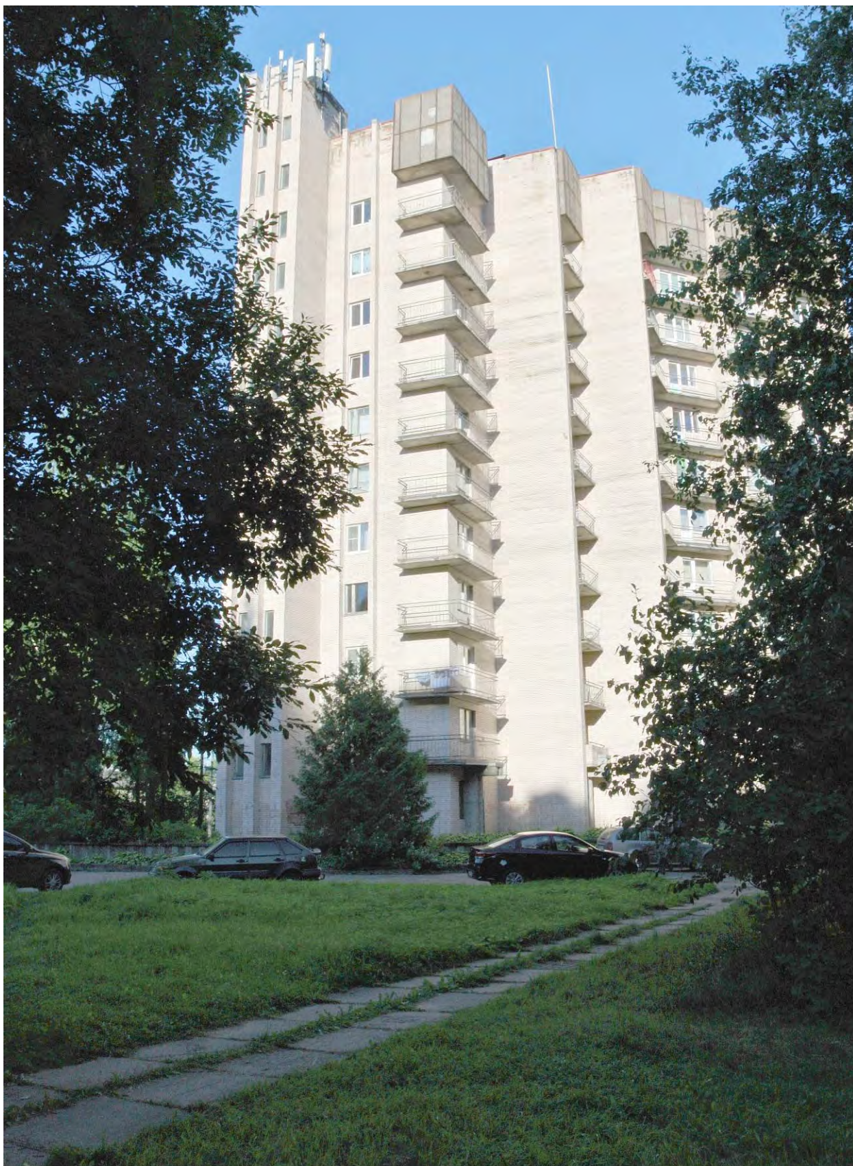
Фото 16. Вид в юго-восточном направлении на здание гостиницы «Академическая» (ул. Крупской, д. 12).
