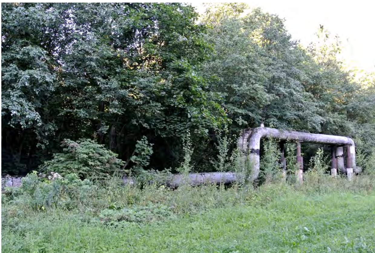
Фото 25. Вид в восточном направлении на восточную сторону подъездной дороги к территории ФГБУ «ПИАФ».
