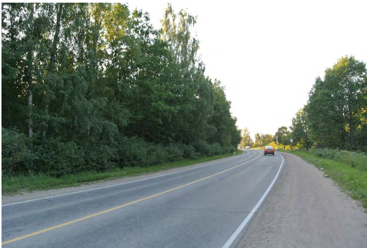
Фото 44. Вид в северном направлении на Соколовское шоссе в районе границ СНТ «Рошалец» и СНТ «Мариенбург».
