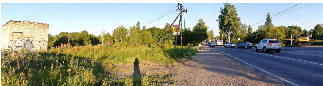
Фото 32. Панорама в восточном направлении на Соколовское шоссе, парк «Зверинец» на границе с «Дворцовым парком» и здание трансформаторной подстанции на территории парка «Зверинец» (Соколовское ш., д. 1а).
