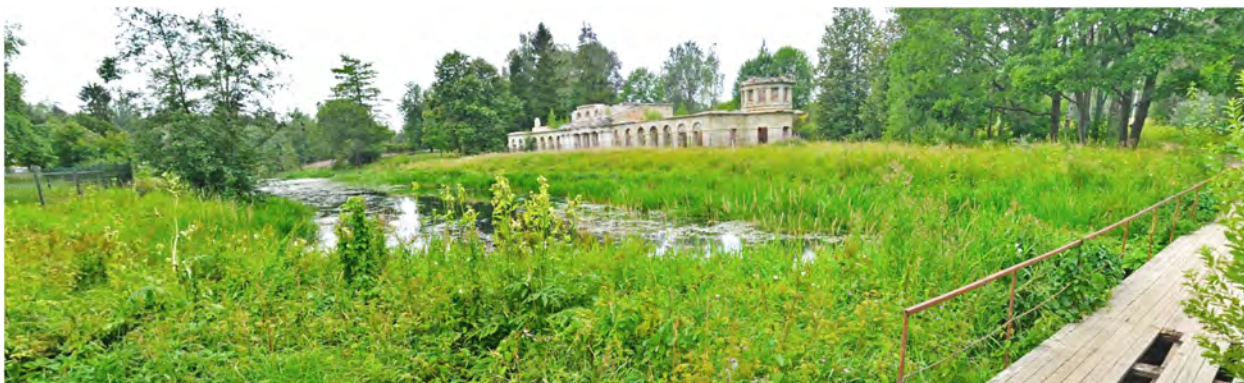
Фото 49. Вид в северо-западном направлении на здание «Птичник»а от моста-руины «Наумахия».
