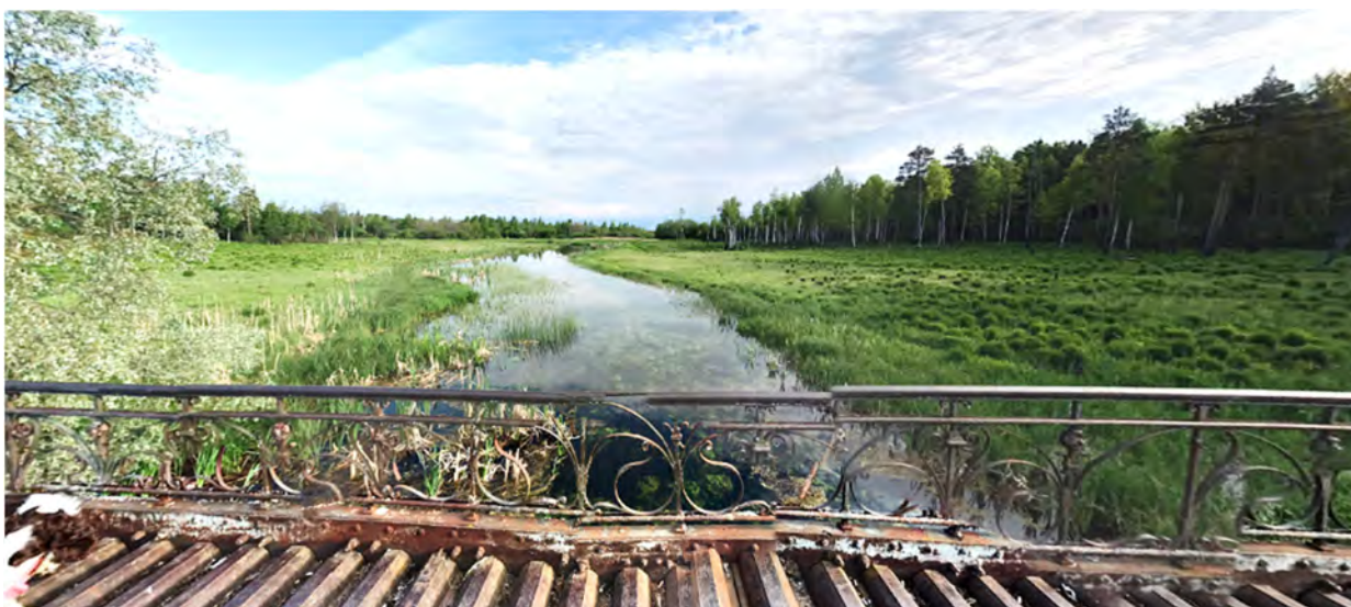
Фото 47. Северный (Осиновый) мост. Вид в северном направлении.
