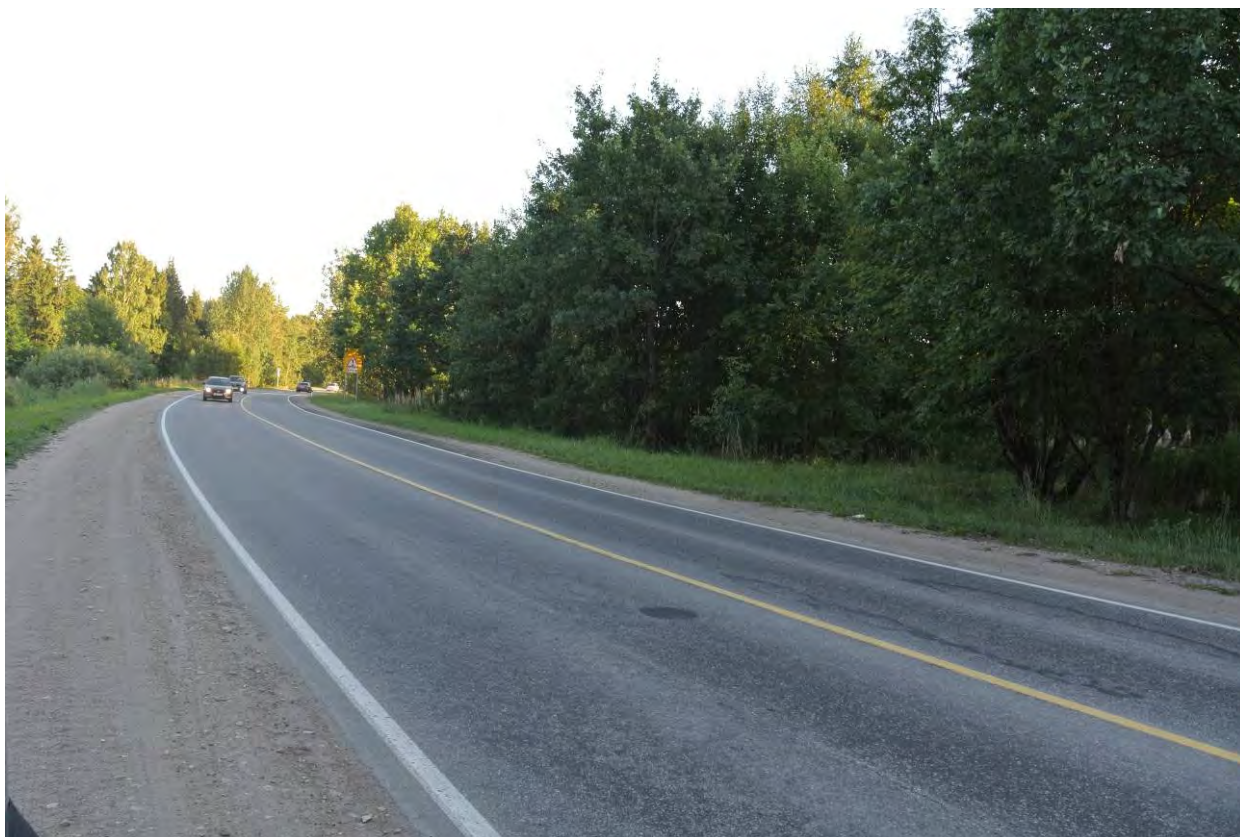
Фото 45. Вид в южном направлении на Соколовское шоссе перед железнодорожным переездом.
