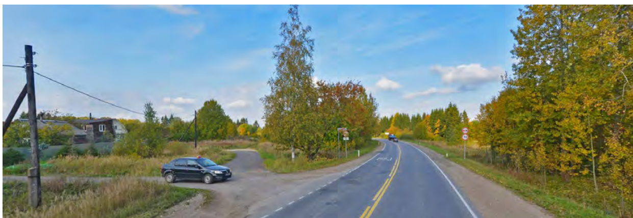
ФОТО 12. Вид Соколовского шоссе в северном направлении в районе СНТ «Мариенбург».
