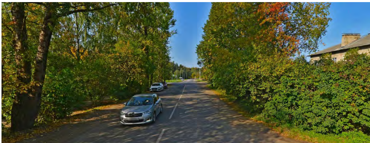
ФОТО 1. Вид с Рощинской ул. от дома № 29 в северо-западном направлении.
