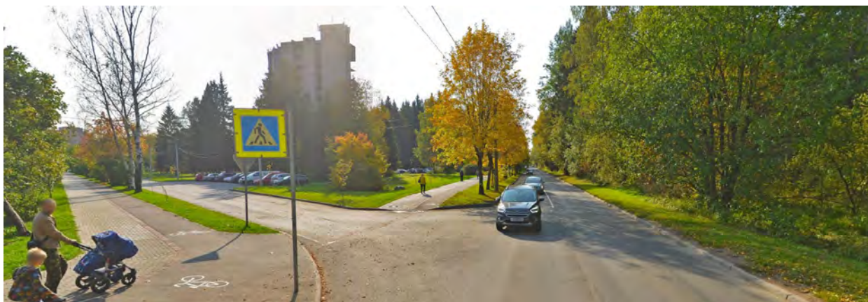
ФОТО 4. Вид на здание гостиницы «Академическая» и перекресток ул. Крупской и ул. Профессора Русинова в южном направлении.
