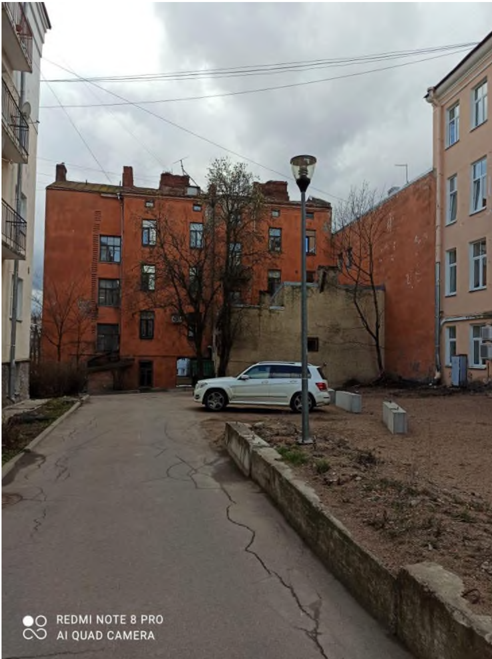
Фото 23. Общий вид дворовых фасадов Жилого дома по ул. Титова, 4, и дворового корпуса по ул. Титова, 4 а. Фото с северо-запада. 20.04.2021 г.
