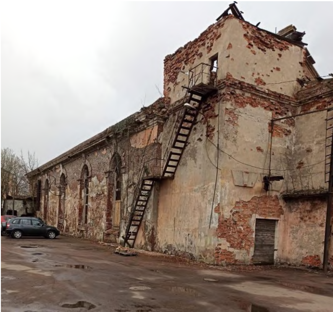
Фото 5. Церковь монастыря «Черных братьев», ул. Выборгская, 11. Дворовый северный фасад. Фото 20.04.2021 г.
