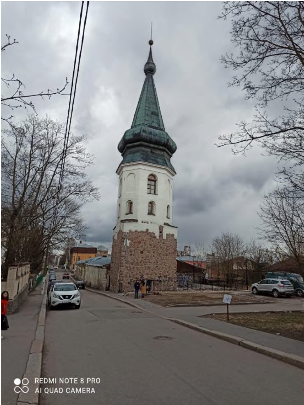
Фото 1. Башня Ратуши, ул. Выборгская, 13 а. Фото с северо-запада. 20.04.2021 г.
