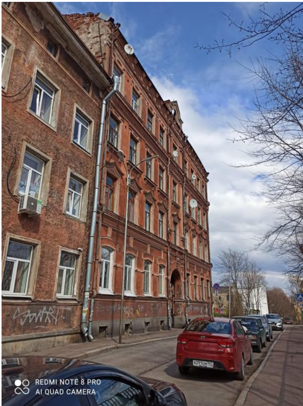
Фото 15. Жилой дом б. И. Науккаринена, ул. Титова, д. 4. Общий вид лицевого фасада с запада. Фото 20.04.2021 г.
