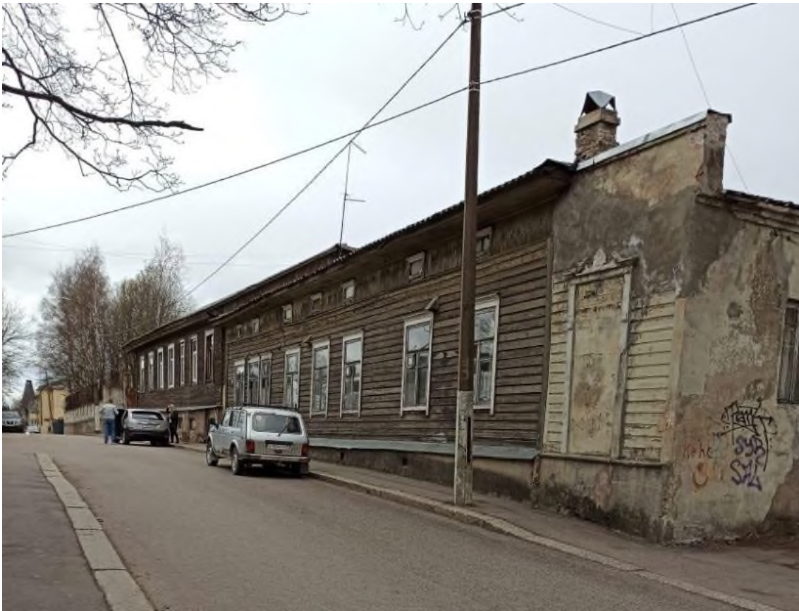
Фото 6. Общий вид жилых домов по ул. Выборгской, 18 и 20. Фото с юго-востока. Фото 20.04.2021 г.
