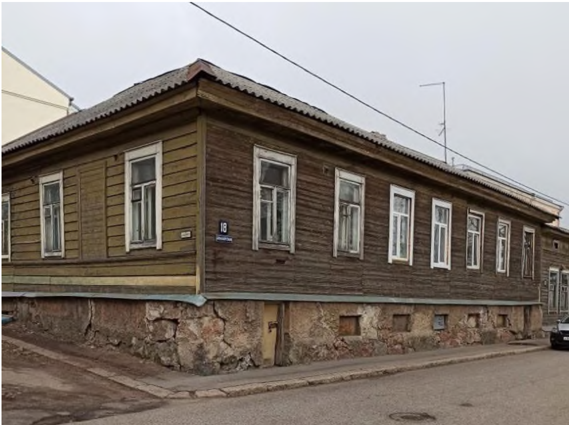
Фото 10. Жилой дом, ул. Выборгская, 18. Общий вид с запада. Фото 20.04.2021 г.
