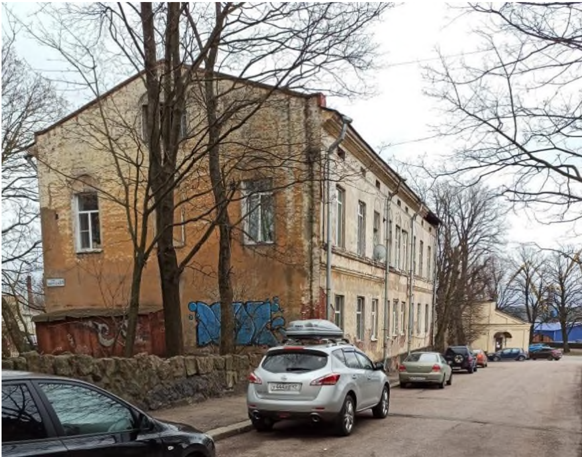
Фото 17. Жилой дом, ул. Выборгская, 13. Общий вид с севера. Фото 20.04.2021 г.
