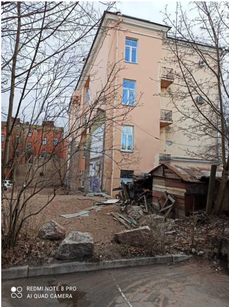
Фото 22. Бывший жилой дом, ул. Выборгская, 22. Общий вид дворового фасада с северо-запада. На фасаде – абрис утраченного строения по ул. Сторожевой башни, 21. Перед зданием – участок строительства. Фото 20.04.2021 г.
