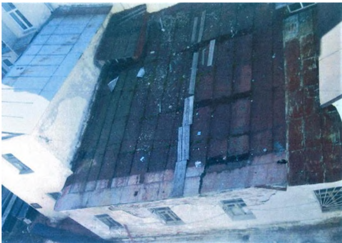
Фото 5. Вид крыши здания с пристройками 1964 и 1975 гг. Фото (копия) 2014 г.
