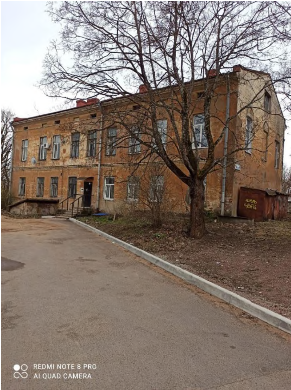
Фото 18. Жилой дом, ул. Выборгская, 13. Общий вид с северо-востока. Фото 20.04.2021 г.
