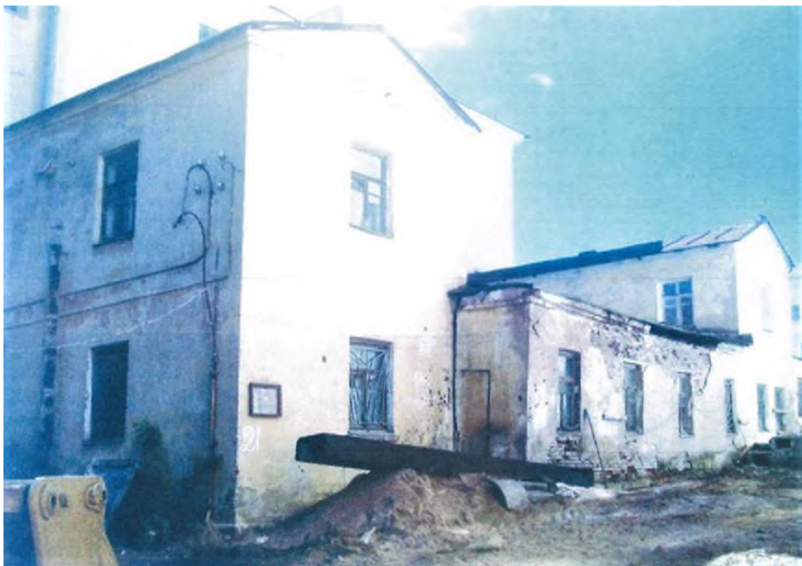
Фото 3. Общий вид здания с пристройками 1964 и 1975 гг. с северо-востока. Фото (копия) 2014 г.
