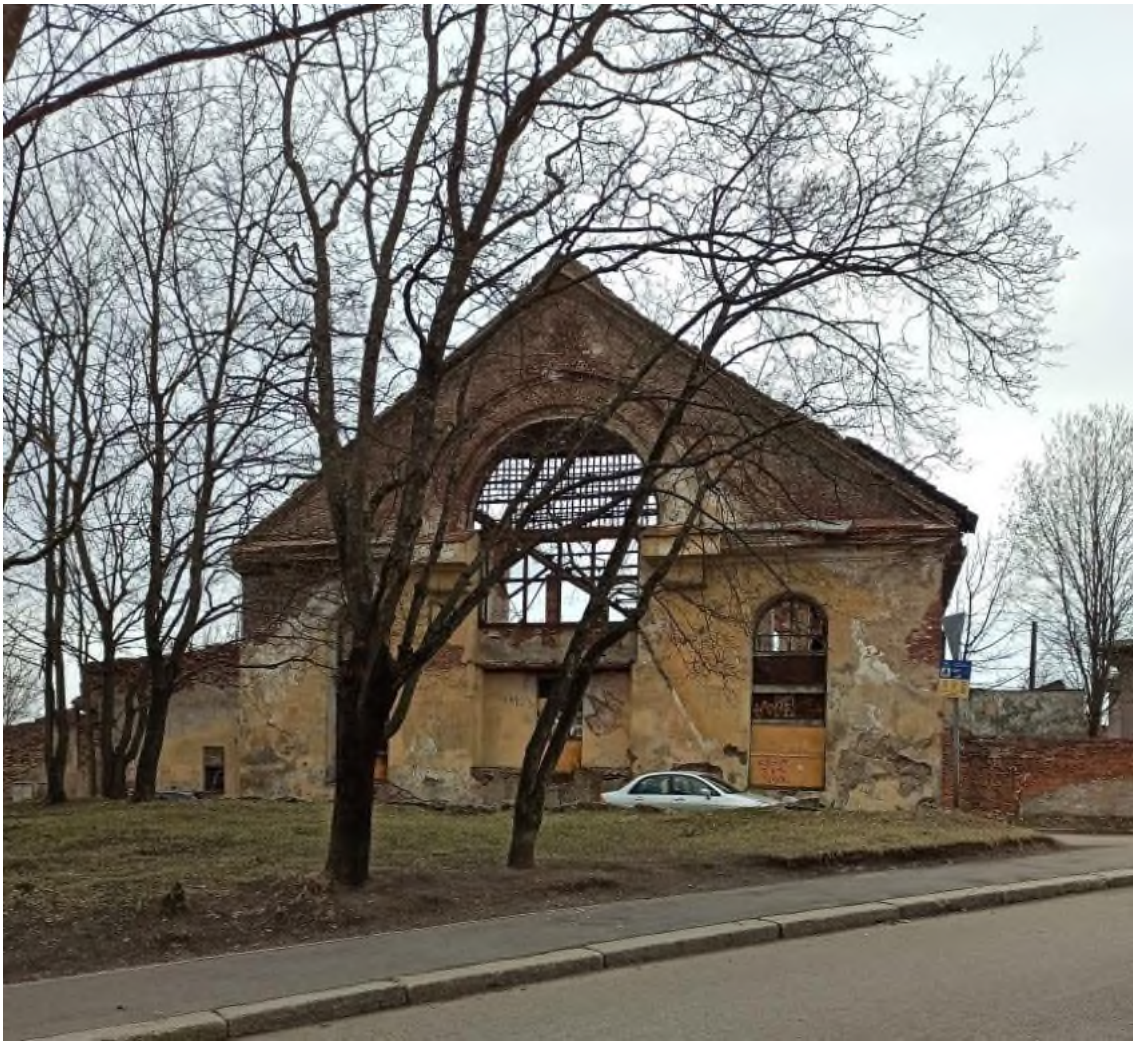
Фото 4. Церковь монастыря «Черных братьев», ул. Выборгская, 11. Лицевой восточный фасад. Фото 20.04.2021 г.
