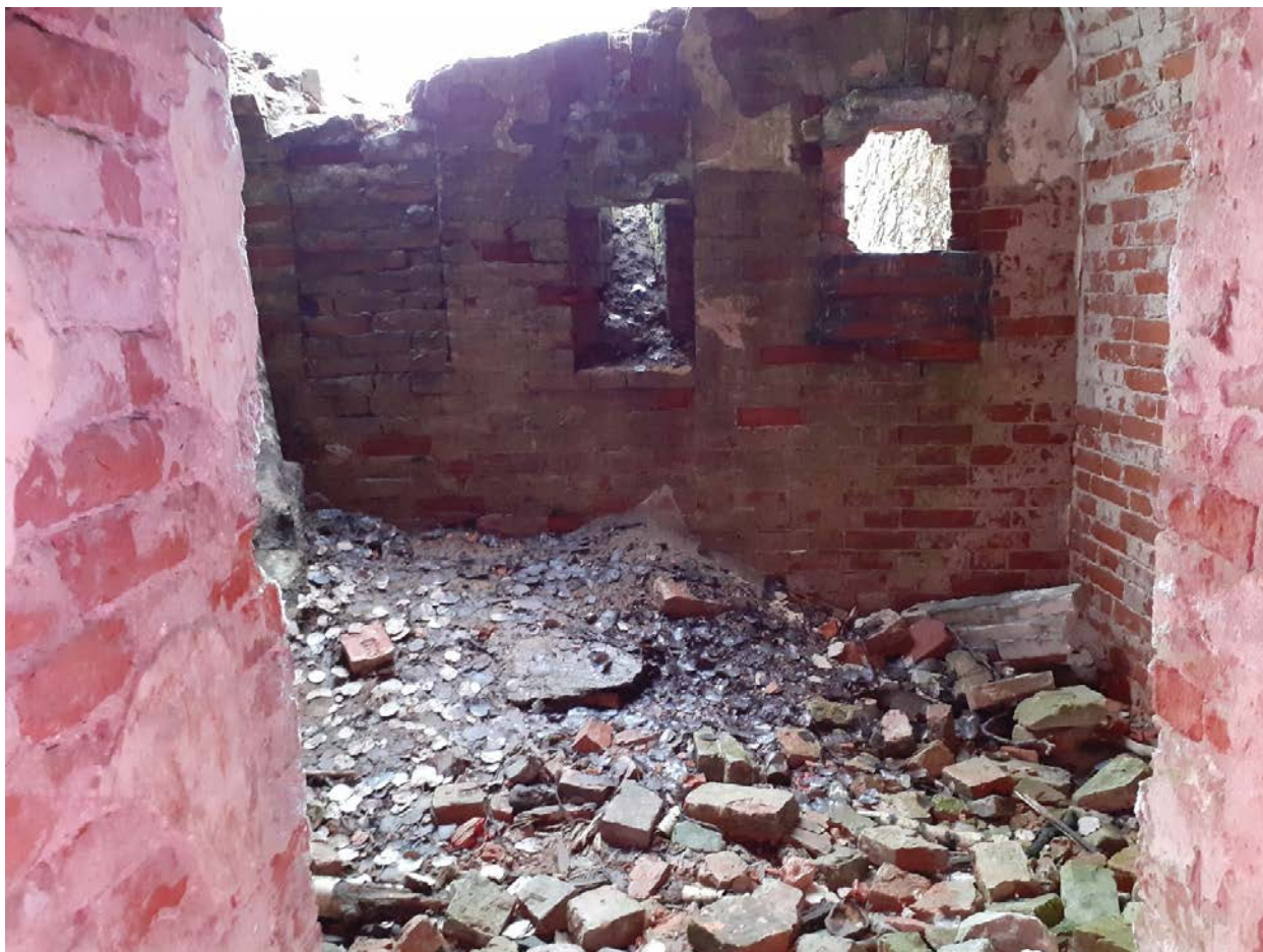
11. Капонир. Сквозное разрушение стены. Амбразуры, частично заложенные в 1950-е годы или позже.
