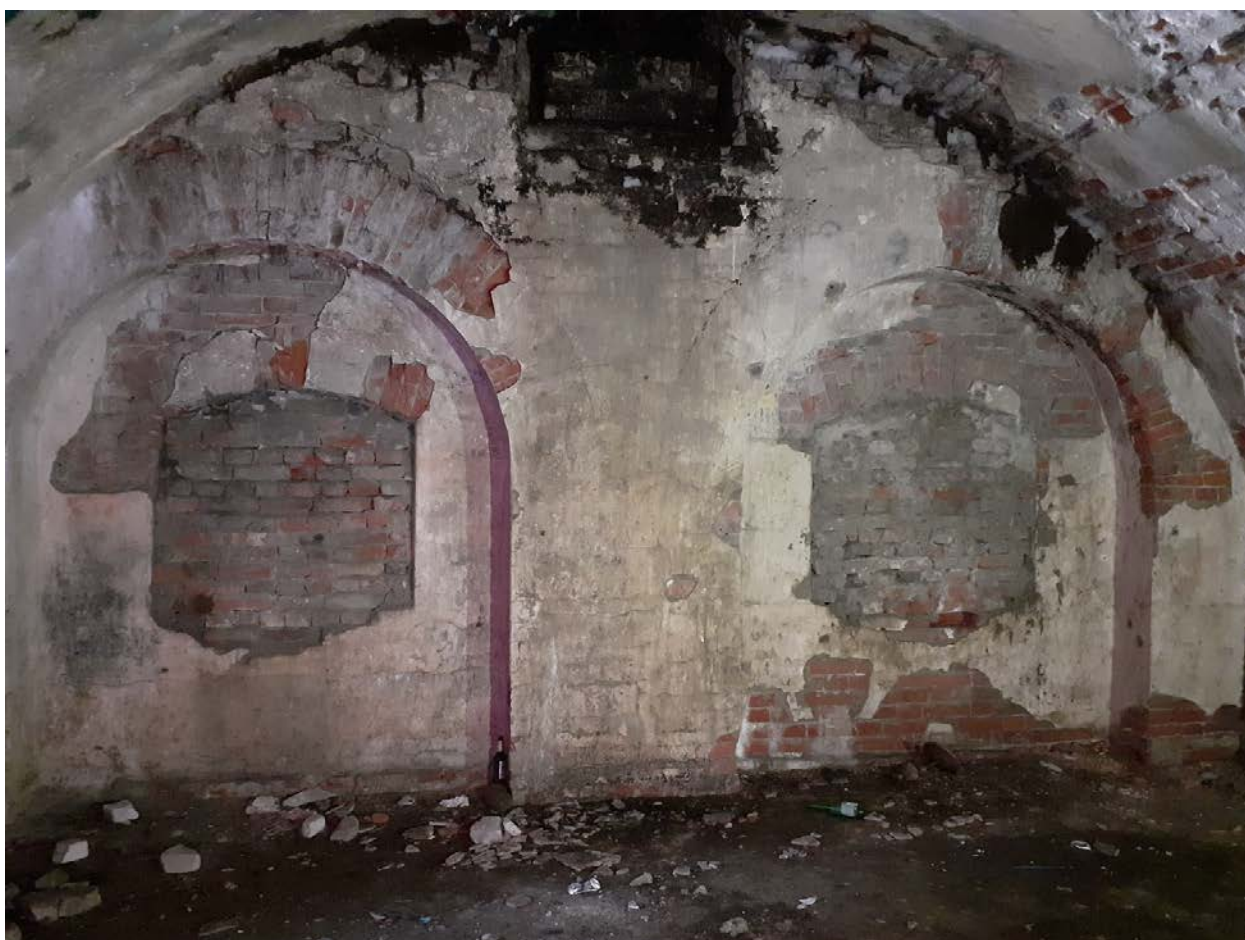
10. Капонир. Амбразуры для единорогов заложены кирпичом в 1950-е годы или позже.
