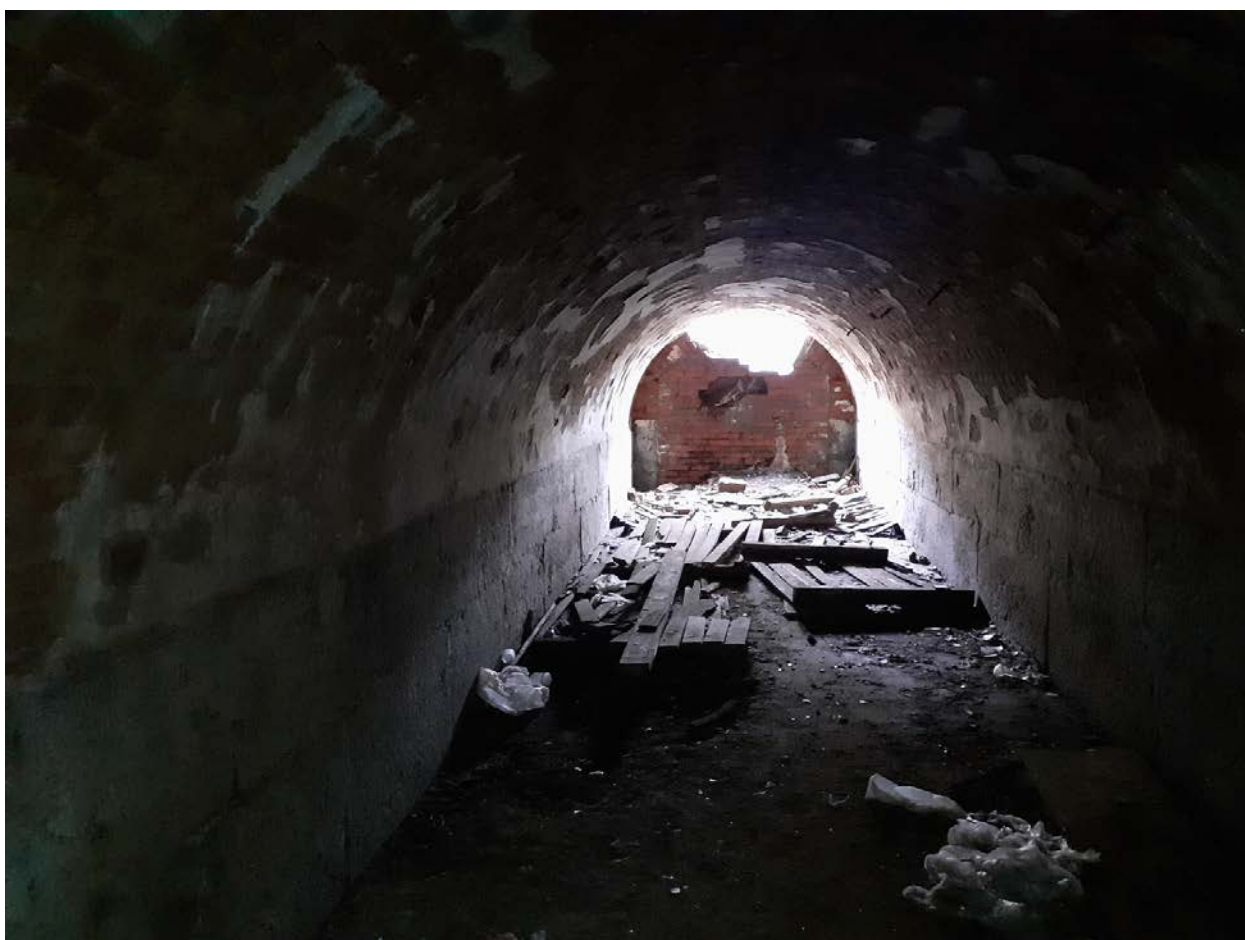
8. Главная потерна. Выход из потерны частично заложен кирпичом в 1950-е годы или позже
